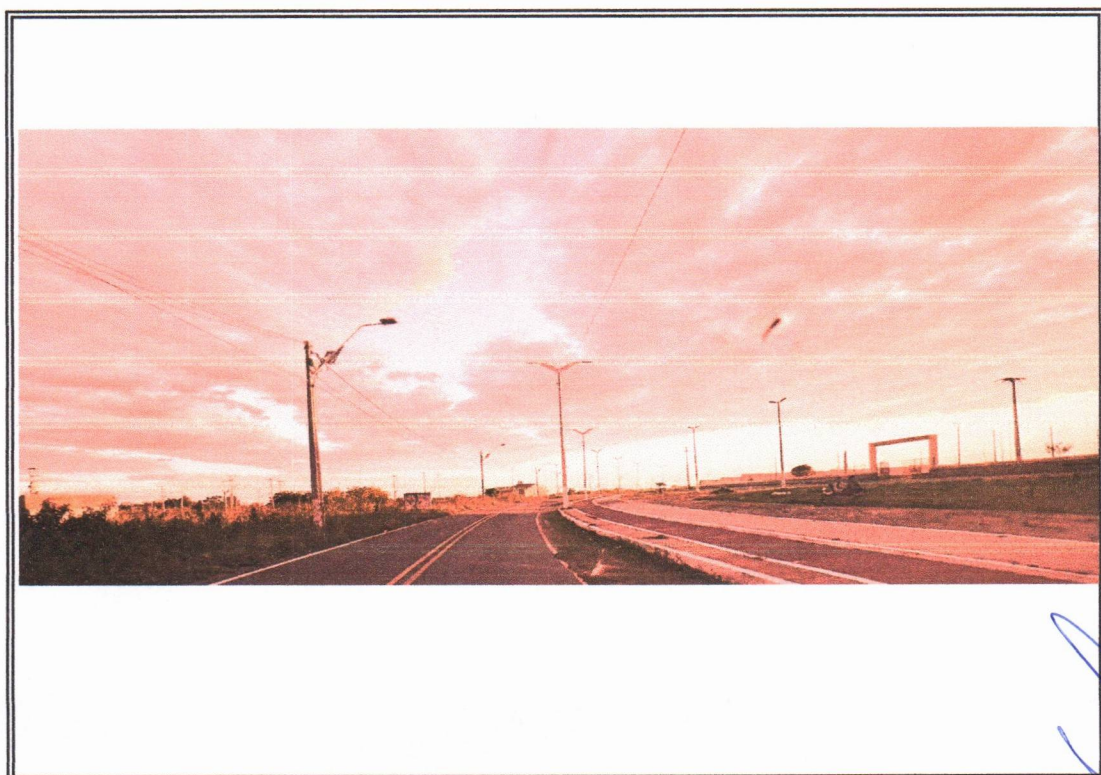
Foto 06- Vista onde sera feito sarjeta
