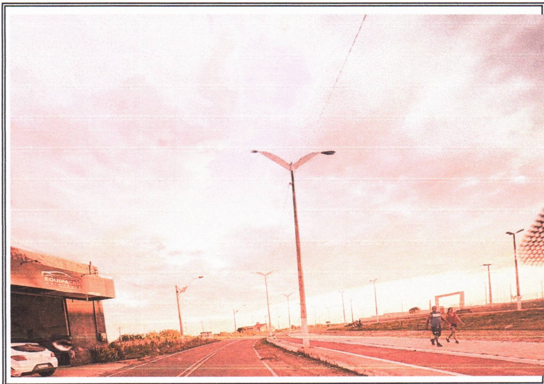
Foto 05 - Vista onde sera feito sarjeta
