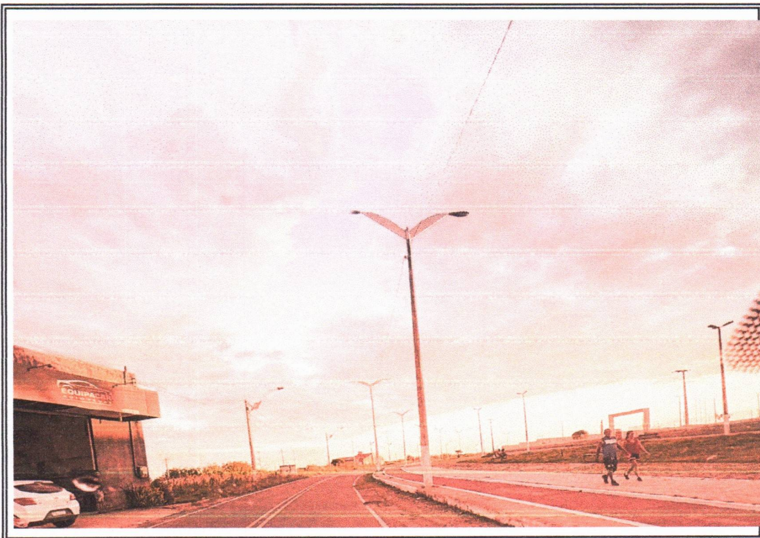
Foto 05 - Vista onde sera feito sarjeta
