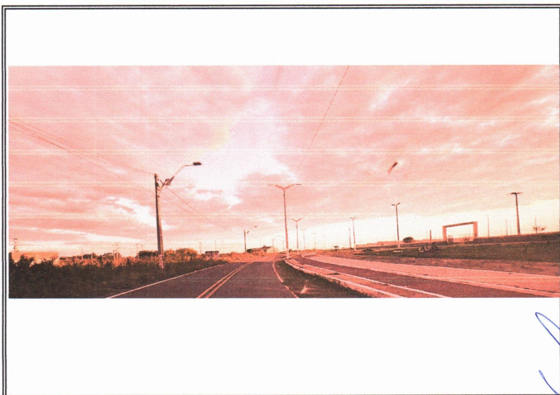
Foto 06- Vista onde sera feito sarjeta
