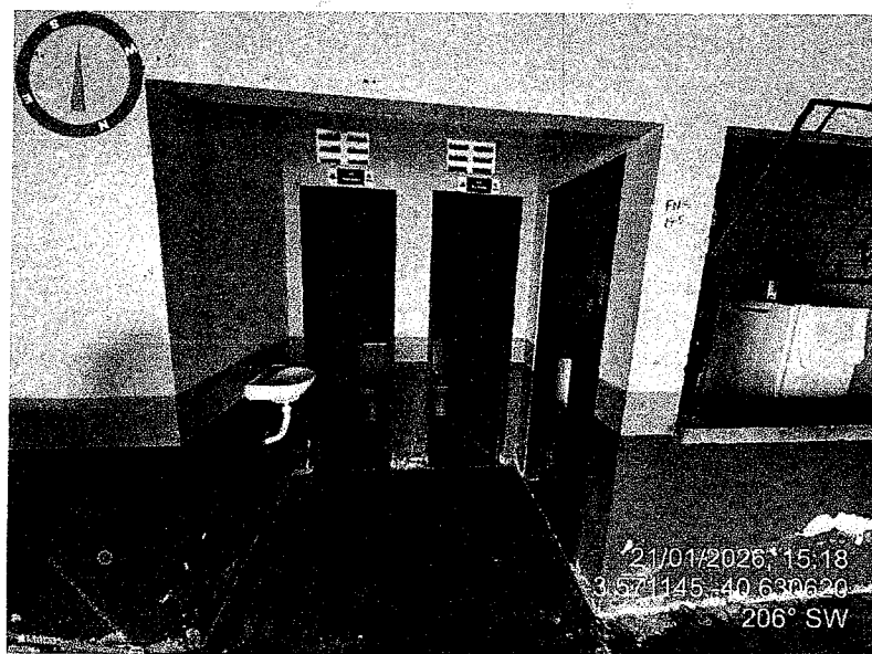
FOTO 08: VISTA DOS BANHEIROS AO LADO DA CANTINA
