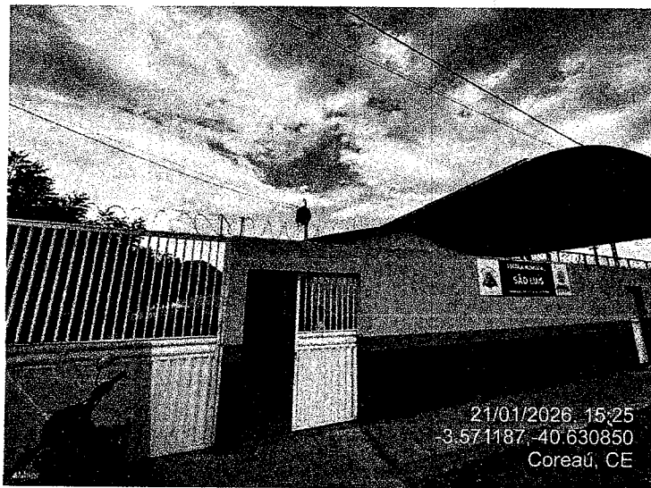
FOTO 04: FACHADA DA ESCOLA
