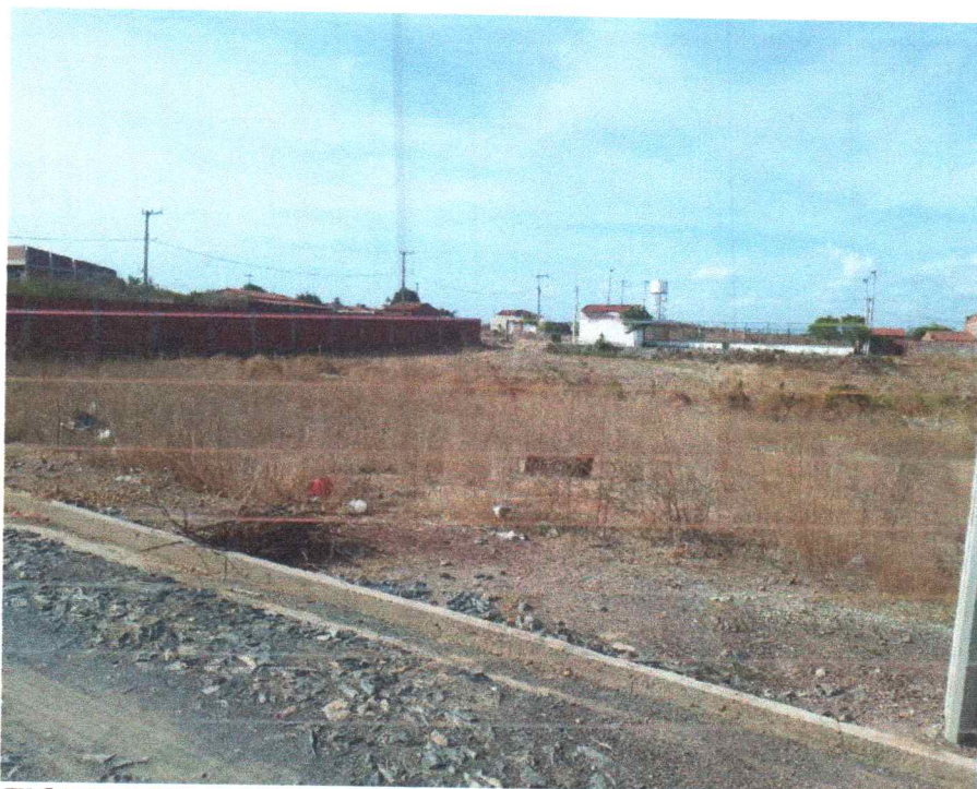
FIGURA 09: LOCAL PARA CONSTRUÇÃO DE ESCOLA NO DISTRITO DE UBAÚNA
