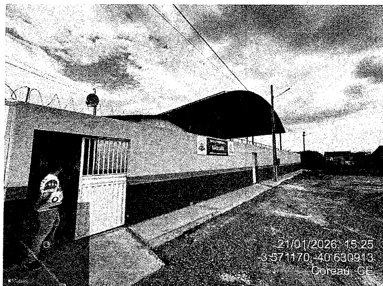
FOTO 10: VISTA DA FACHADA DA ESCOLA
