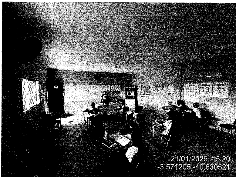
FOTO 07: SALA ONDE SERÁ TROCADO O PISO PARA INDUSTRIAL.
