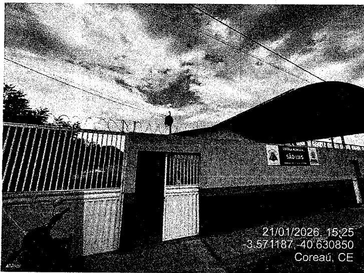
FOTO 04: FACHADA DA ESCOLA
