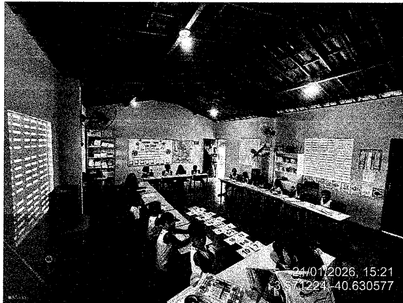
FOTO 01: SALA ONDE SERÁ FORRADA COM FORRO PVC TROCADO O PISO PARA INDUSTRIAL.
