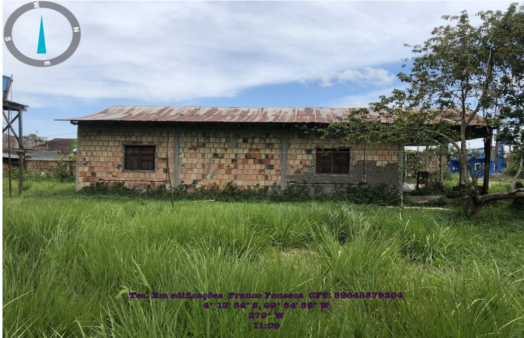
09- Vista da residência dentro das limitações do terreno.
