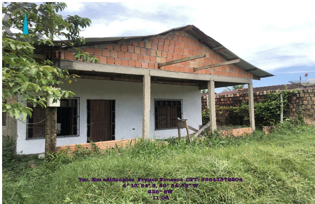
IMAGEM 05 – Vista da residência dentro da propriedade.
