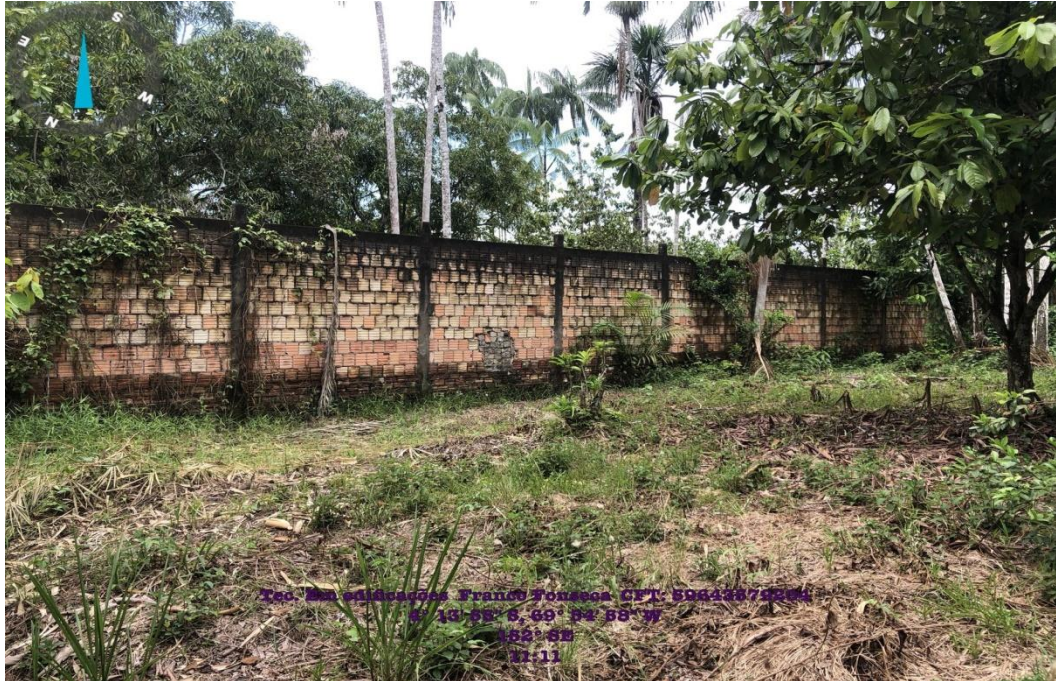
IMAGEM 15 – Vista geral interna do terreno.
