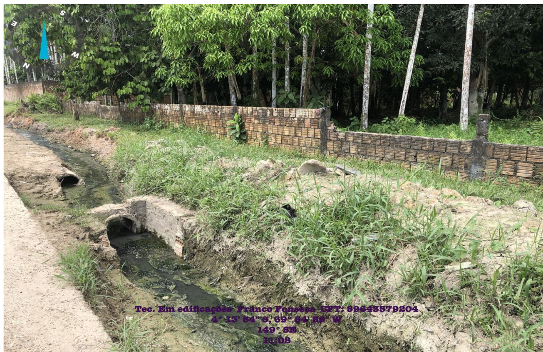
IMAGEM 01 – Vista da tubulação de drenagem externa.
