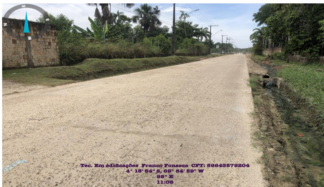
IMAGEM 02 – Vista da pavimentação em concreto estrutural.
