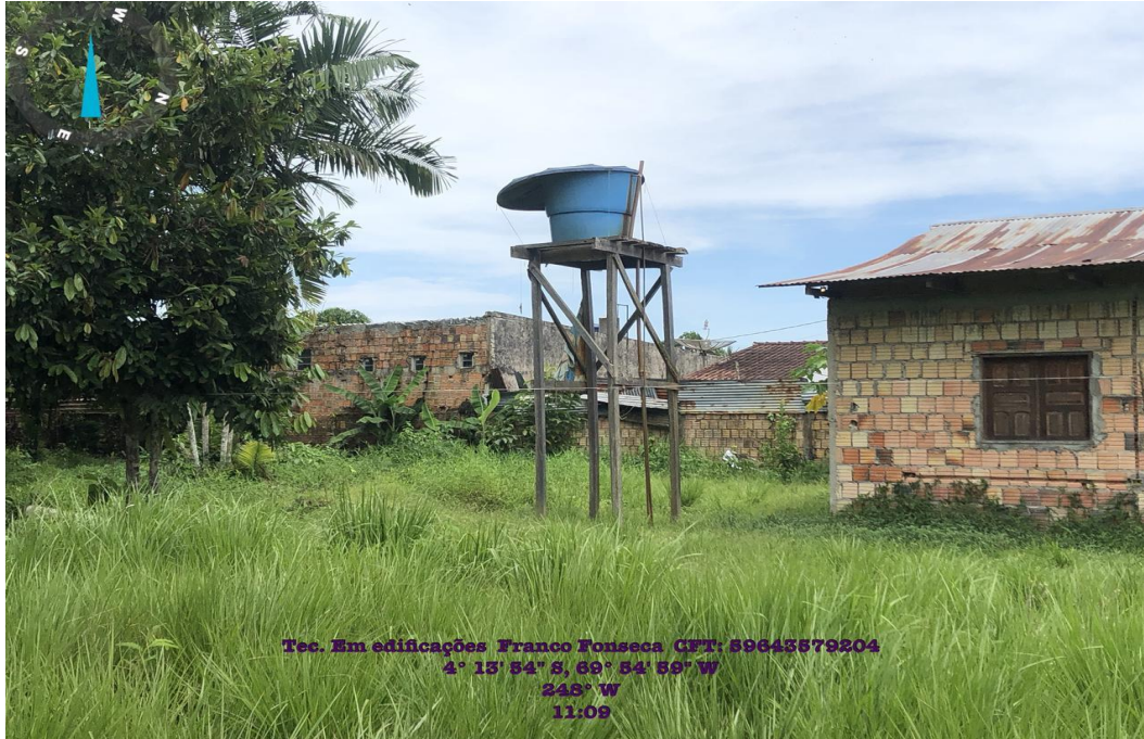
IMAGEM 07 – Vista do castelo d’água elevado da residência.
