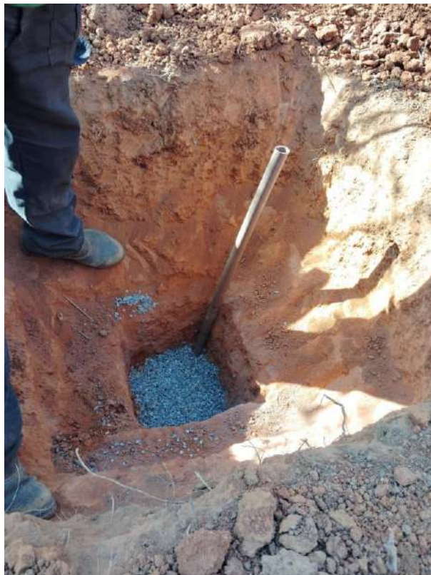
FOTO 3 – PROCESSO DE COLOCAÇÃO DA BRITA E ESCALA DE MEDIÇÃO.
