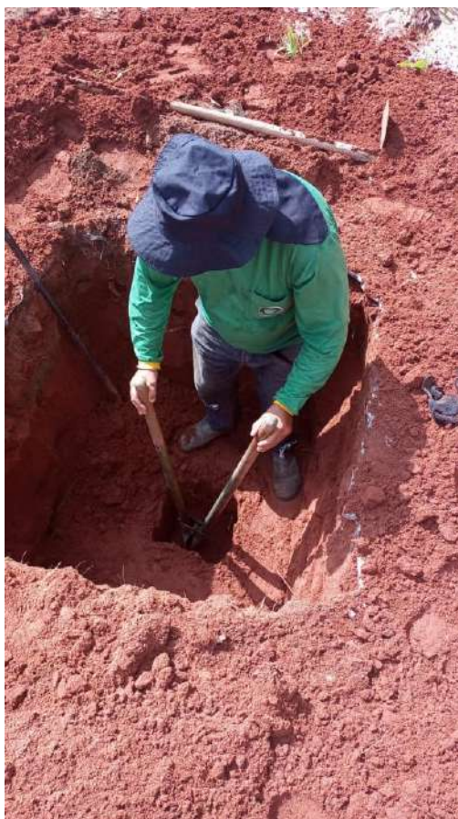
FOTO 2 – FASE DE ESCAVAÇÃO DA VALA MAIOR
