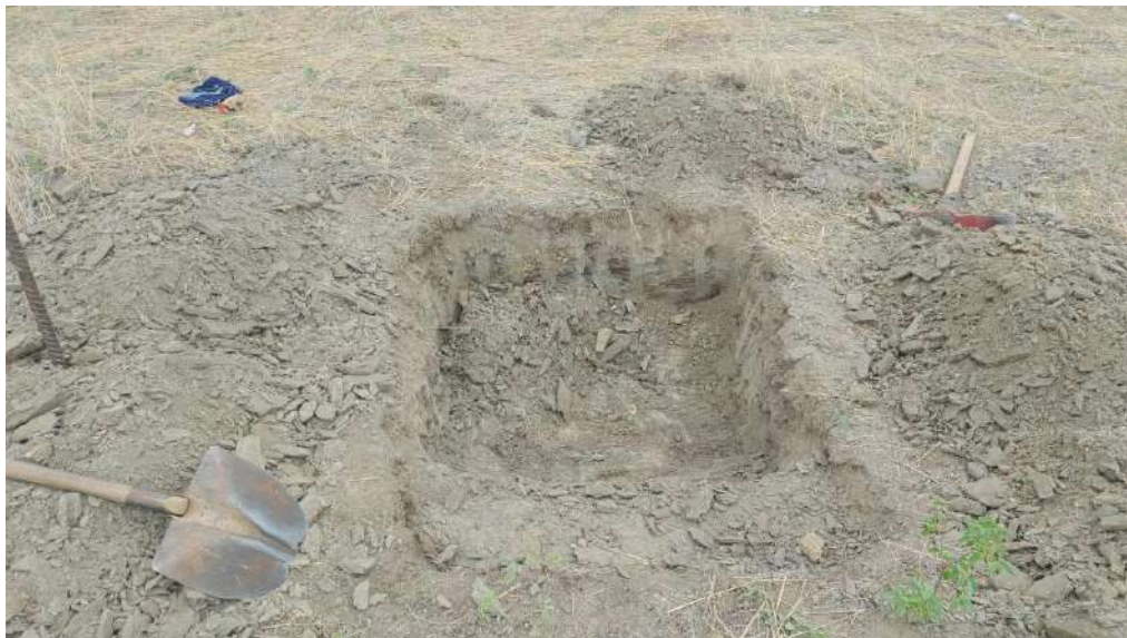
FOTO 1 – INICIO DA ABERTURA DA VALA MAIOR
