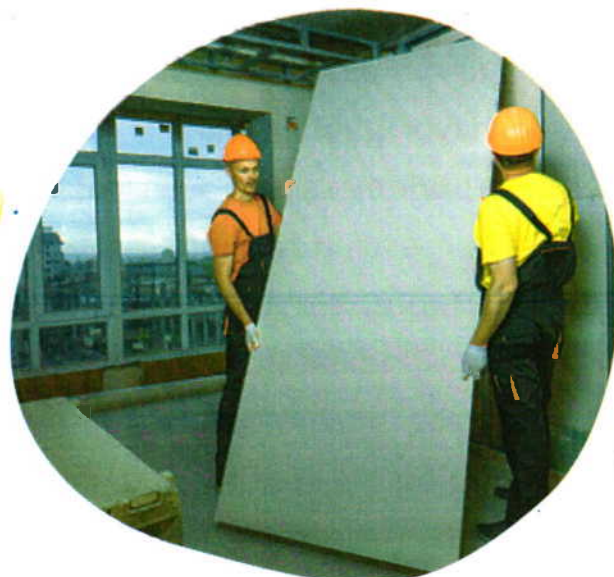
Figura 13- Arquivo Canva - Divisórias interna (drywall)
