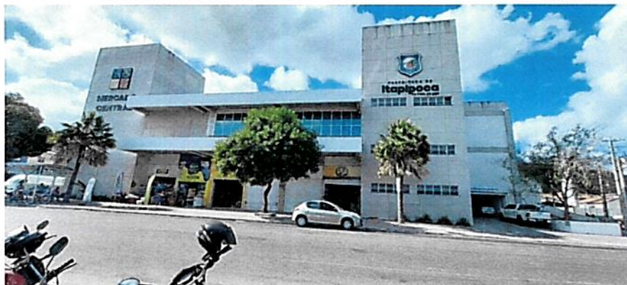
VISTA FRENTE, (prédio)
