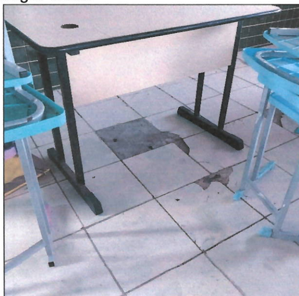
Figura 3: Piso de salas de aula degradados.
