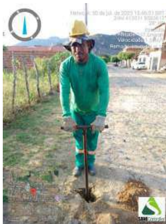
Figura 50 - Detalhe da equipe iniciando a sondagem ST-13
