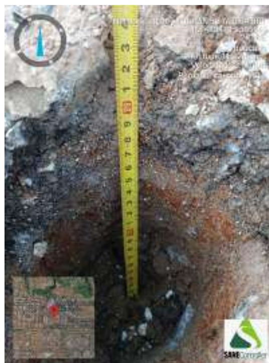
Figura 60 - Indicação da profundidade obtida durante o avanço da sondagem ST-15
