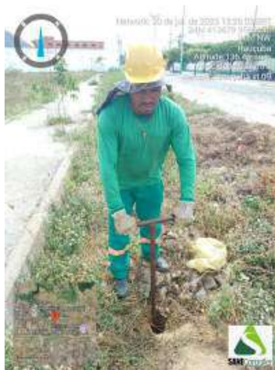
Figura 35 - Detalhe da equipe iniciando a sondagem ST-09
