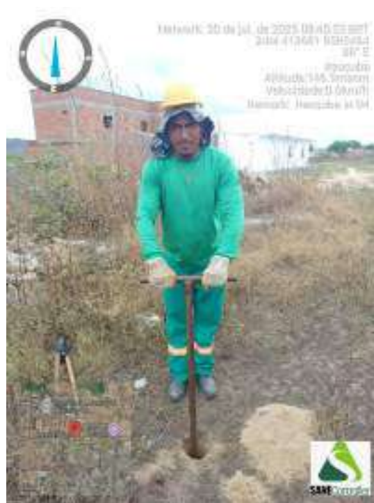
Figura 15 - Detalhe da equipe iniciando a sondagem ST-04
