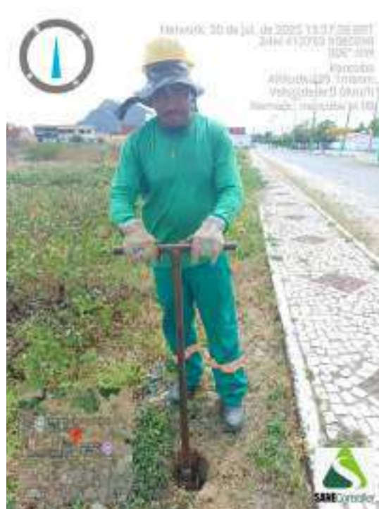
Figura 31 - Detalhe da equipe iniciando a sondagem ST-08
