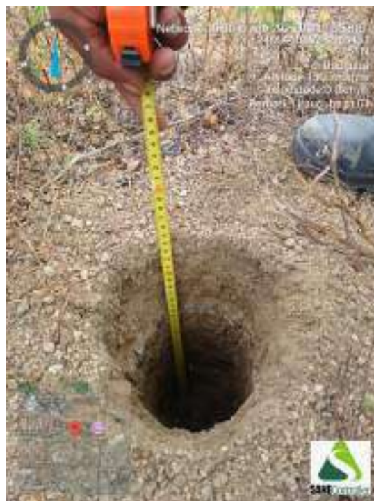
Figura 5 - Indicação da profundidade obtida durante o avanço da sondagem ST-01.
