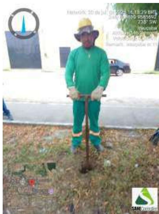
Figura 42 - Detalhe da equipe iniciando a sondagem ST-11
