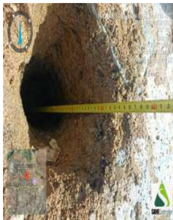
Figura 29 - Indicação da profundidade obtida durante o avanço da sondagem ST-07
