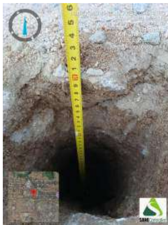
Figura 56 - Indicação da profundidade obtida durante o avanço da sondagem ST-14
