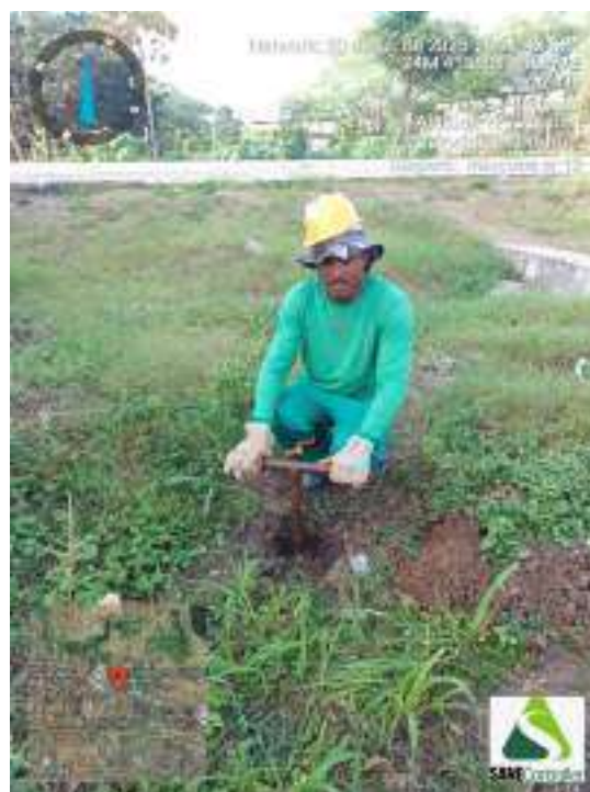
Figura 46 - Detalhe da equipe iniciando a sondagem ST-12
