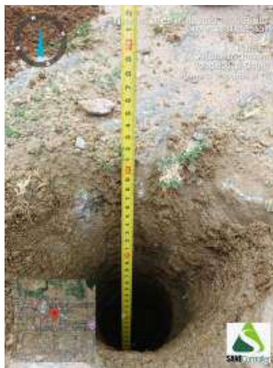
Figura 39 - Indicação da profundidade obtida durante o avanço da sondagem ST-10
