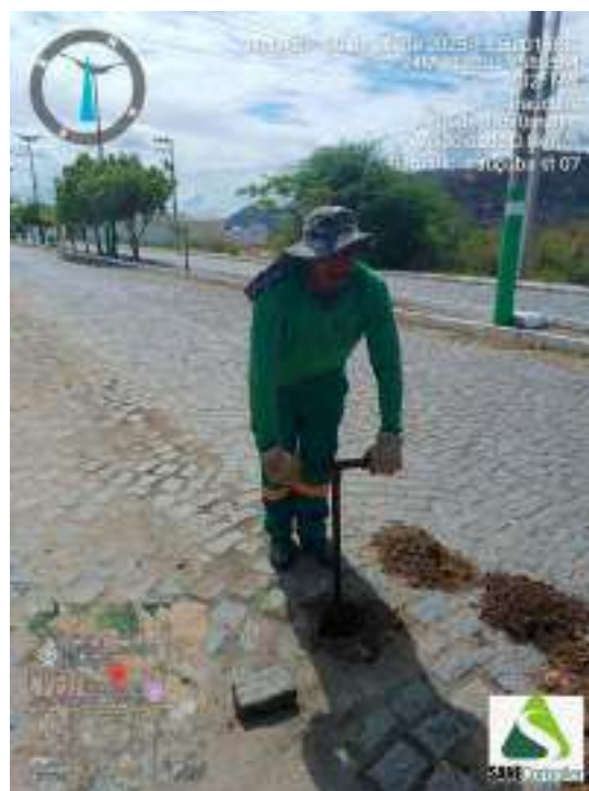
Figura 27 - Detalhe da equipe iniciando a sondagem ST-07
