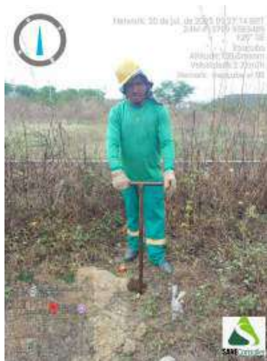
Figura 7 - Detalhe da equipe iniciando a sondagem ST-02
