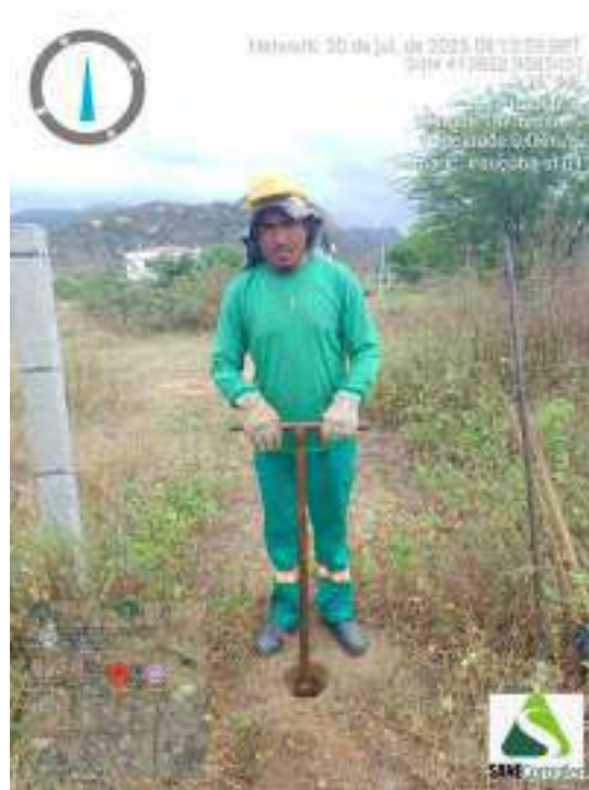
Figura 3 - Detalhe da equipe iniciando a sondagem ST-01
