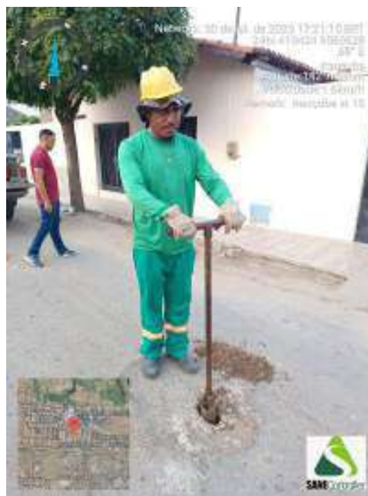
Figura 58 - Detalhe da equipe iniciando a sondagem ST-15
