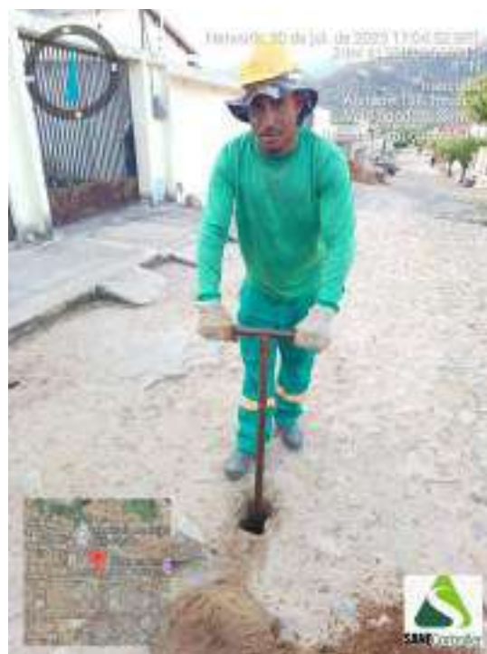
Figura 54 - Detalhe da equipe iniciando a sondagem ST-14
