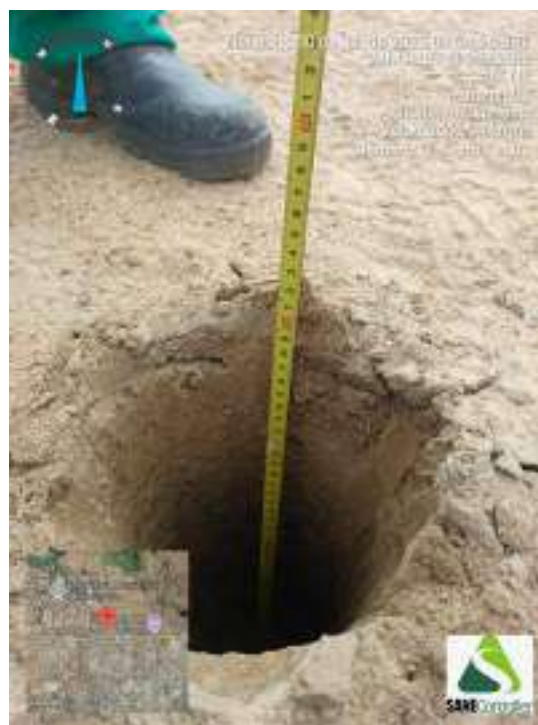
Figura 13 - Indicação da profundidade obtida durante o avanço da sondagem ST-03
