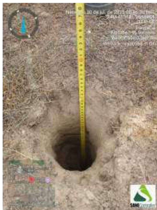
Figura 17 - Indicação da profundidade obtida durante o avanço da sondagem ST-04
