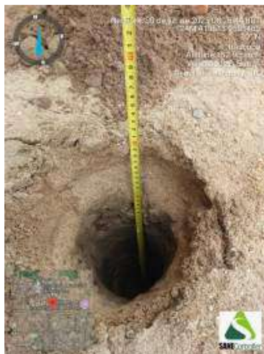
Figura 21 - Indicação da profundidade obtida durante o avanço da sondagem ST-05.
