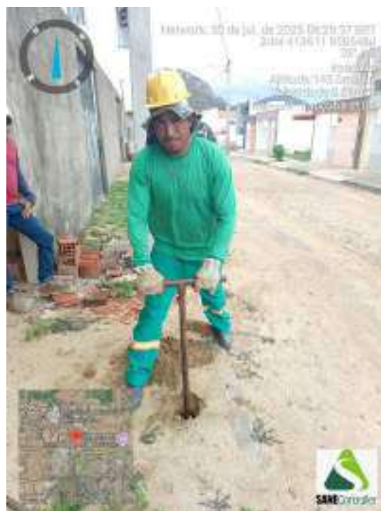
Figura 19 - Detalhe da equipe iniciando a sondagem ST-05
