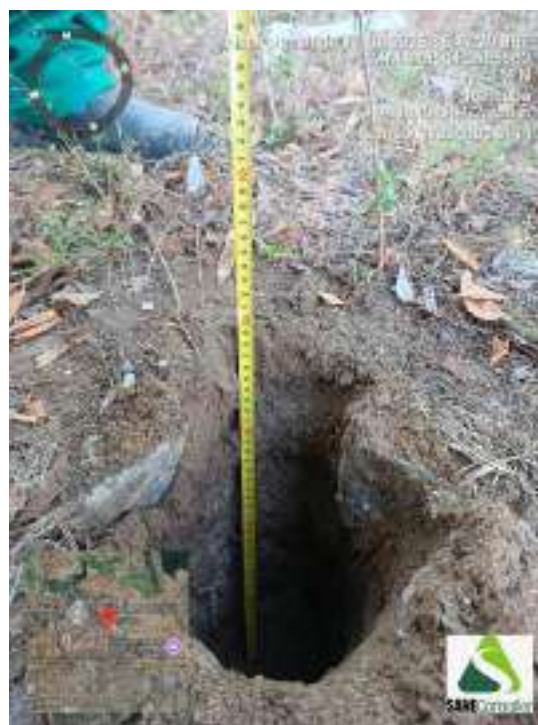
Figura 44 - Indicação da profundidade obtida durante o avanço da sondagem ST-11
