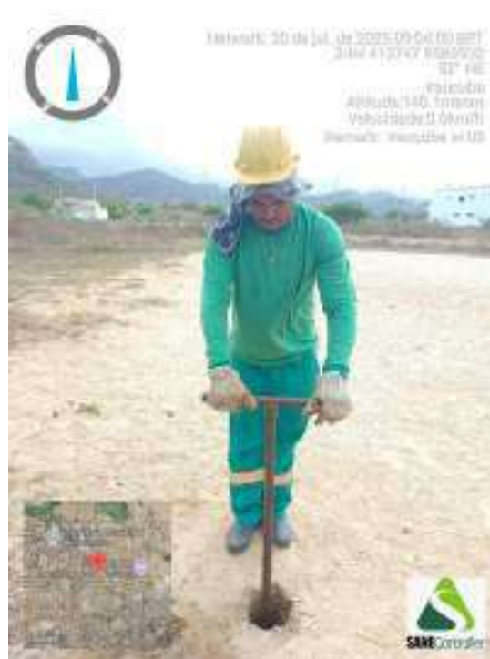
Figura 11 - Detalhe da equipe iniciando a sondagem ST-03
