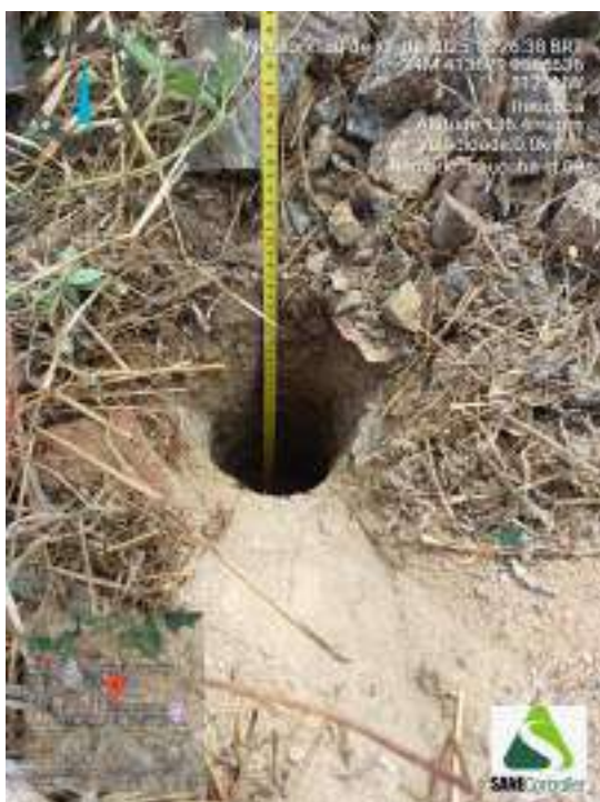
Figura 36 - Indicação da profundidade obtida durante o avanço da sondagem ST-09
