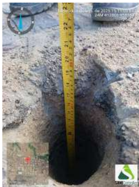
Figura 230 - Indicação da profundidade obtida durante o avanço da sondagem ST-58
