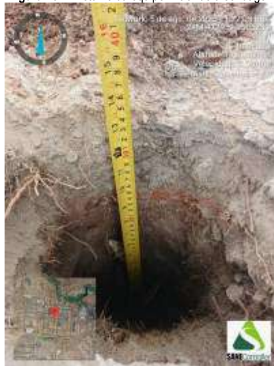
Figura 186 - Indicação da profundidade obtida durante o avanço da sondagem ST-47
