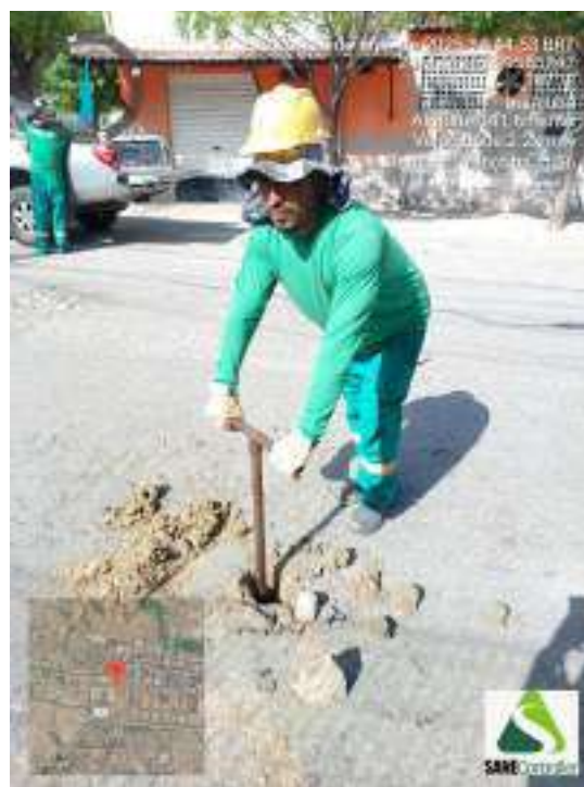
Figura 220 - Detalhe da equipe iniciando a sondagem ST-56
