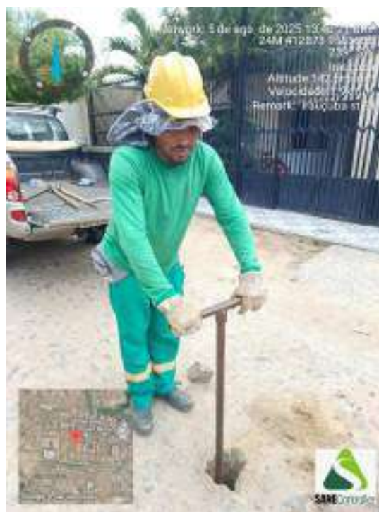
Figura 200 - Detalhe da equipe iniciando a sondagem ST-51
