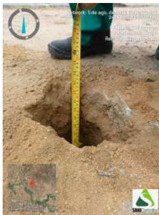
Figura 166 - Indicação da profundidade obtida durante o avanço da sondagem ST-42
