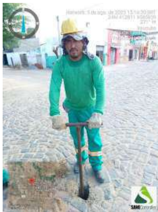
Figura 228 - Detalhe da equipe iniciando a sondagem ST-58
