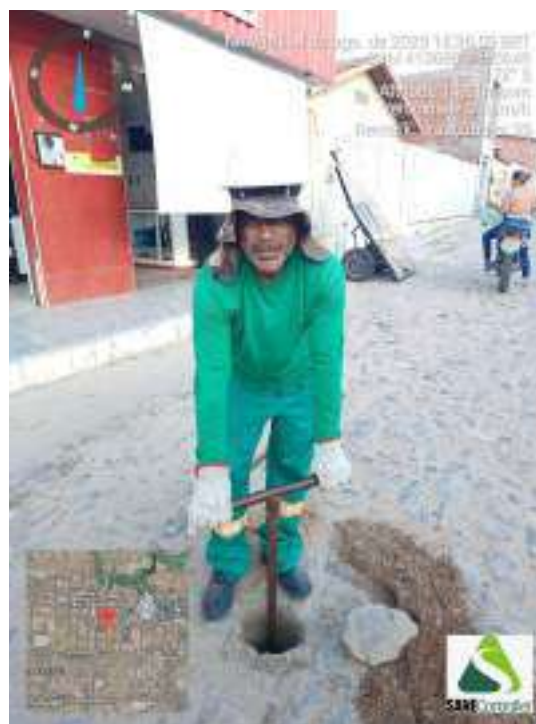
Figura 138 - Detalhe da equipe iniciando a sondagem ST-35
