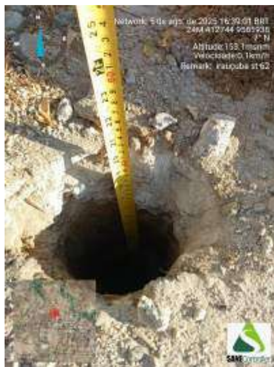
Figura 246 - Indicação da profundidade obtida durante o avanço da sondagem ST-62
