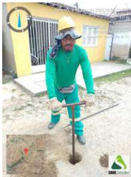
Figura 280 - Detalhe da equipe iniciando a sondagem ST-71
