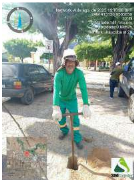
Figura 114 - Detalhe da equipe iniciando a sondagem ST-29
