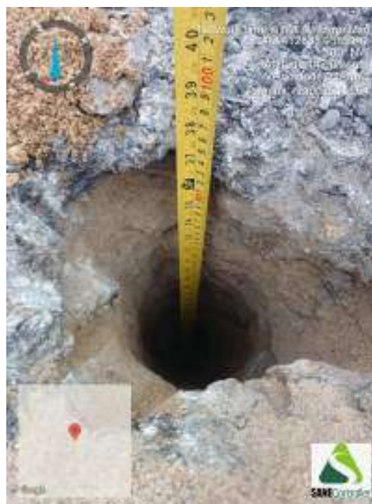
Figura 254 - Indicação da profundidade obtida durante o avanço da sondagem ST-64
