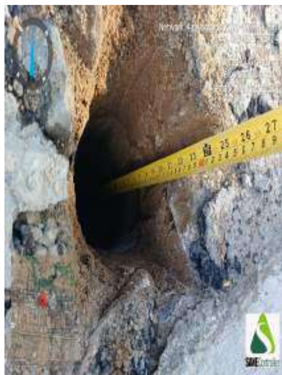
Figura 120 - Indicação da profundidade obtida durante o avanço da sondagem ST-30.
