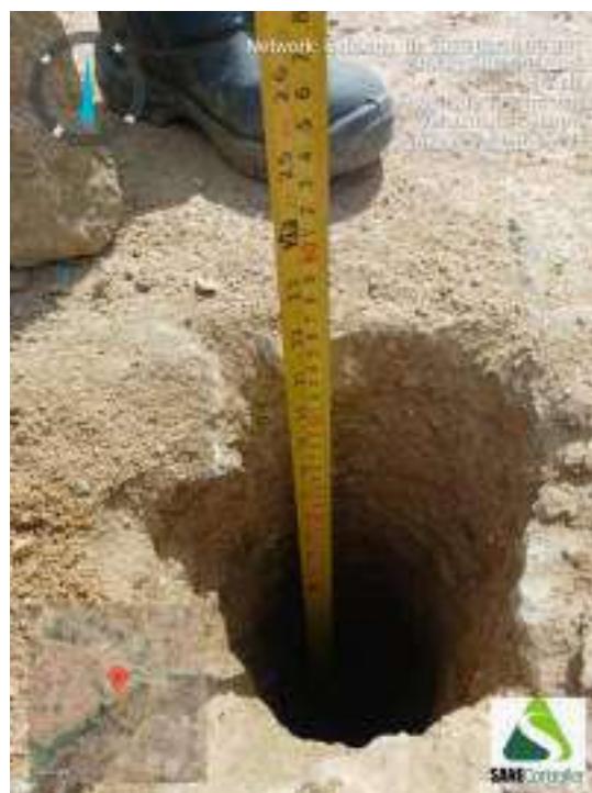
Figura 282 - Indicação da profundidade obtida durante o avanço da sondagem ST-71
