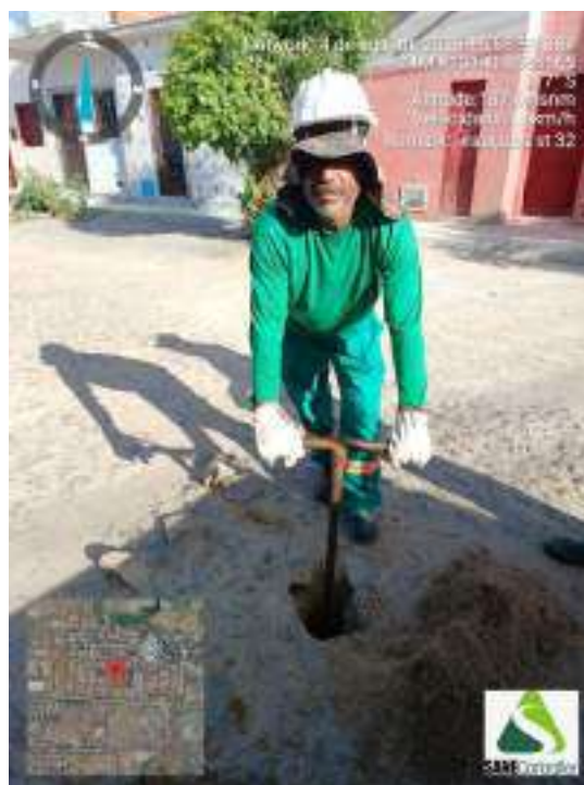
Figura 126 - Detalhe da equipe iniciando a sondagem ST-32.
