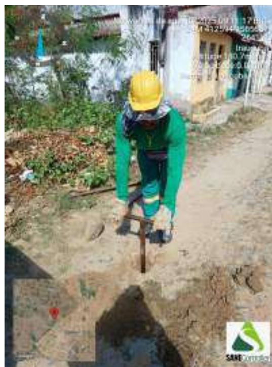
Figura 276 - Detalhe da equipe iniciando a sondagem ST-70
