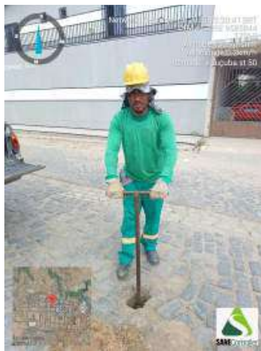
Figura 196 - Detalhe da equipe iniciando a sondagem ST-50
