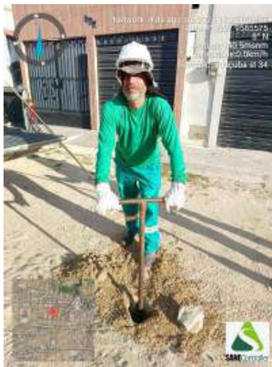
Figura 134 - Detalhe da equipe iniciando a sondagem ST-34
