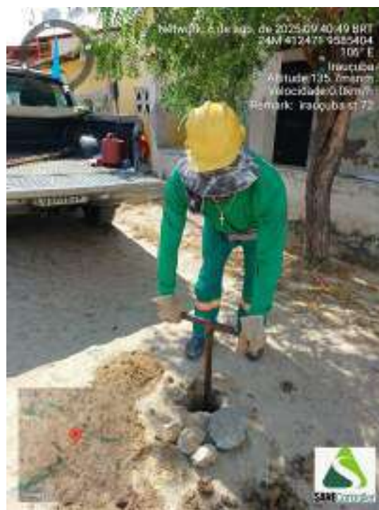
Figura 284 - Detalhe da equipe iniciando a sondagem ST-72
