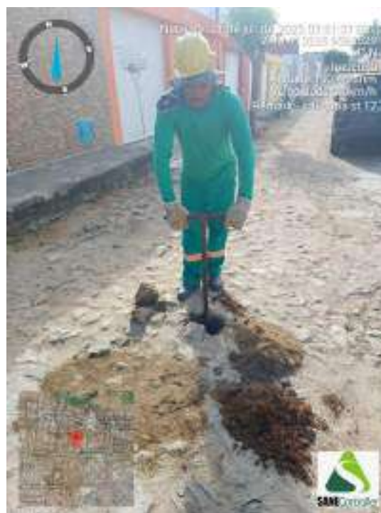
Figura 66 - Detalhe da equipe iniciando a sondagem ST-17
