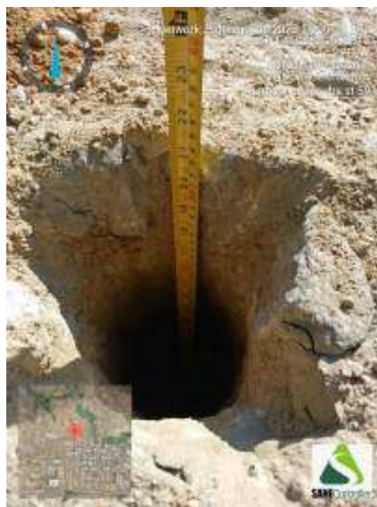
Figura 234 - Indicação da profundidade obtida durante o avanço da sondagem ST-59
