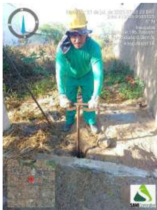
Figura 62 - Indicação da profundidade obtida durante o avanço da sondagem ST-16
