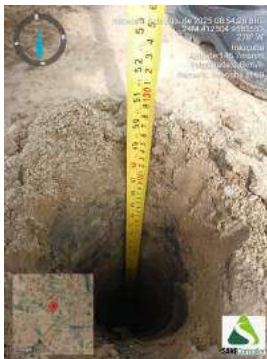
Figura 274 - Indicação da profundidade obtida durante o avanço da sondagem ST-69
