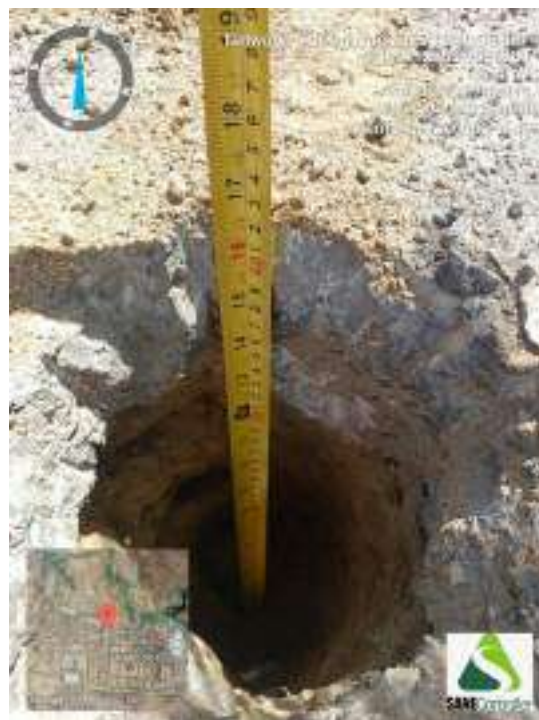
Figura 194 - Indicação da profundidade obtida durante o avanço da sondagem ST-49
