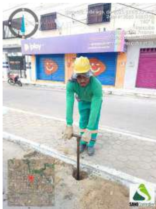
Figura 142 - Detalhe da equipe iniciando a sondagem ST-36
