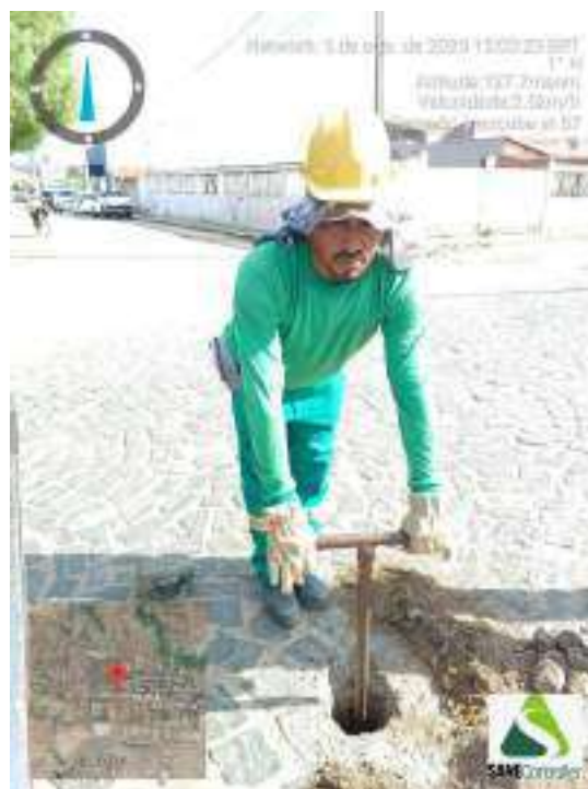
Figura 224 - Detalhe da equipe iniciando a sondagem ST-57
