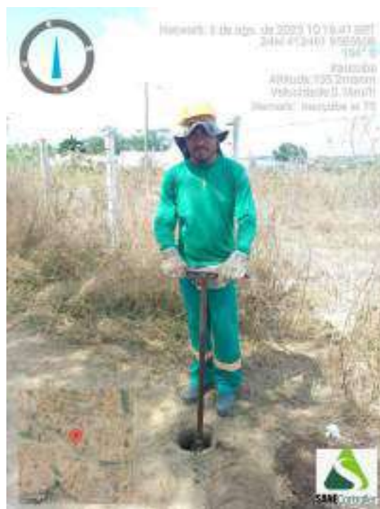
Figura 295 - Detalhe da equipe iniciando a sondagem ST-75
