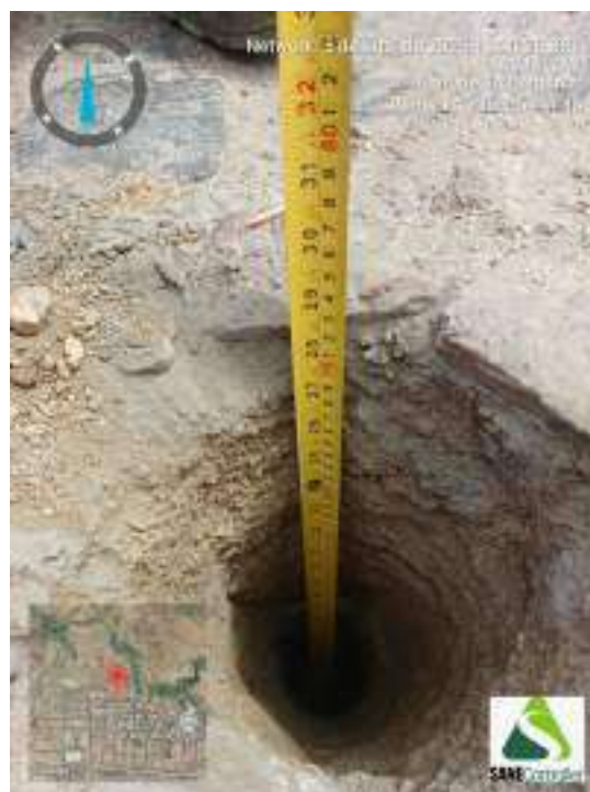
Figura 190 - Indicação da profundidade obtida durante o avanço da sondagem ST-48
