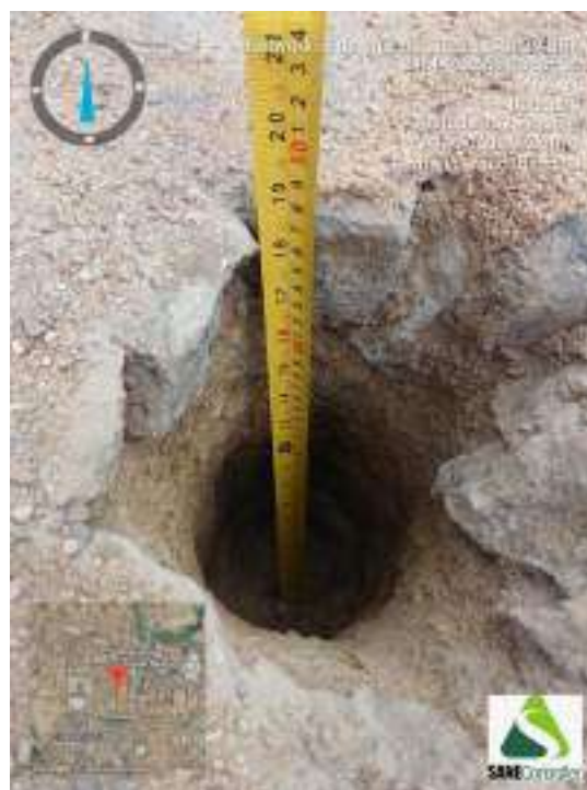
Figura 202 - Indicação da profundidade obtida durante o avanço da sondagem ST-51
