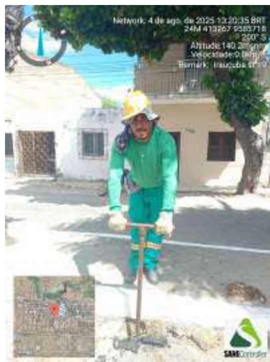
Figura 74 - Detalhe da equipe iniciando a sondagem ST-19
