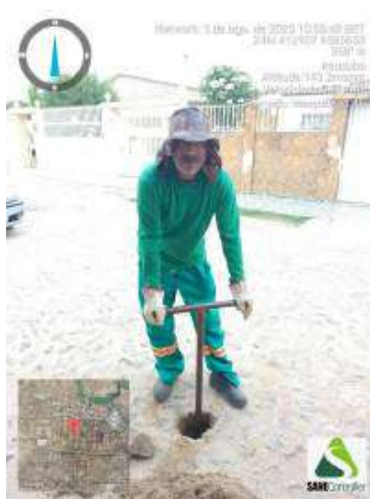
Figura 180 - Detalhe da equipe iniciando a sondagem ST-46
