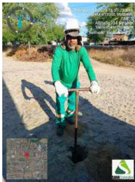
Figura 130 - Detalhe da equipe iniciando a sondagem ST-33
