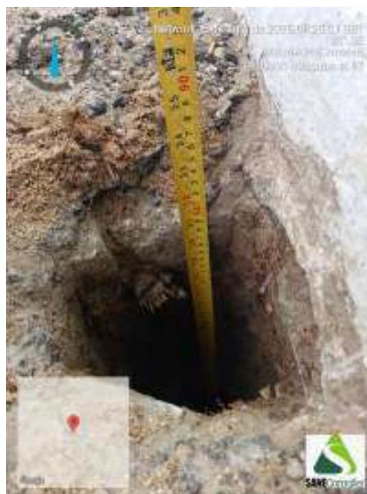
Figura 266 - Indicação da profundidade obtida durante o avanço da sondagem ST-67
