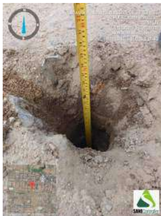
Figura 158 - Indicação da profundidade obtida durante o avanço da sondagem ST-40
