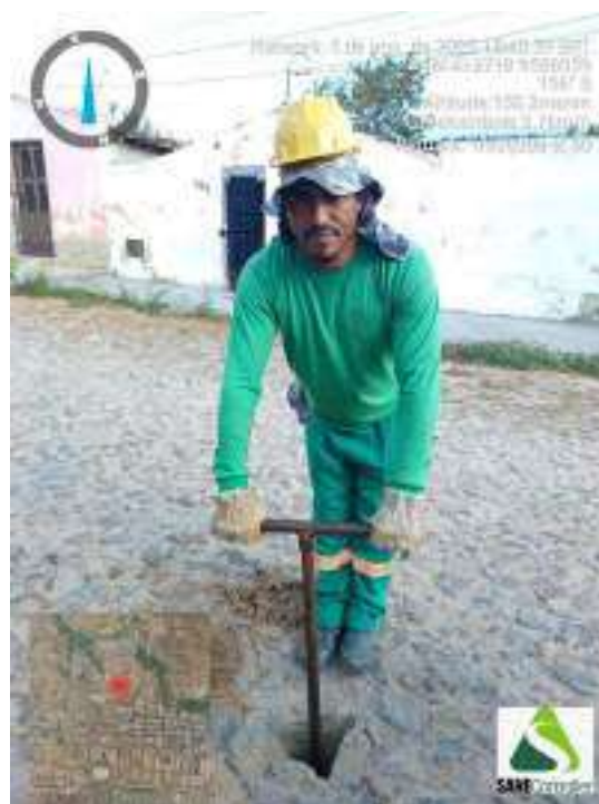
Figura 236 - Detalhe da equipe iniciando a sondagem ST-60
