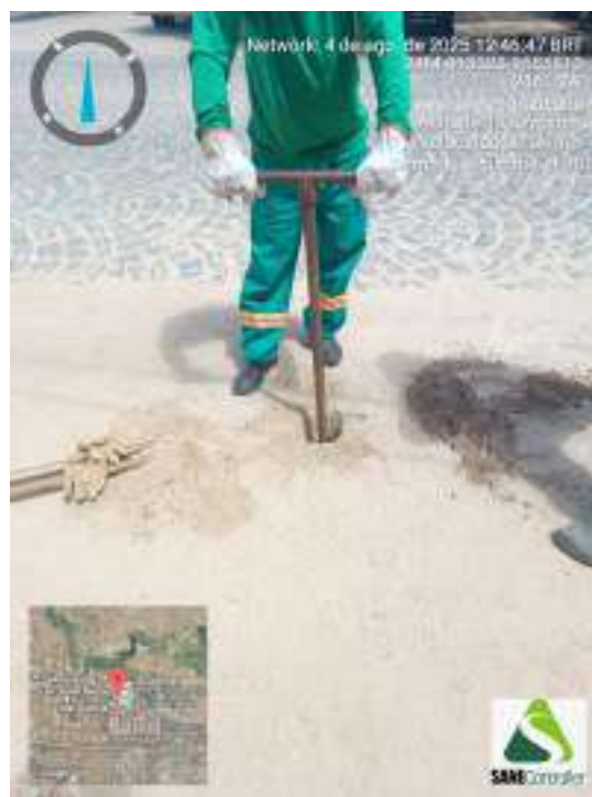
Figura 78 - Detalhe da equipe iniciando a sondagem ST-20
