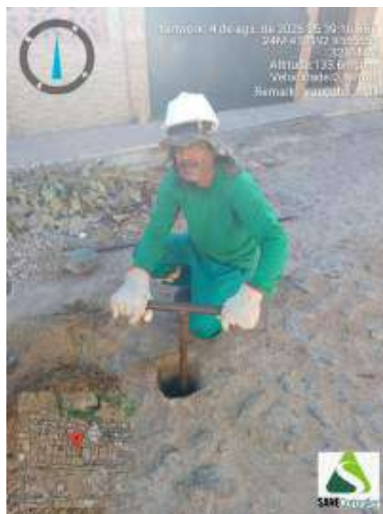
Figura 122 - Detalhe da equipe iniciando a sondagem ST-31.
