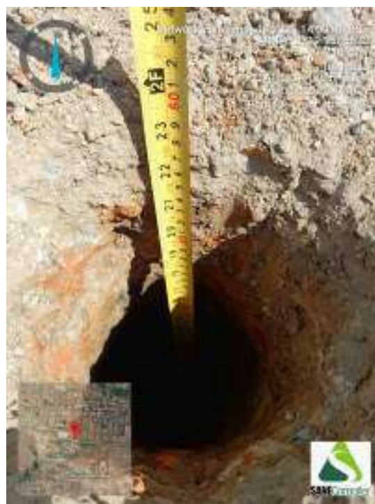
Figura 210 - Indicação da profundidade obtida durante o avanço da sondagem ST-53
