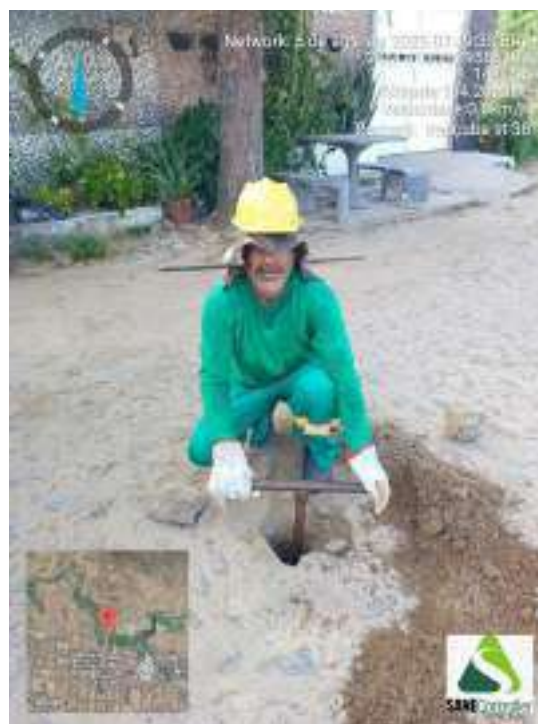
Figura 149 - Detalhe da equipe iniciando a sondagem ST-38
