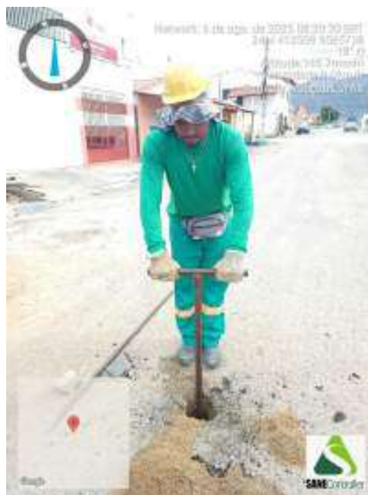
Figura 268 - Detalhe da equipe iniciando a sondagem ST-68
