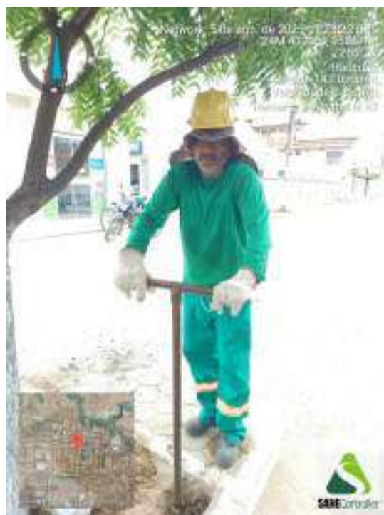
Figura 184 - Detalhe da equipe iniciando a sondagem ST-47
