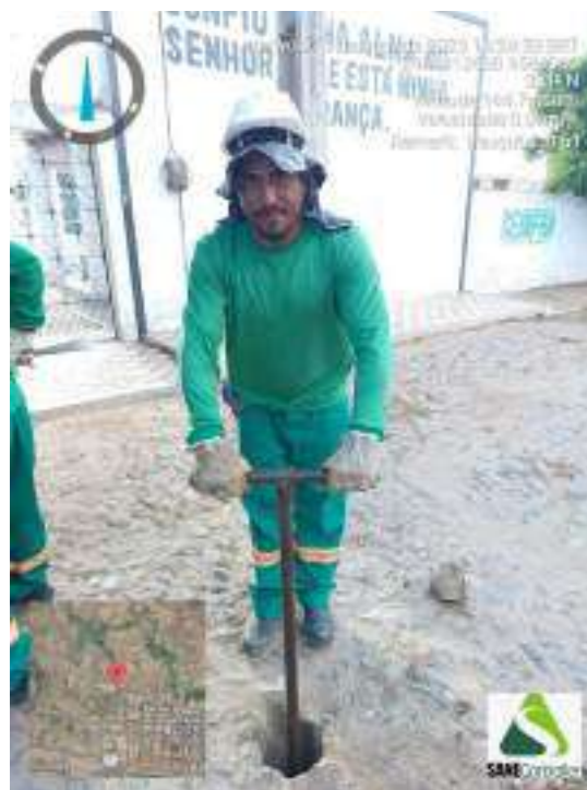
Figura 240 - Detalhe da equipe iniciando a sondagem ST-61
