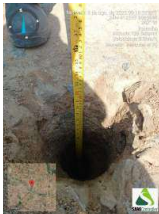
Figura 278 - Indicação da profundidade obtida durante o avanço da sondagem ST-70
