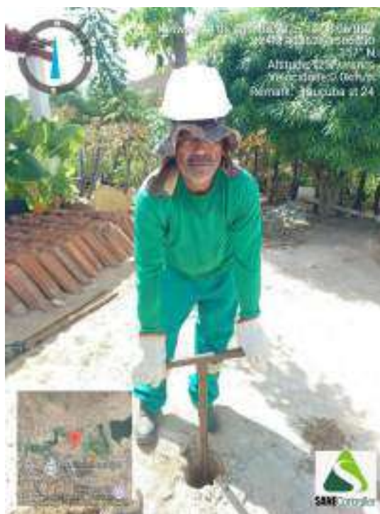
Figura 94 - Detalhe da equipe iniciando a sondagem ST-24
