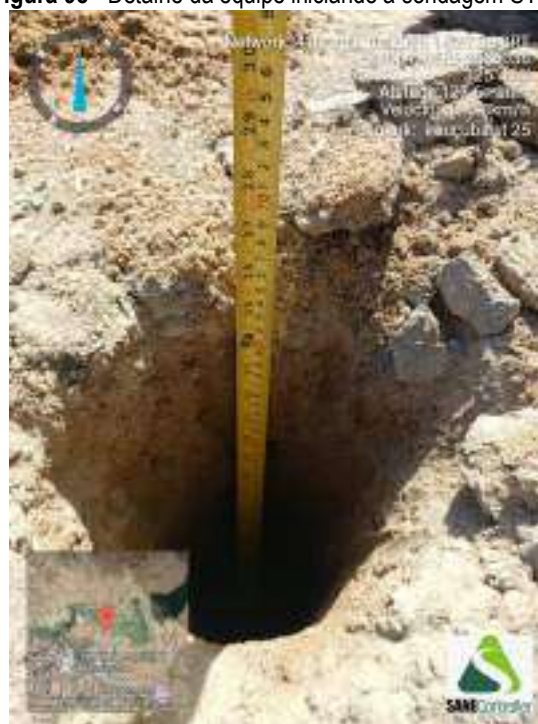
Figura 100 - Indicação da profundidade obtida durante o avanço da sondagem ST-25
