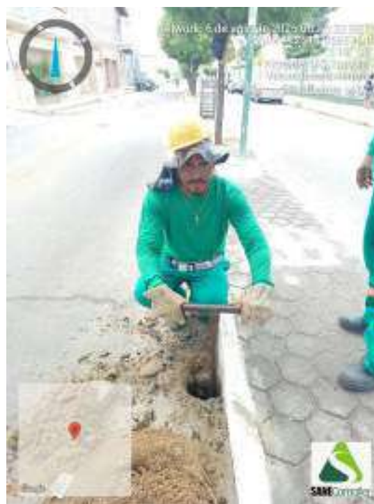
Figura 264 - Detalhe da equipe iniciando a sondagem ST-67
