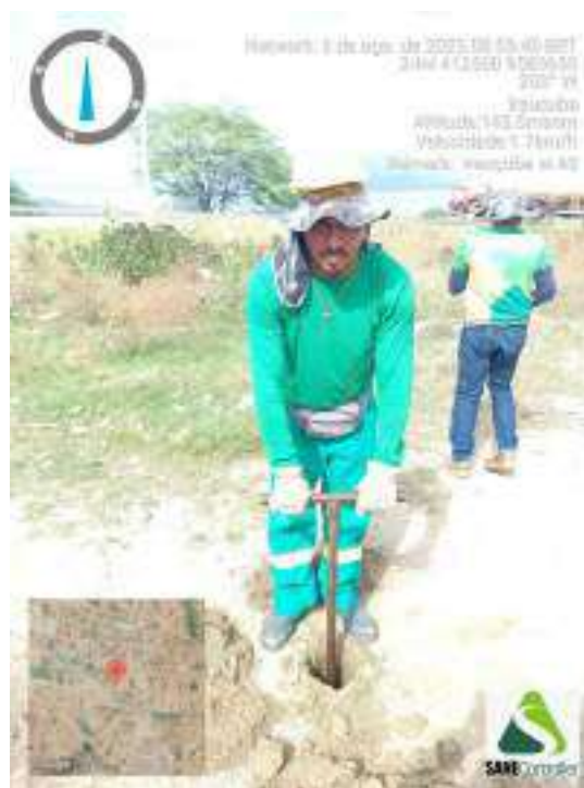
Figura 272 - Detalhe da equipe iniciando a sondagem ST-69
