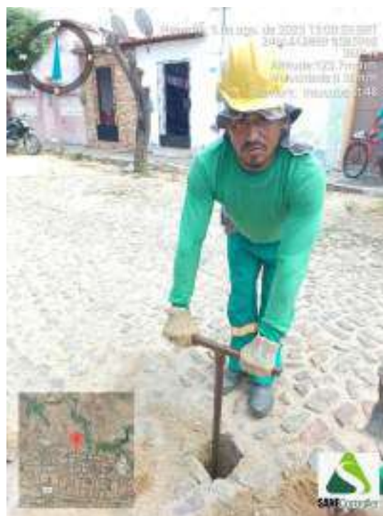
Figura 188 - Detalhe da equipe iniciando a sondagem ST-48
