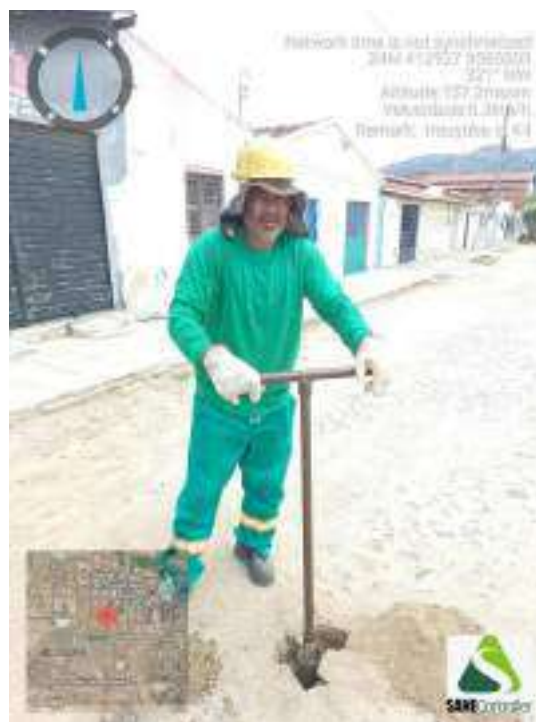
Figura 172 - Detalhe da equipe iniciando a sondagem ST-44
