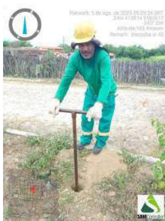
Figura 168 - Detalhe da equipe iniciando a sondagem ST-43
