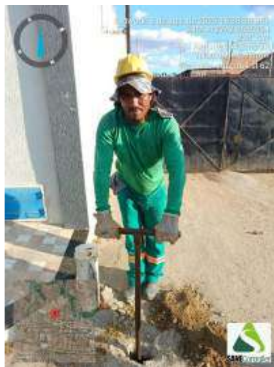
Figura 244 - Detalhe da equipe iniciando a sondagem ST-62
