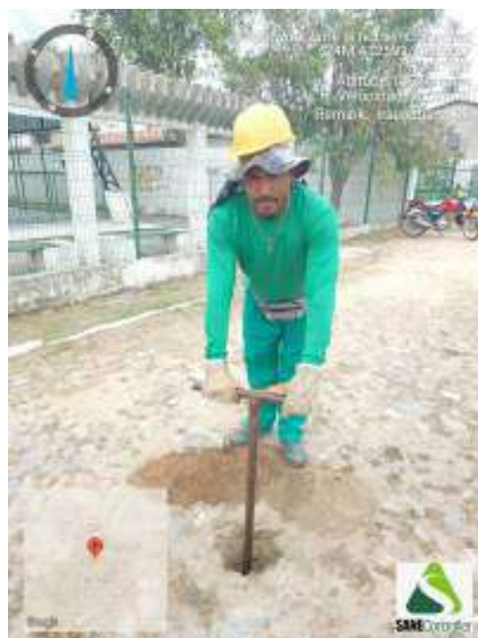
Figura 260 - Detalhe da equipe iniciando a sondagem ST-66
