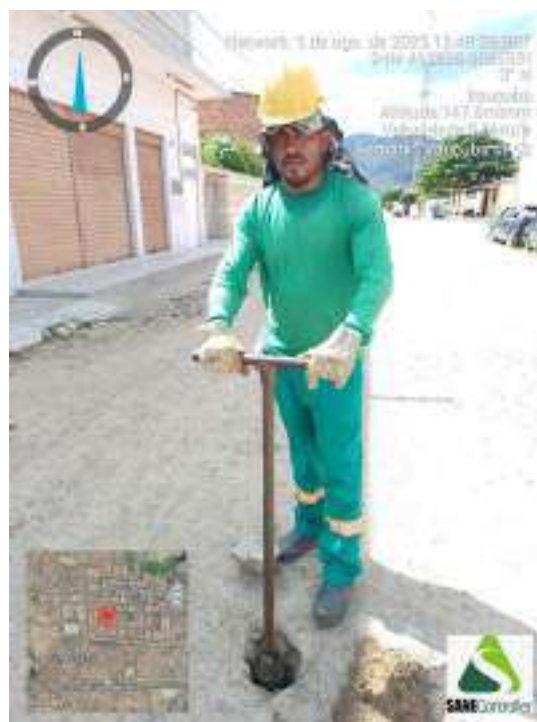
Figura 204 - Detalhe da equipe iniciando a sondagem ST-52
