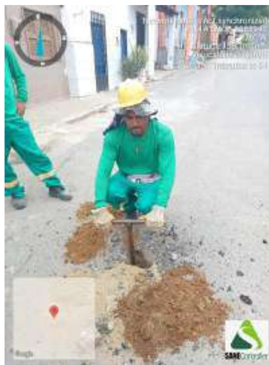
Figura 252 - Detalhe da equipe iniciando a sondagem ST-64
