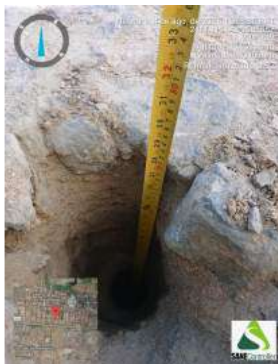
Figura 128 - Indicação da profundidade obtida durante o avanço da sondagem ST-32
