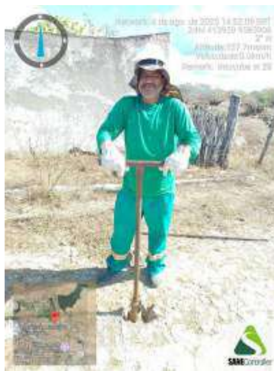
Figura 110 - Detalhe da equipe iniciando a sondagem ST-28
