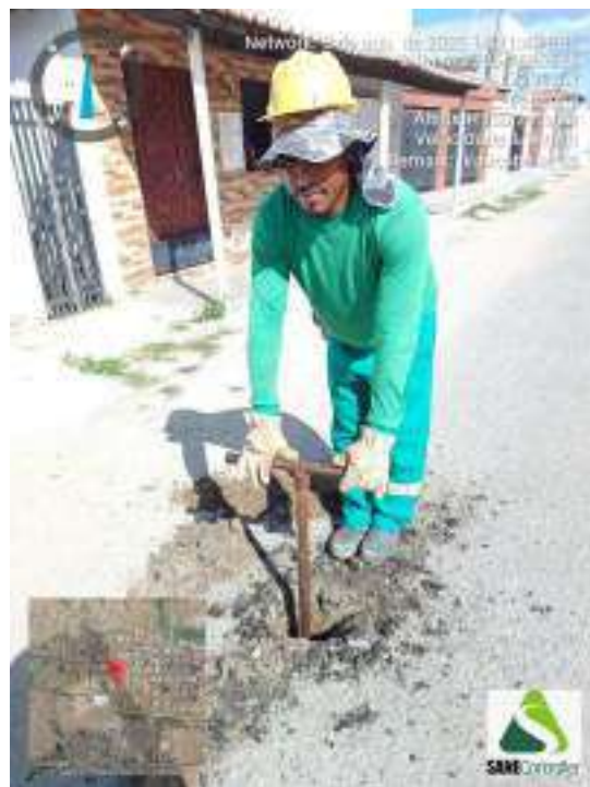
Figura 216 - Detalhe da equipe iniciando a sondagem ST-55
