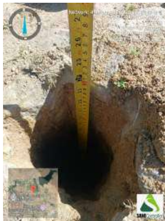
Figura 108 - Indicação da profundidade obtida durante o avanço da sondagem ST-27
