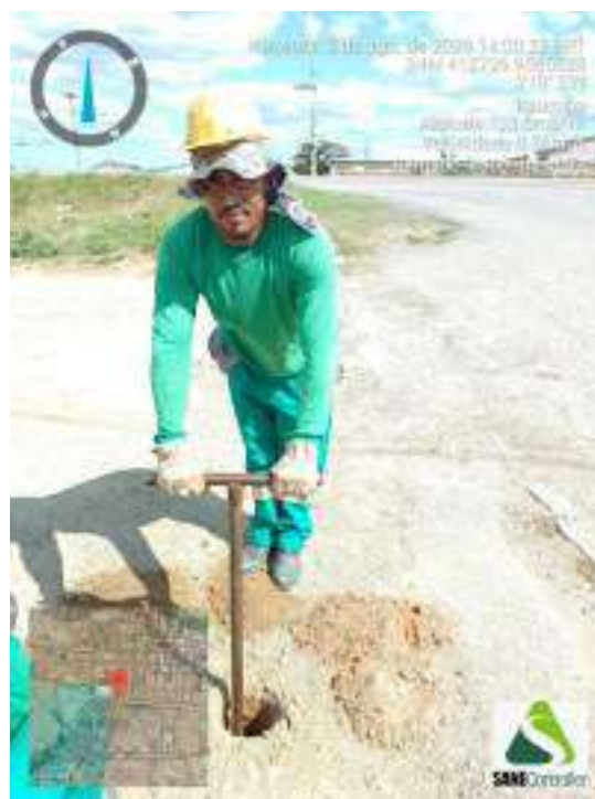
Figura 208 - Detalhe da equipe iniciando a sondagem ST-53
