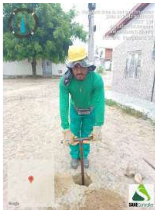
Figura 256 - Detalhe da equipe iniciando a sondagem ST-65
