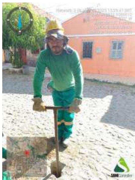
Figura 232 - Detalhe da equipe iniciando a sondagem ST-59
