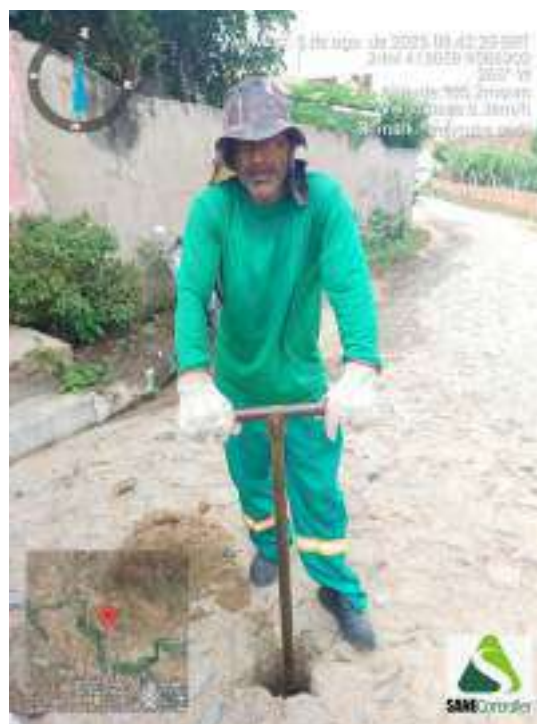
Figura 160 - Detalhe da equipe iniciando a sondagem ST-41
