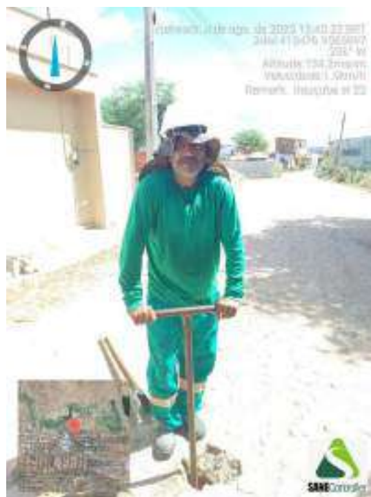
Figura 86 - Detalhe da equipe iniciando a sondagem ST-22
