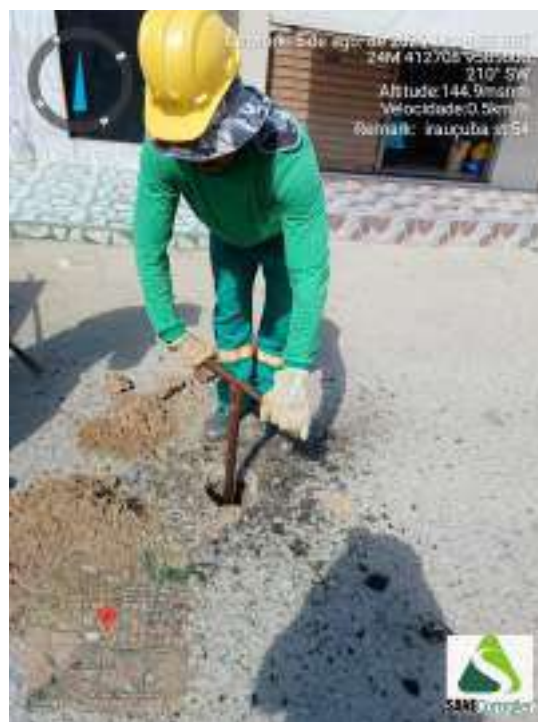
Figura 212 - Detalhe da equipe iniciando a sondagem ST-54
