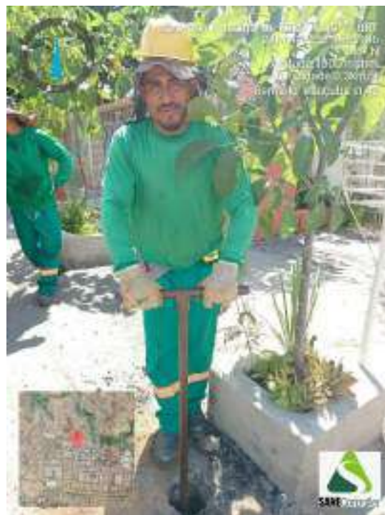
Figura 192 - Detalhe da equipe iniciando a sondagem ST-49
