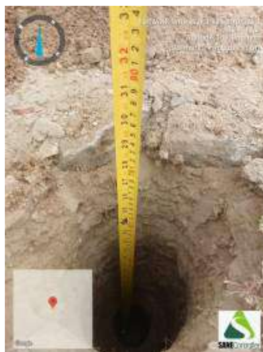
Figura 262 - Indicação da profundidade obtida durante o avanço da sondagem ST-66
