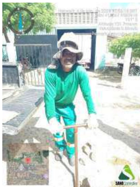
Figura 90 - Detalhe da equipe iniciando a sondagem ST-23
