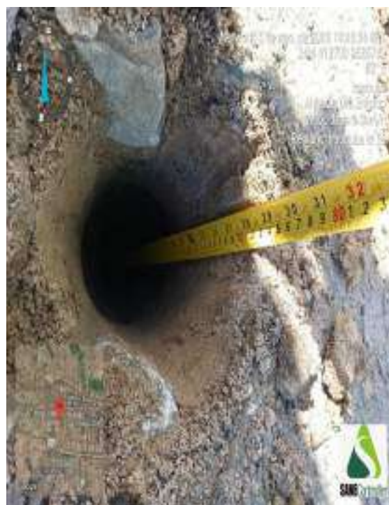
Figura 222 - Indicação da profundidade obtida durante o avanço da sondagem ST-56
