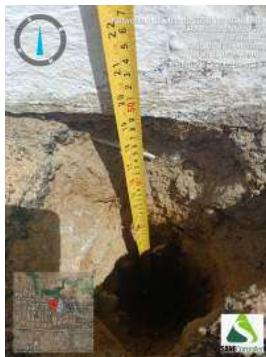
Figura 76 - Indicação da profundidade obtida durante o avanço da sondagem ST-19
