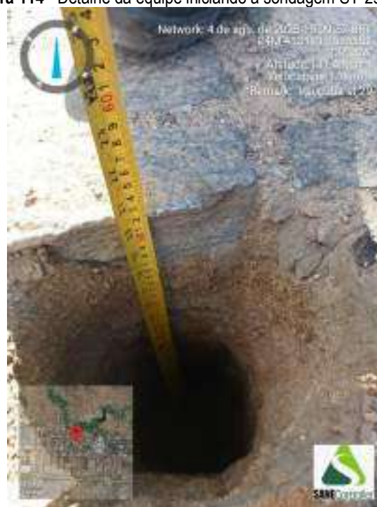
Figura 116 - Detalhe da equipe iniciando a sondagem ST-29
