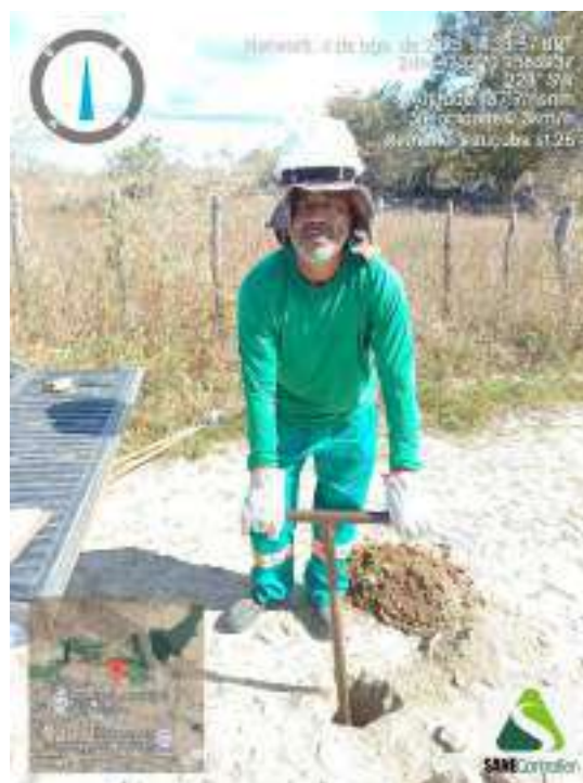
Figura 102 - Detalhe da equipe iniciando a sondagem ST-26
