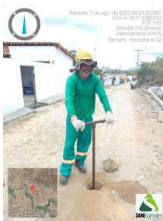
Figura 164 - Detalhe da equipe iniciando a sondagem ST-42
