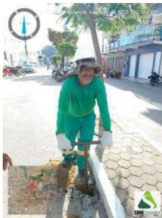
Figura 118 - Detalhe da equipe iniciando a sondagem ST-30.
