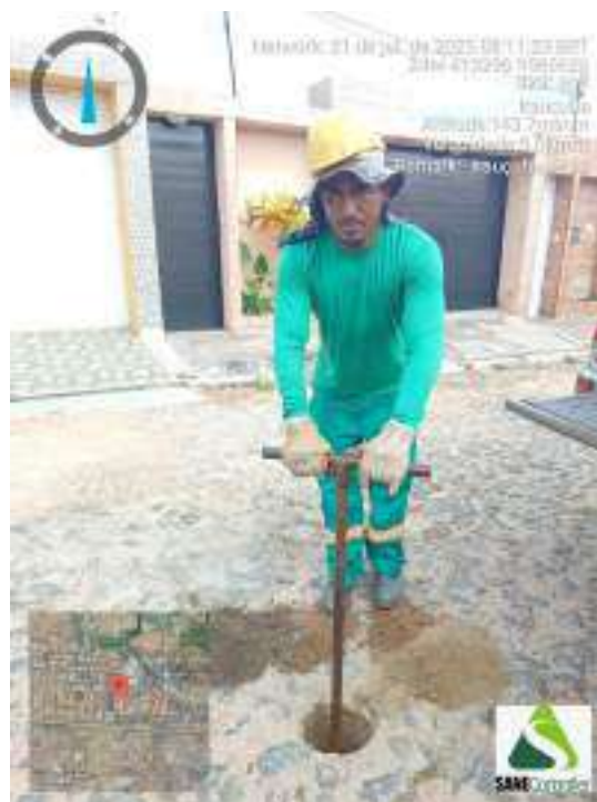
Figura 70 - Detalhe da equipe iniciando a sondagem ST-18
