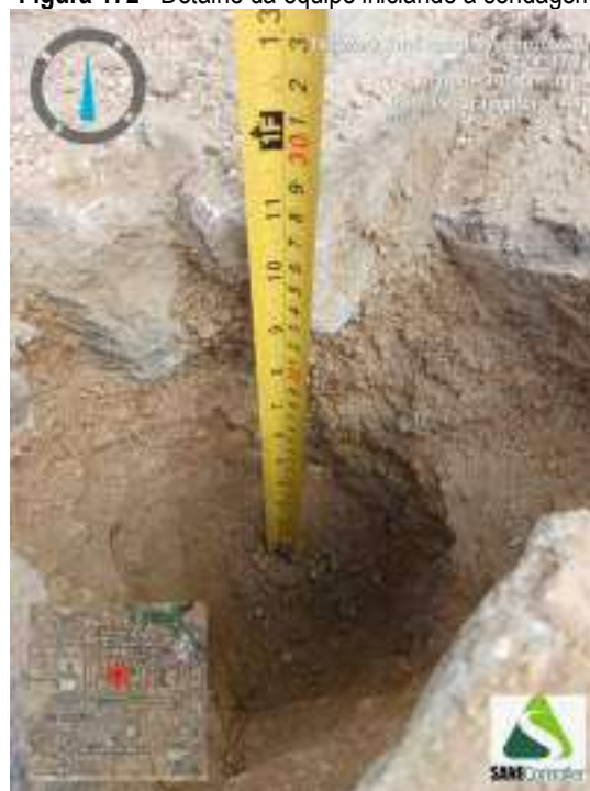
Figura 174 - Indicação da profundidade obtida durante o avanço da sondagem ST-44
