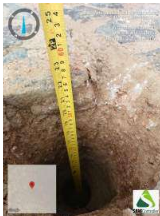
Figura 250 - Indicação da profundidade obtida durante o avanço da sondagem ST-63
