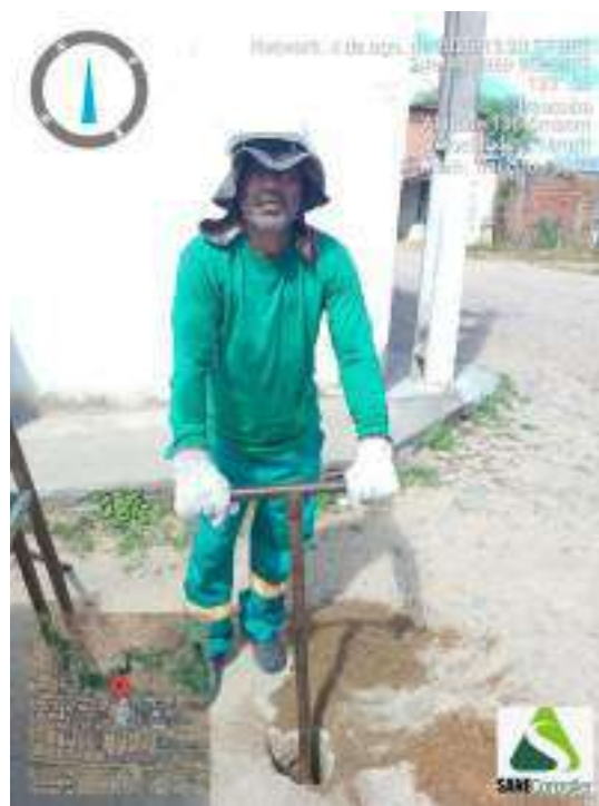
Figura 82 - Detalhe da equipe iniciando a sondagem ST-21
