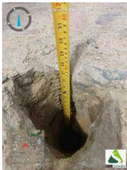
Figura 178 - Indicação da profundidade obtida durante o avanço da sondagem ST-45
