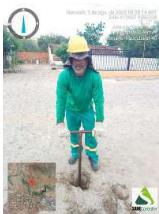
Figura 156 - Detalhe da equipe iniciando a sondagem ST-40
