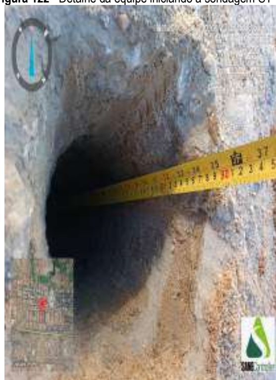
Figura 124 - Indicação da profundidade obtida durante o avanço da sondagem ST-31
