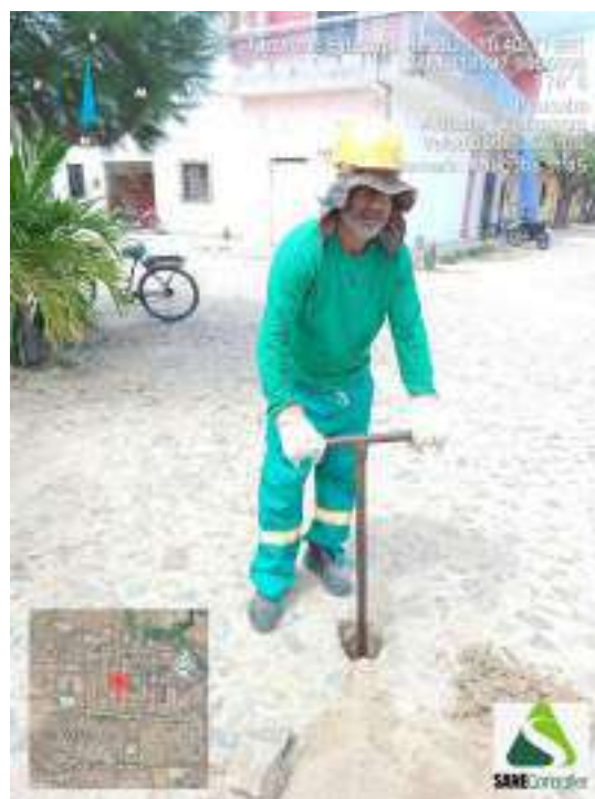
Figura 176 - Detalhe da equipe iniciando a sondagem ST-45
