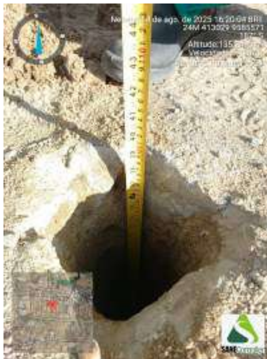
Figura 136 - Indicação da profundidade obtida durante o avanço da sondagem ST-34
