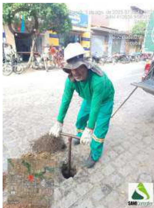
Figura 145 - Detalhe da equipe iniciando a sondagem ST-37
