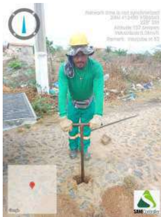
Figura 248 - Detalhe da equipe iniciando a sondagem ST-63
