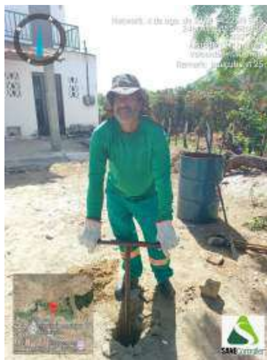
Figura 98 - Detalhe da equipe iniciando a sondagem ST-25
