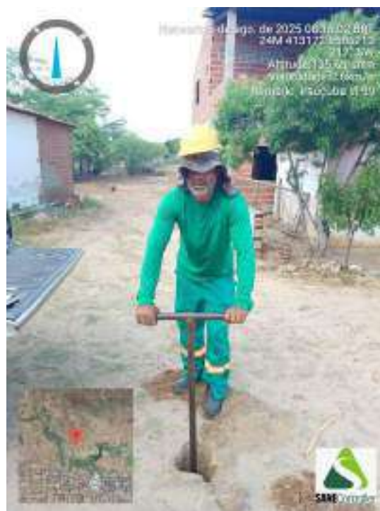
Figura 153 - Detalhe da equipe iniciando a sondagem ST-39
