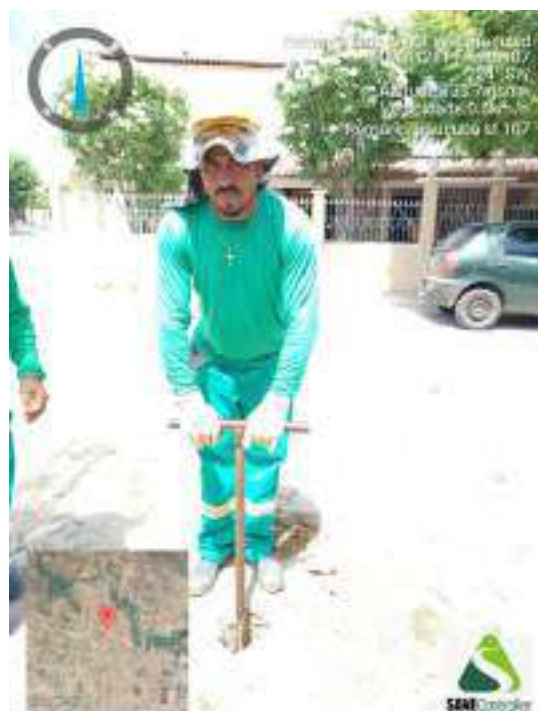
Figura 422 - Detalhe da equipe iniciando a sondagem do ST-107
