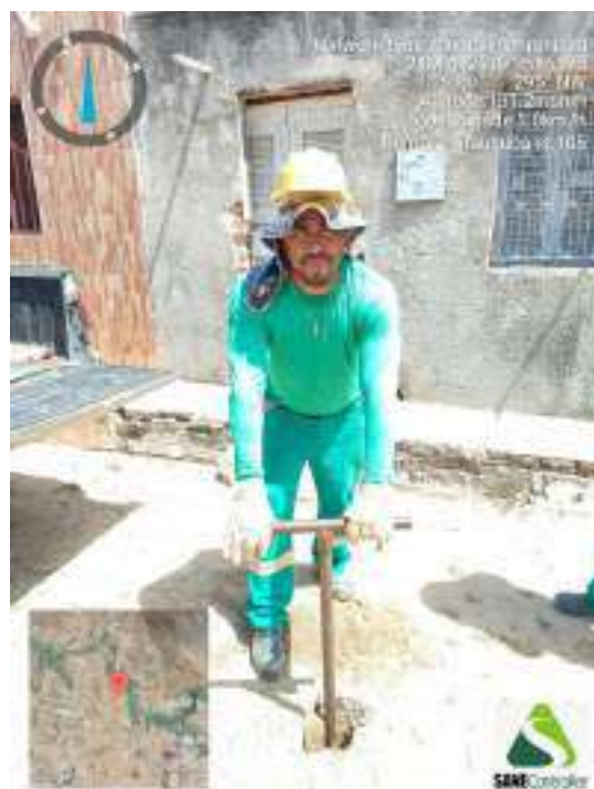
Figura 414 - Detalhe da equipe iniciando a sondagem do ST-105
