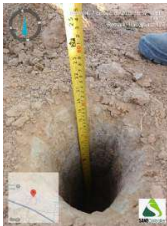
Figura 488 - Indicação da profundidade obtida durante o avanço da sondagem ST-123
