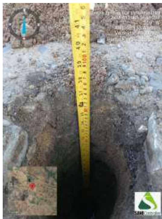
Figura 368 - Indicação da profundidade obtida durante o avanço da sondagem ST-93
