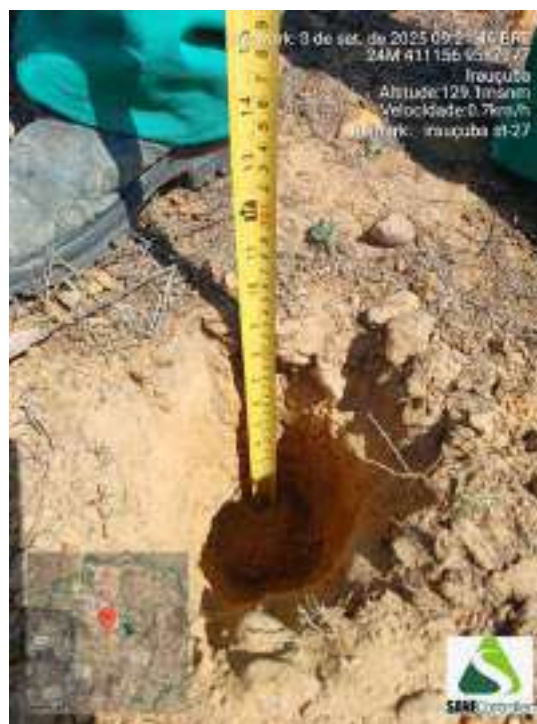
Figura 504 - Indicação da profundidade obtida durante o avanço da sondagem ST-127
