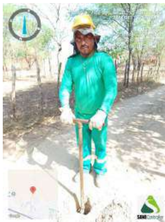
Figura 454 - Detalhe da equipe iniciando a sondagem do ST-115
