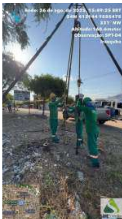
Figura 534 - Equipe iniciando a sondagem do SPT-04
