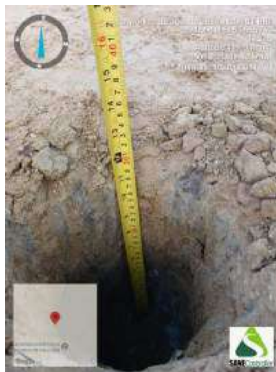
Figura 480 - Indicação da profundidade obtida durante o avanço da sondagem ST-121
