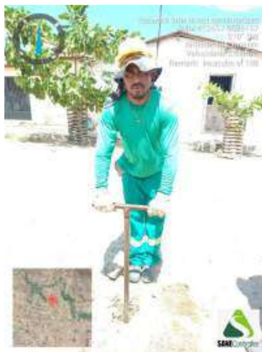
Figura 426 - Detalhe da equipe iniciando a sondagem do ST-108
