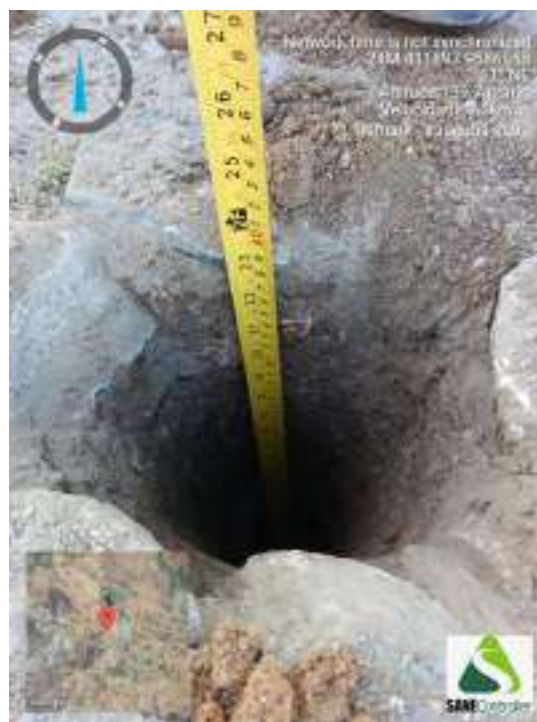
Figura 364 - Indicação da profundidade obtida durante o avanço da sondagem ST-92
