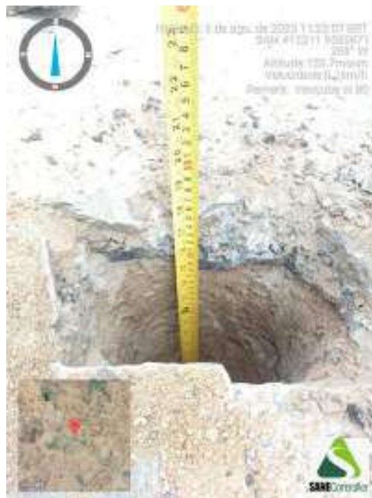
Figura 316 - Indicação da profundidade obtida durante o avanço da sondagem ST-80
