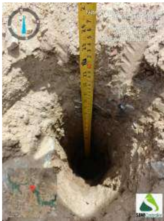
Figura 412 - Indicação da profundidade obtida durante o avanço da sondagem ST-104
