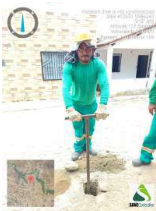
Figura 430 - Detalhe da equipe iniciando a sondagem do ST-109
