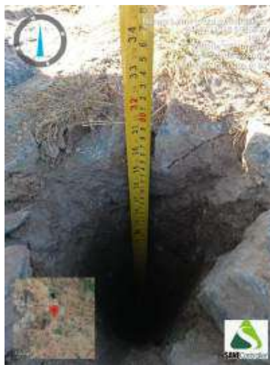
Figura 372 - Indicação da profundidade obtida durante o avanço da sondagem ST-94
