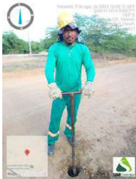
Figura 478 - Detalhe da equipe iniciando a sondagem do ST-121
