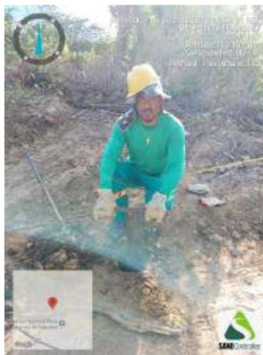
Figura 474 - Detalhe da equipe iniciando a sondagem do ST-120
