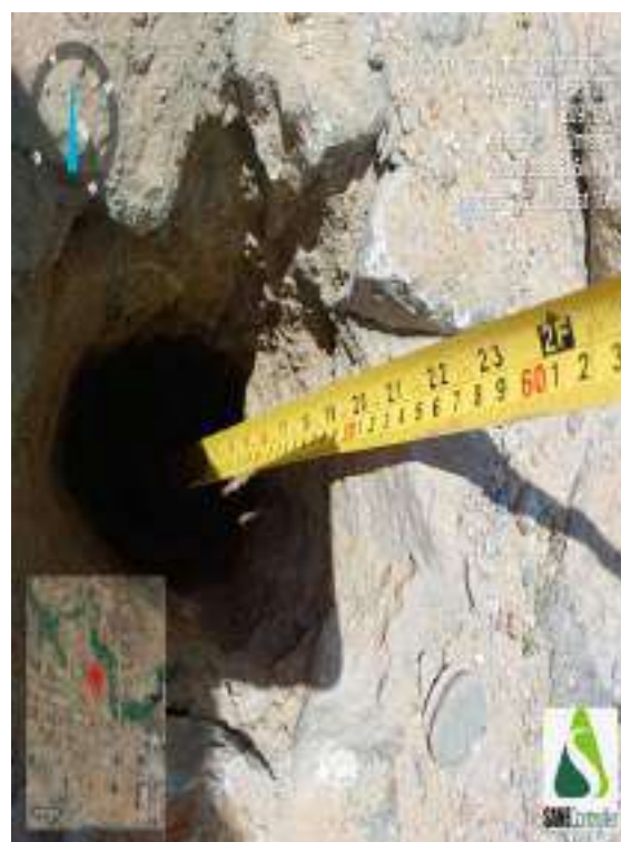
Figura 420 - Indicação da profundidade obtida durante o avanço da sondagem ST-106
