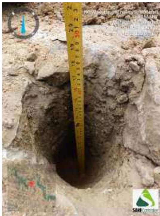
Figura 432 - Indicação da profundidade obtida durante o avanço da sondagem ST-109
