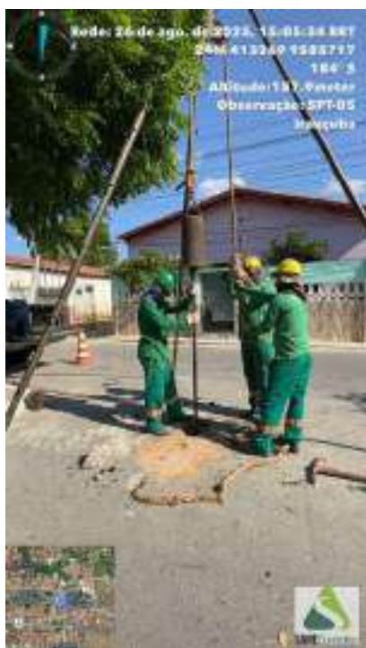
Figura 538 - Equipe avançando a sondagem do SPT-05
