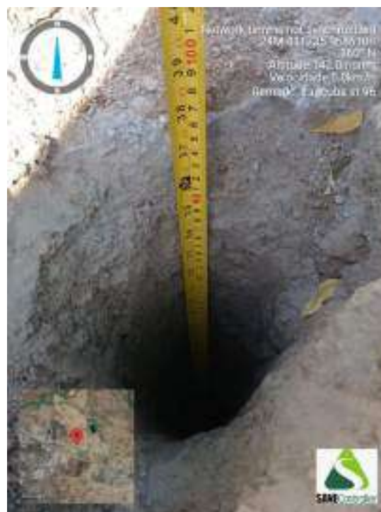
Figura 380 - Indicação da profundidade obtida durante o avanço da sondagem ST-96
