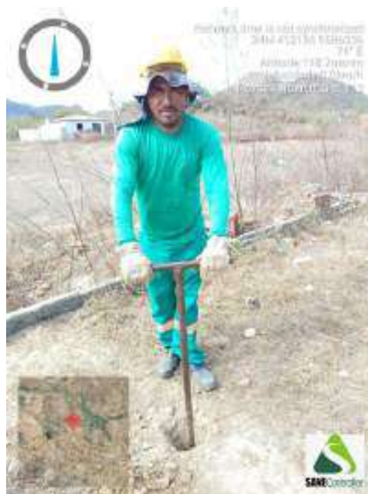
Figura 446 - Detalhe da equipe iniciando a sondagem do ST-113
