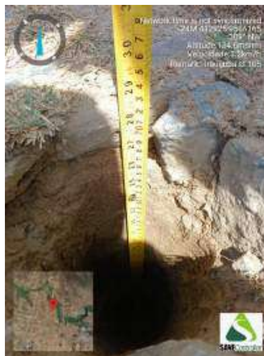
Figura 416 - Indicação da profundidade obtida durante o avanço da sondagem ST-105
