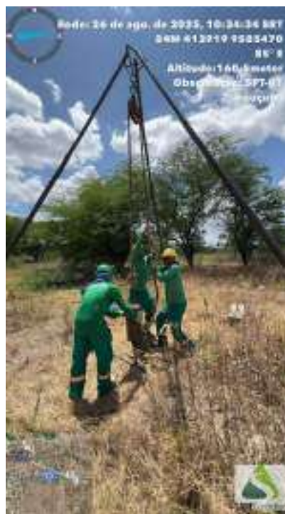
Figura 522 - Equipe iniciando a sondagem do SPT-01
