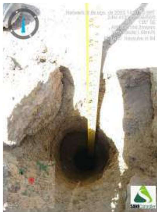
Figura 332 - Indicação da profundidade obtida durante o avanço da sondagem ST-84
