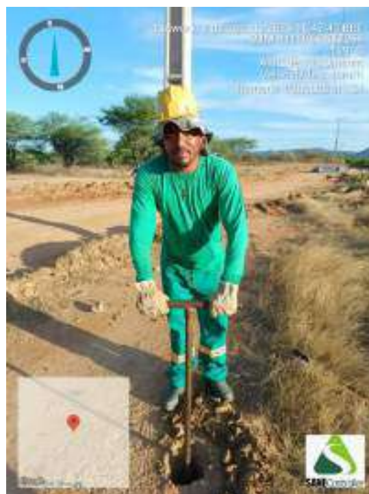
Figura 490 - Detalhe da equipe iniciando a sondagem do ST-124
