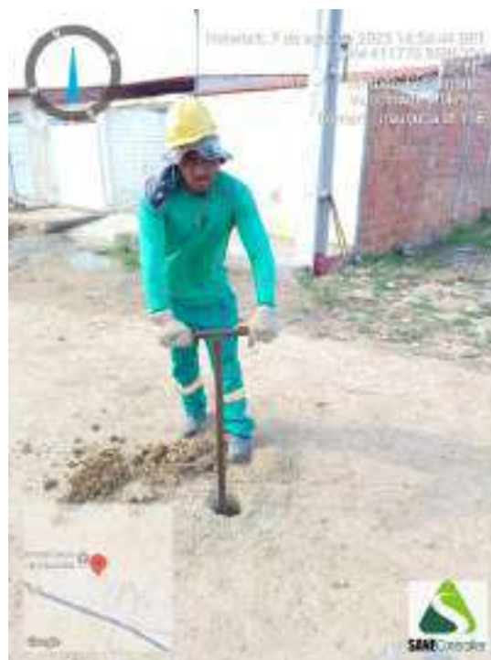
Figura 458 - Detalhe da equipe iniciando a sondagem do ST-116
