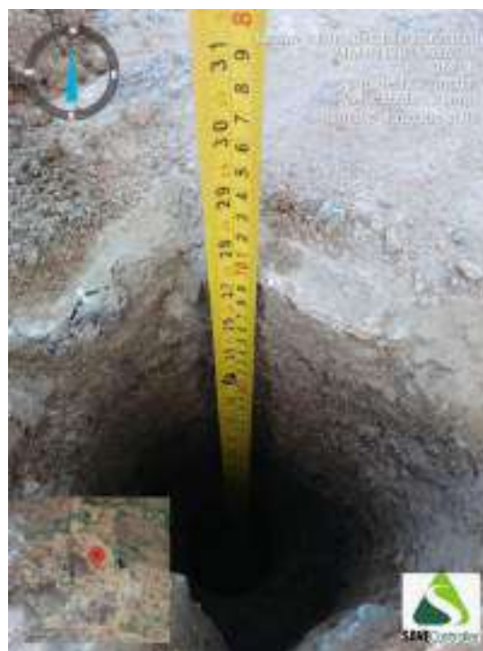
Figura 388 - Indicação da profundidade obtida durante o avanço da sondagem ST-98
