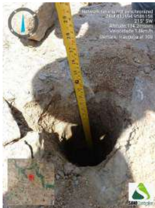
Figura 428 - Indicação da profundidade obtida durante o avanço da sondagem ST-108
