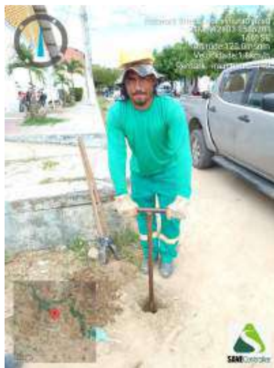
Figura 434 - Detalhe da equipe iniciando a sondagem do ST-110
