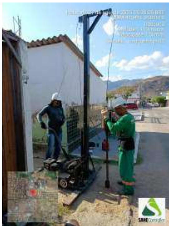
Figura 531 - Equipe avançando a sondagem do SPT-03
