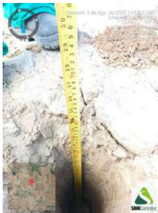
Figura 328 - Indicação da profundidade obtida durante o avanço da sondagem ST-83
