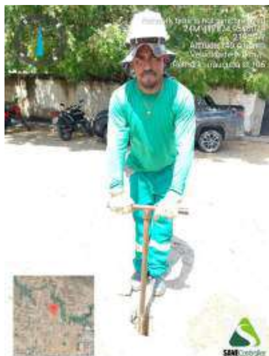
Figura 418 - Detalhe da equipe iniciando a sondagem do ST-106
