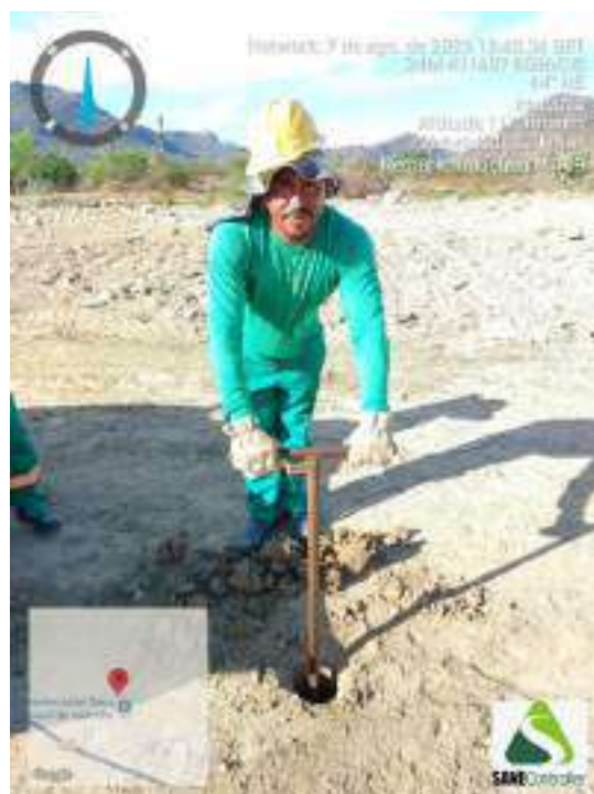
Figura 470 - Detalhe da equipe iniciando a sondagem do ST-119
