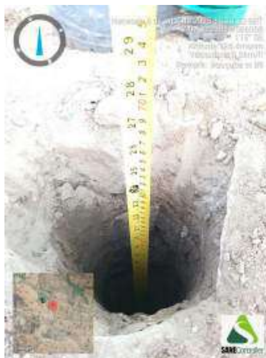
Figura 352 - Indicação da profundidade obtida durante o avanço da sondagem ST-89
