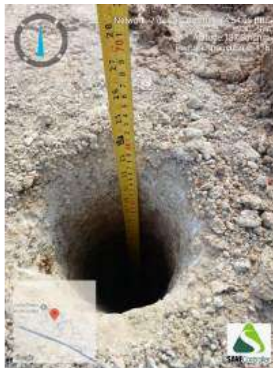
Figura 460 - Indicação da profundidade obtida durante o avanço da sondagem ST-116
