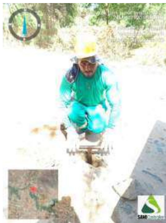
Figura 406 - Detalhe da equipe iniciando a sondagem do ST-103
