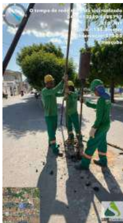
Figura 537 - Equipe iniciando a sondagem do SPT-05
