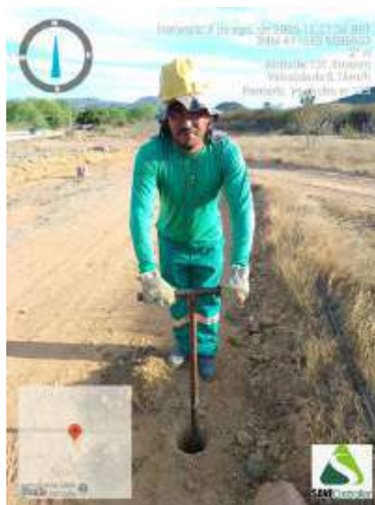
Figura 486 - Detalhe da equipe iniciando a sondagem do ST-123
