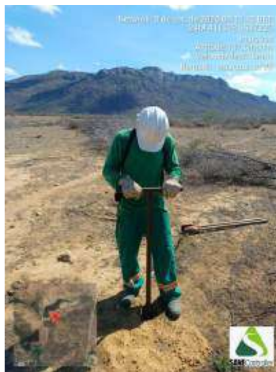
Figura 506 - Detalhe da equipe iniciando a sondagem do ST-128
