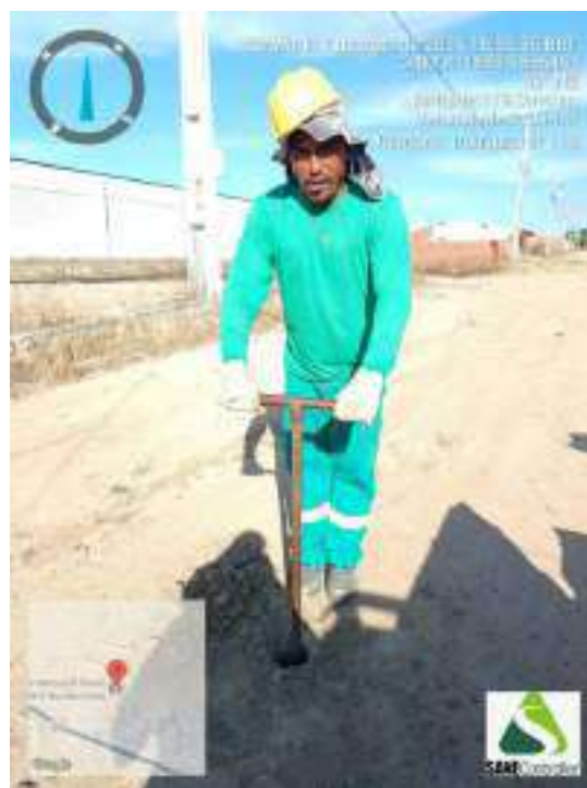
Figura 466 - Detalhe da equipe iniciando a sondagem do ST-118
