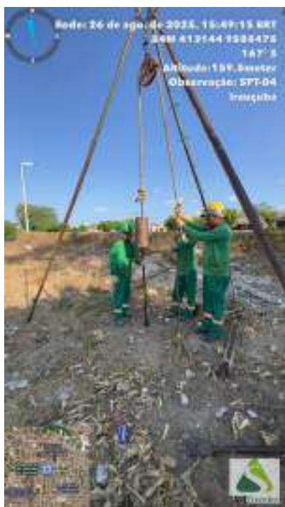
Figura 535 - Equipe avançando a sondagem do SPT-04
