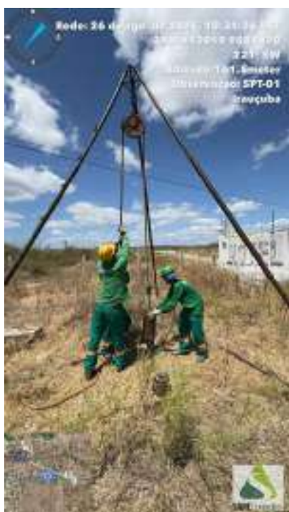
Figura 523 - Equipe avançando a sondagem SPT-01
