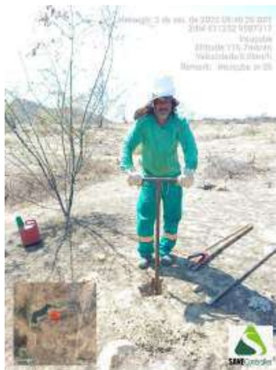
Figura 498 - Detalhe da equipe iniciando a sondagem do ST-126
