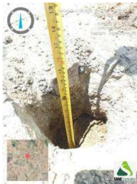
Figura 312 - Indicação da profundidade obtida durante o avanço da sondagem ST-79
