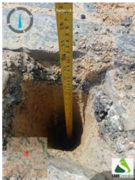
Figura 304 - Indicação da profundidade obtida durante o avanço da sondagem ST-77
