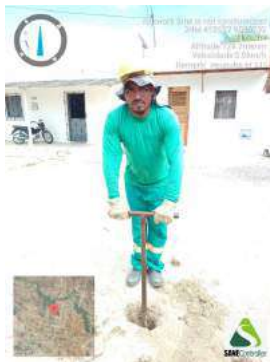
Figura 438 - Detalhe da equipe iniciando a sondagem do ST-111
