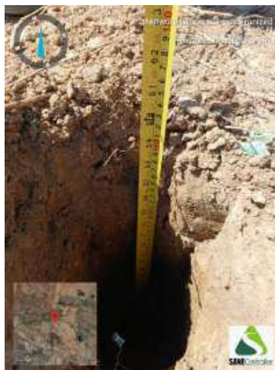
Figura 404 - Indicação da profundidade obtida durante o avanço da sondagem ST-102
