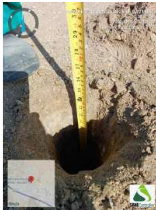
Figura 464 - Indicação da profundidade obtida durante o avanço da sondagem ST-117
