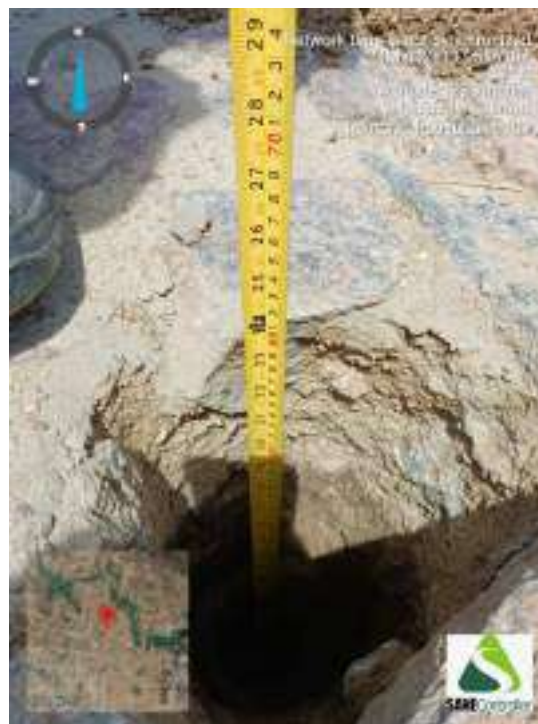
Figura 424 - Indicação da profundidade obtida durante o avanço da sondagem ST-107
