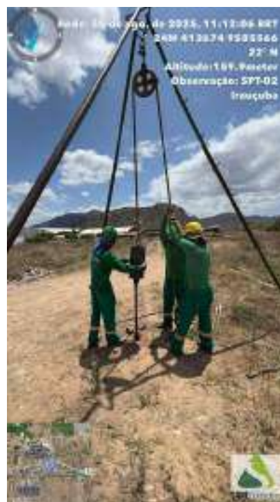
Figura 526 - Equipe iniciando a sondagem do SPT-02
