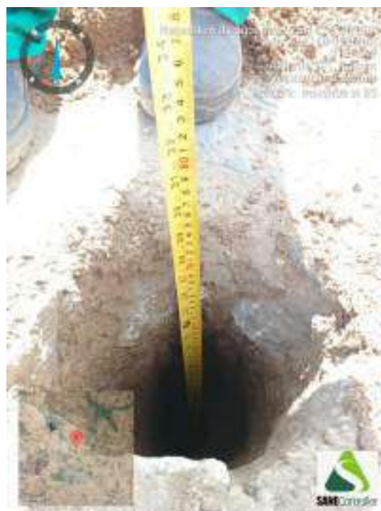
Figura 336 - Indicação da profundidade obtida durante o avanço da sondagem ST-85
