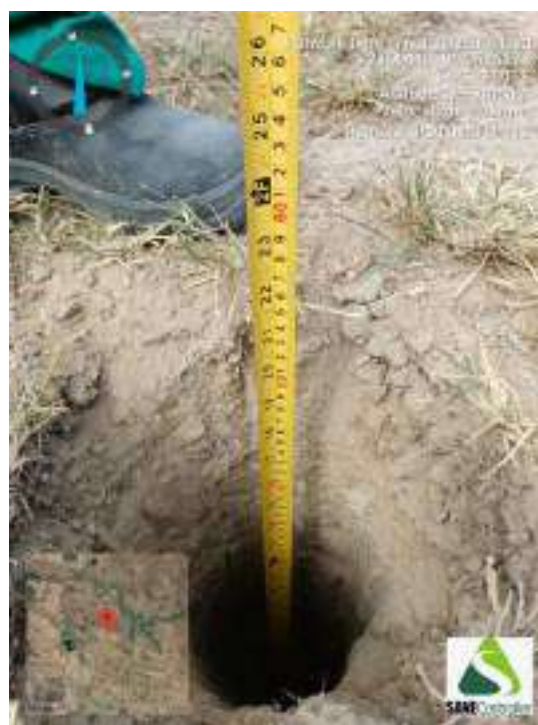
Figura 444 - Indicação da profundidade obtida durante o avanço da sondagem ST-112
