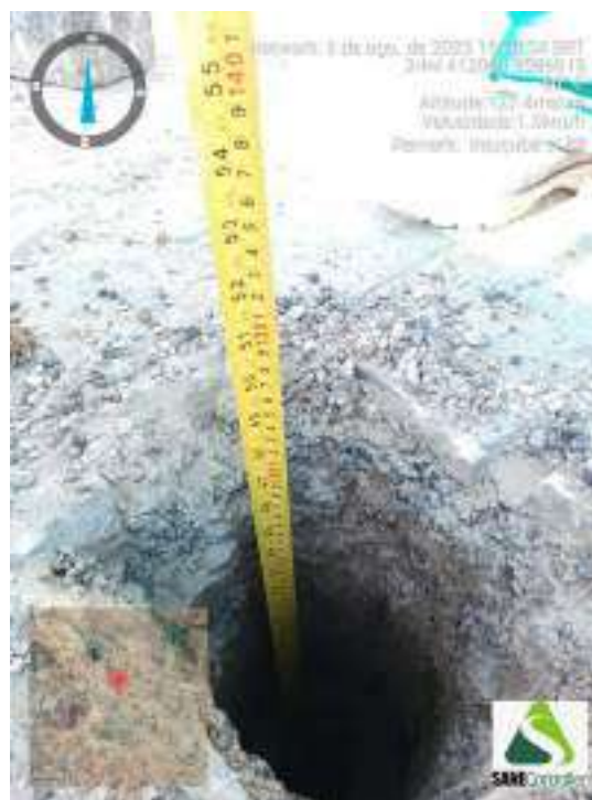
Figura 348 - Indicação da profundidade obtida durante o avanço da sondagem ST-88
