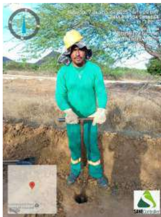
Figura 482 - Detalhe da equipe iniciando a sondagem do ST-122
