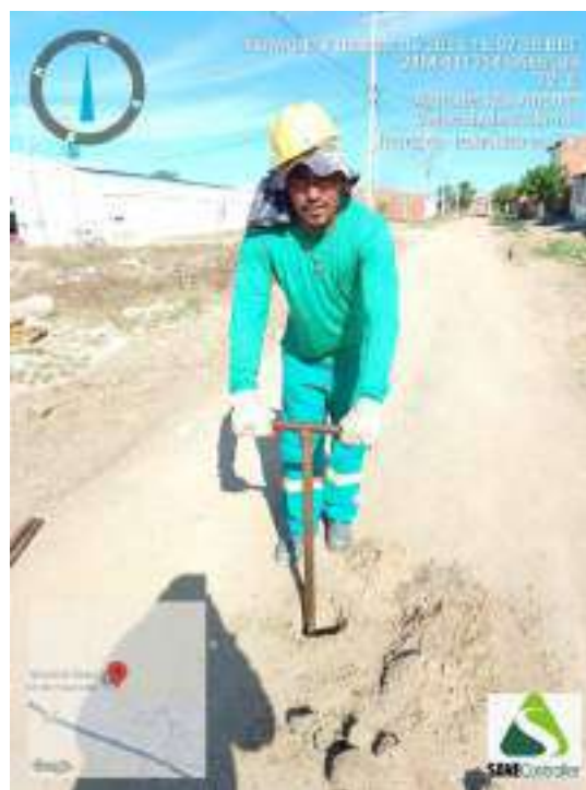
Figura 462 - Detalhe da equipe iniciando a sondagem do ST-117
