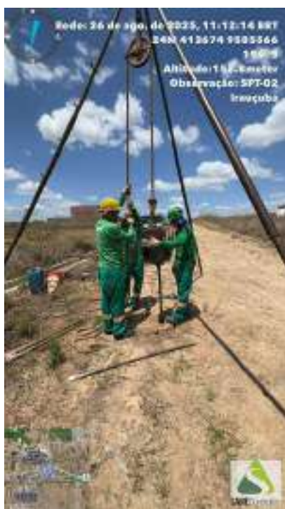
Figura 527 - Equipe avançando a sondagem do SPT-02
