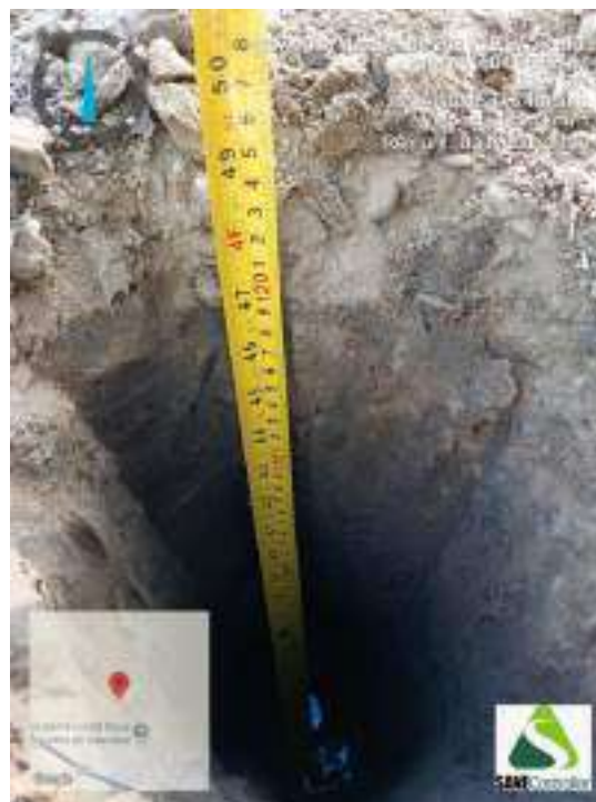
Figura 476 - Indicação da profundidade obtida durante o avanço da sondagem ST-120
