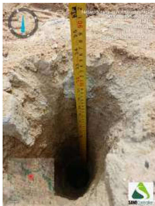
Figura 440 - Indicação da profundidade obtida durante o avanço da sondagem ST-111
