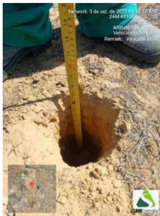
Figura 508 - Indicação da profundidade obtida durante o avanço da sondagem ST-128
