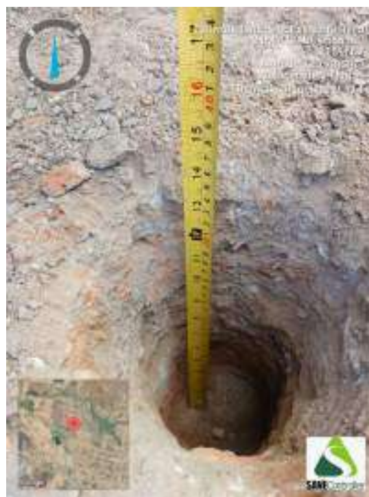
Figura 452 - Indicação da profundidade obtida durante o avanço da sondagem ST-114
