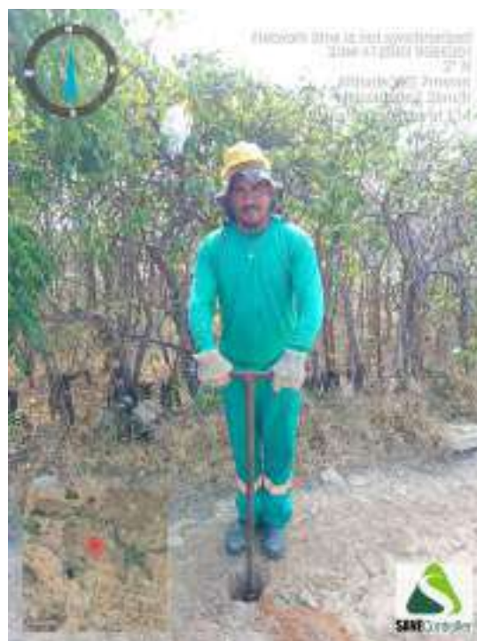
Figura 450 - Detalhe da equipe iniciando a sondagem do ST-114
