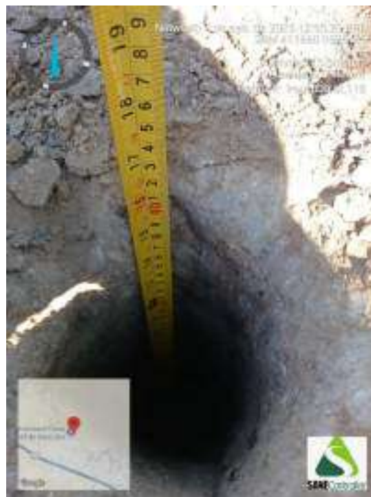
Figura 468 - Indicação da profundidade obtida durante o avanço da sondagem ST-118
