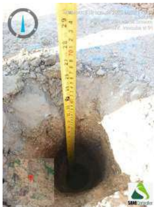
Figura 360 - Indicação da profundidade obtida durante o avanço da sondagem ST-91
