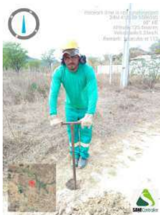
Figura 442 - Detalhe da equipe iniciando a sondagem do ST-112
