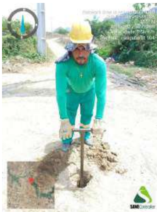
Figura 410 - Detalhe da equipe iniciando a sondagem do ST-104
