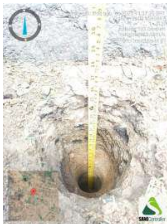
Figura 320 - Indicação da profundidade obtida durante o avanço da sondagem ST-81
