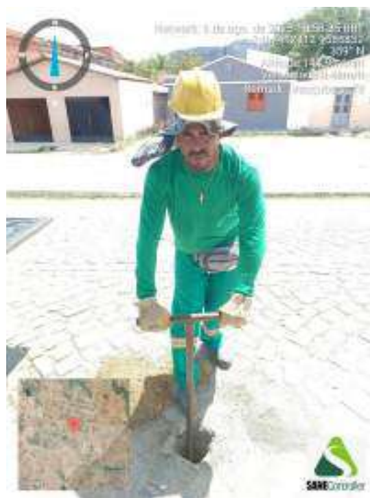
Figura 306 - Indicação da profundidade obtida durante o avanço da sondagem ST-78
