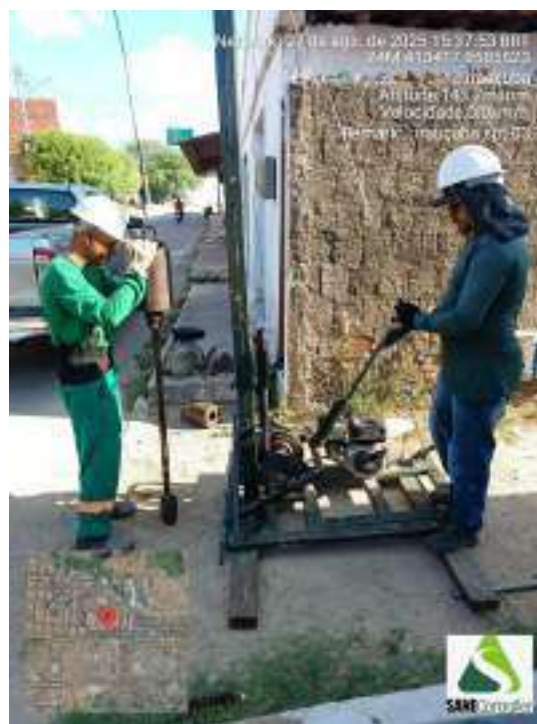
Figura 530 - Equipe iniciando a sondagem do SPT-03
