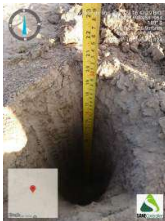
Figura 492 - Indicação da profundidade obtida durante o avanço da sondagem ST-124
