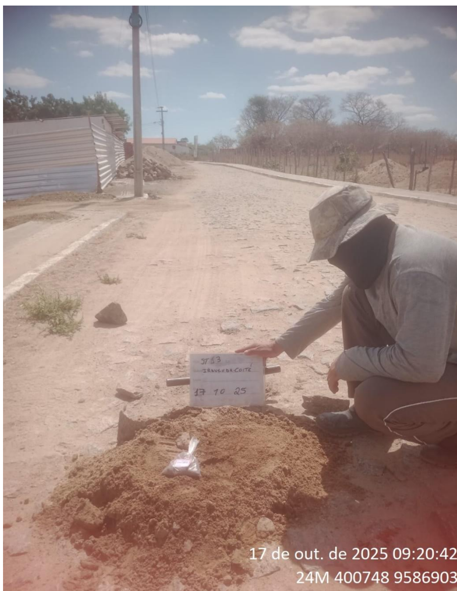
Instalação do furo 2.ST-13
