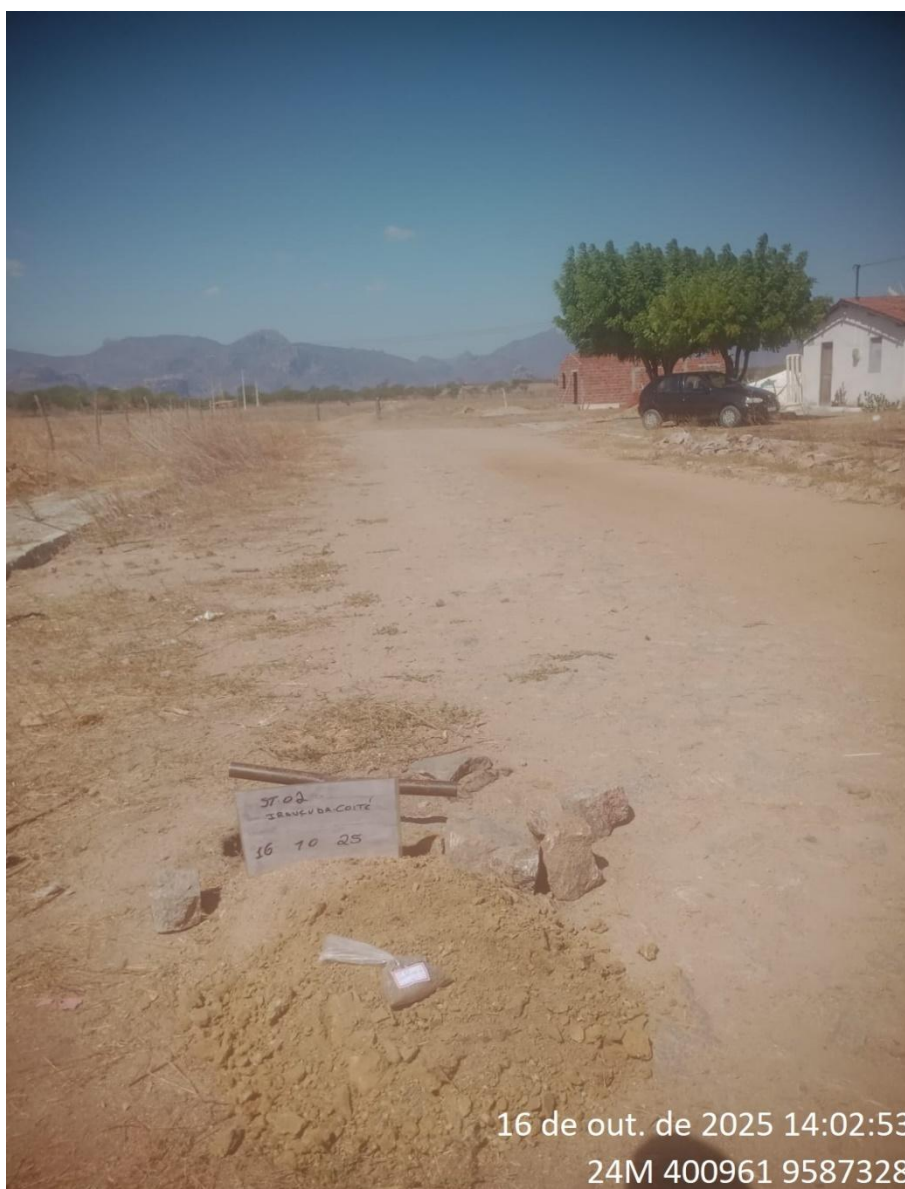
Instalação do furo 2.ST-02
