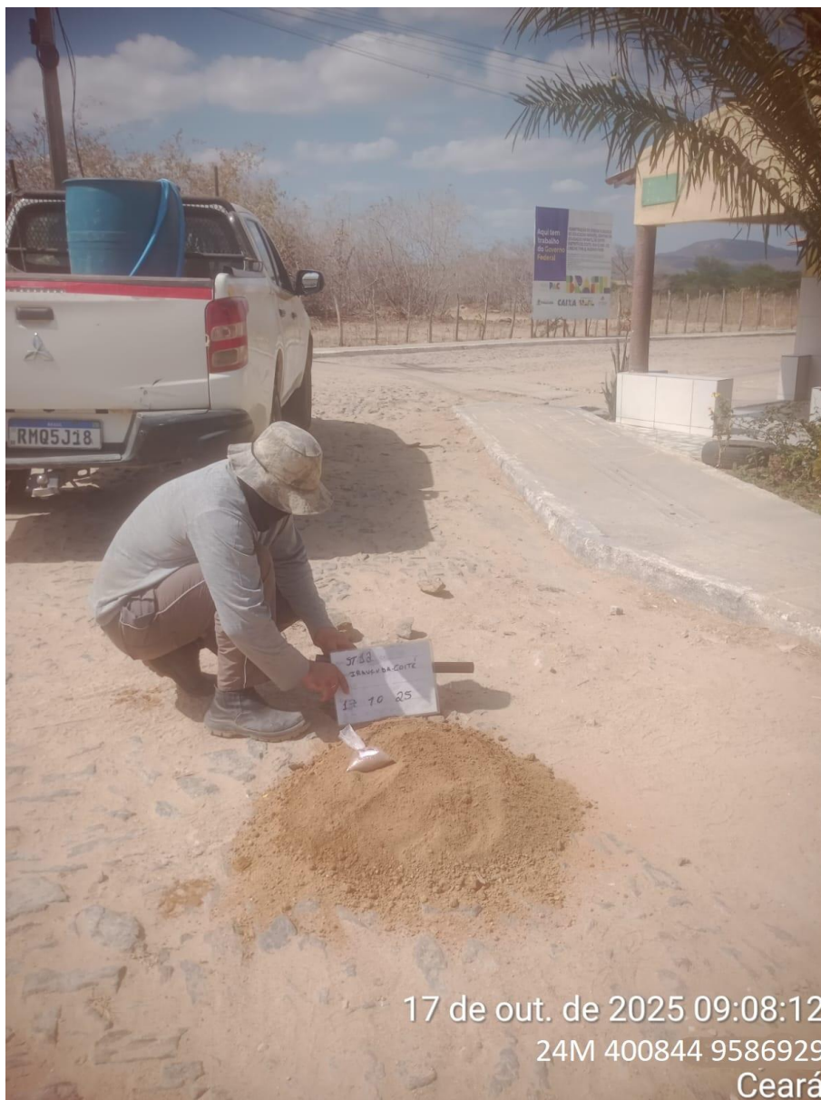
Instalação do furo 2.ST-12
