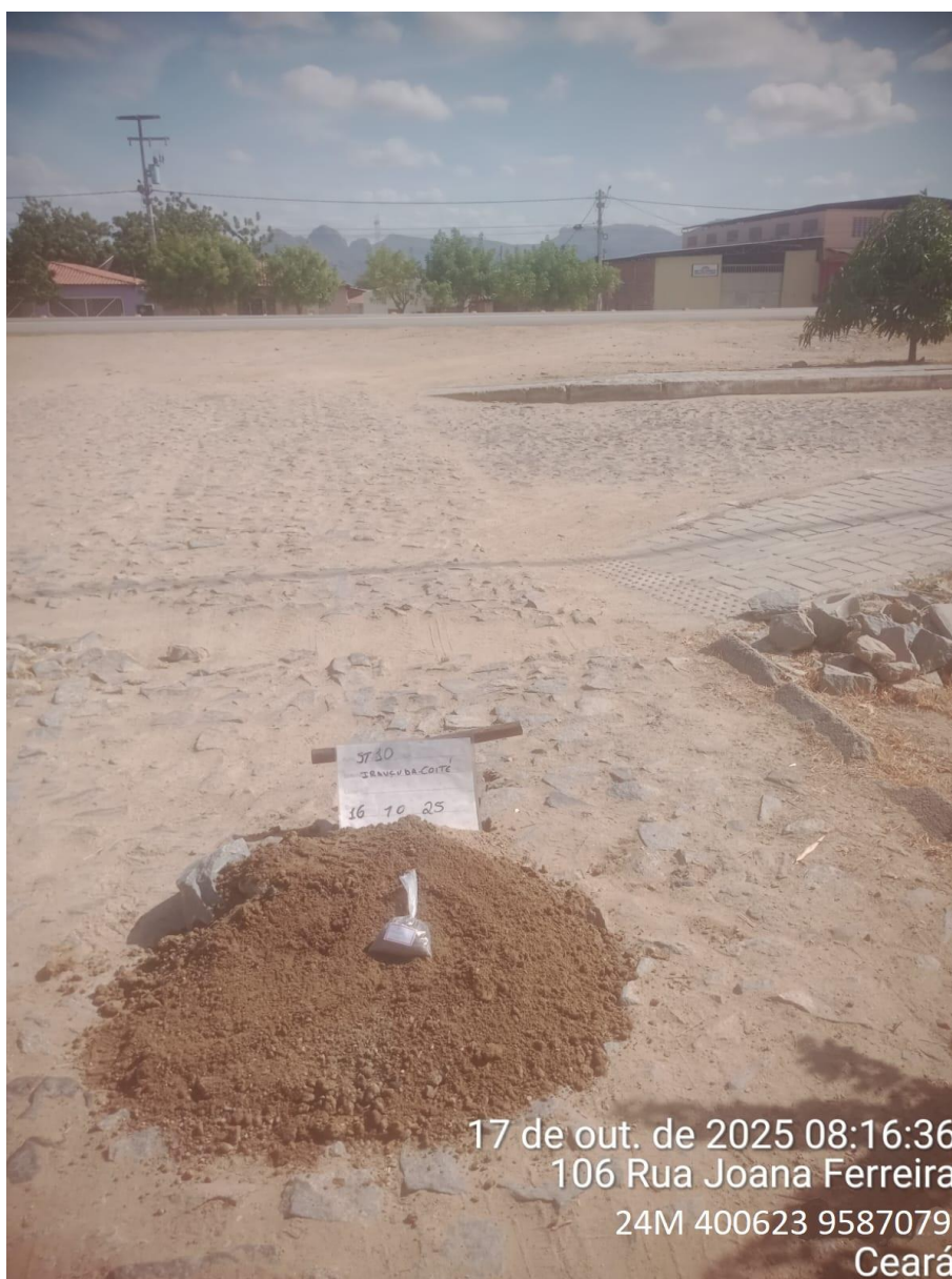
Instalação do furo 2.ST-10
