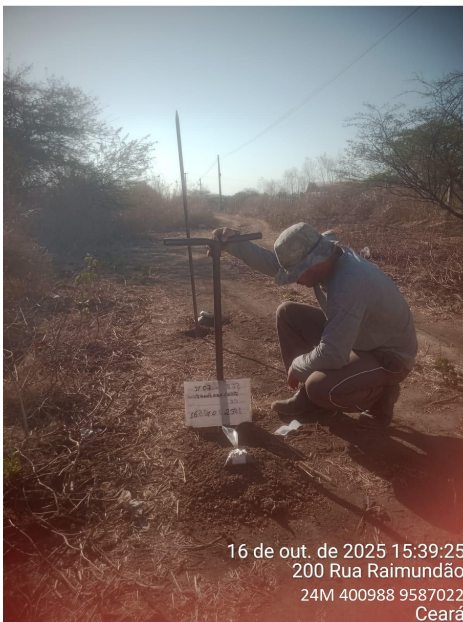
Instalação do furo 2.ST-07
