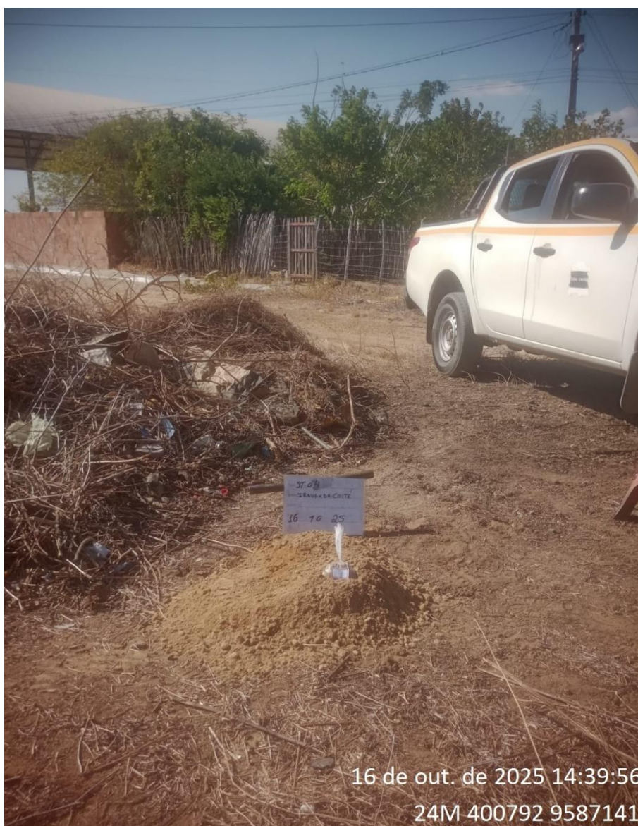
Instalação do furo 2.ST-04
