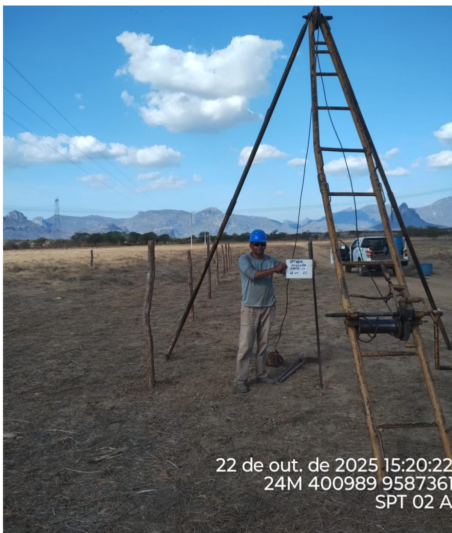
Instalação do furo 2.SPT-02 A
