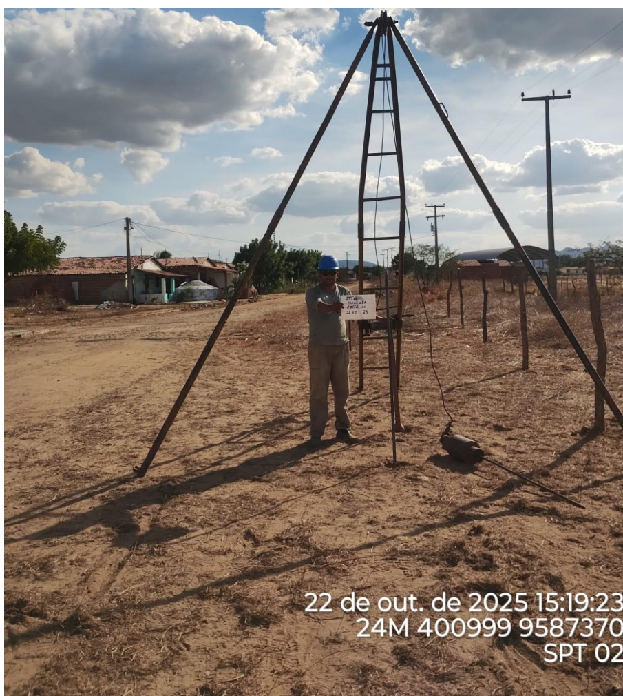
Instalação do furo 2.SPT-02
