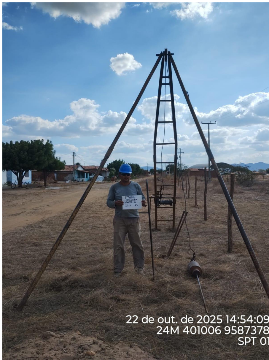
Instalação do furo 2.SPT-01
