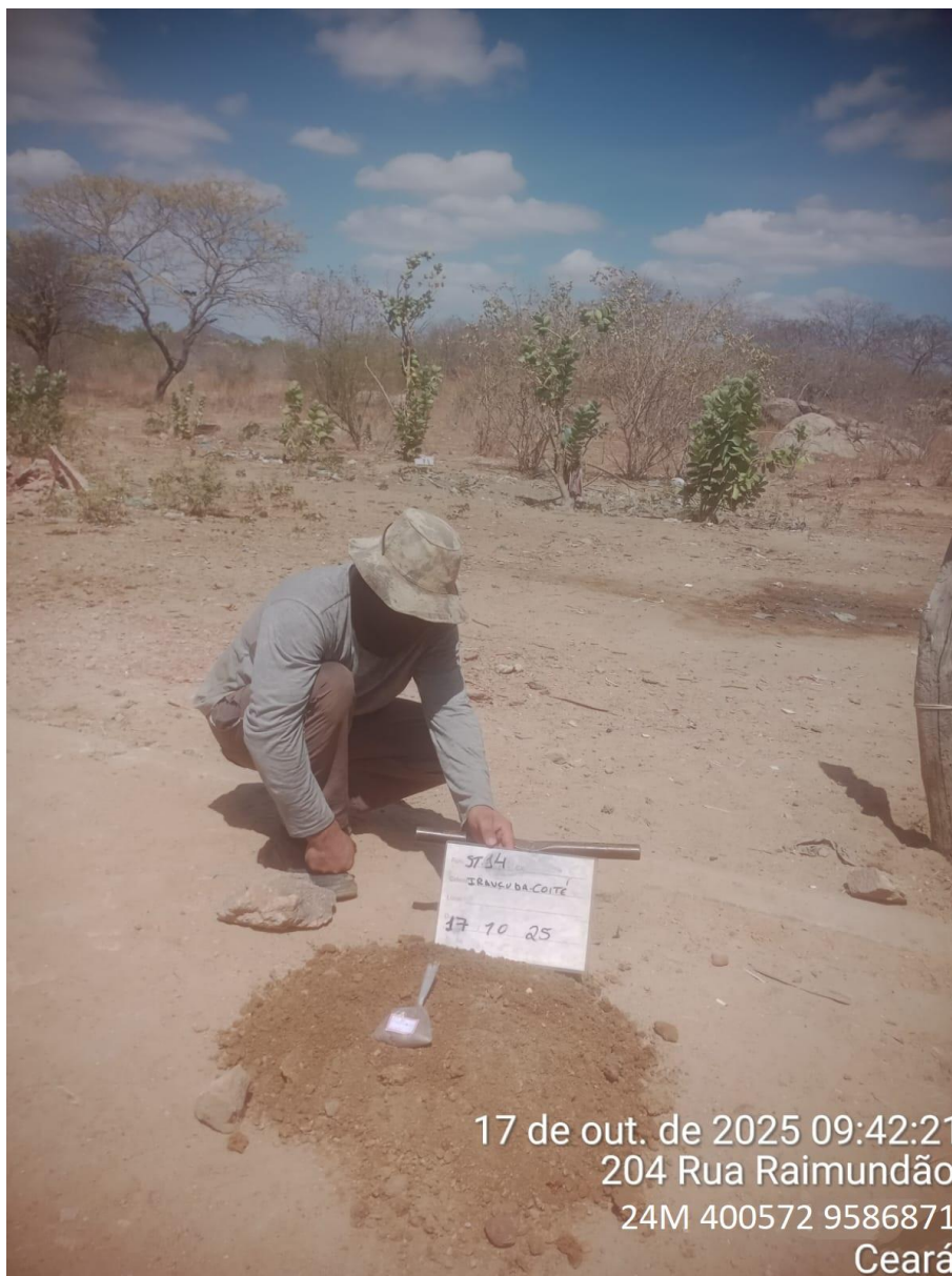
instalação do furo 2.ST-14
