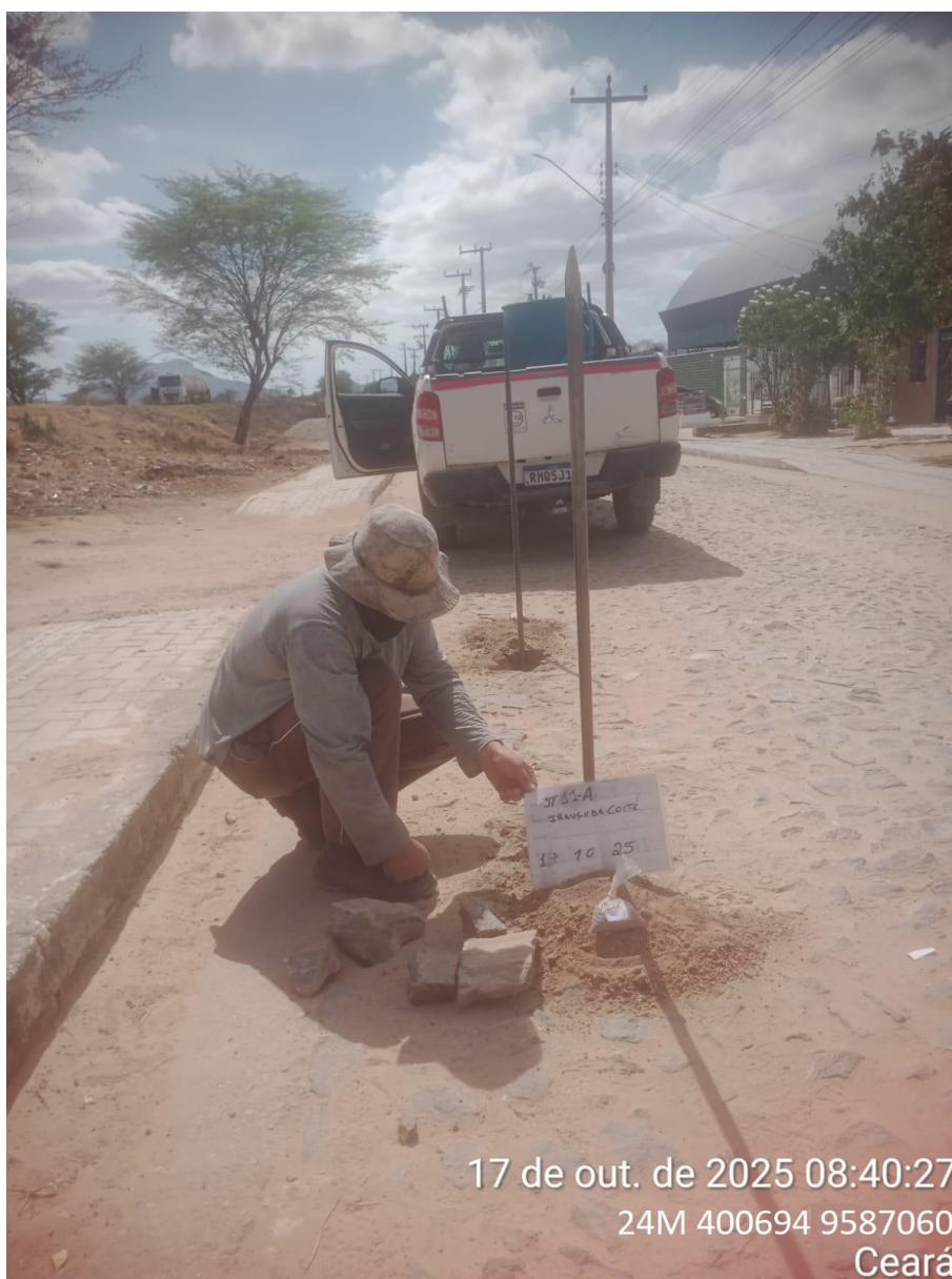
Instalação do furo 2.ST-11 A
