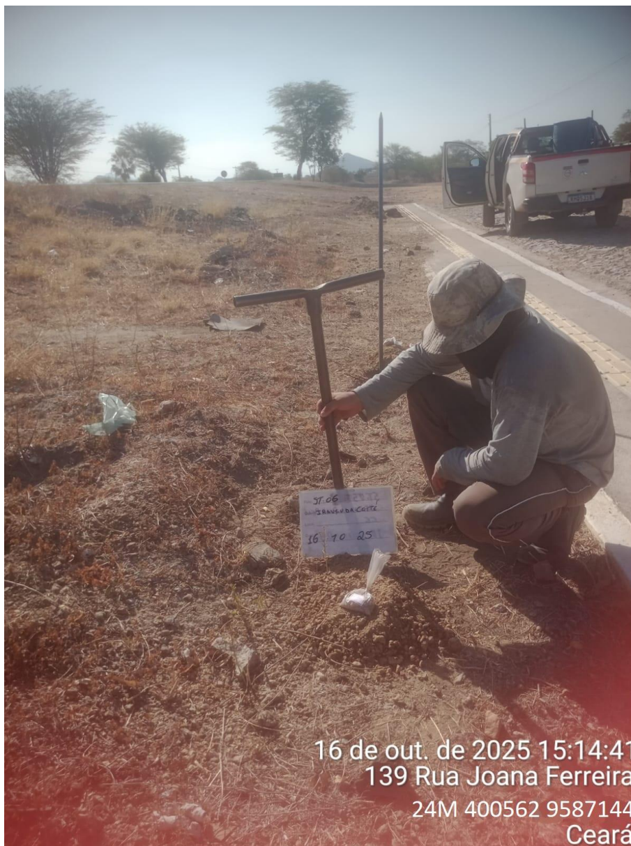
Instalação do furo 2.ST-06
