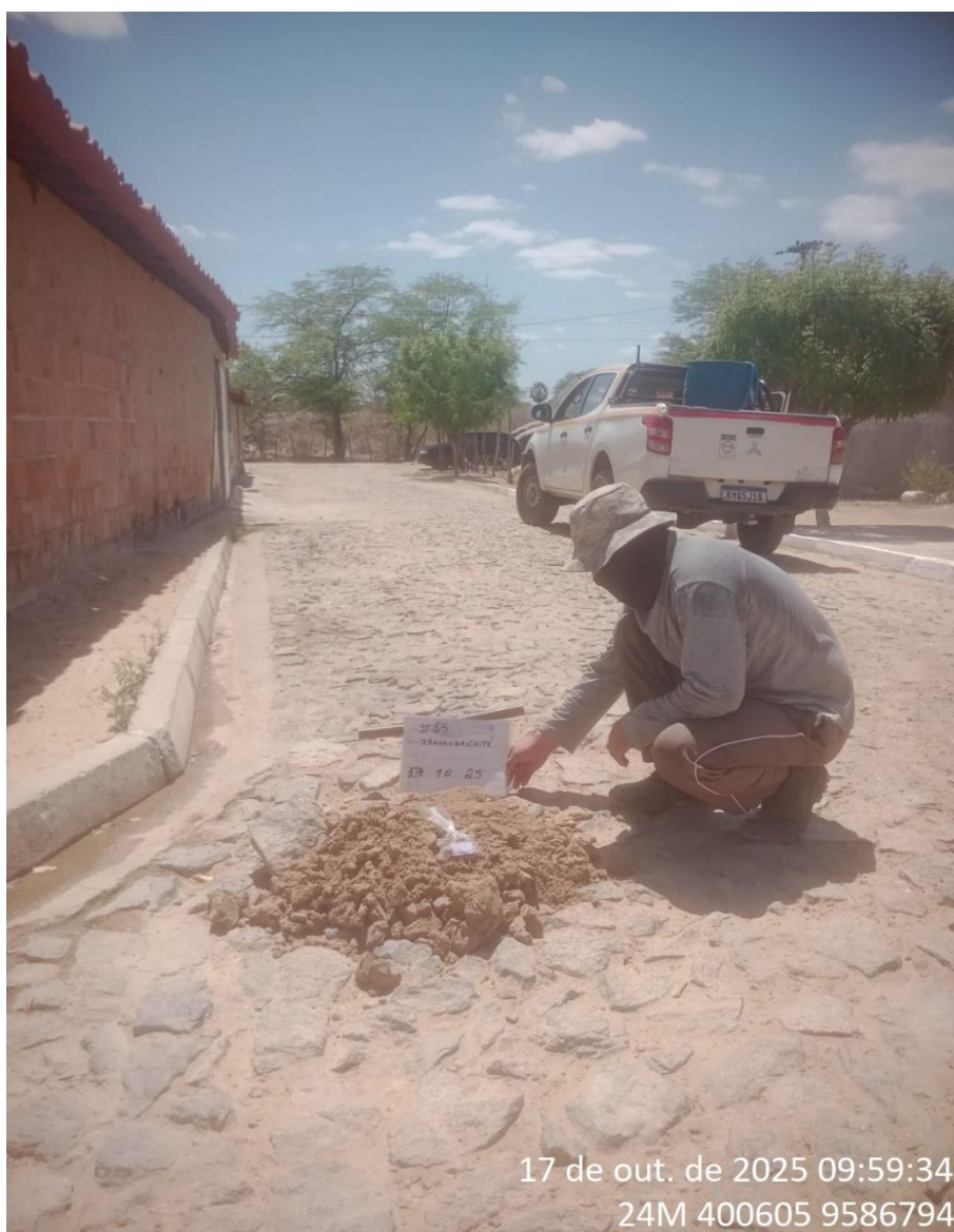
Instalação do furo 2.ST-15
