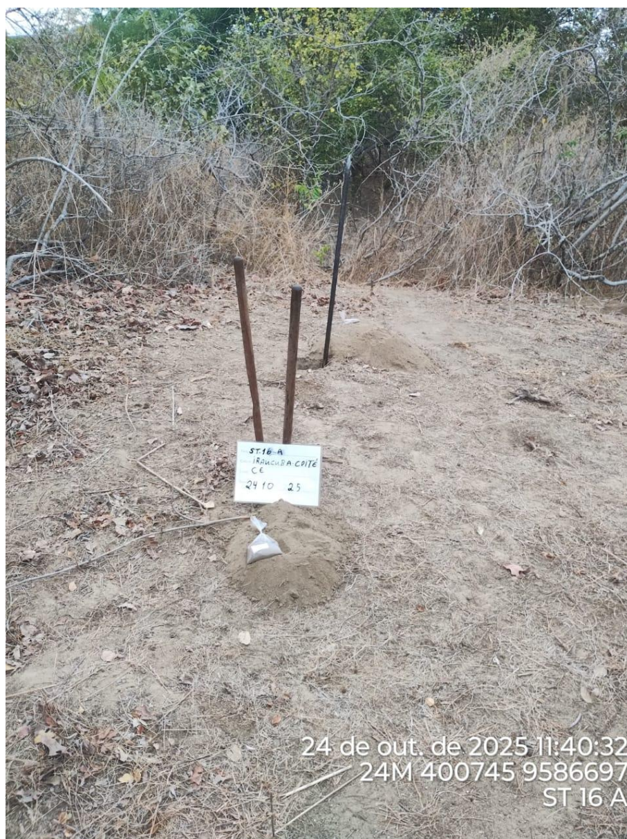
Instalação do furo 2.ST-16 A
