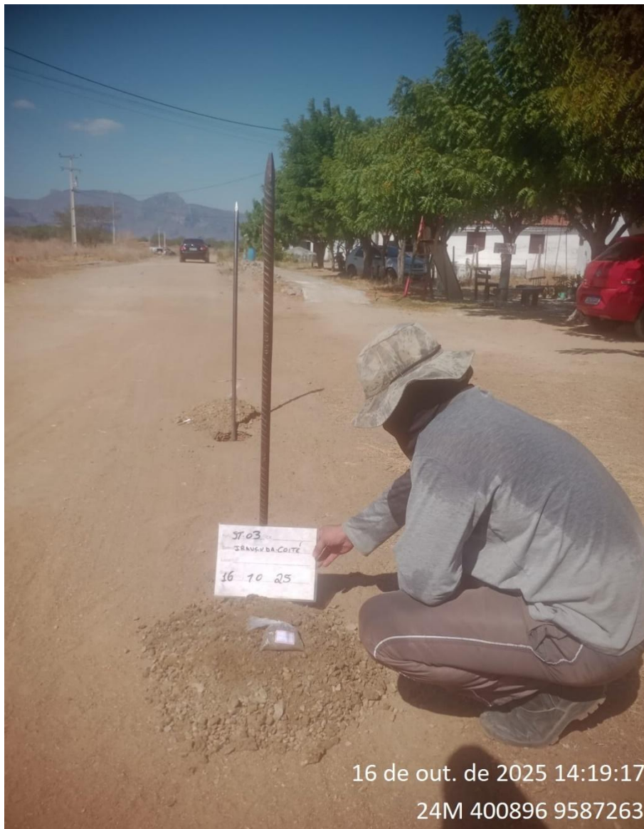
Instalação do furo 2.ST-03
