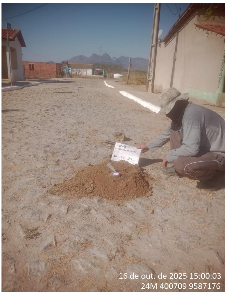
Instalação do furo 2.ST-05
