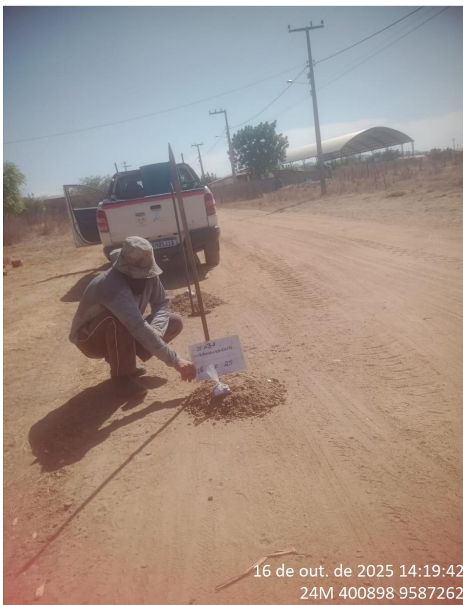
Instalação do furo 2.ST-03 A
