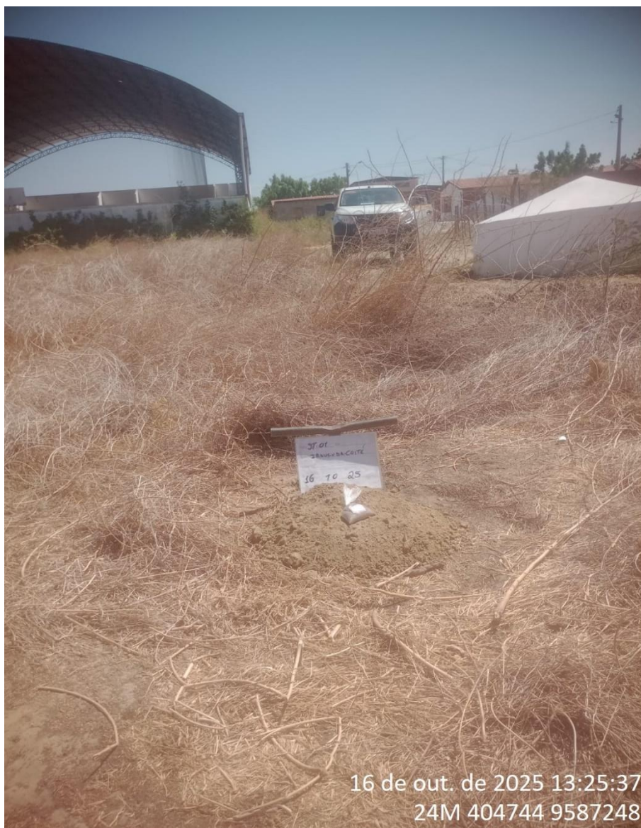
Instalação do furo 2.ST-01
