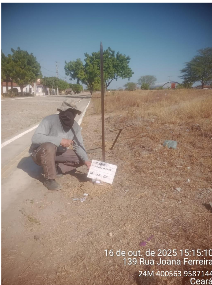
Instalação do furo 2.ST-06 A
