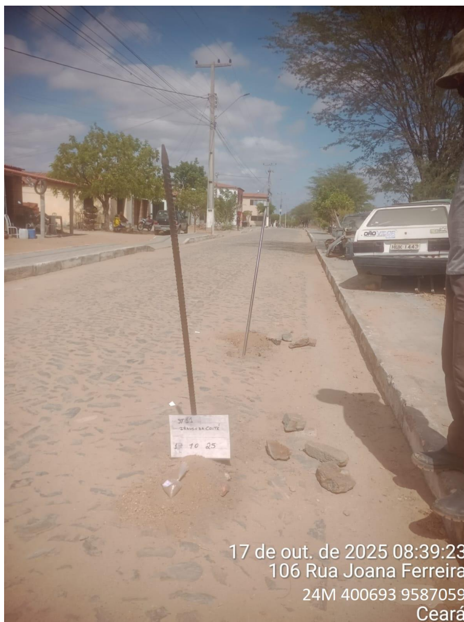
Instalação do furo 2.ST-11
