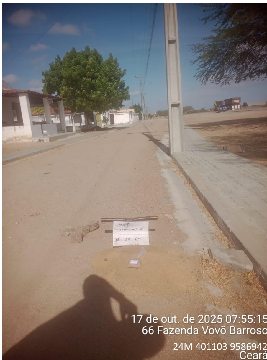
Instalação do furo 2.ST-09
