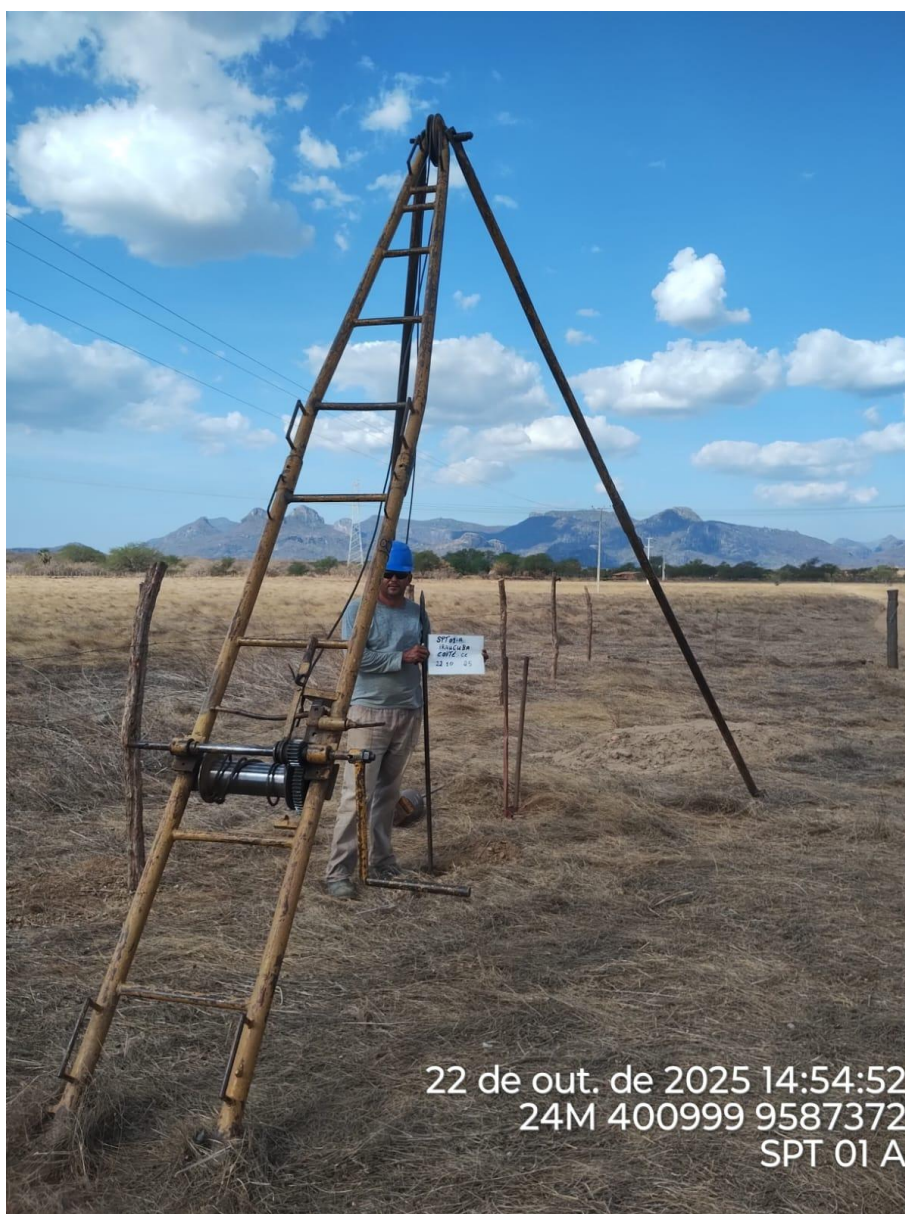
Instalação do furo 2.SPT-01 A
