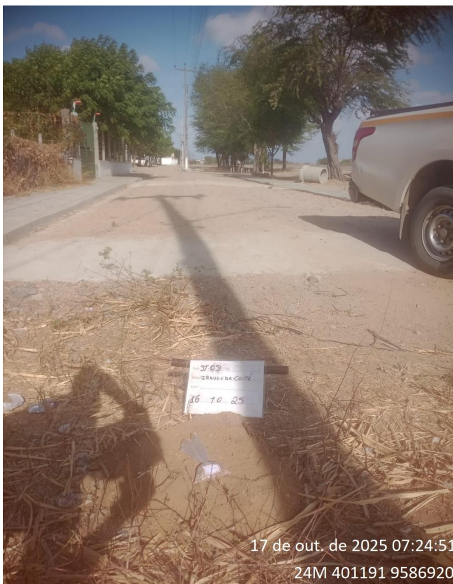
Instalação do furo 2.ST-08
