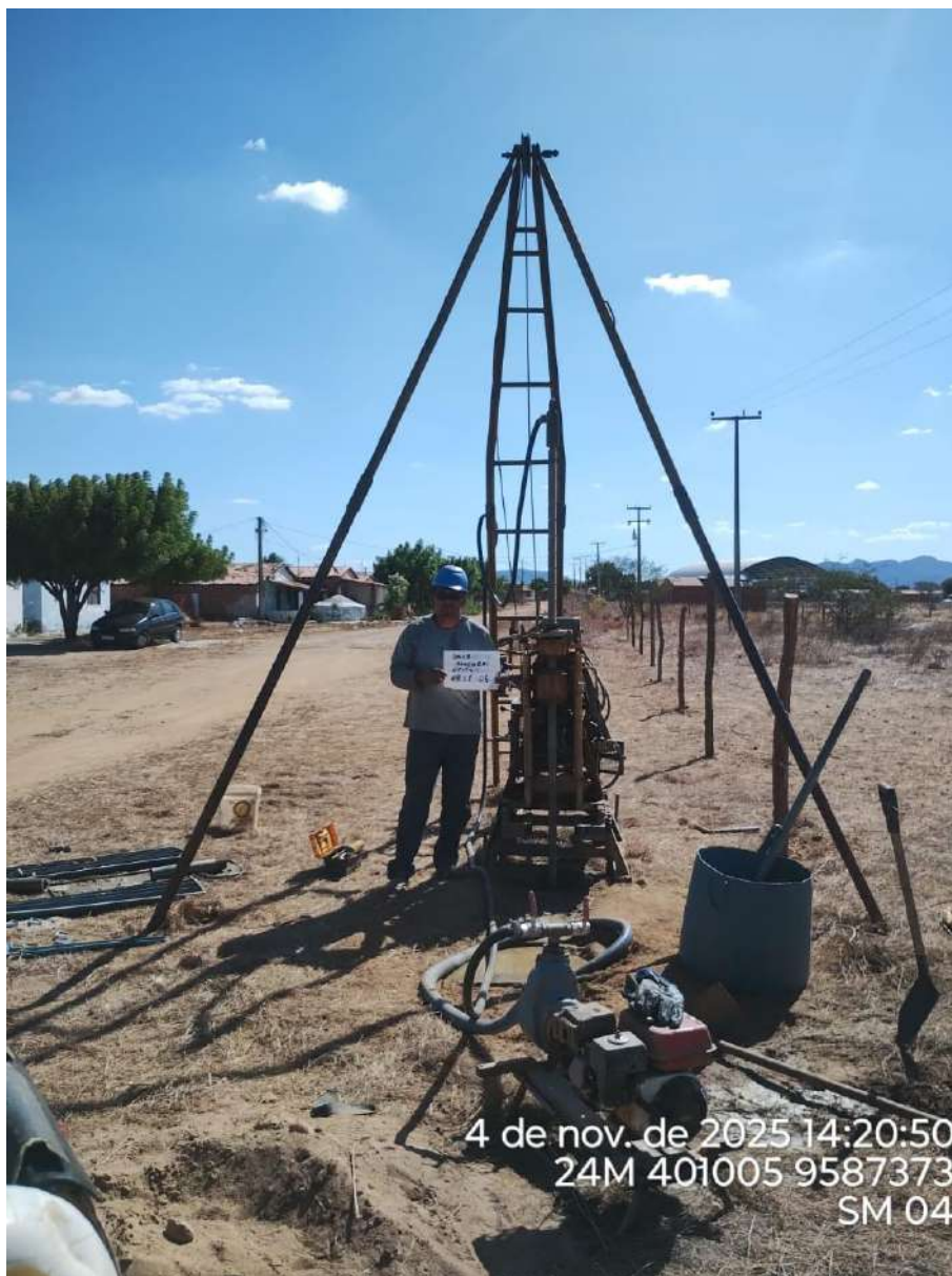
Instalação do furo SR-04
