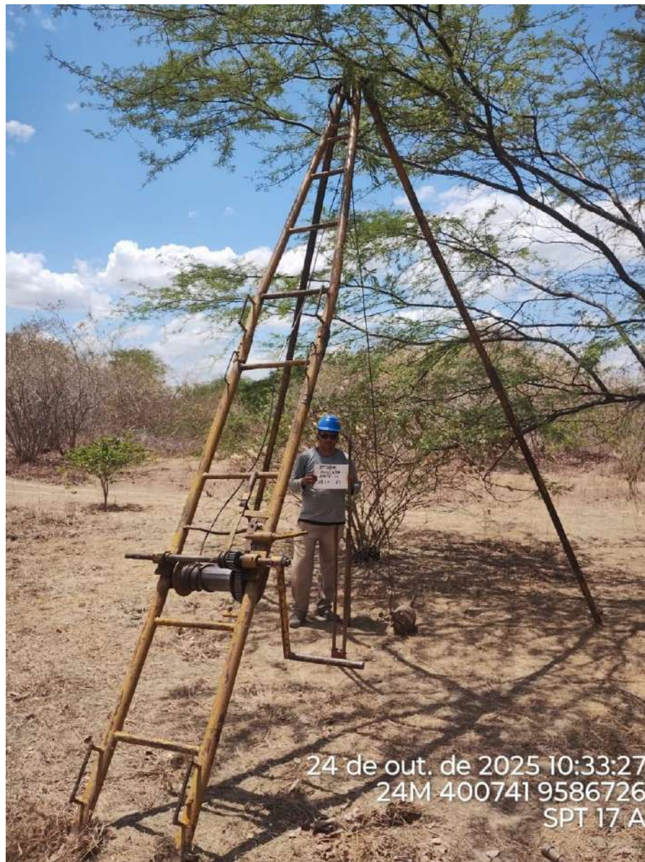
Instalação do furo 2.SPT-17 A
