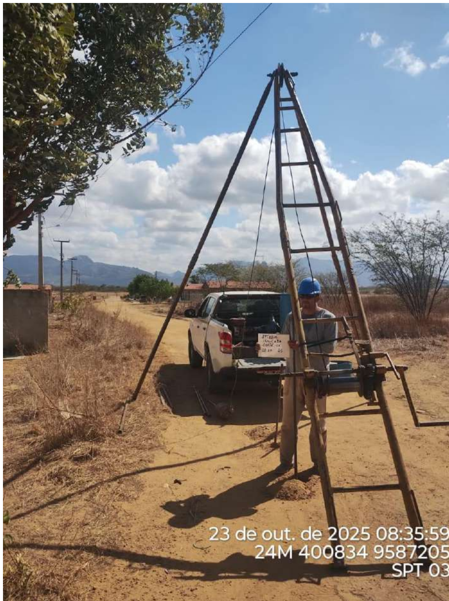
Instalação do furo 2.SPT-03 A
