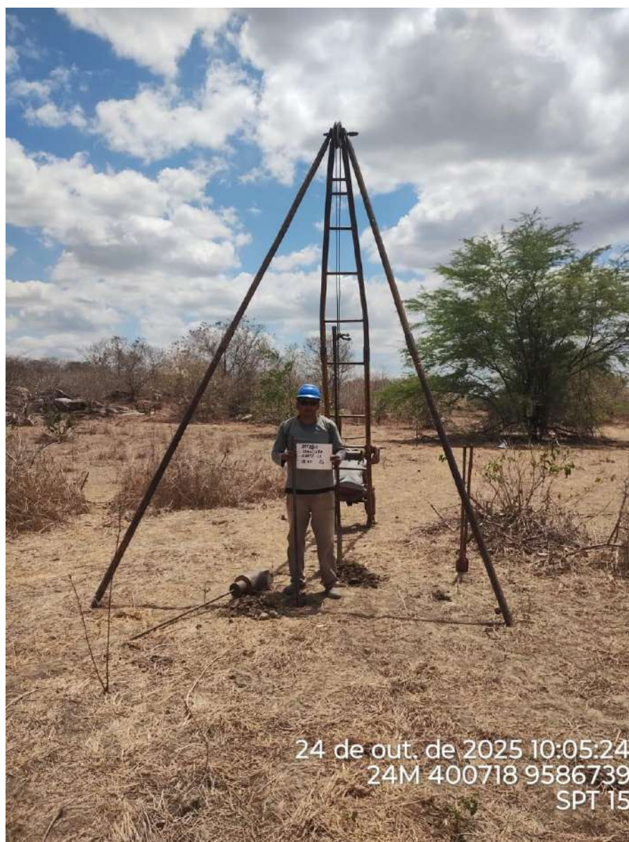
Instalação do furo 2.SPT-15
