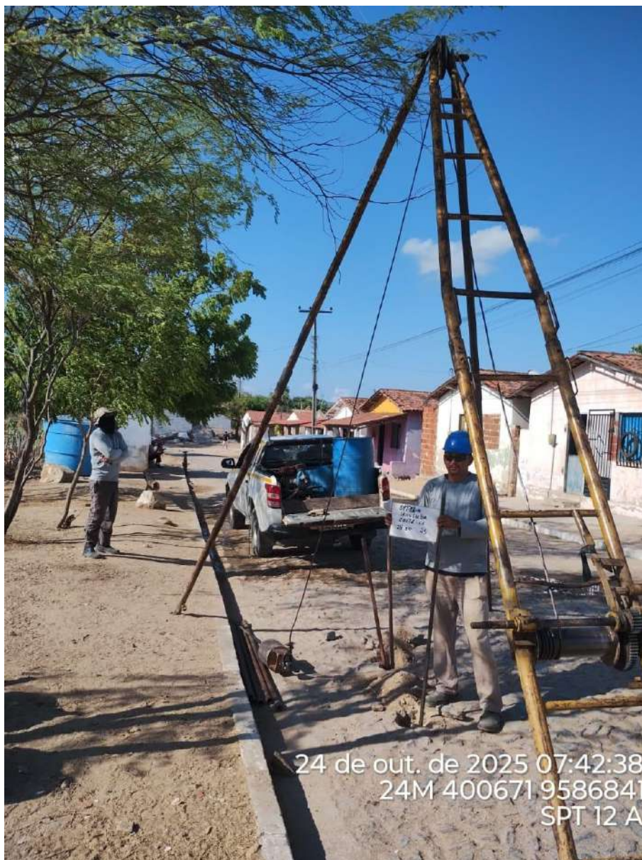
Instalação do furo 2.SPT-12 A
