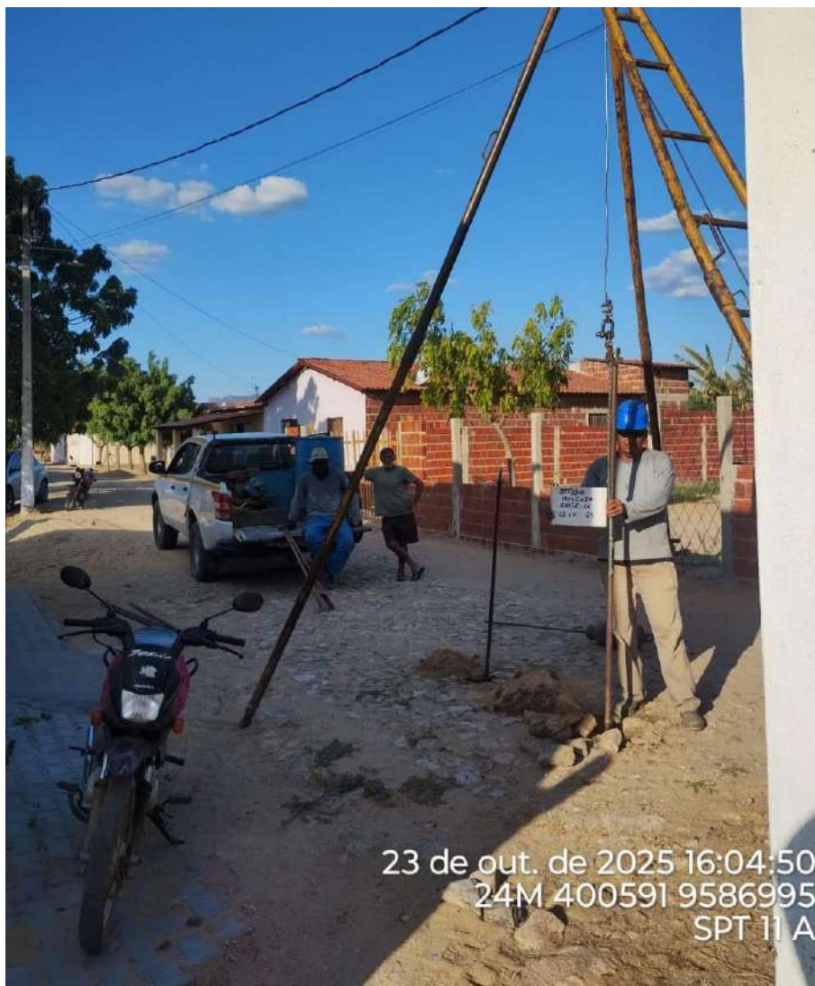
Instalação do furo 2.SPT-11 A
