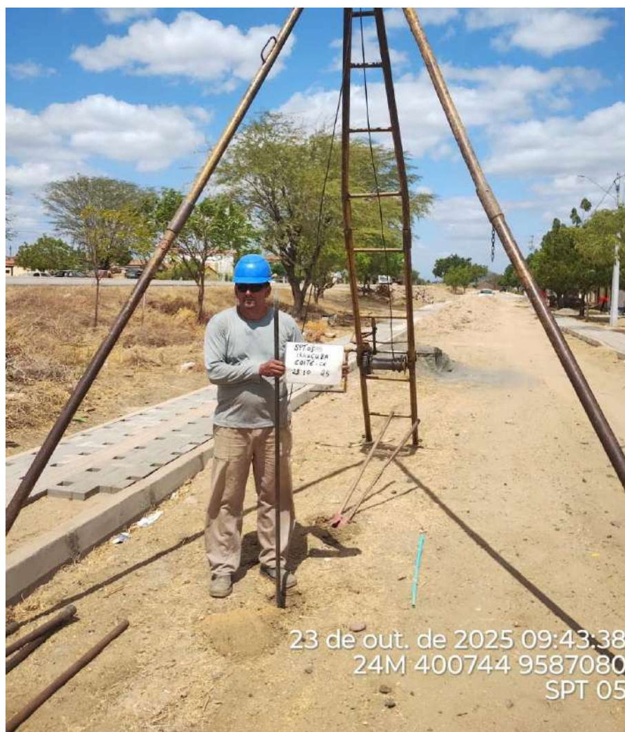
Instalação do furo 2.SPT-05
