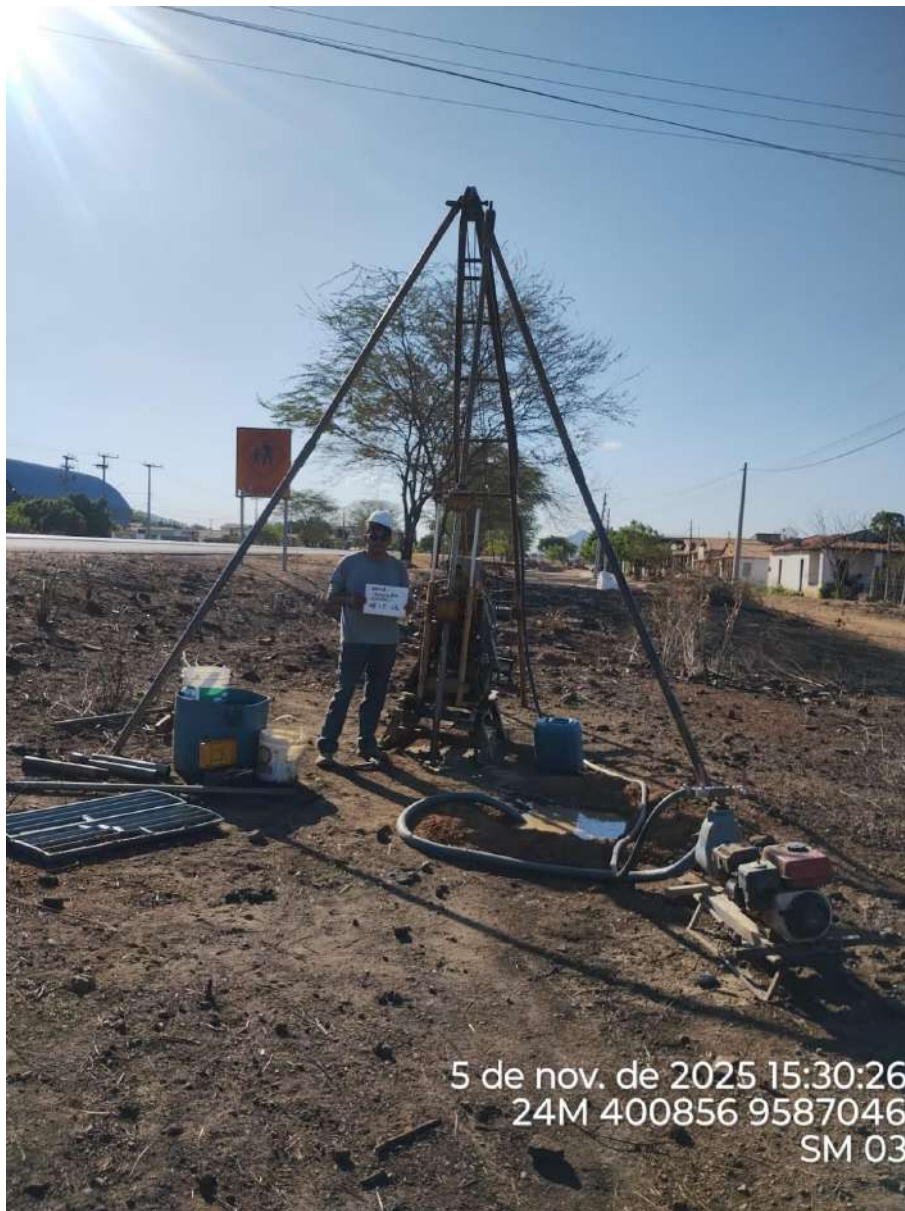
Instalação do furo SR-03
