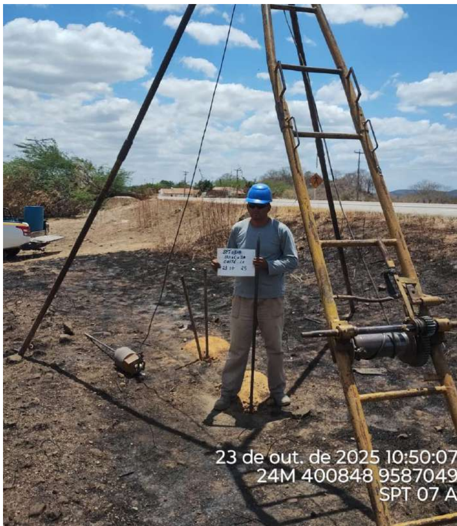
Instalação do furo 2.SPT-07 A
