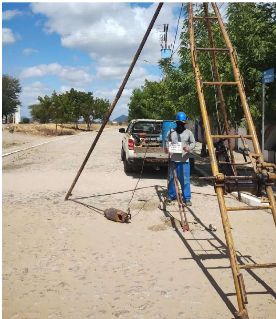
Instalação do furo 2.SPT-04 A
