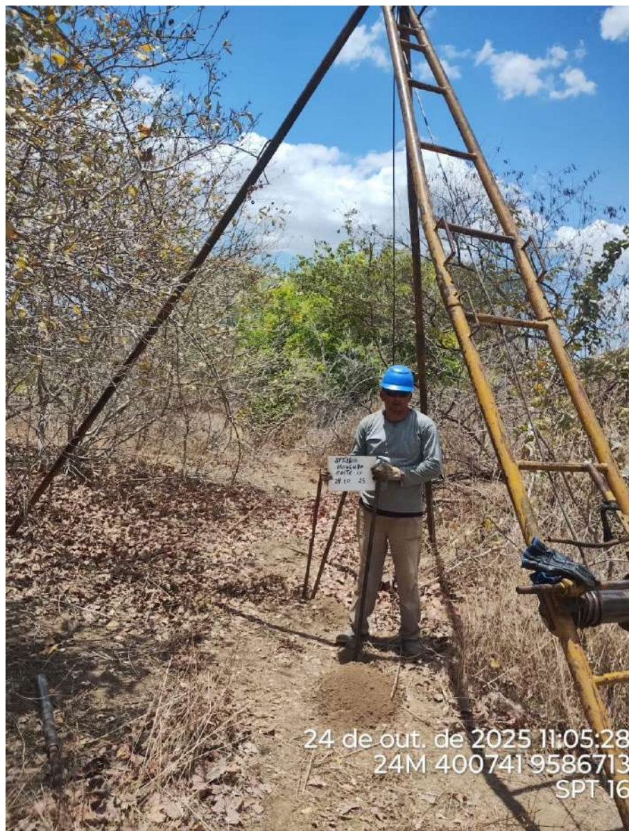
Instalação do furo 2.SPT-16
