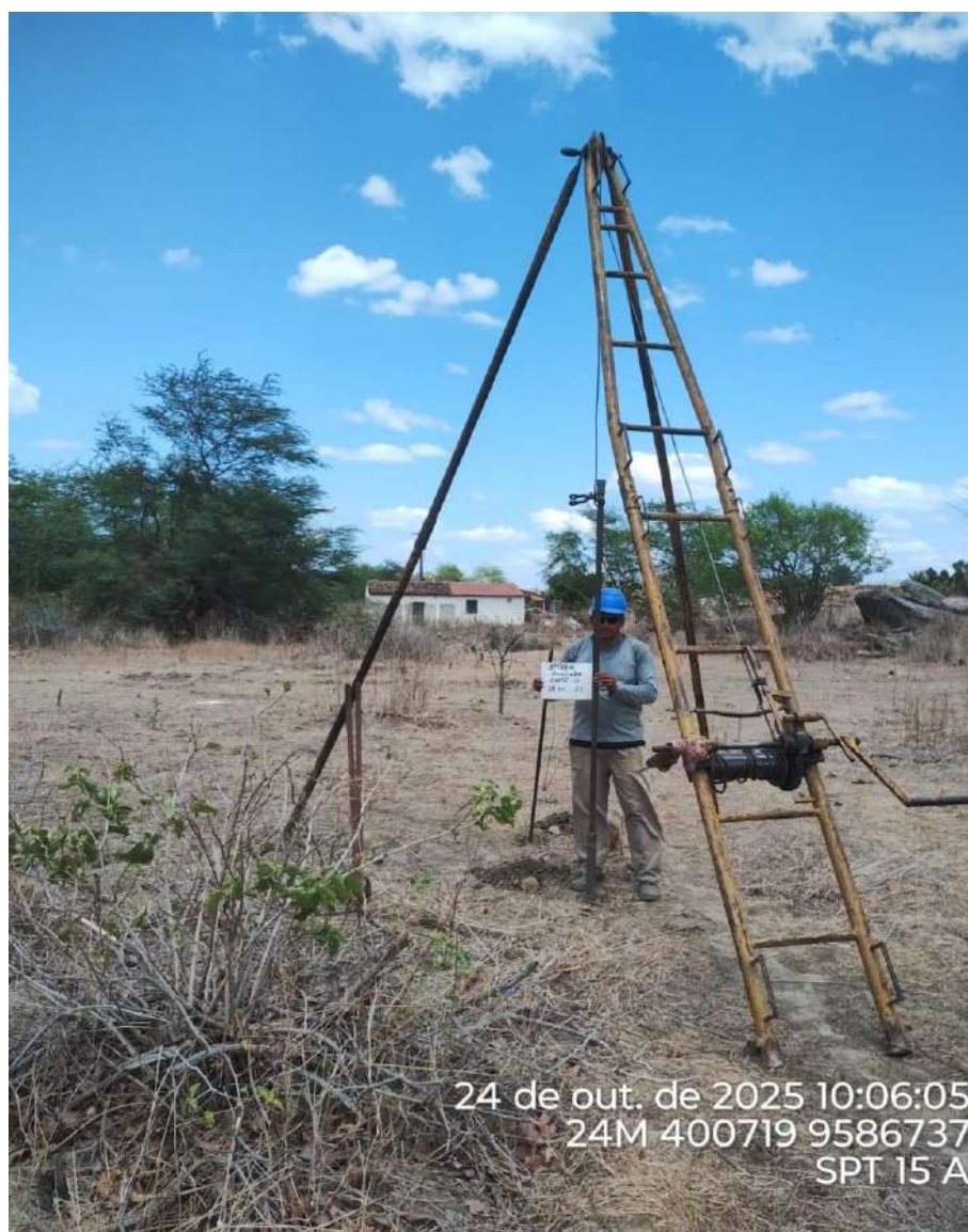
Instalação do furo 2.SPT-15 A
