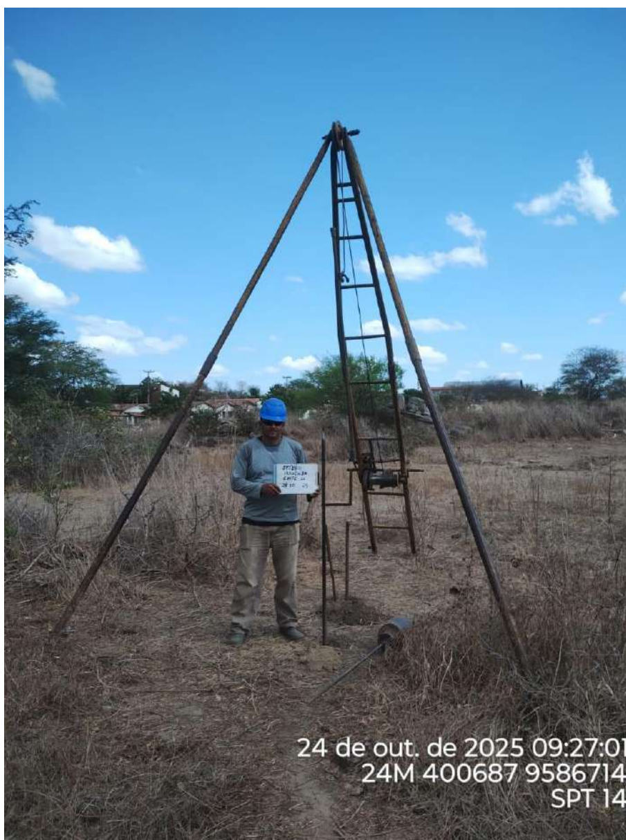
Instalação do furo 2.SPT-14
