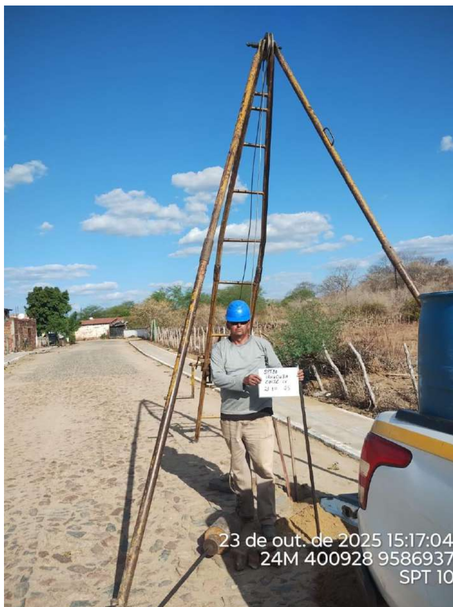
Instalação do furo 2.SPT-10
