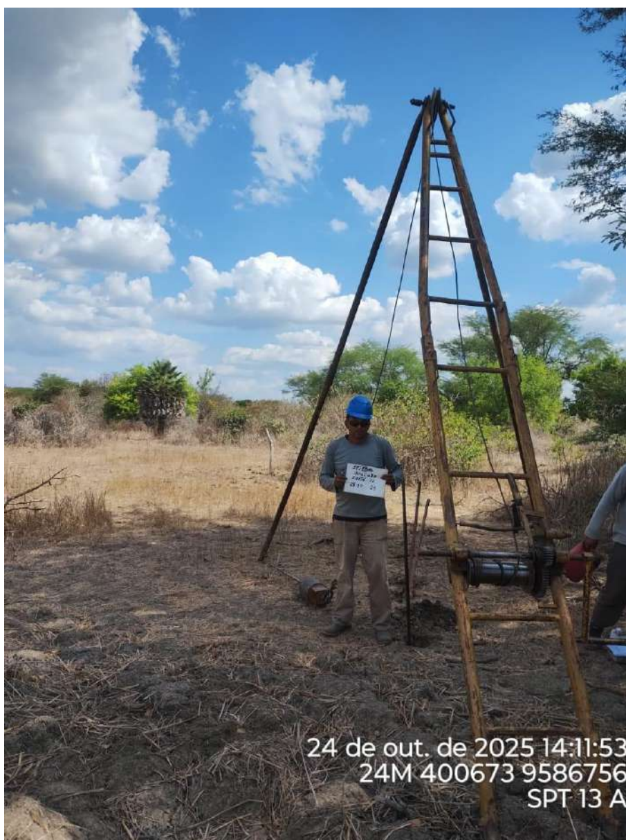
Instalação do furo 2.SPT-13 A
