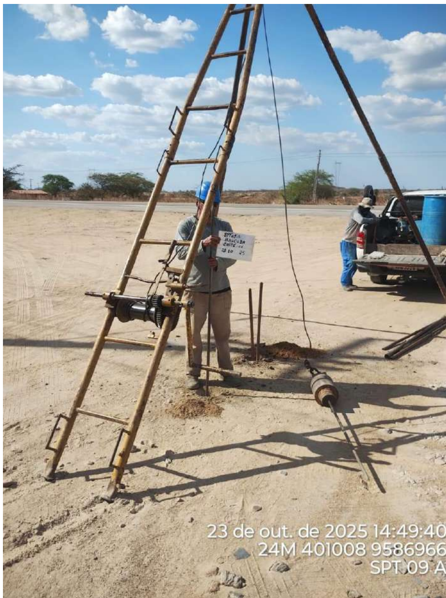
Instalação do furo 2.SPT-09 A
