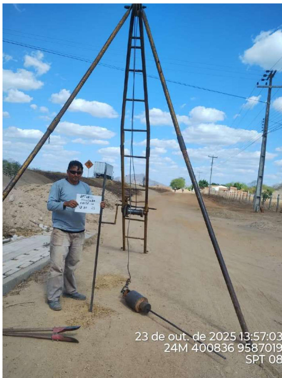
Instalação do furo 2.SPT-08
