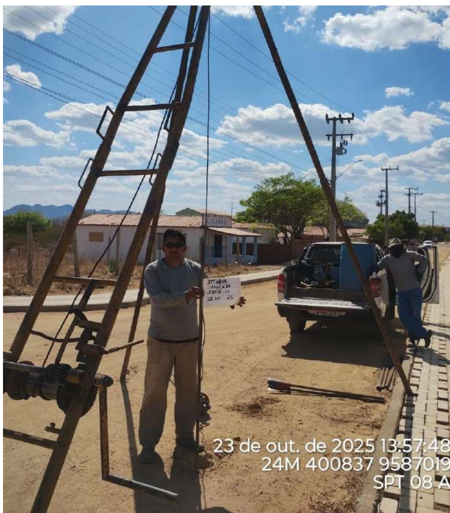
Instalação do furo 2.SPT-08 A
