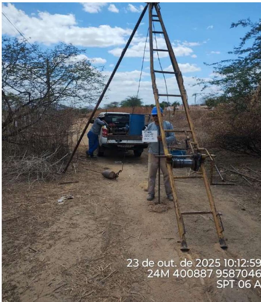
Instalação do furo 2.SPT-06 A
