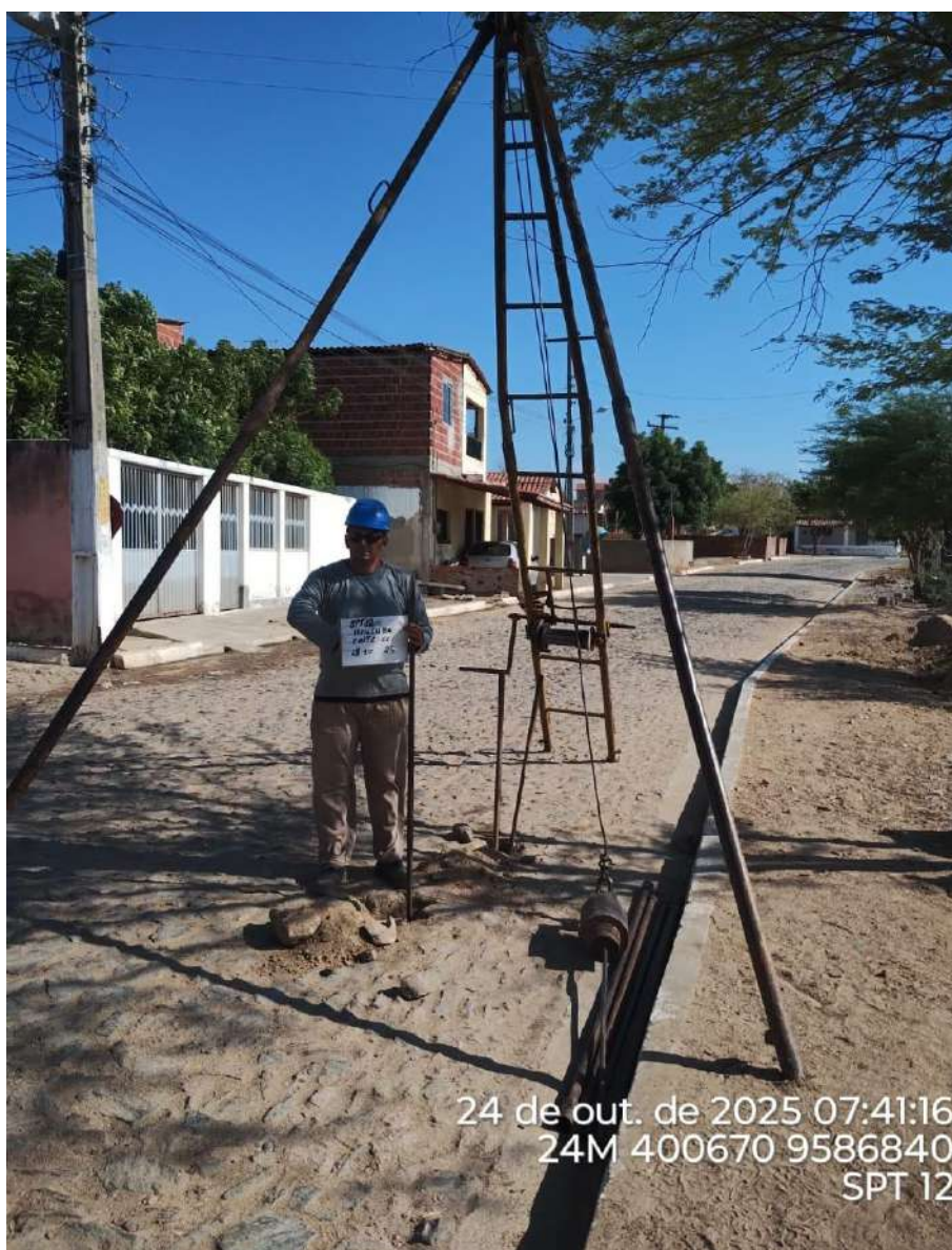
Instalação do furo 2.SPT-12
