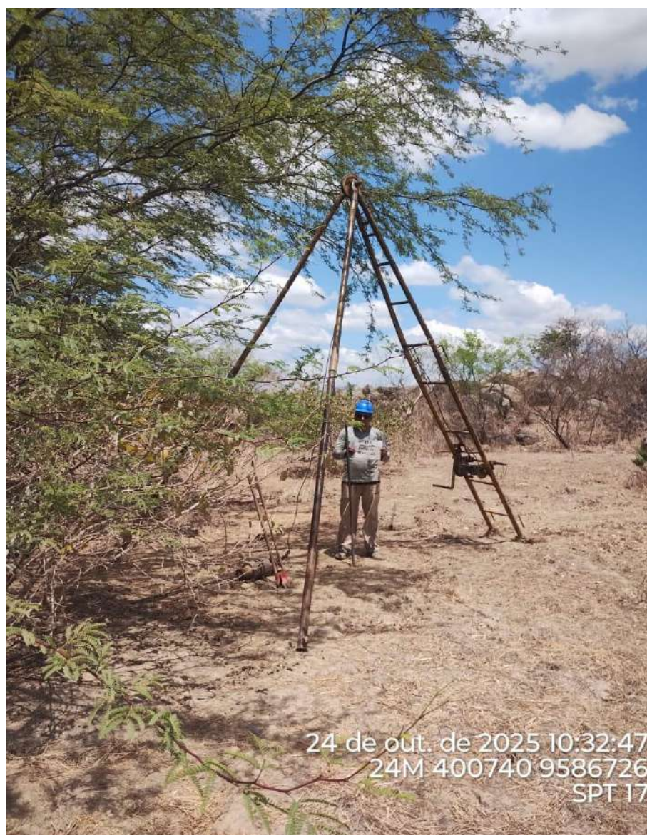
Instalação do furo 2.SPT-17
