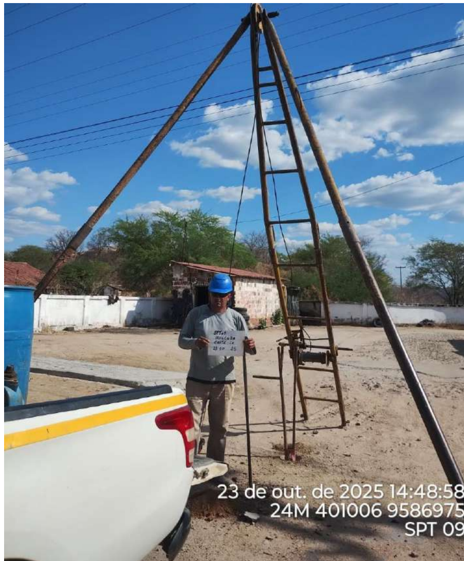
Instalação do furo 2.SPT-09
