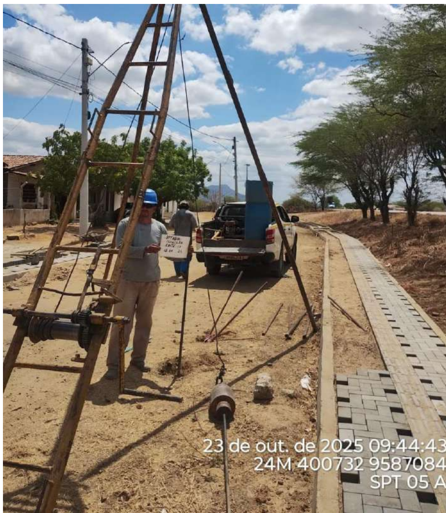
Instalação do furo 2.SPT-05 A
