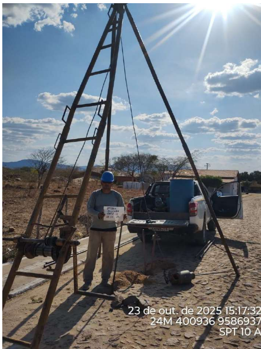
Instalação do furo 2.SPT-10 A
