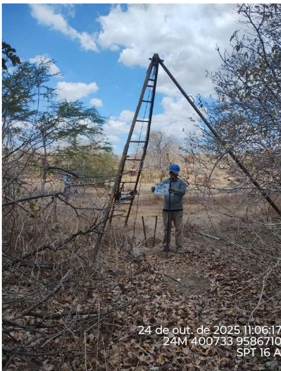
Instalação do furo 2.SPT-16 A
