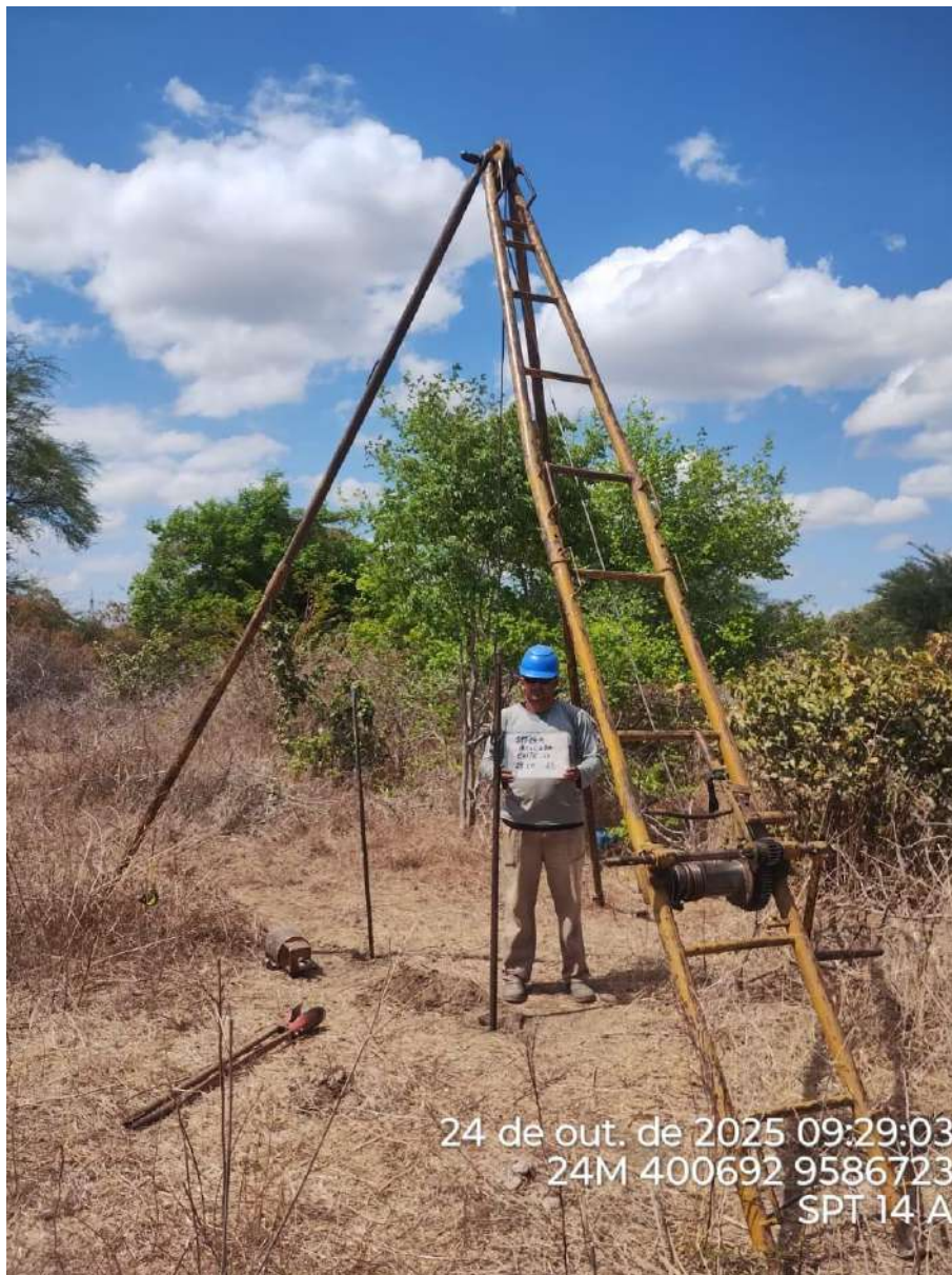
Instalação do furo 2.SPT-14 A
