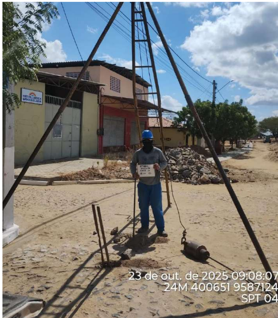
Instalação do furo 2.SPT-04
