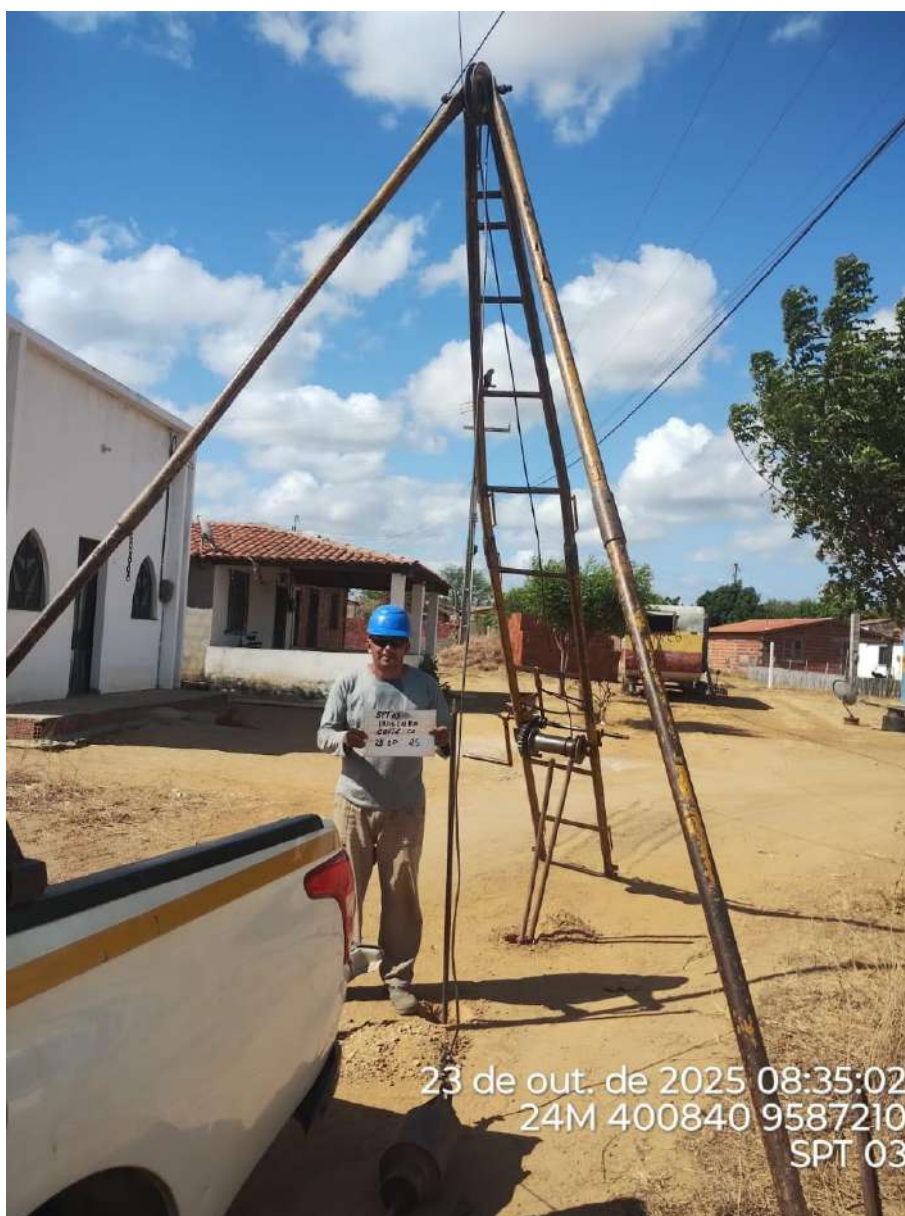
Instalação do furo 2.SPT-03
