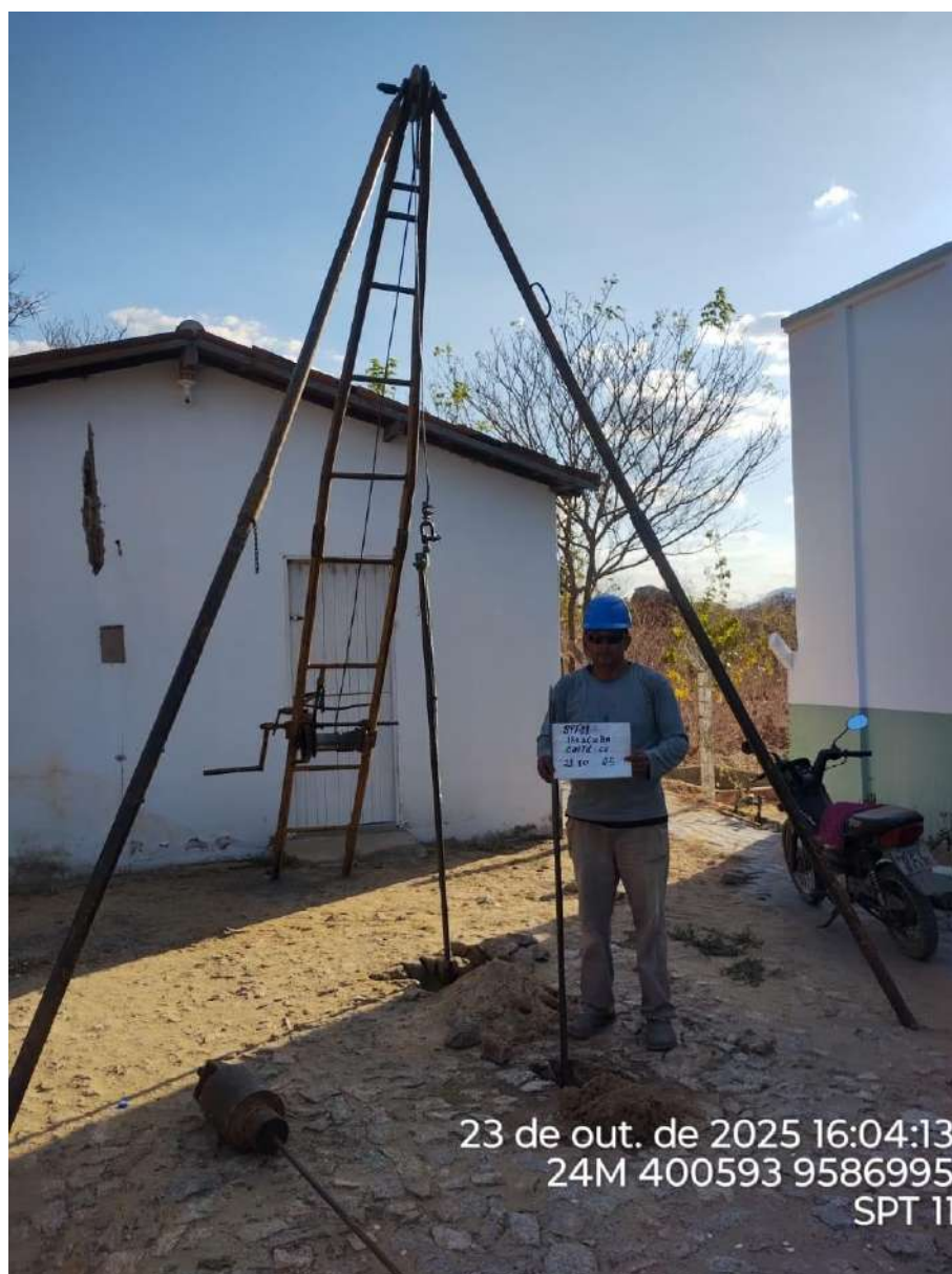
Instalação do furo 2.SPT-11
