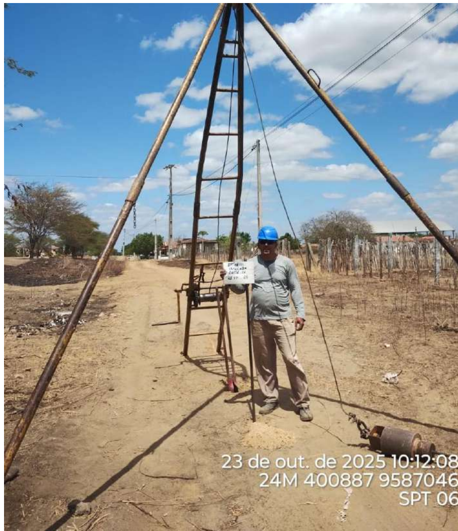
Instalação do furo 2.SPT-06
