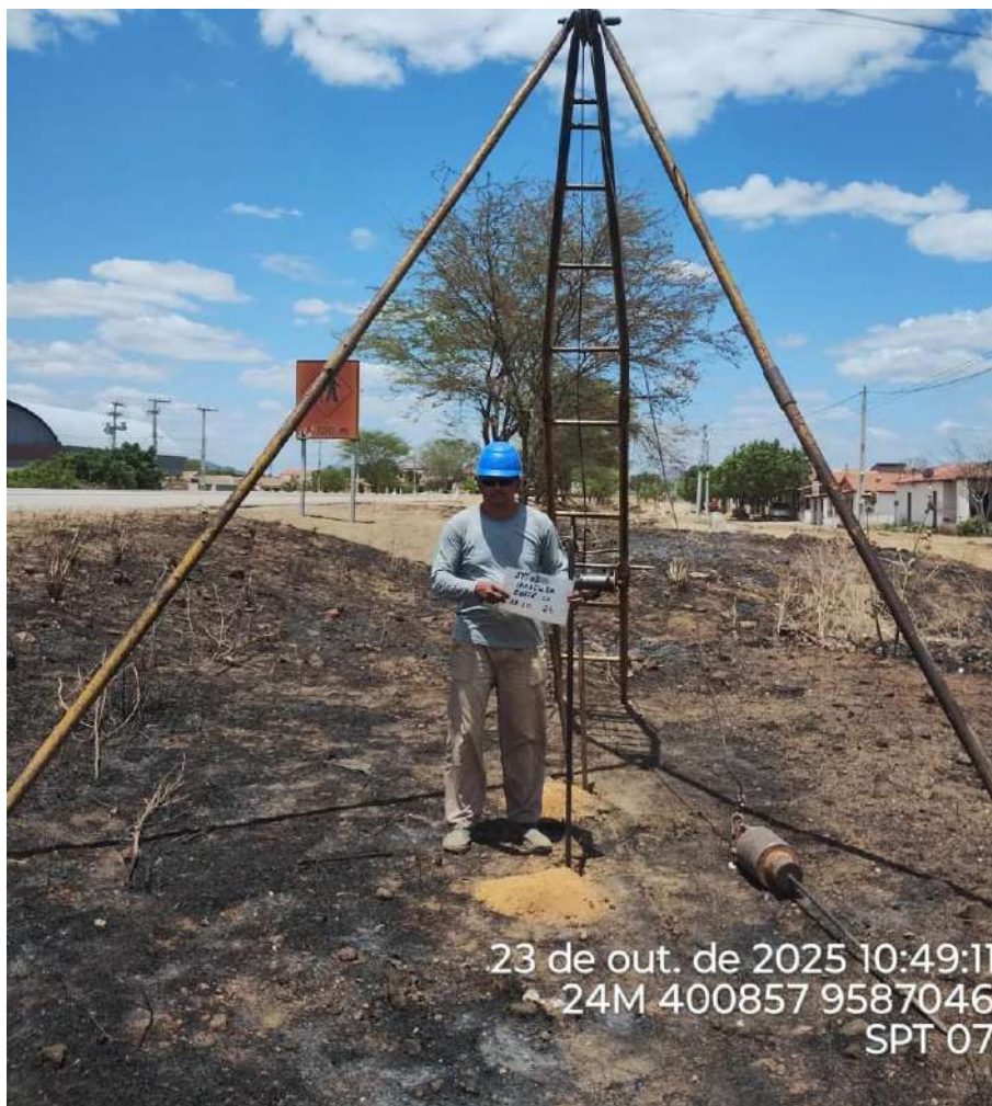
Instalação do furo 2.SPT-07
