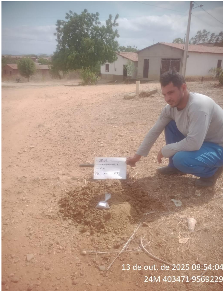
Instalação do furo 1.1.ST-01
