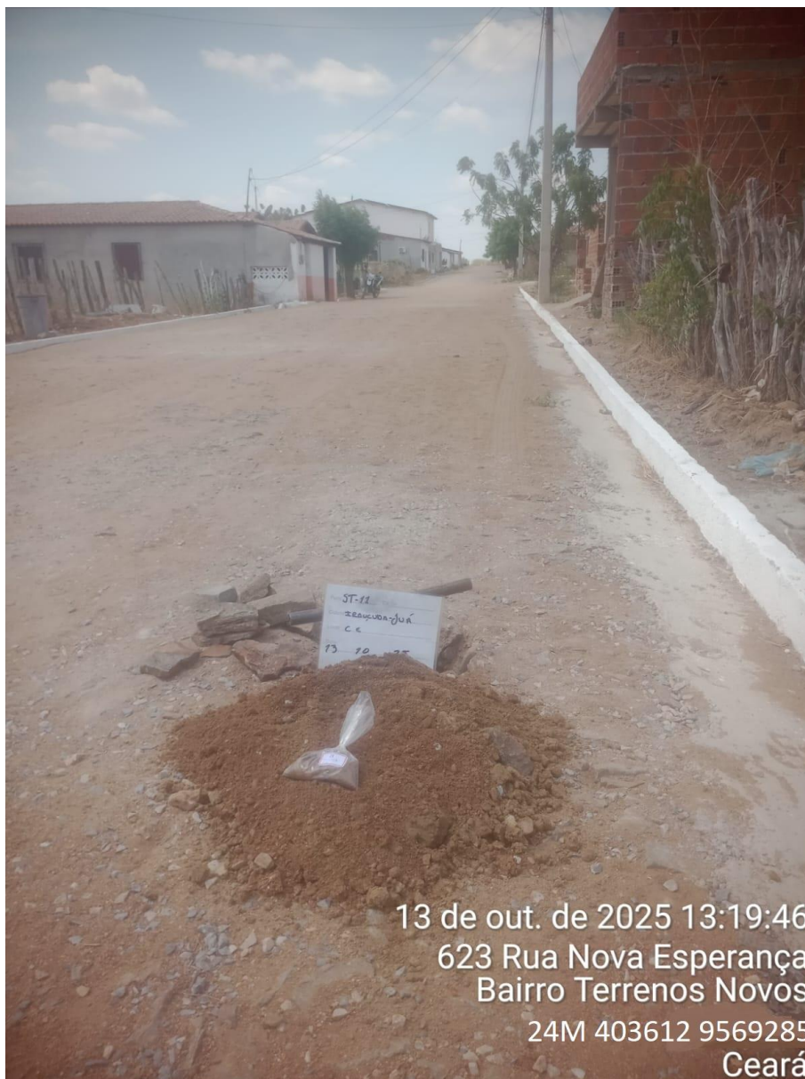
Instalação do furo 1.ST-11
