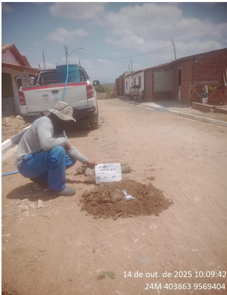
Instalação do furo 1.ST-23
