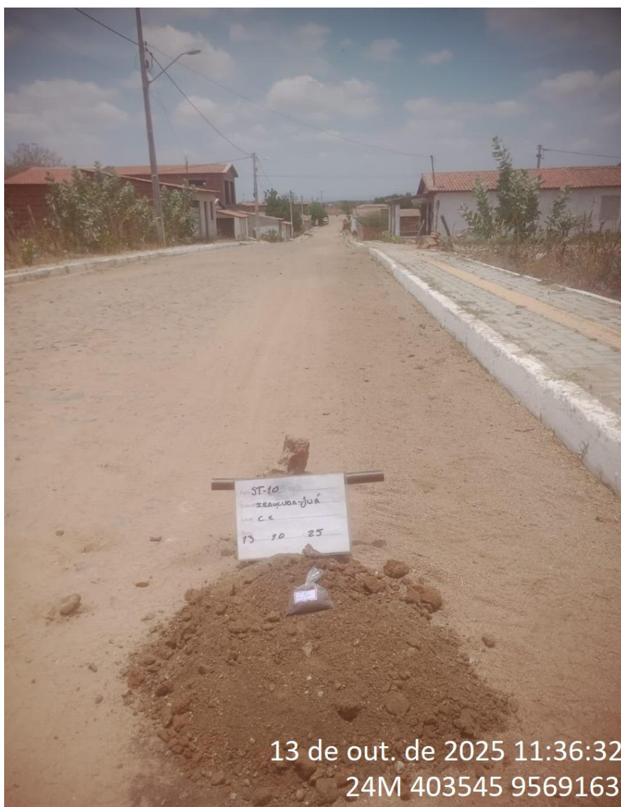
Instalação do furo 1.1.ST-10
