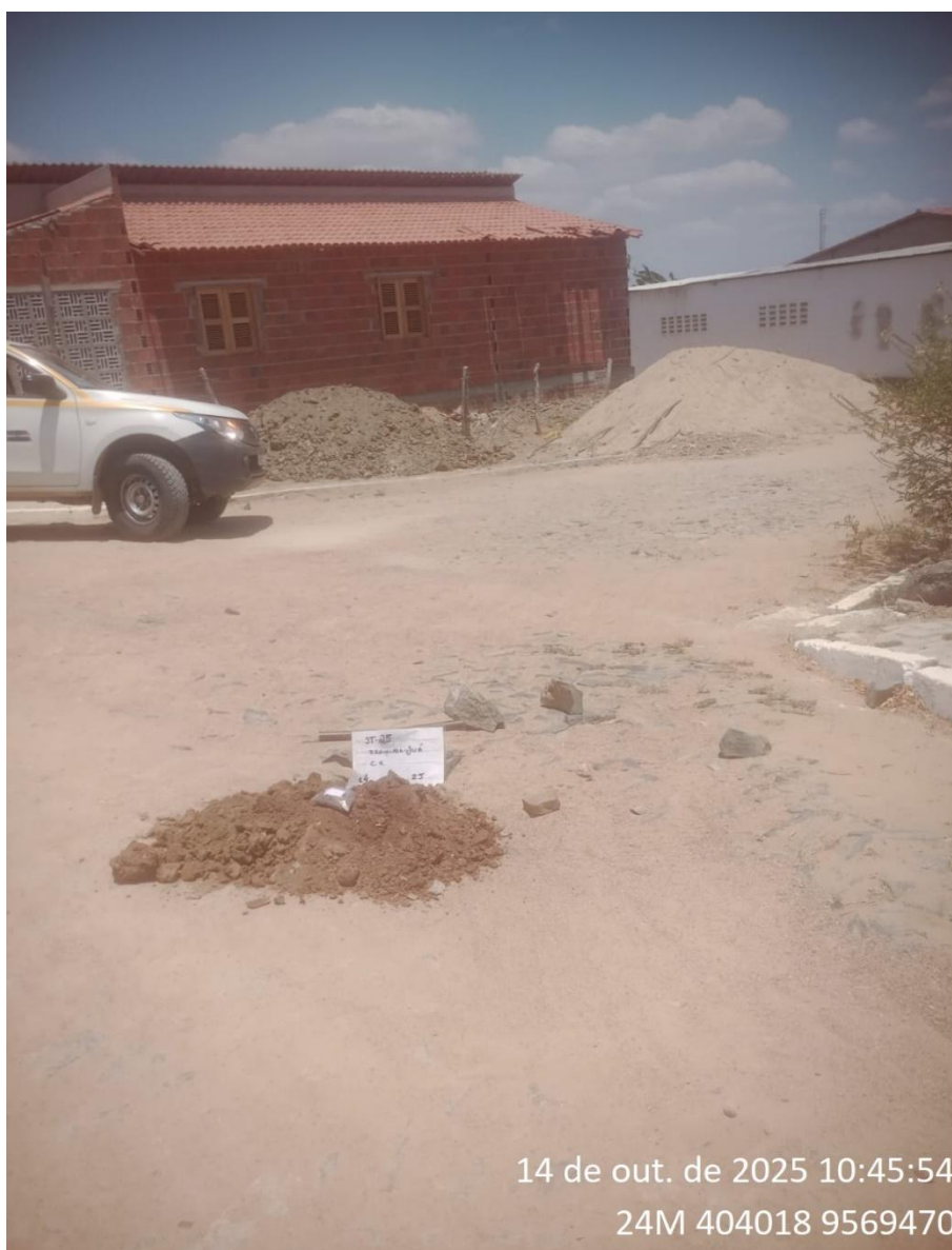
Instalação do furo 1.ST-25
