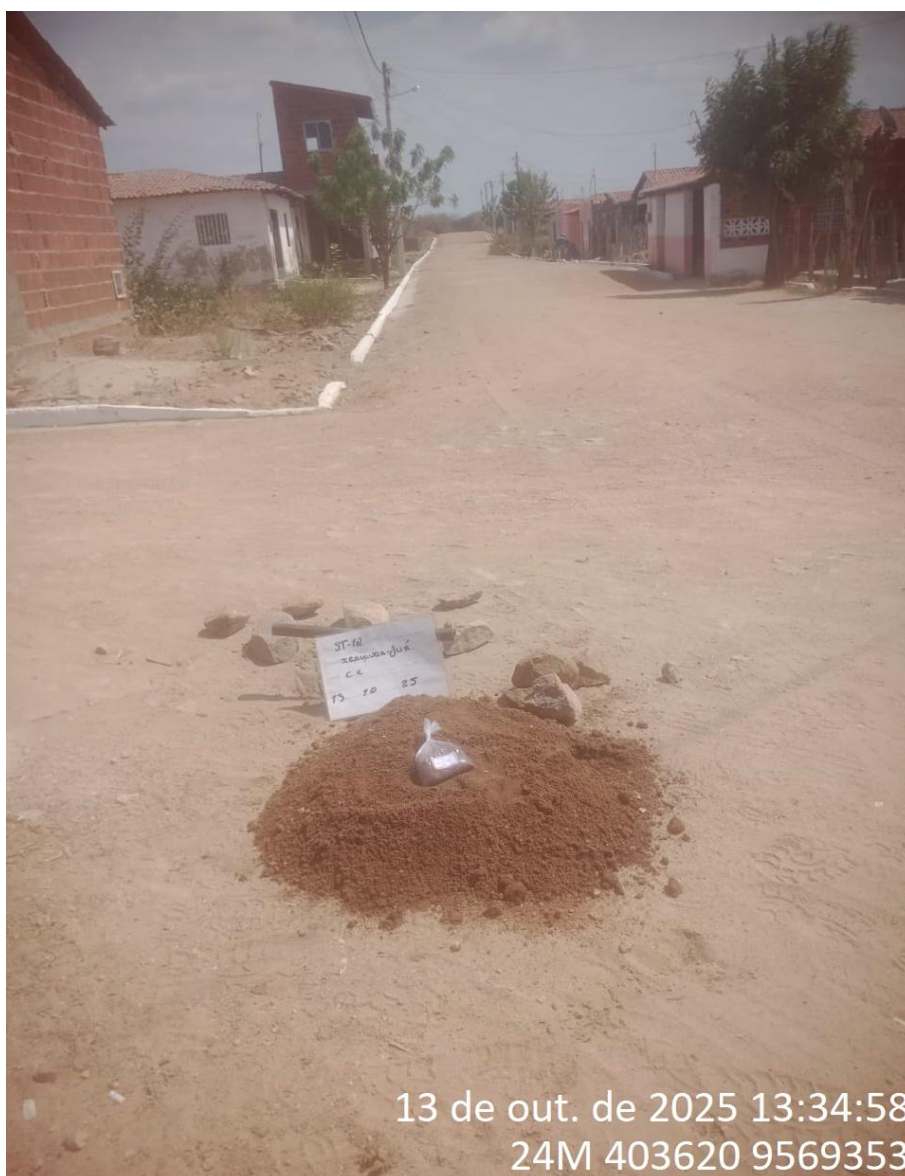
Instalação do furo 1.ST-12
