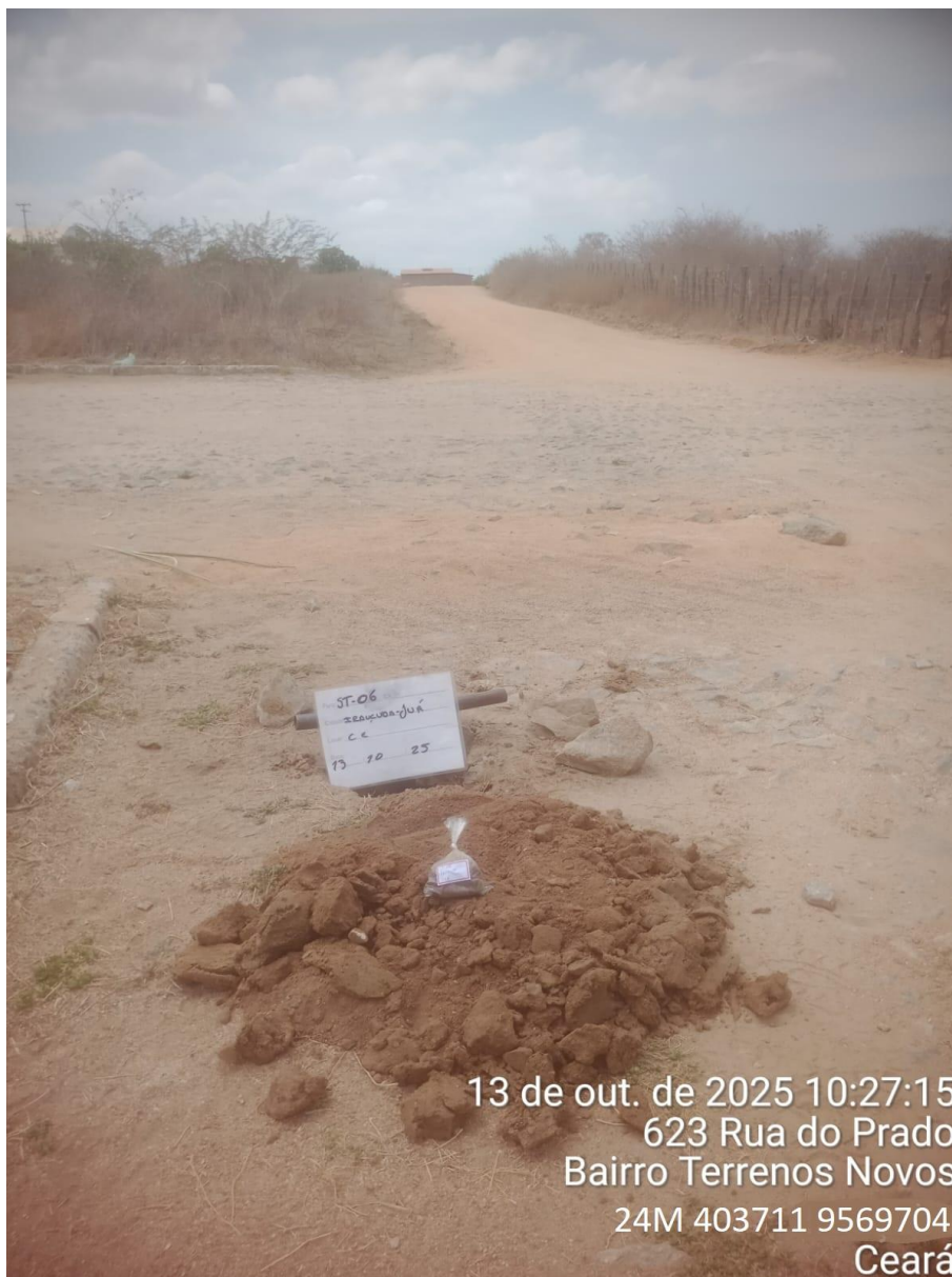
Instalação do furo 1.1.ST-06
