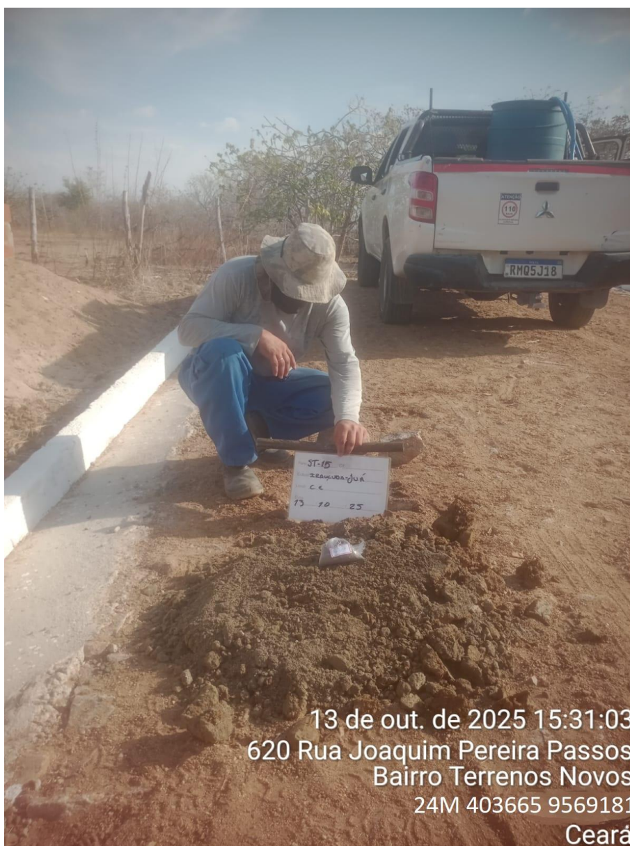
Instalação do furo 1.ST-15
