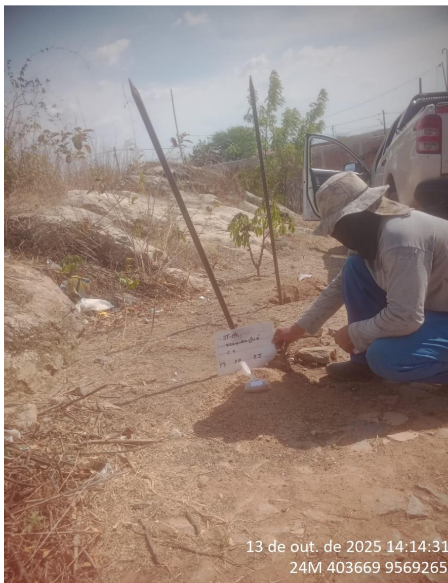
Instalação do furo 1.ST-14
