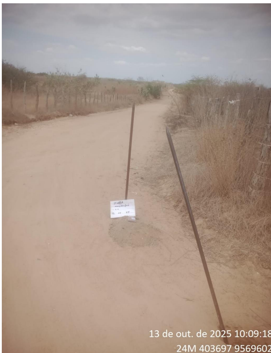
Instalação do furo 1.1.ST-05 A
