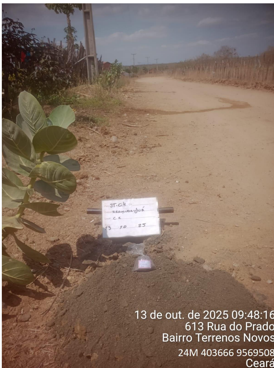
Instalação do furo 1.1.ST-04
