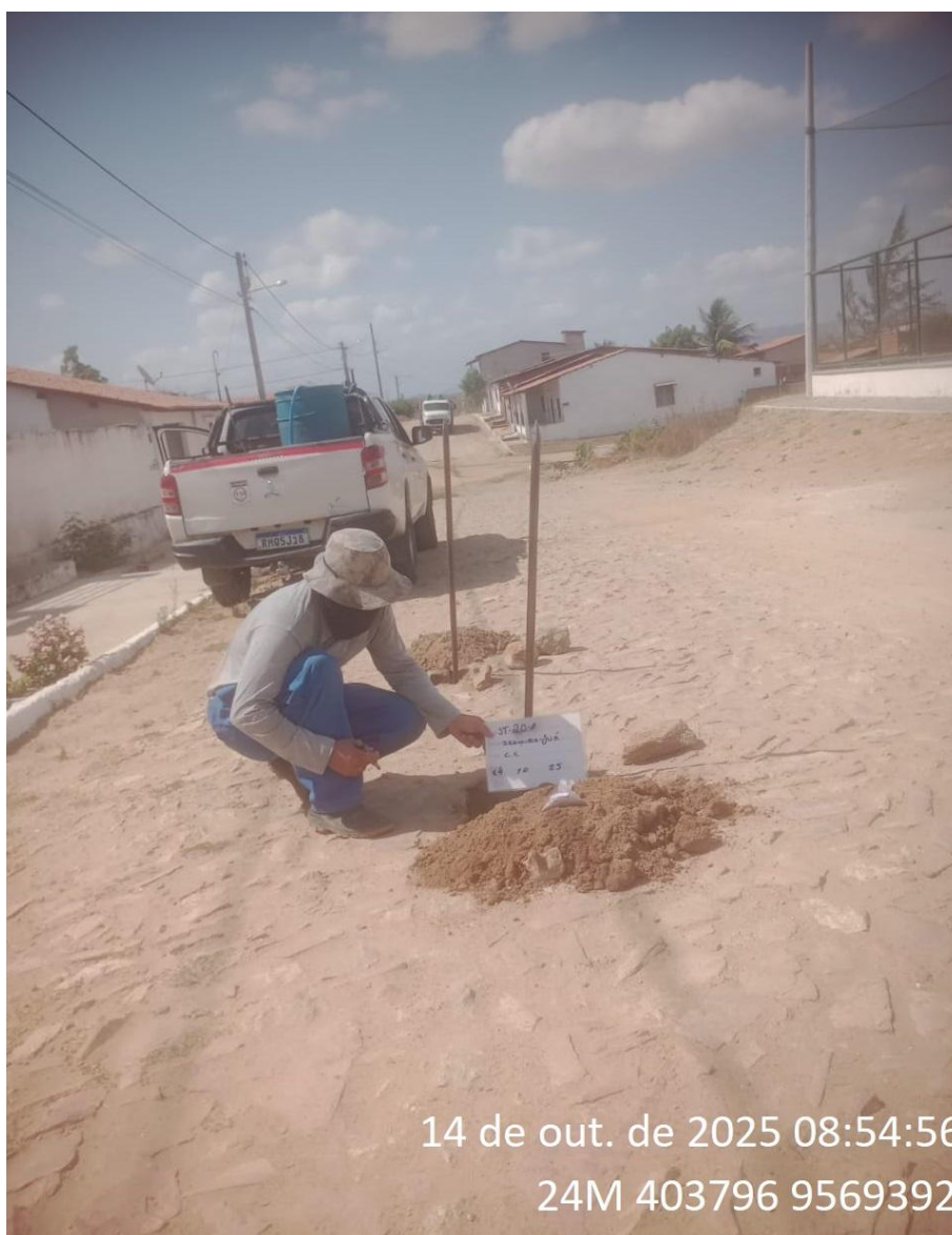
Instalação do furo 1.ST-20 A
