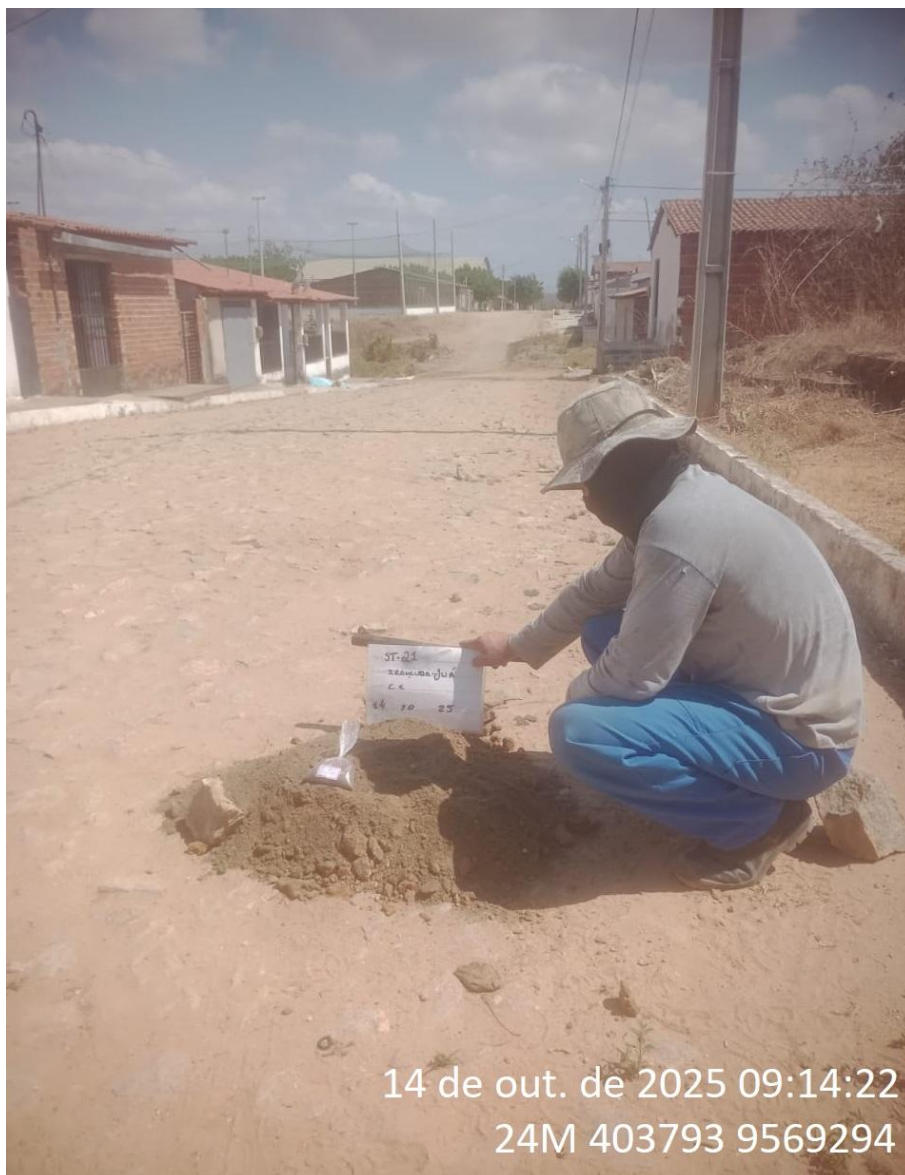
Instalação do furo 1.ST-21
