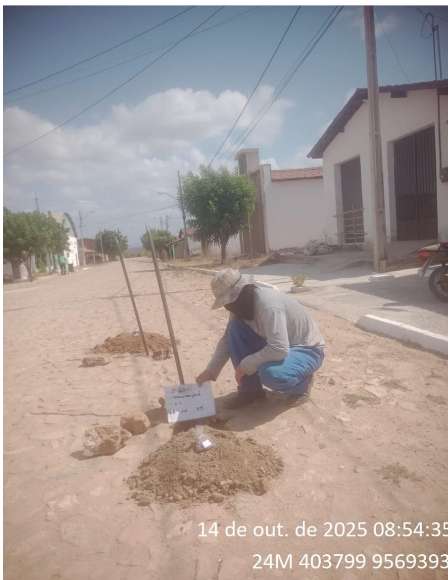
Instalação do furo 1.ST-20
