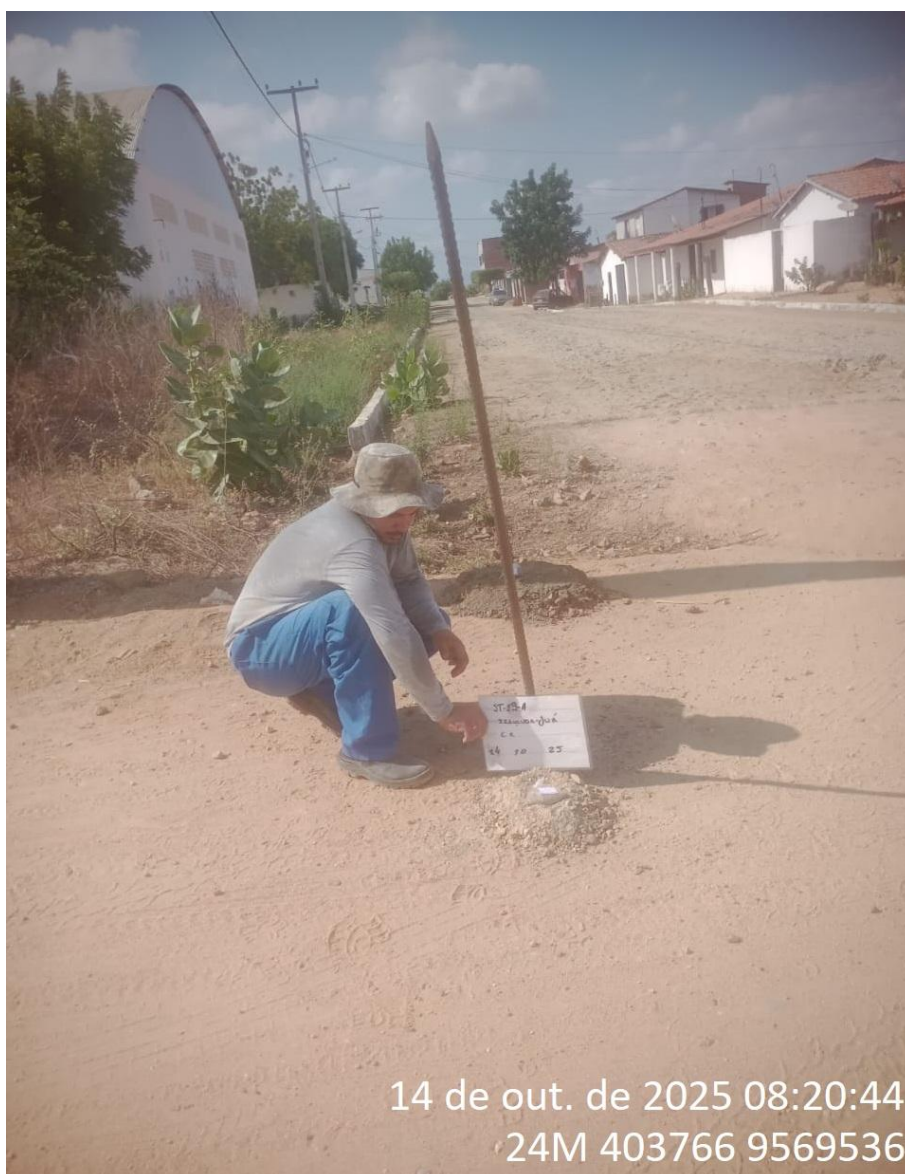
Instalação do furo 1.ST-19 A
