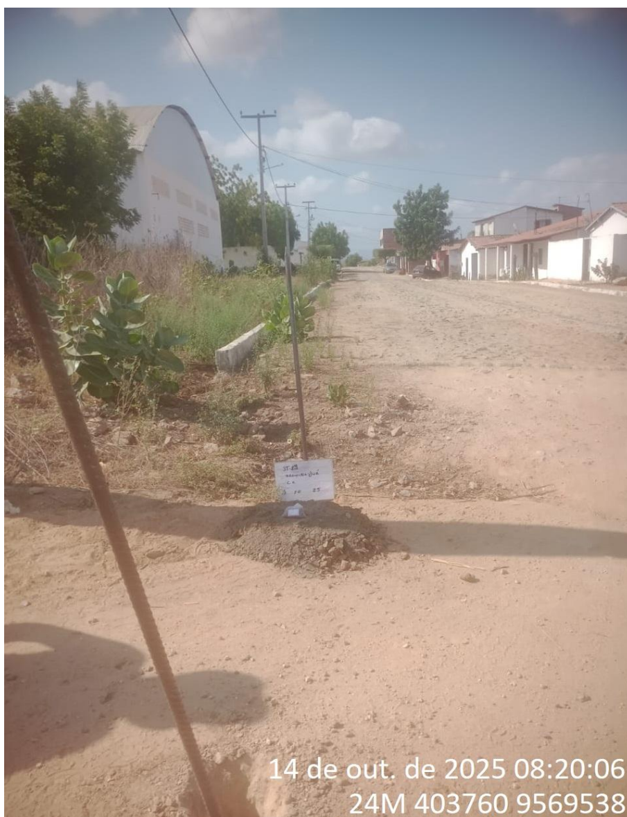
Instalação do furo 1.ST-19
