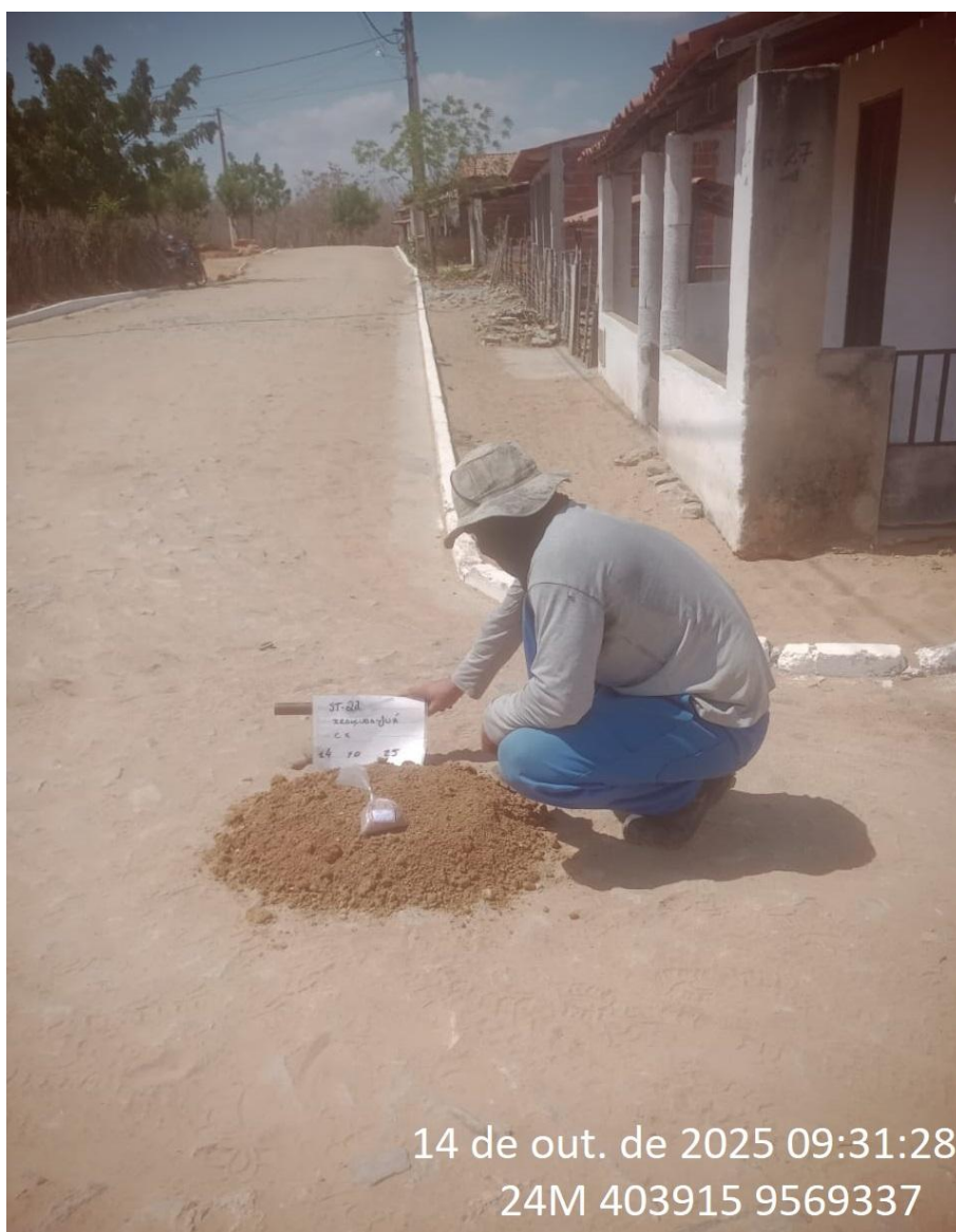
Instalação do furo 1.ST-22
