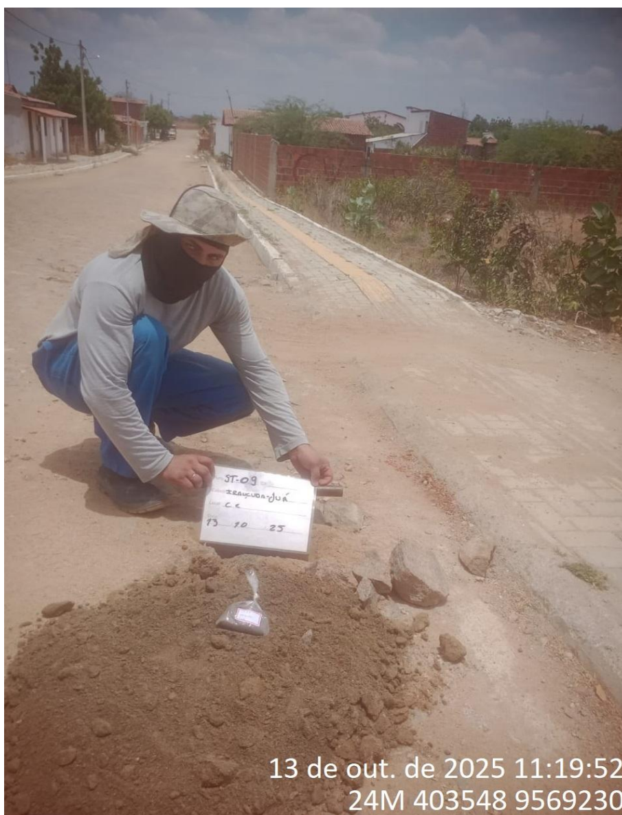
Instalação do furo 1.1.ST-09
