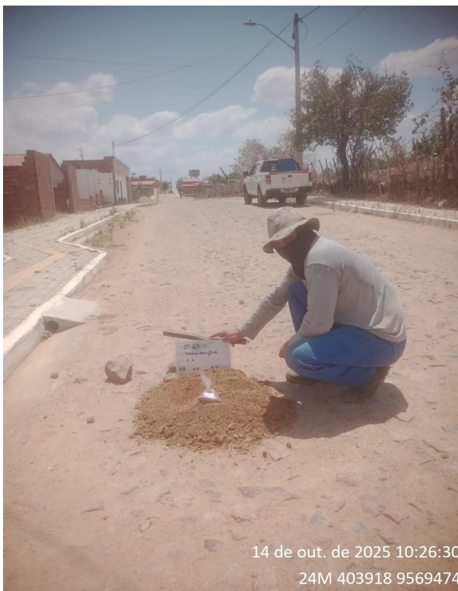
Instalação do furo 1.ST-24
