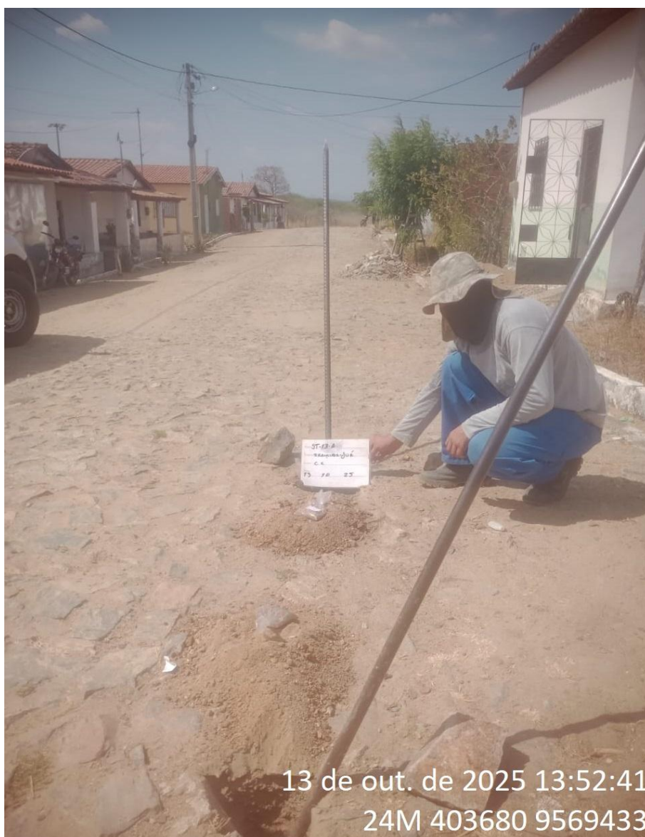
Instalação do furo 1.ST-13 A
