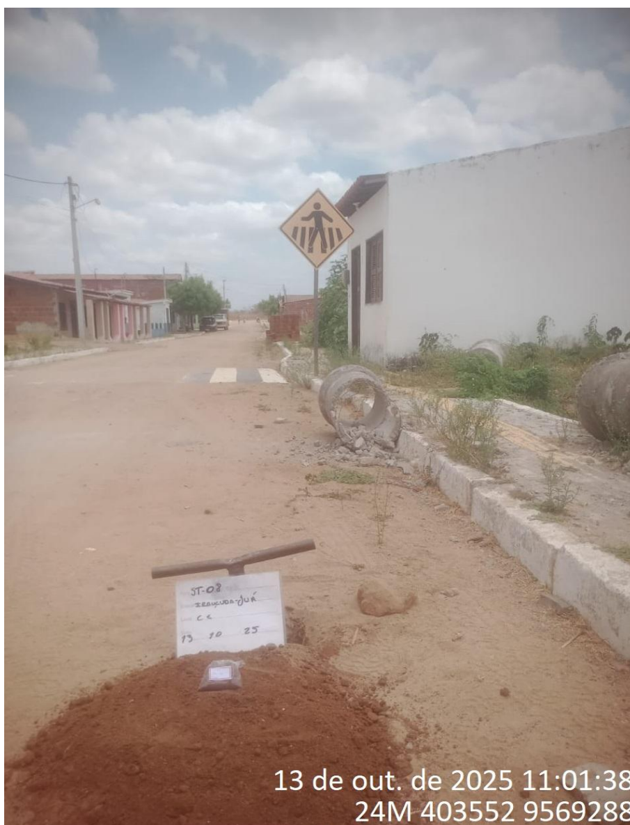
Instalação do furo 1.1.ST-08
