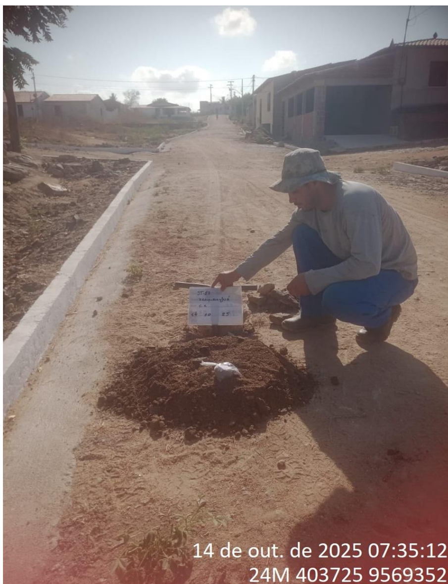
Instalação do furo 1.ST-17
