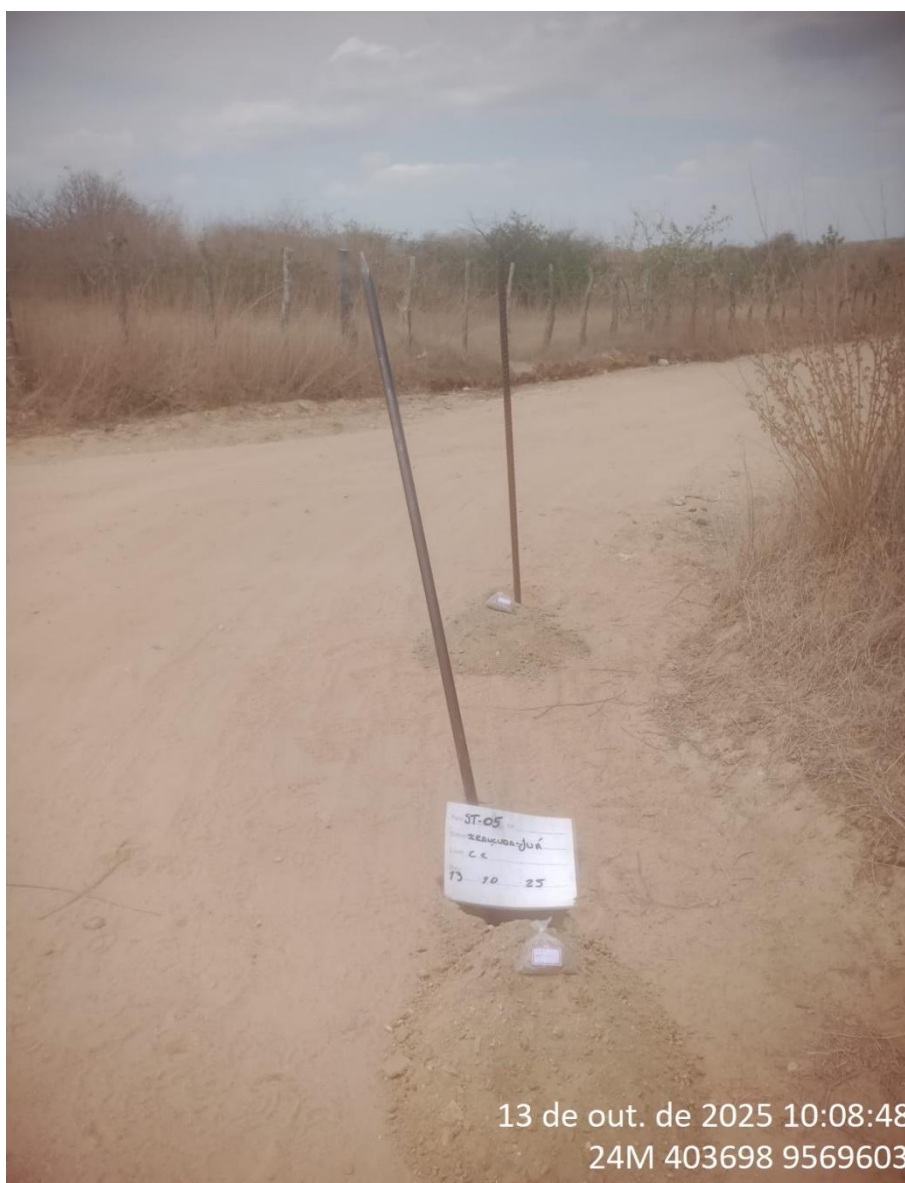
Instalação do furo 1.1.ST-05
