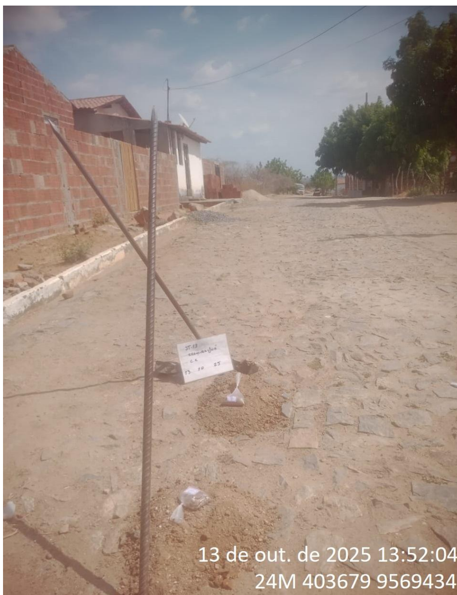
Instalação do furo 1.ST-13
