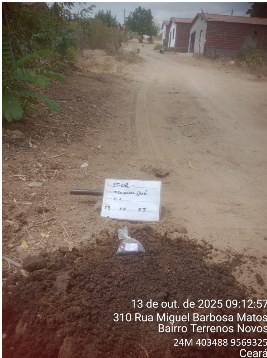
Instalação do furo 1.1.ST-02
