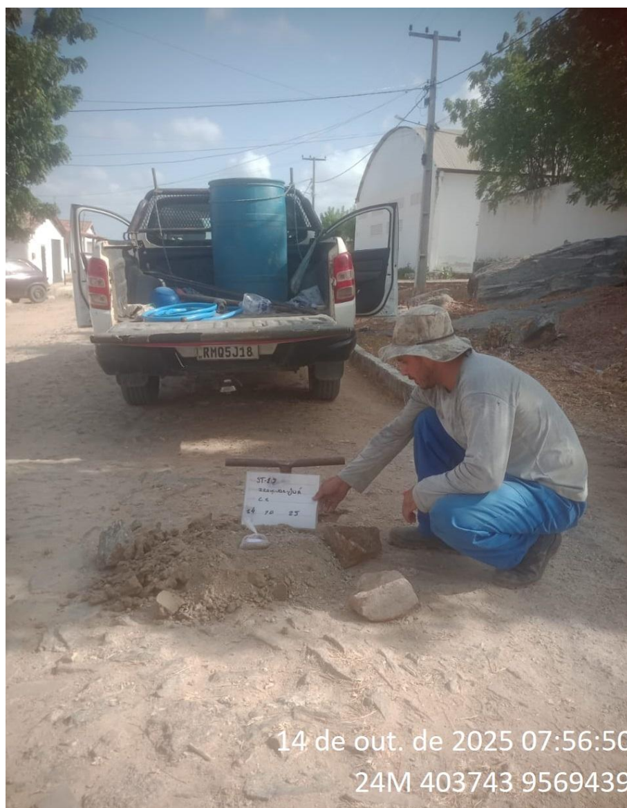
Instalação do furo 1.ST-18
