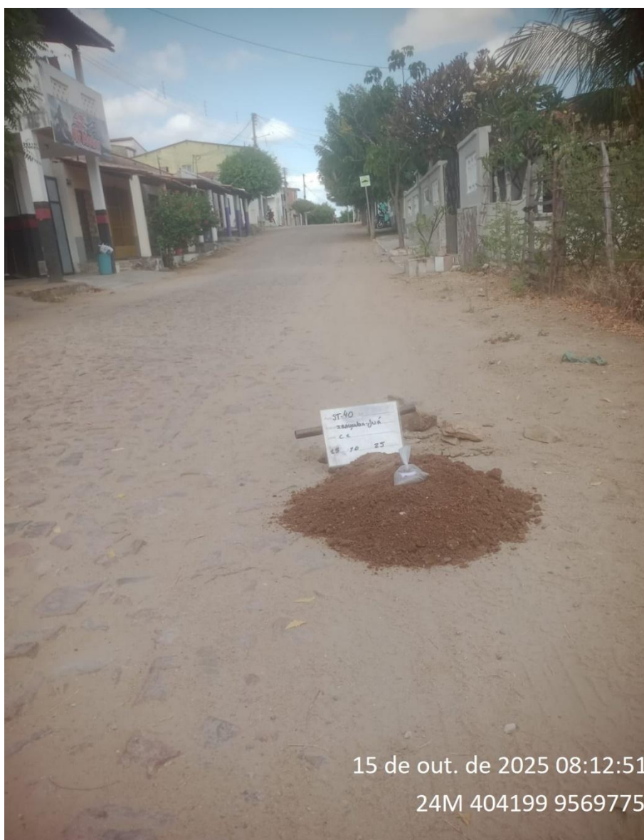
Instalação do furo 1.ST-40
