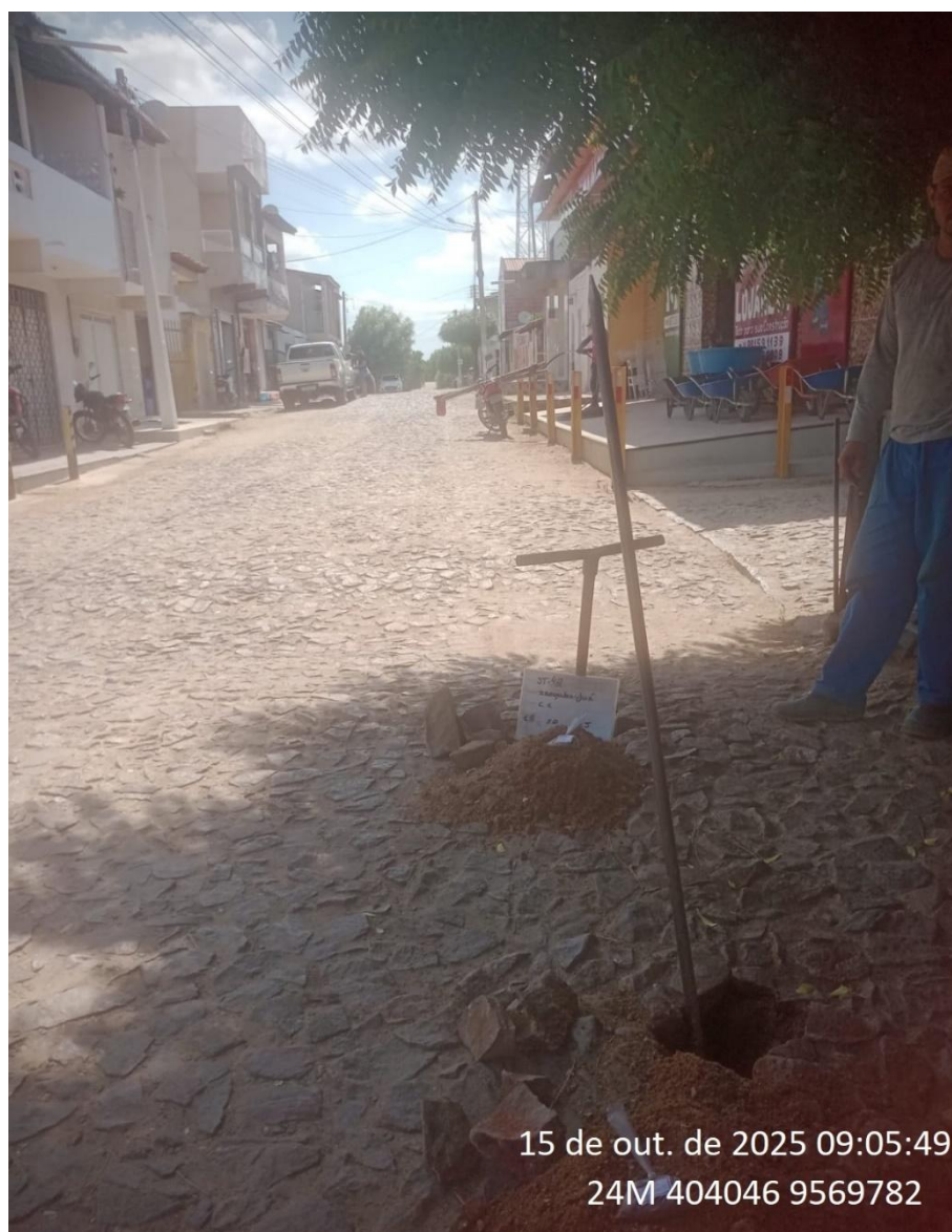
Instalação do furo 1.ST-42
