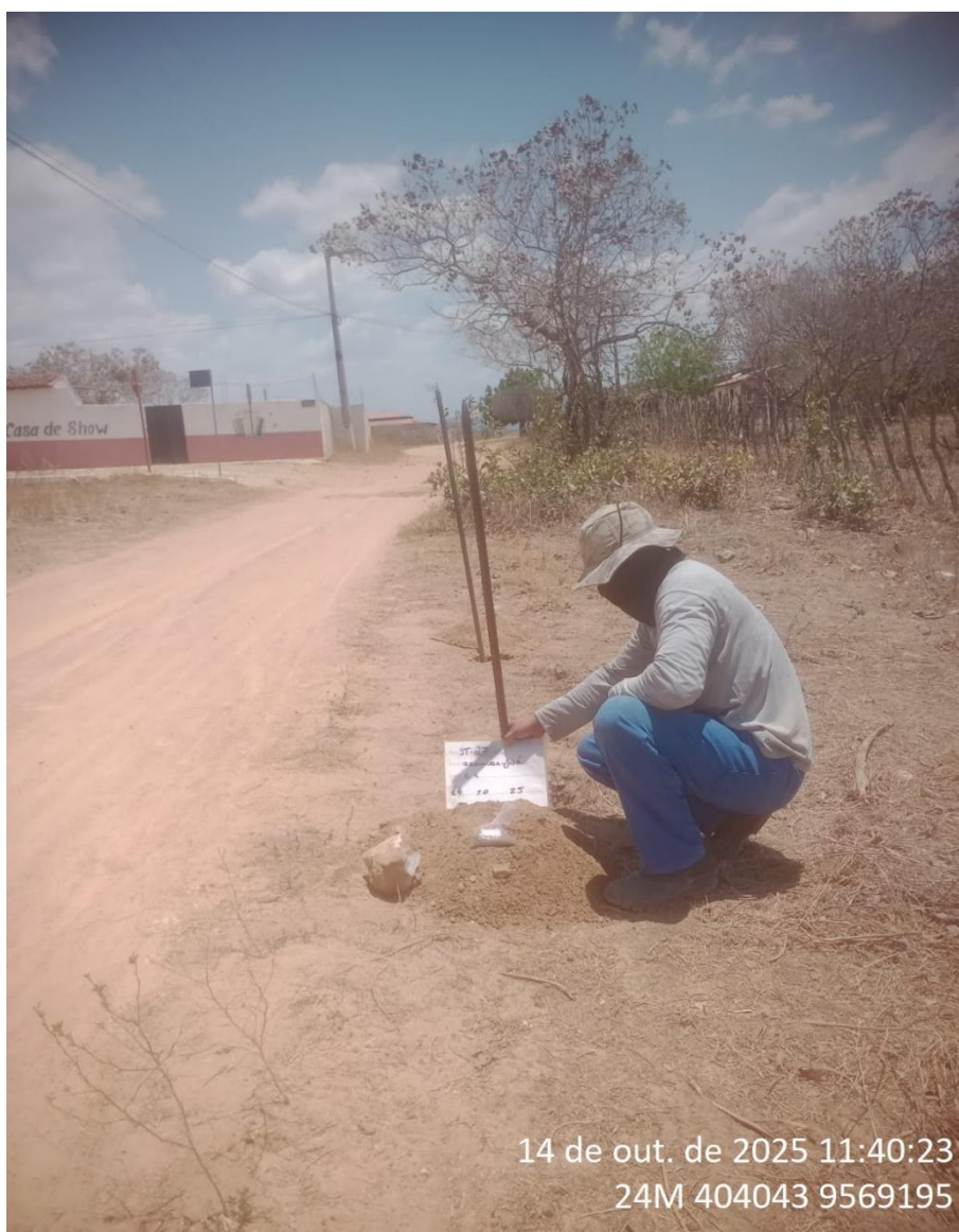
Instalação do furo 1.ST-27
