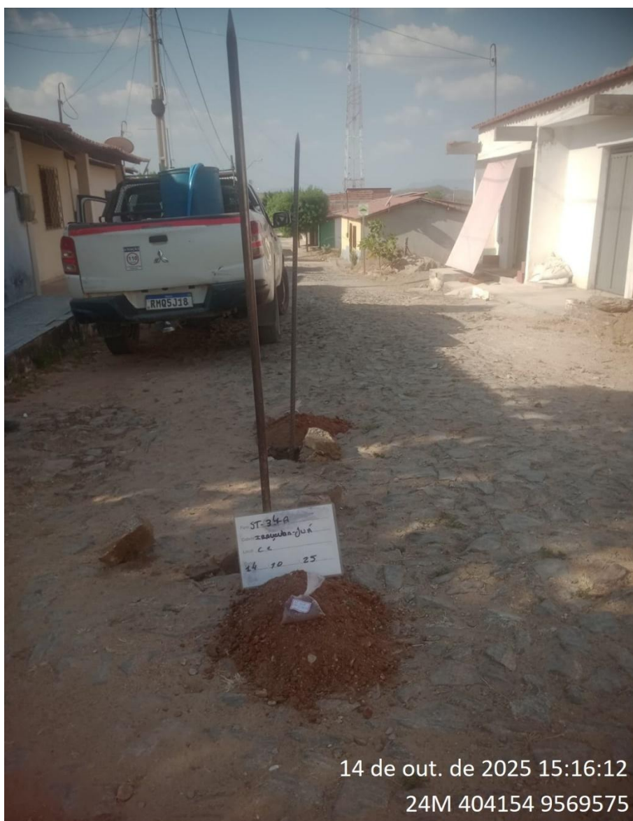
Instalação do furo 1.ST-34 A
