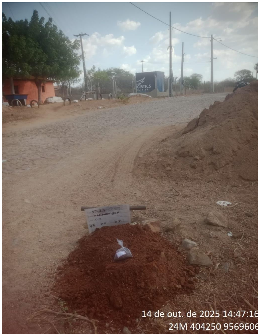
Instalação do furo 1.ST-33
