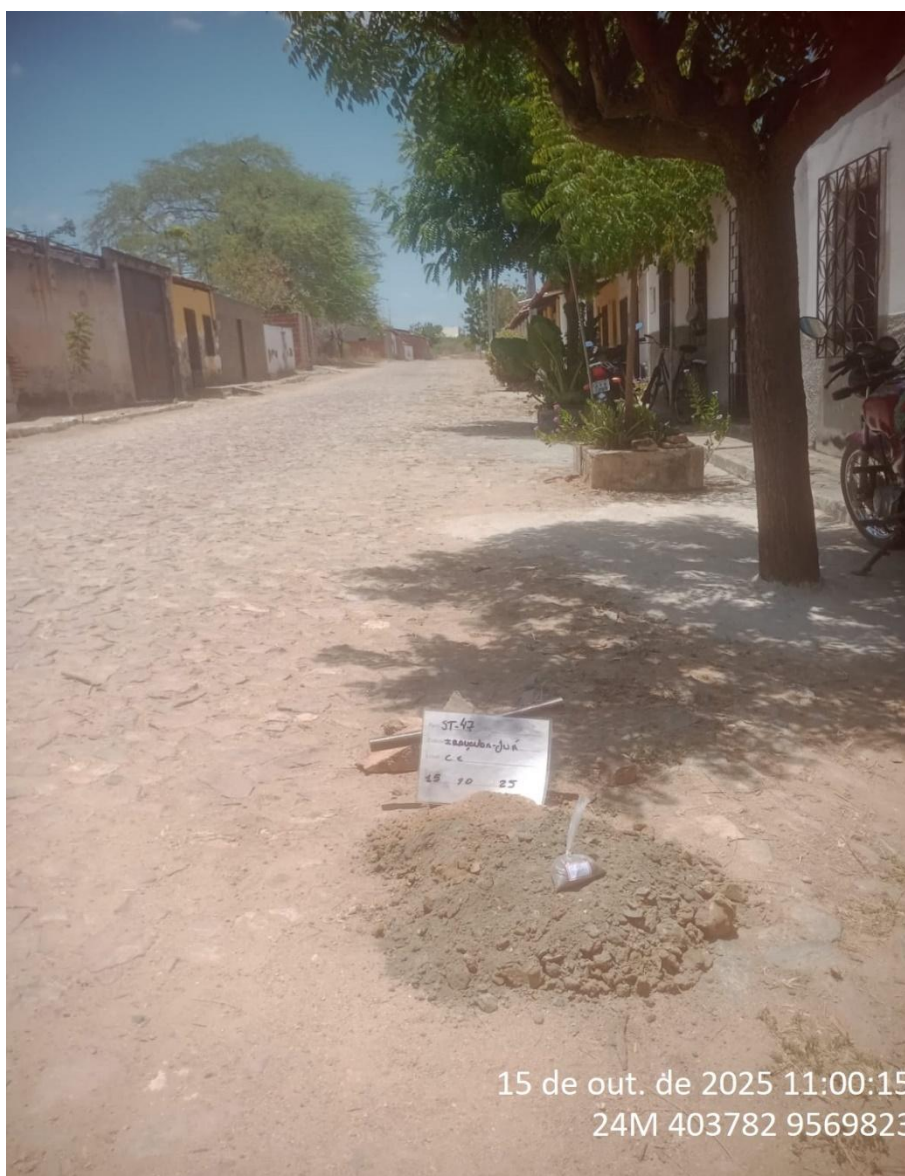
Instalação do furo 1.ST-47
