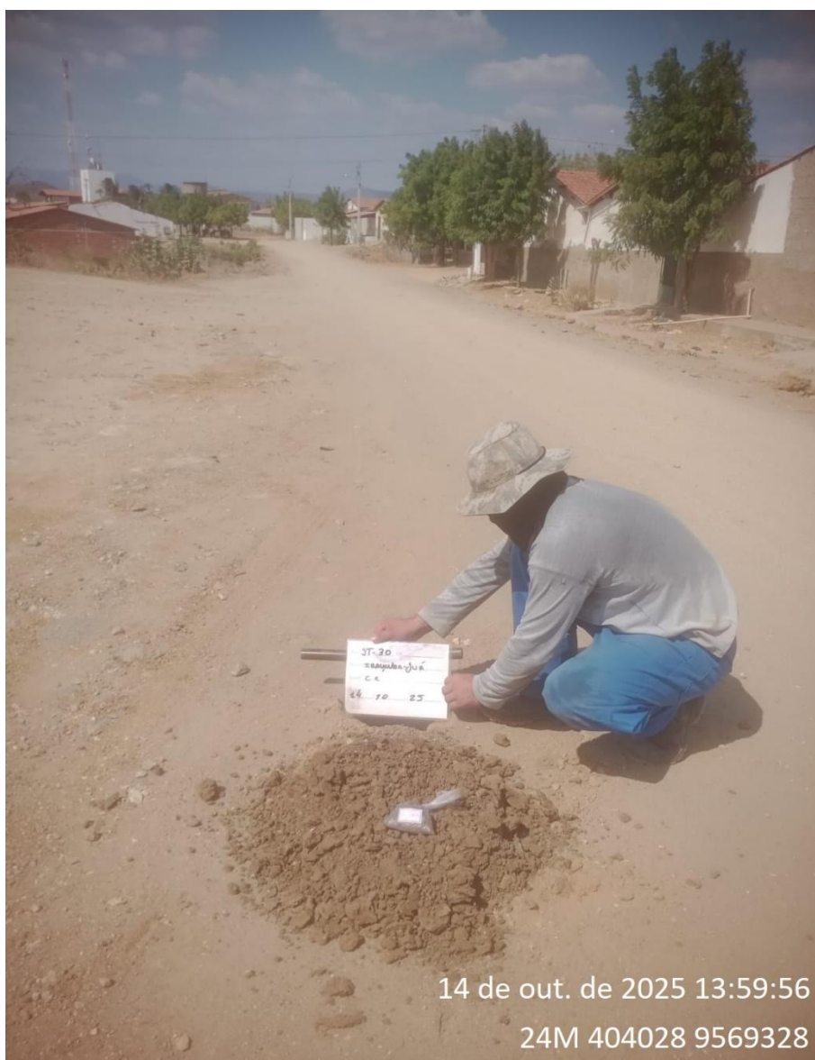
Instalação do furo 1.ST-30
