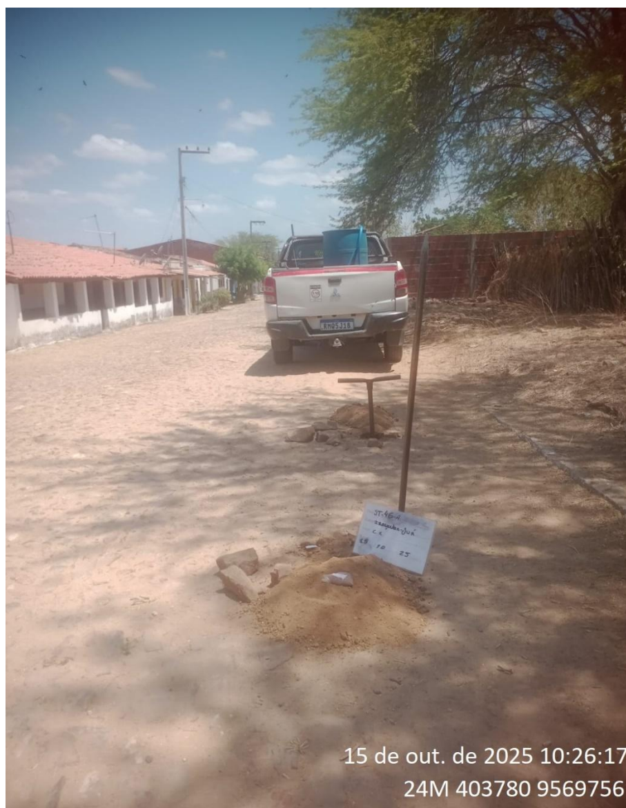
Instalação do furo 1.ST-46 A
