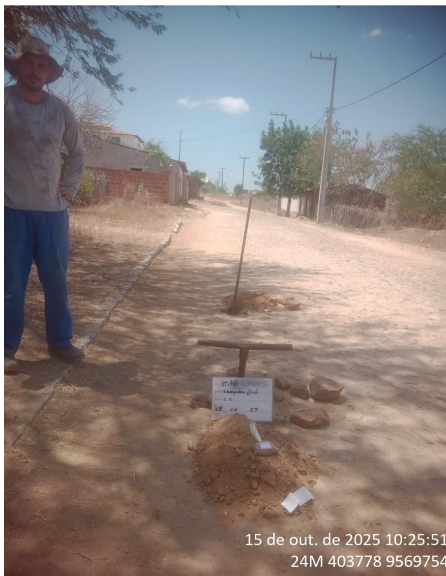
Instalação do furo 1.ST-46
