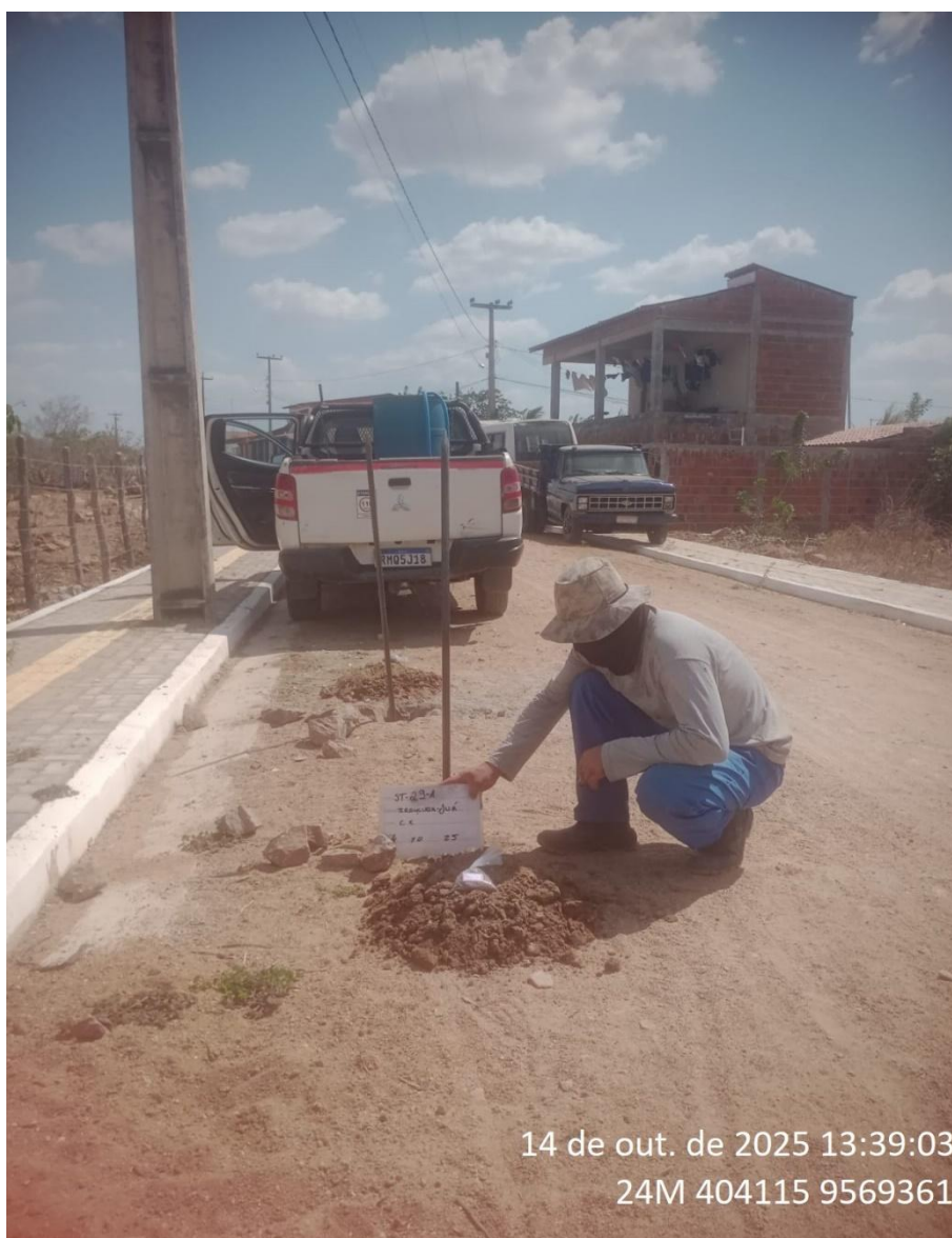
Instalação do furo 1.ST-29 A
