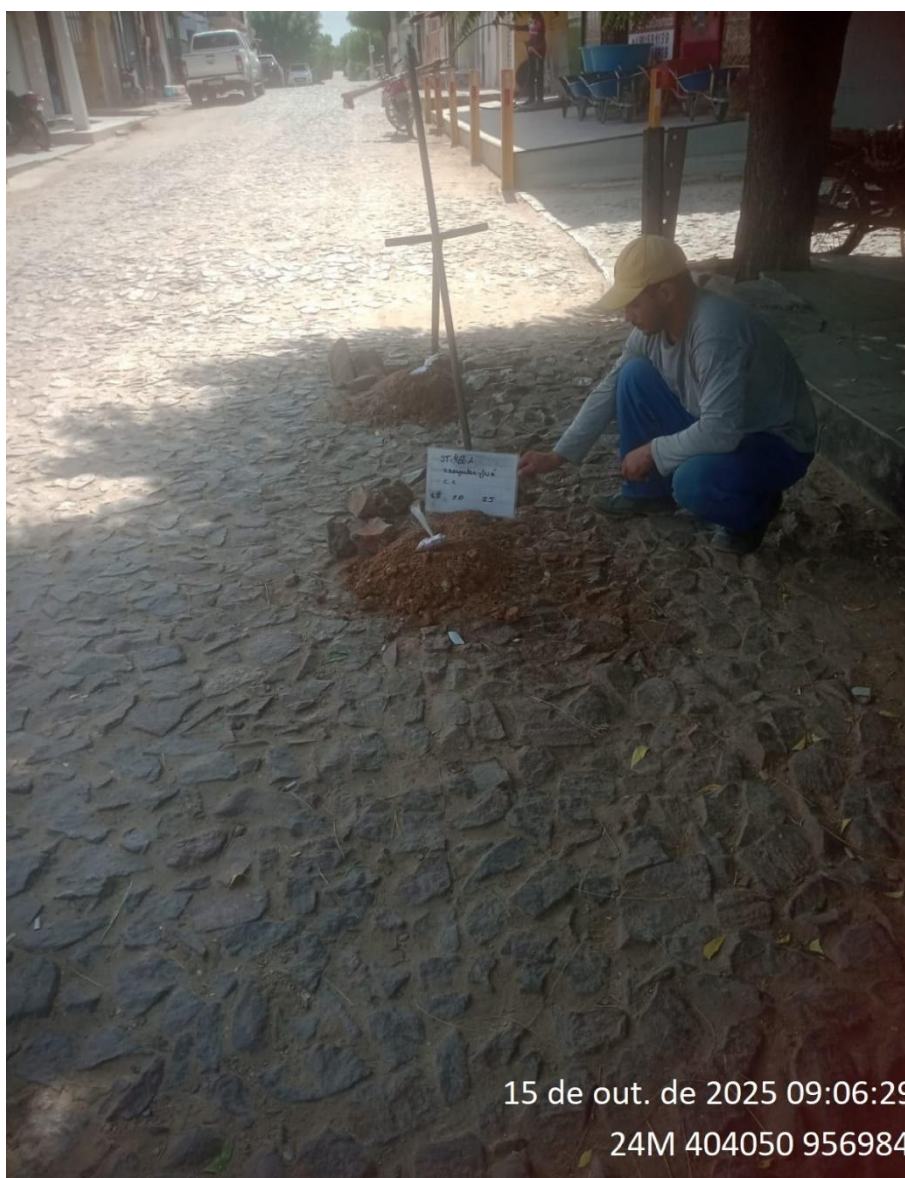
Instalação do furo 1.ST-42 A
