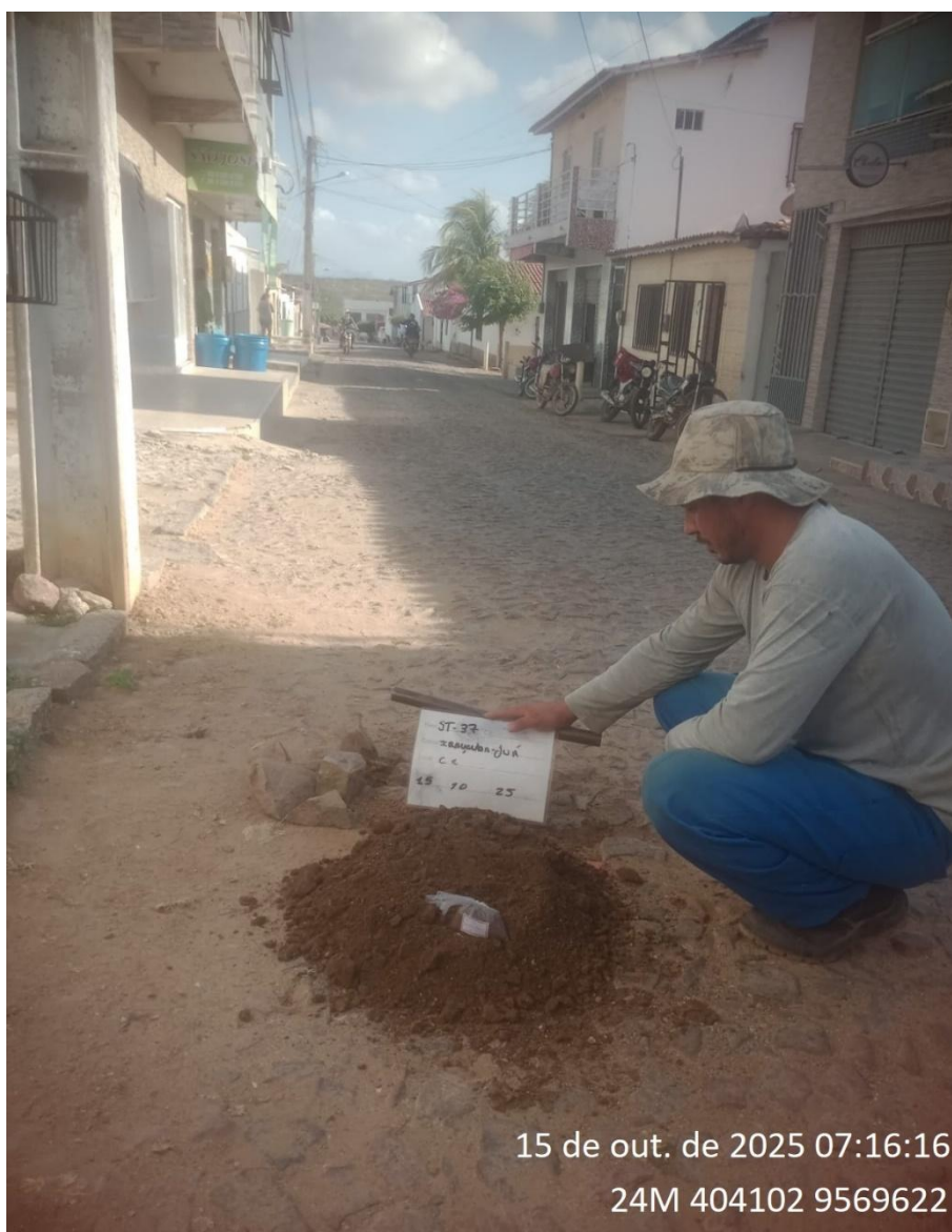
Instalação do furo 1.ST-37
