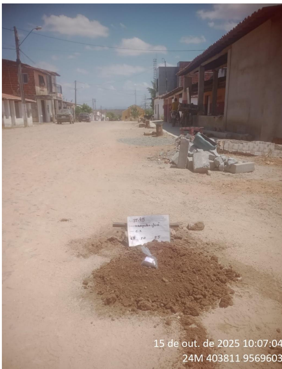
Instalação do furo 1.ST-45
