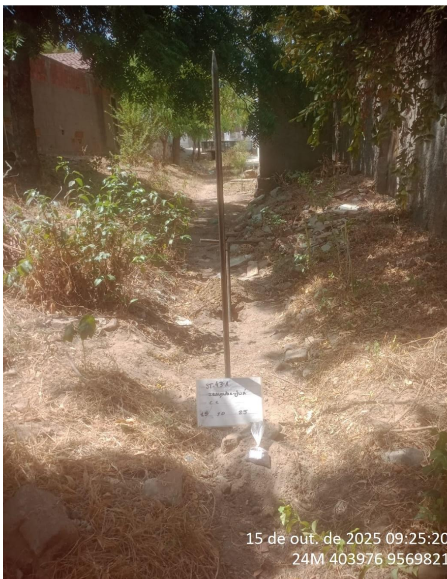
Instalação do furo 1.ST-43 A
