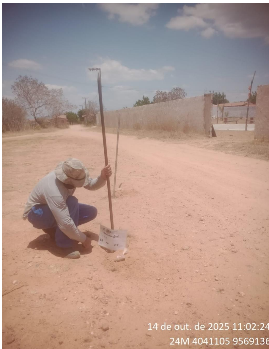
Instalação do furo 1.ST-26 A
