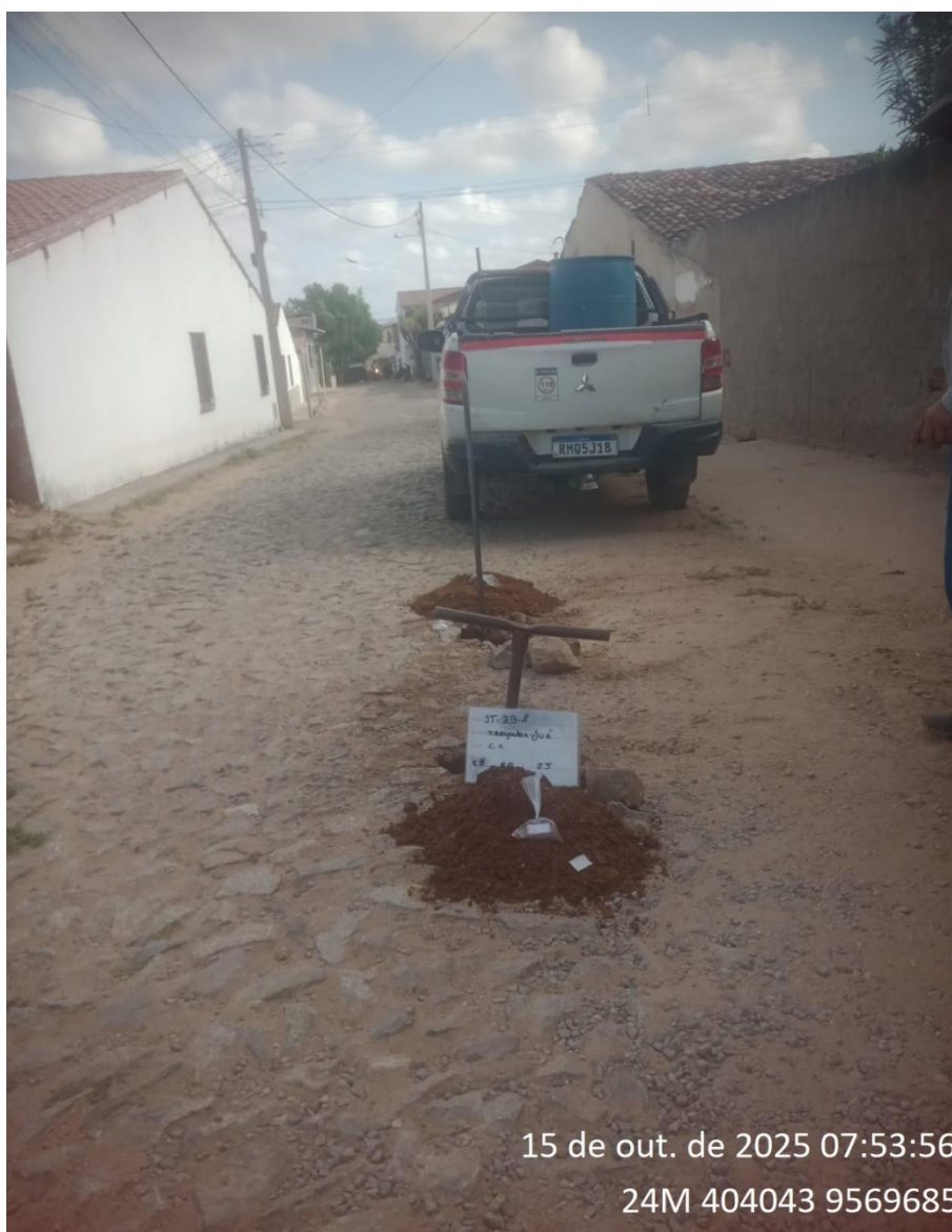
Instalação do furo 1.ST-39 A
