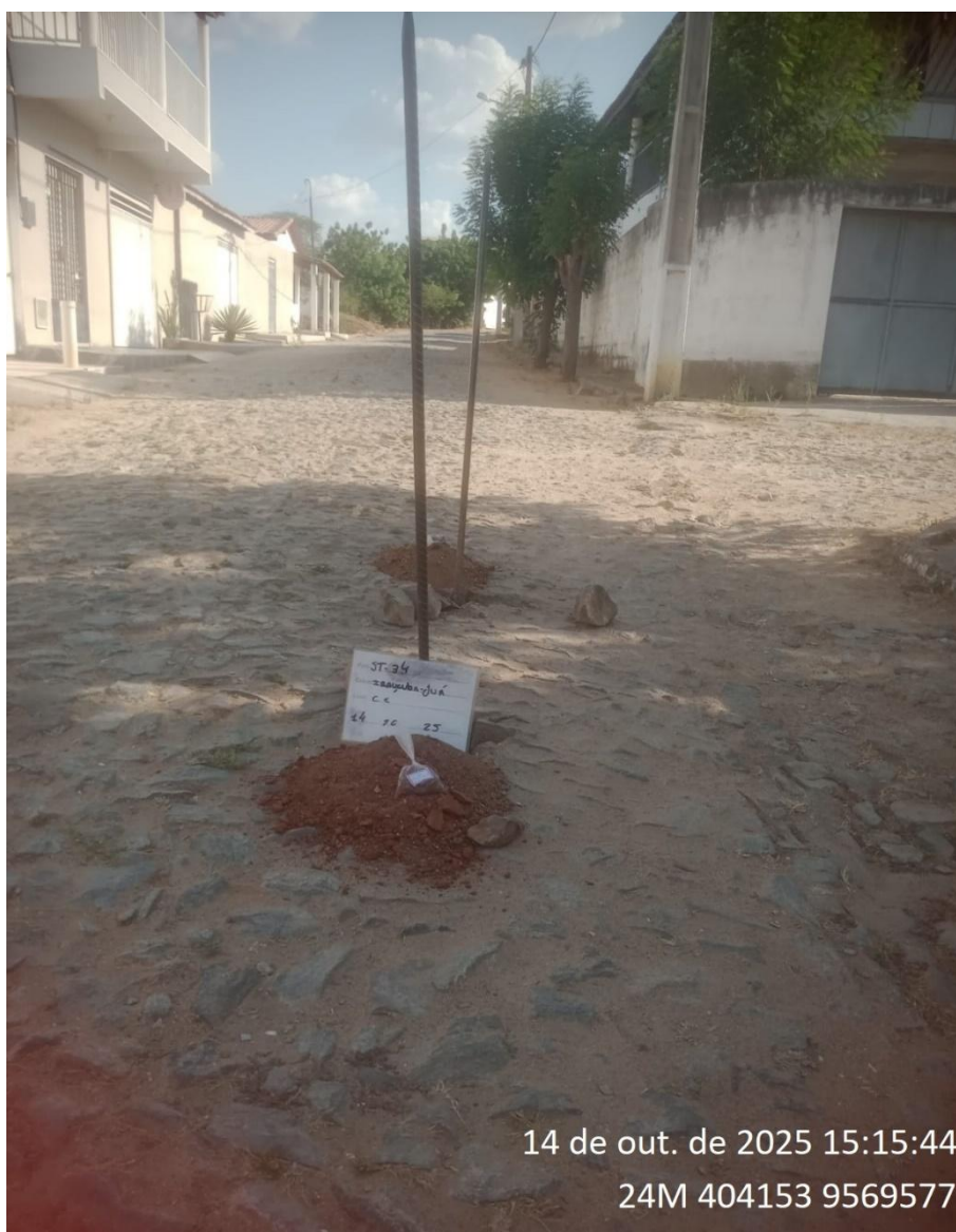
Instalação do furo 1.ST-34
