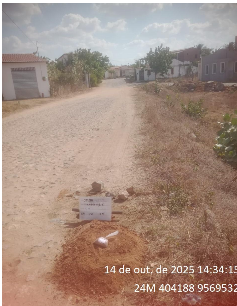
Instalação do furo 1.ST-32
