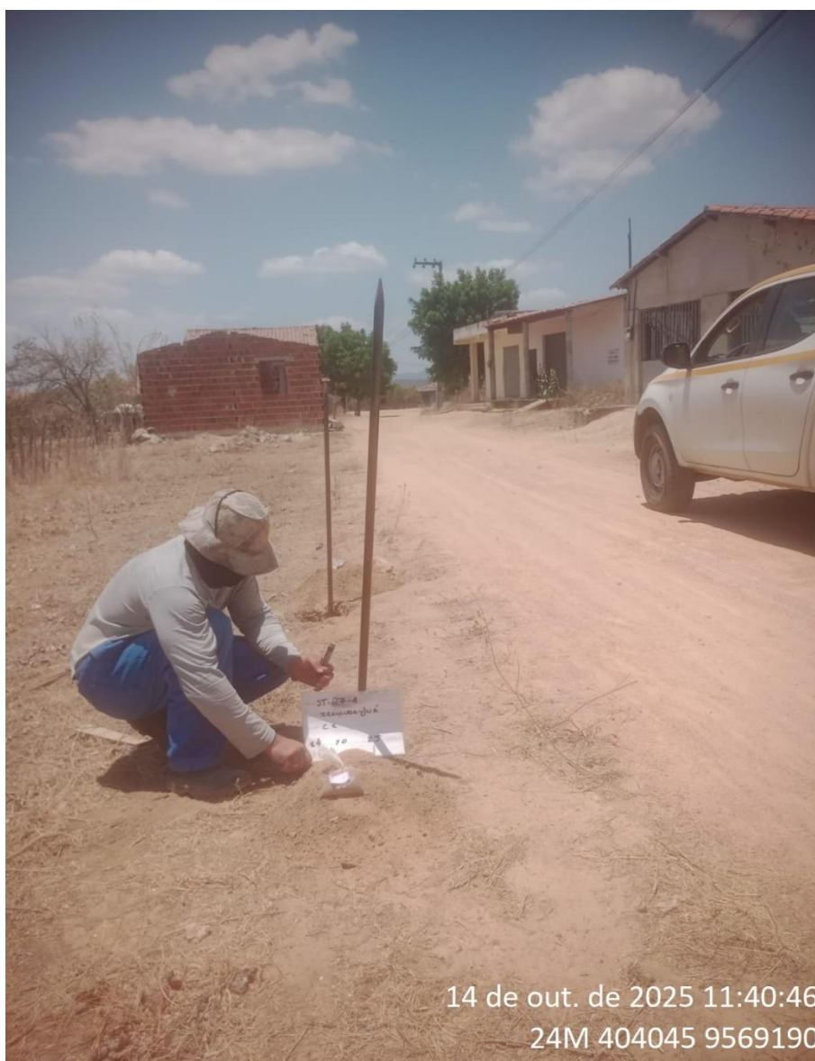
Instalação do furo 1.ST-27 A
