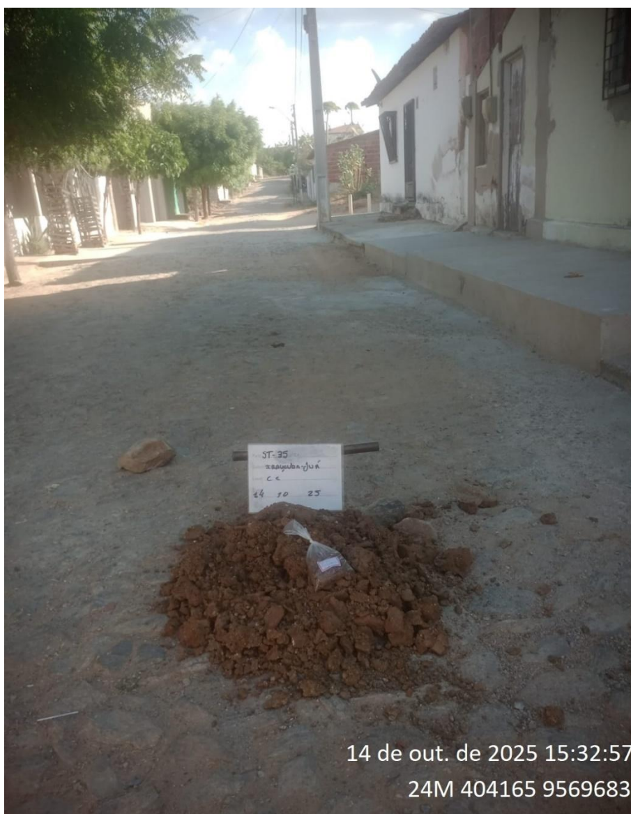
Instalação do furo 1.ST-35
