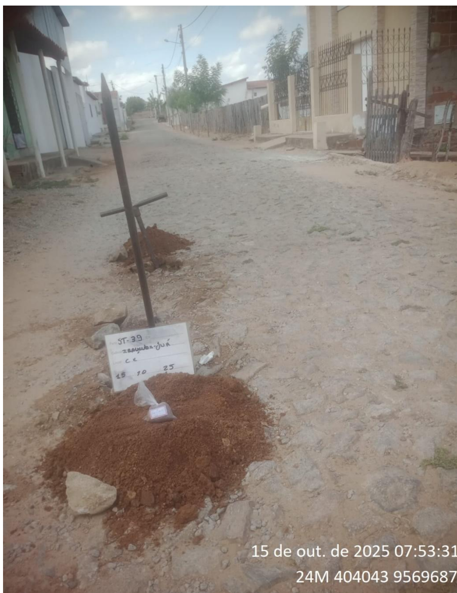
Instalação do furo 1.ST-39
