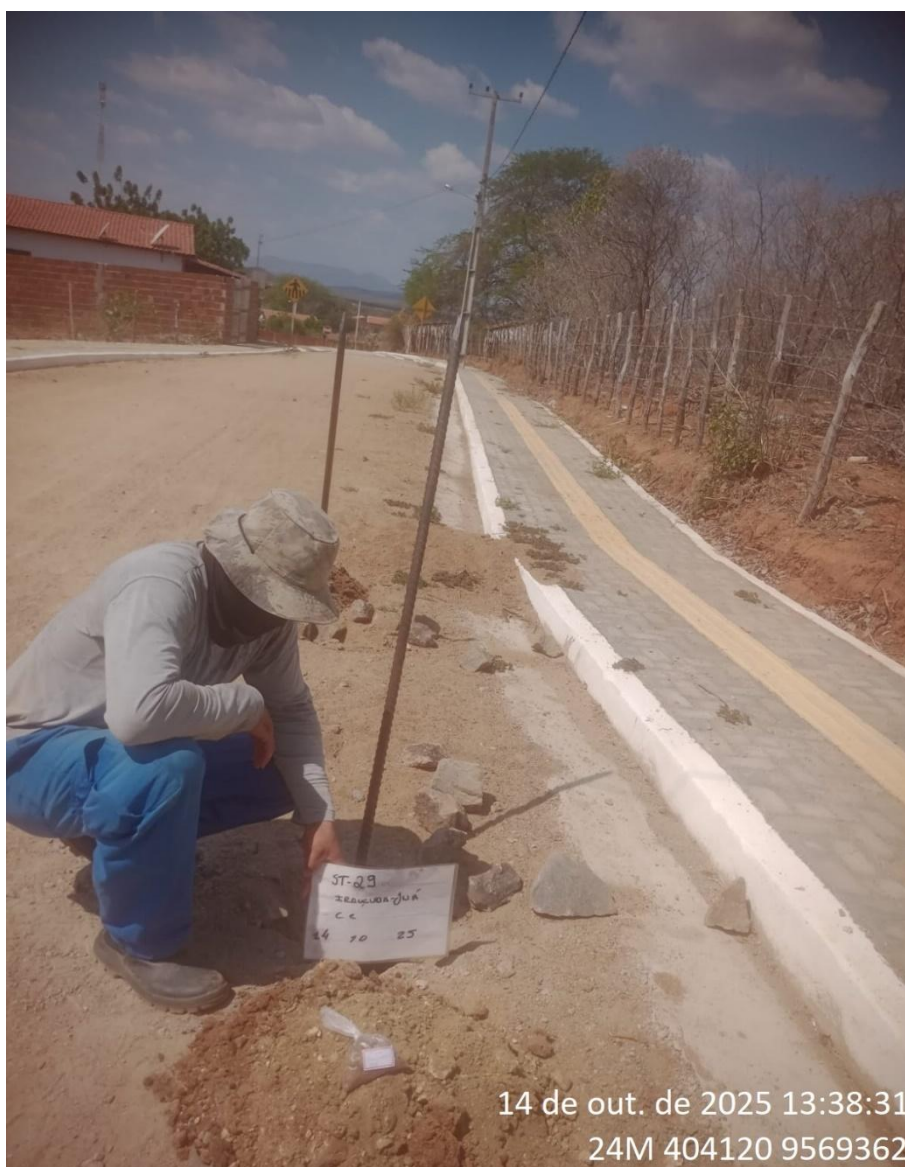
Instalação do furo 1.ST-29
