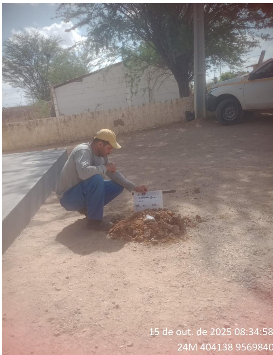
Instalação do furo 1.ST-41
