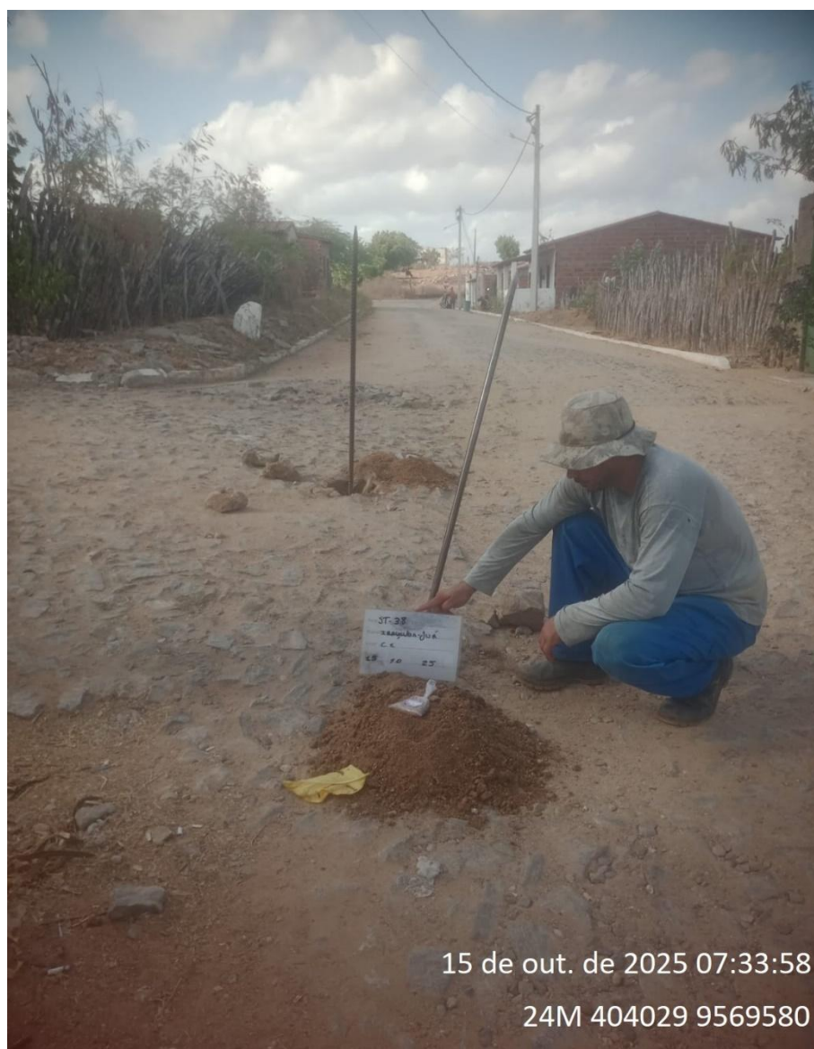
Instalação do furo 1.ST-38
