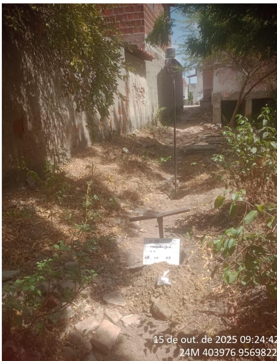
Instalação do furo 1.ST-43
