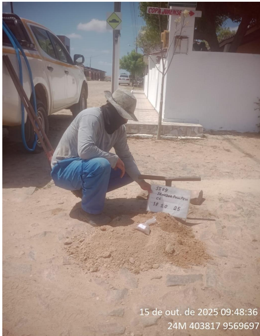
Instalação do furo 1.ST-44
