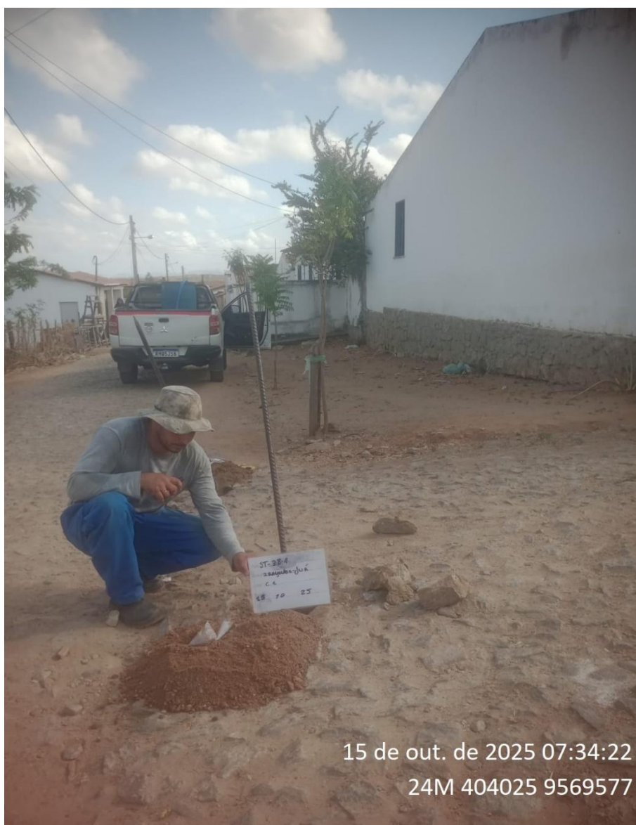
Instalação do furo 1.ST-38 A
