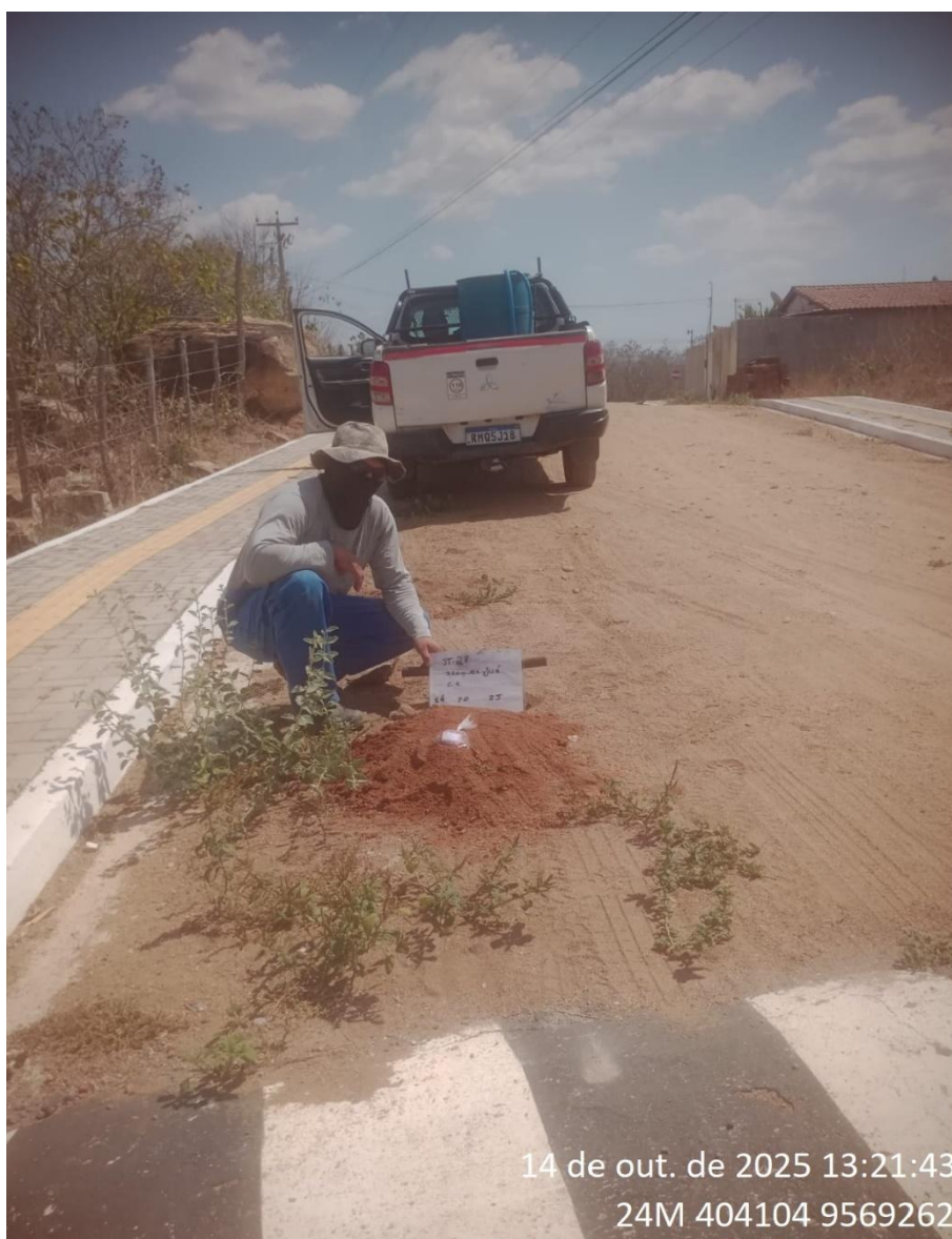
Instalação do furo 1.ST-28
