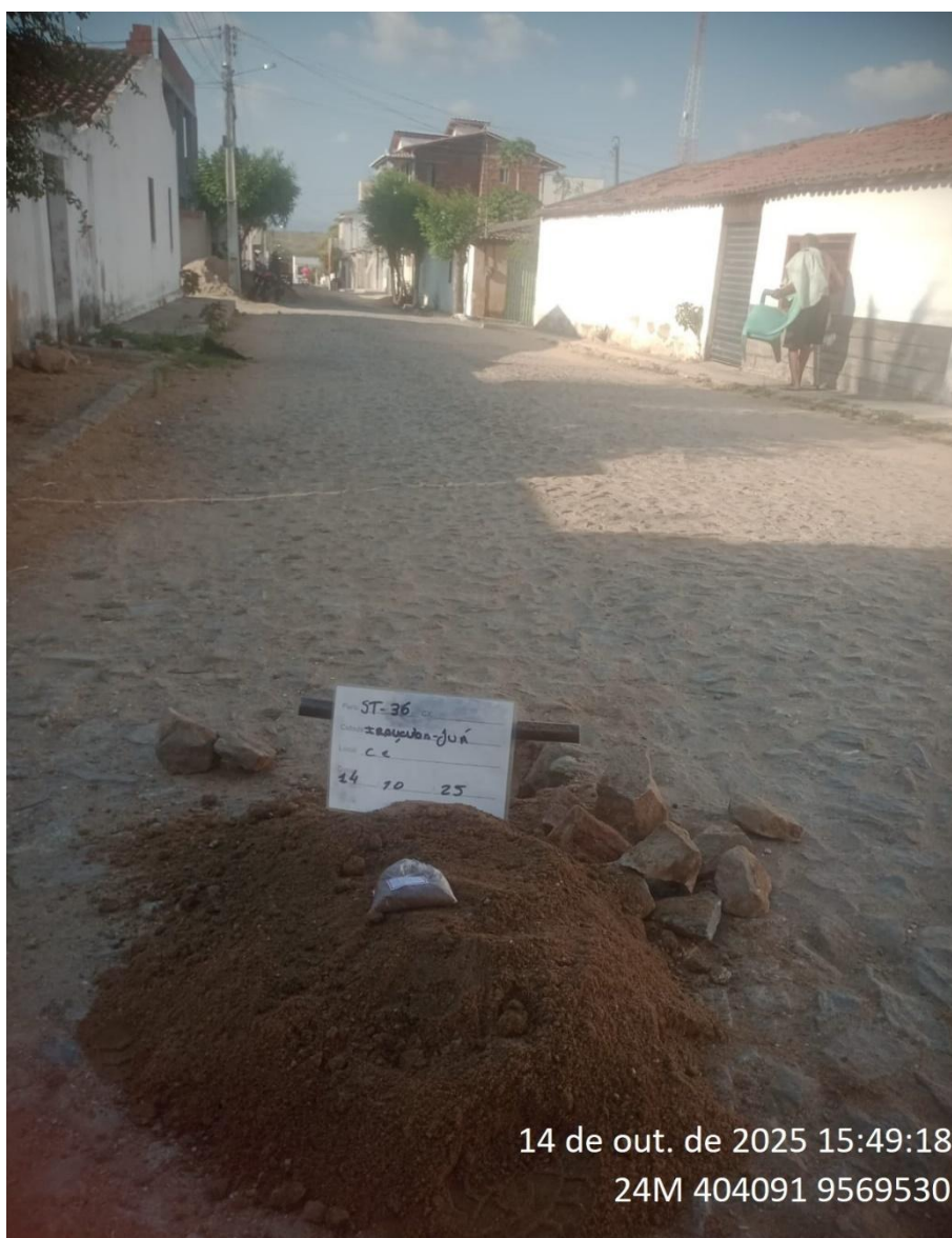
Instalação do furo 1.ST-36
