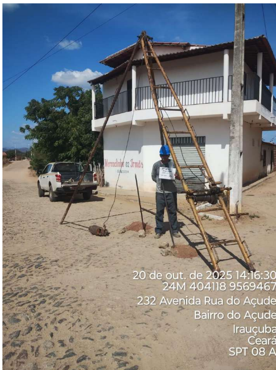
Instalação do furo 1.SPT-08 A
