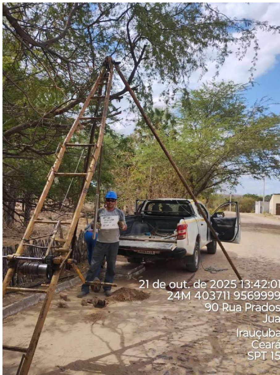
Instalação do furo 1.SPT-15
