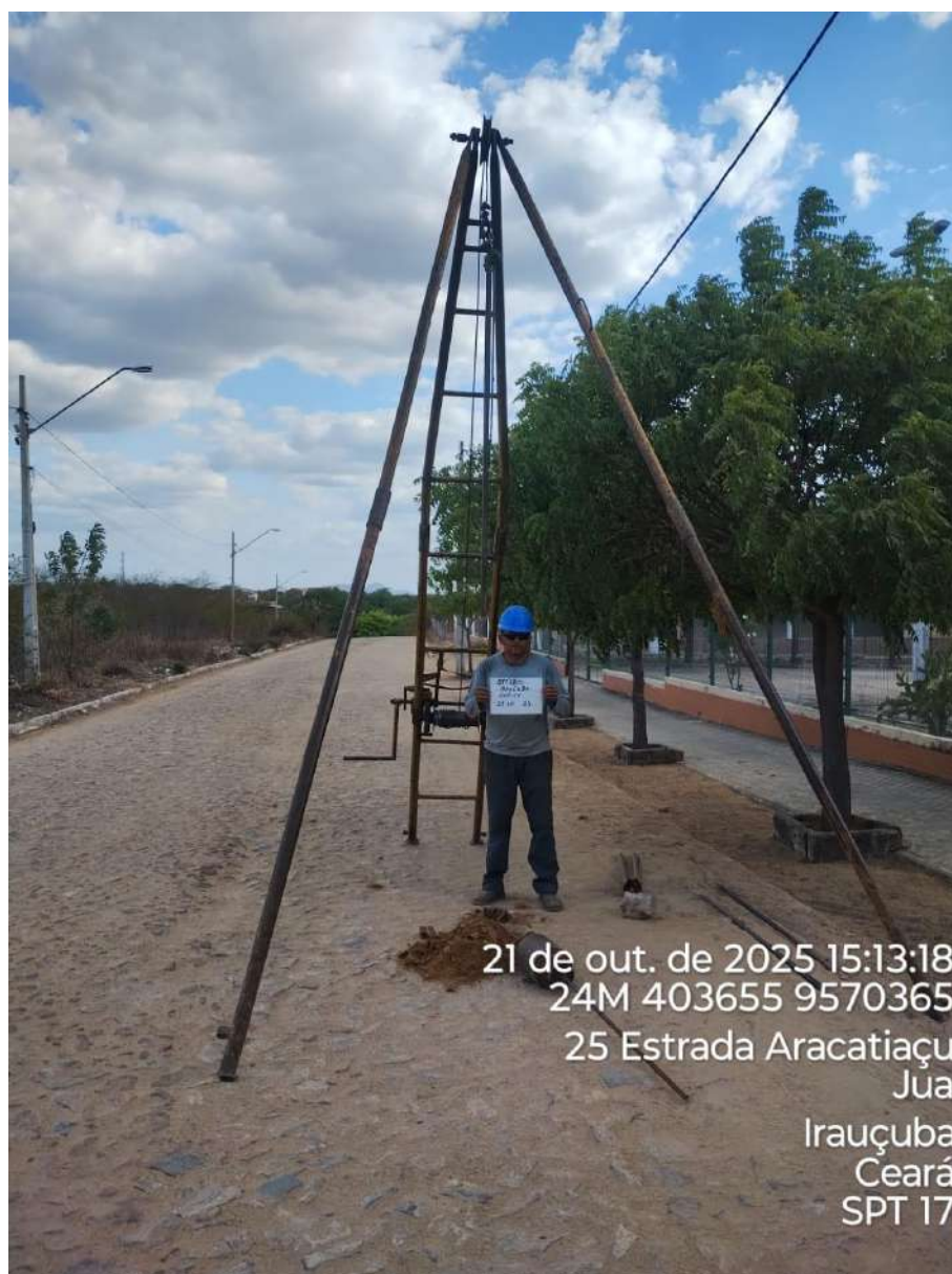
Instalação do furo 1.SPT-17
