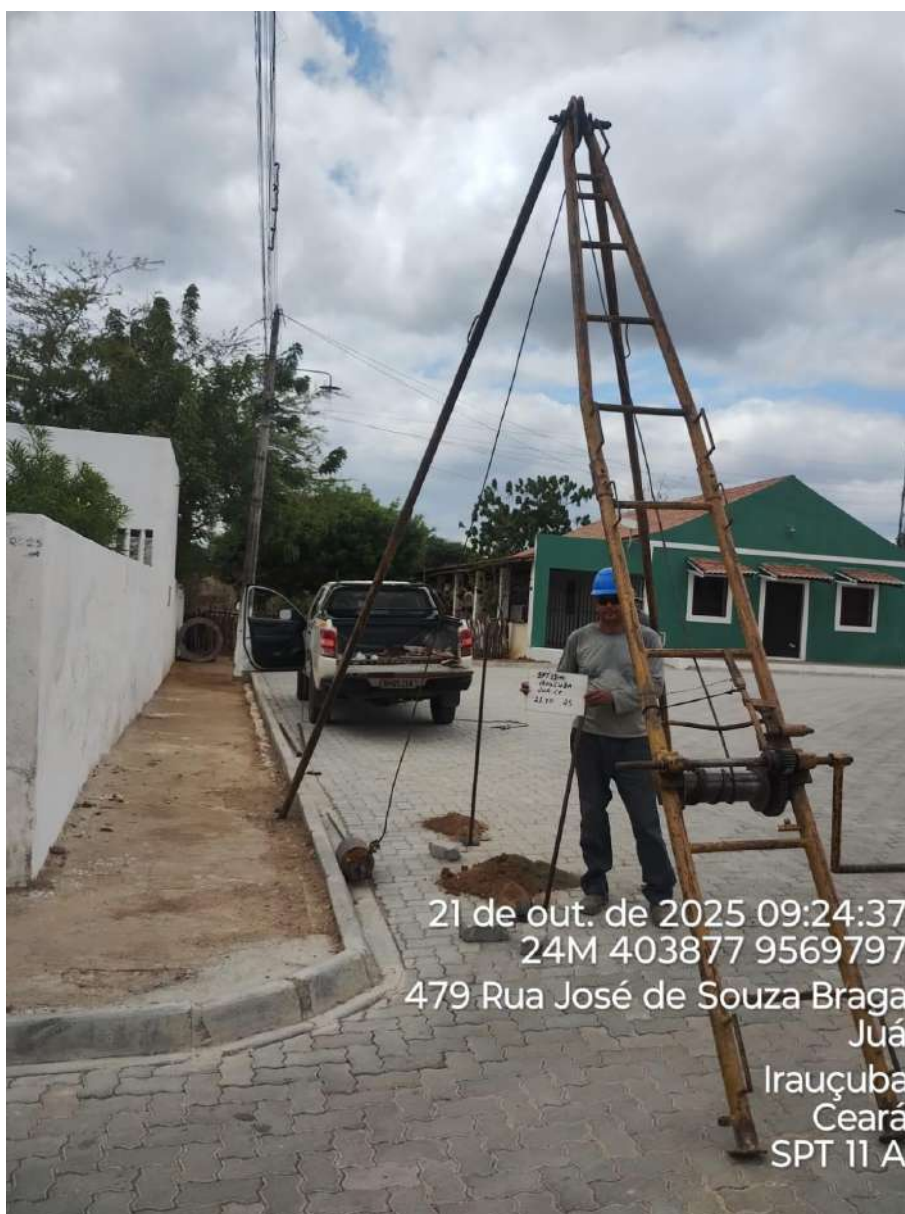
Instalação do furo 1.SPT-11 A
