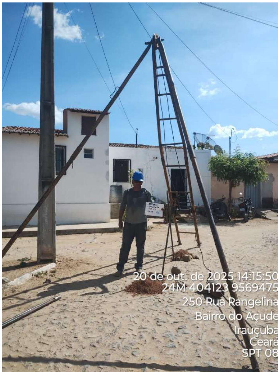
Instalação do furo 1.SPT-08
