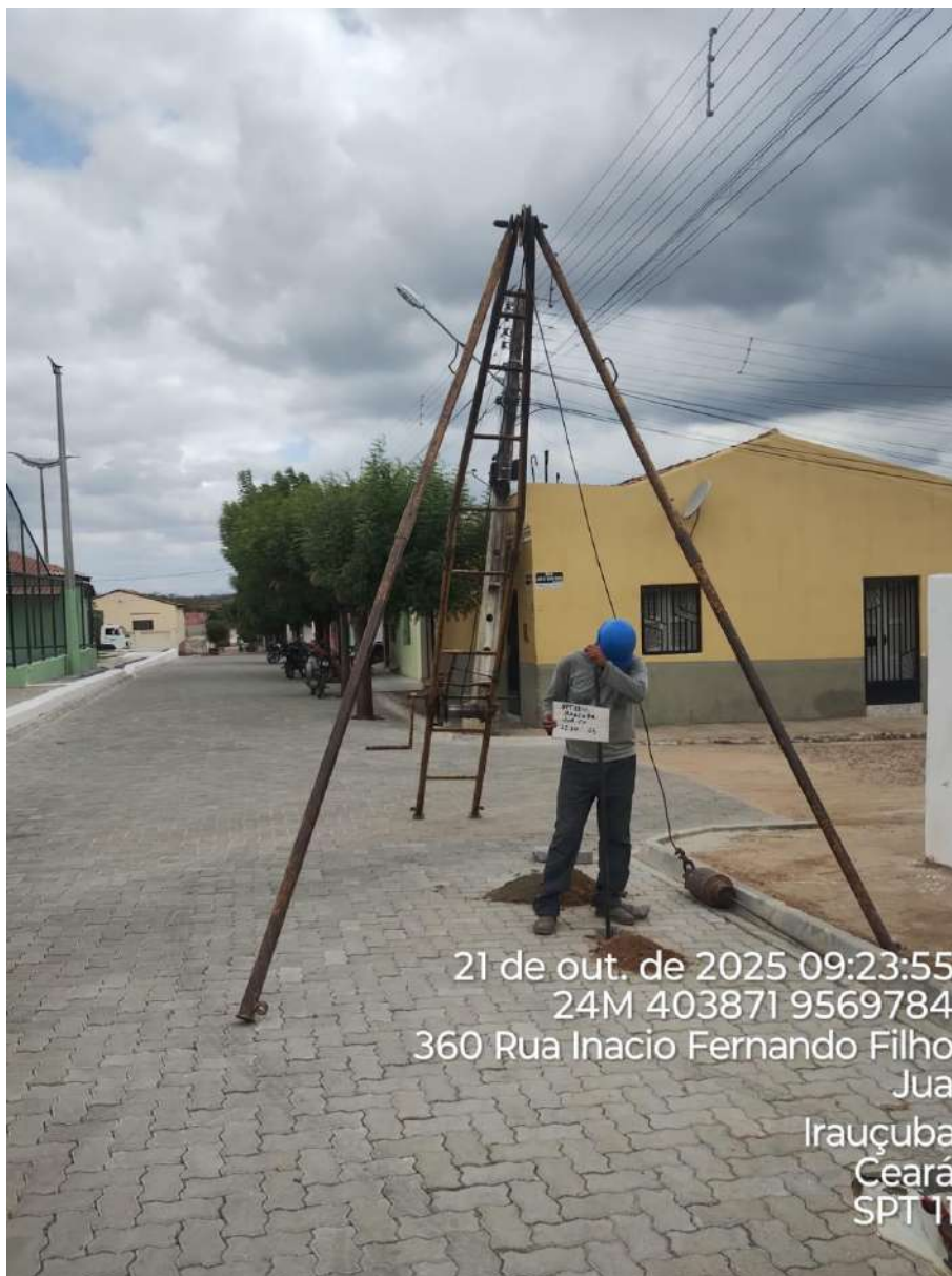
Instalação do furo 1.SPT-11
