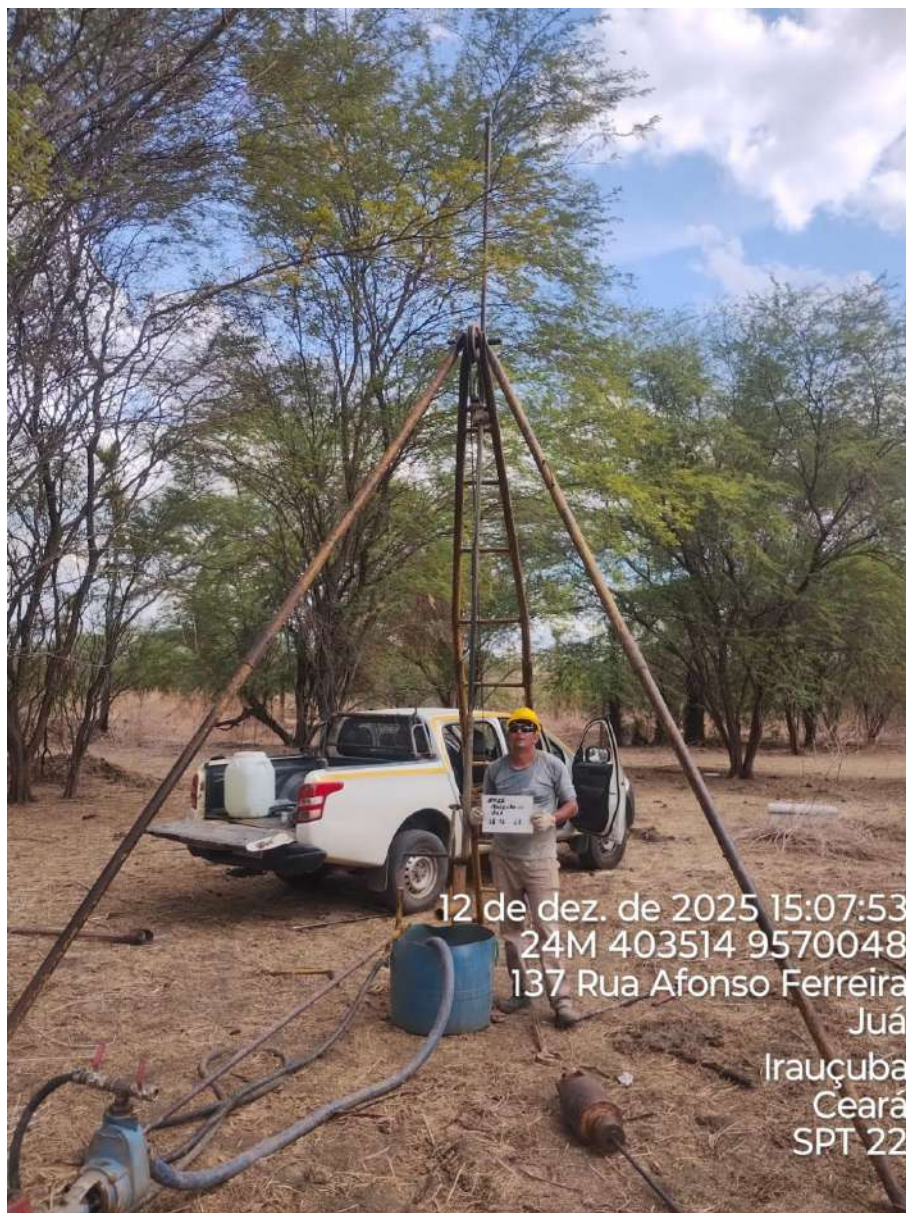
Instalação do furo 1.SPT-22
