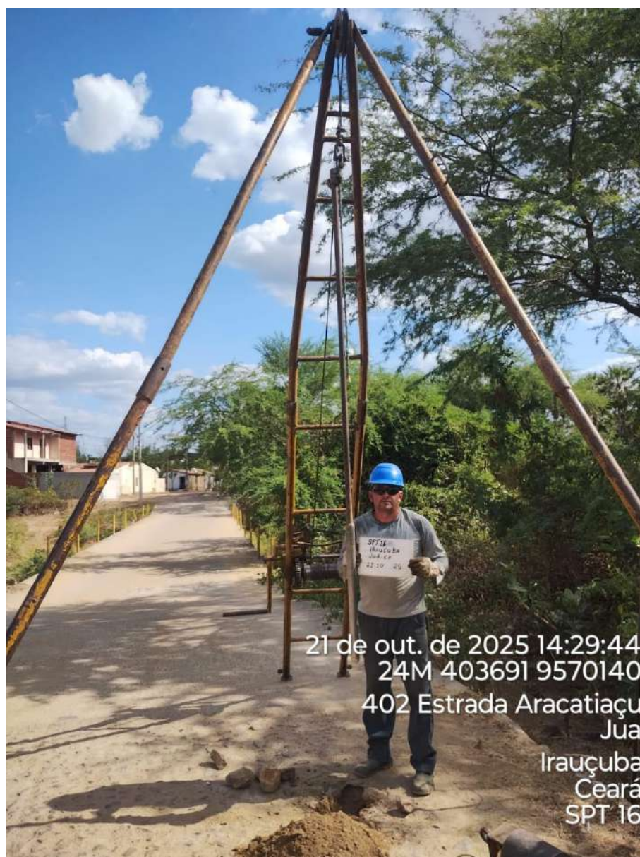
Instalação do furo 1.SPT-16
