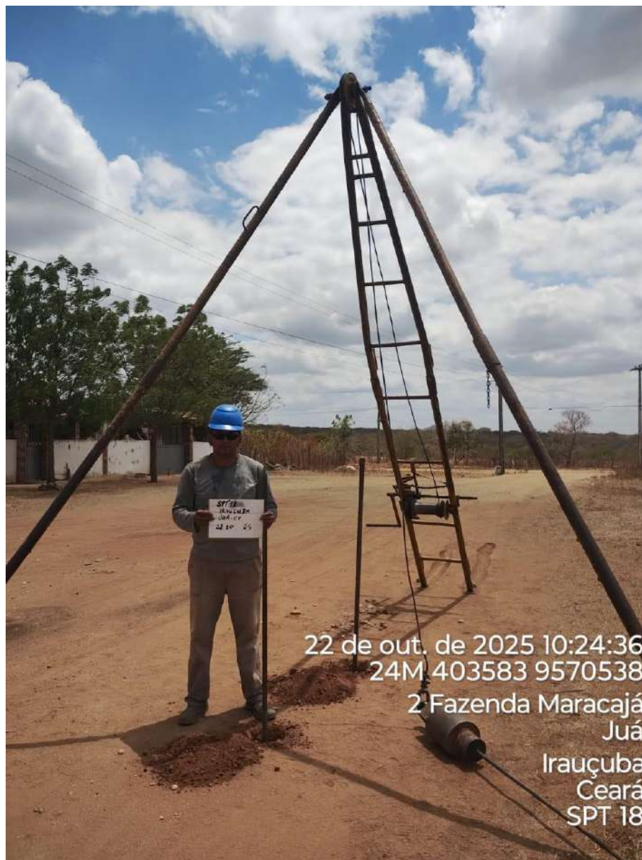
Instalação do furo 1.SPT-18
