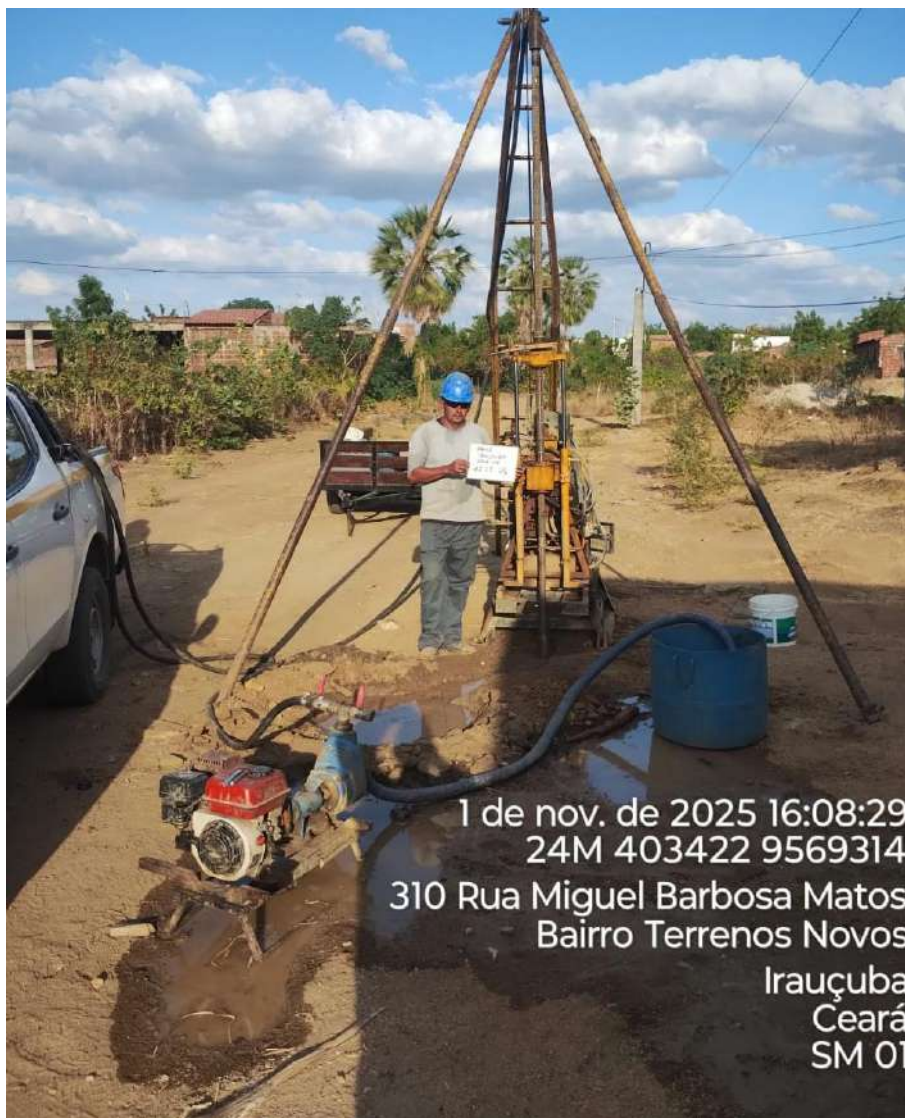
Instalação do furo SR-01
