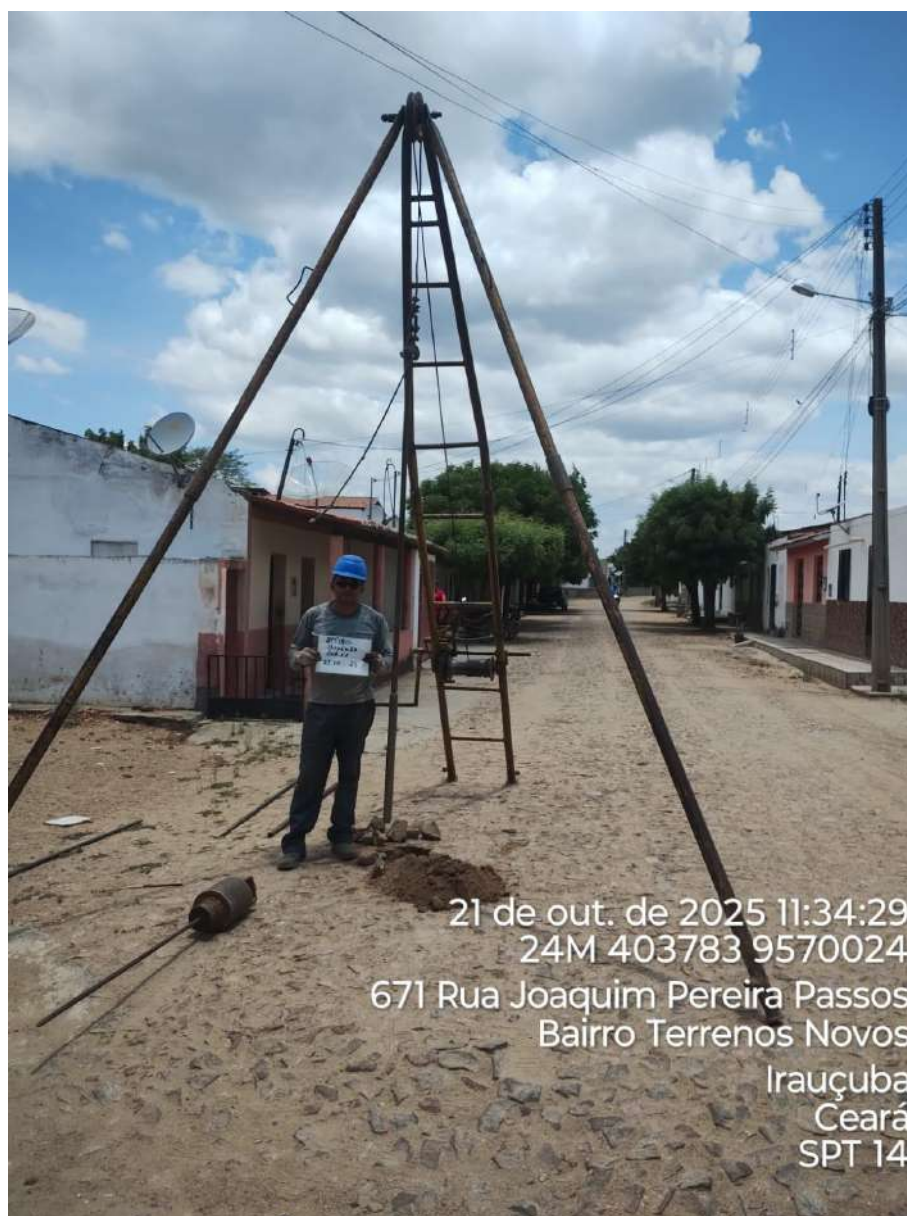
Instalação do furo 1.SPT-14
