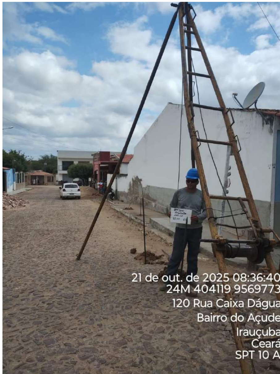
Instalação do furo 1.SPT-10 A
