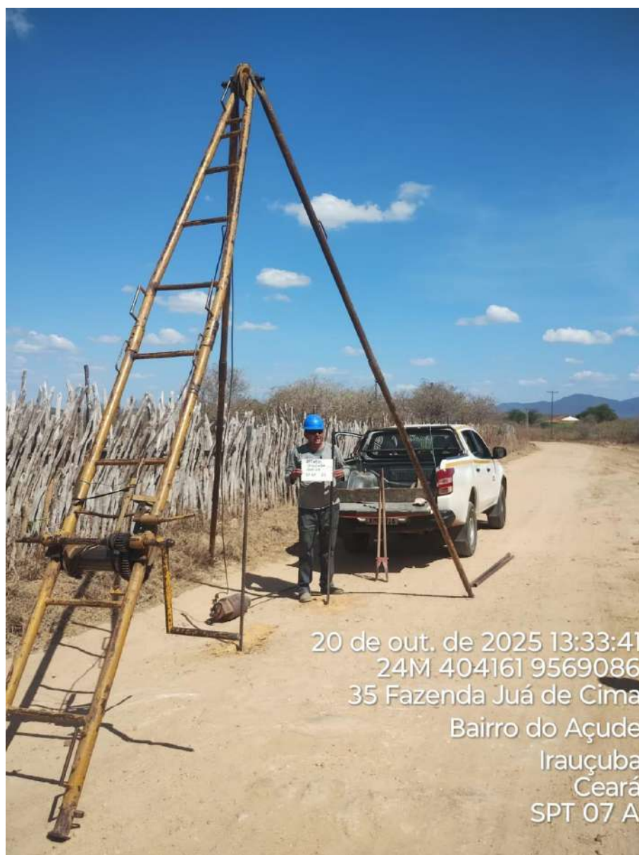
Instalação do furo 1.SPT-07 A
