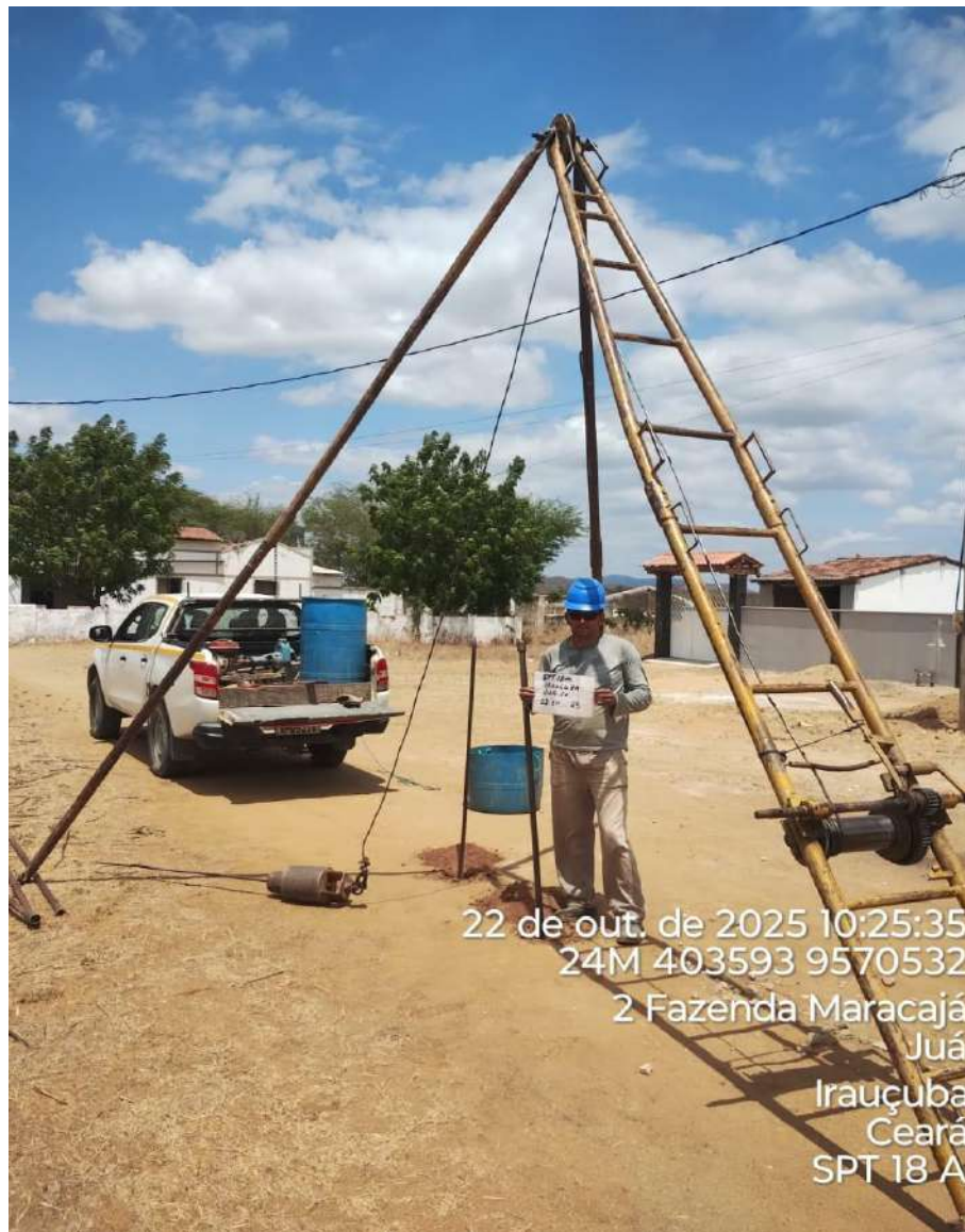
Instalação do furo 1.SPT-18 A
