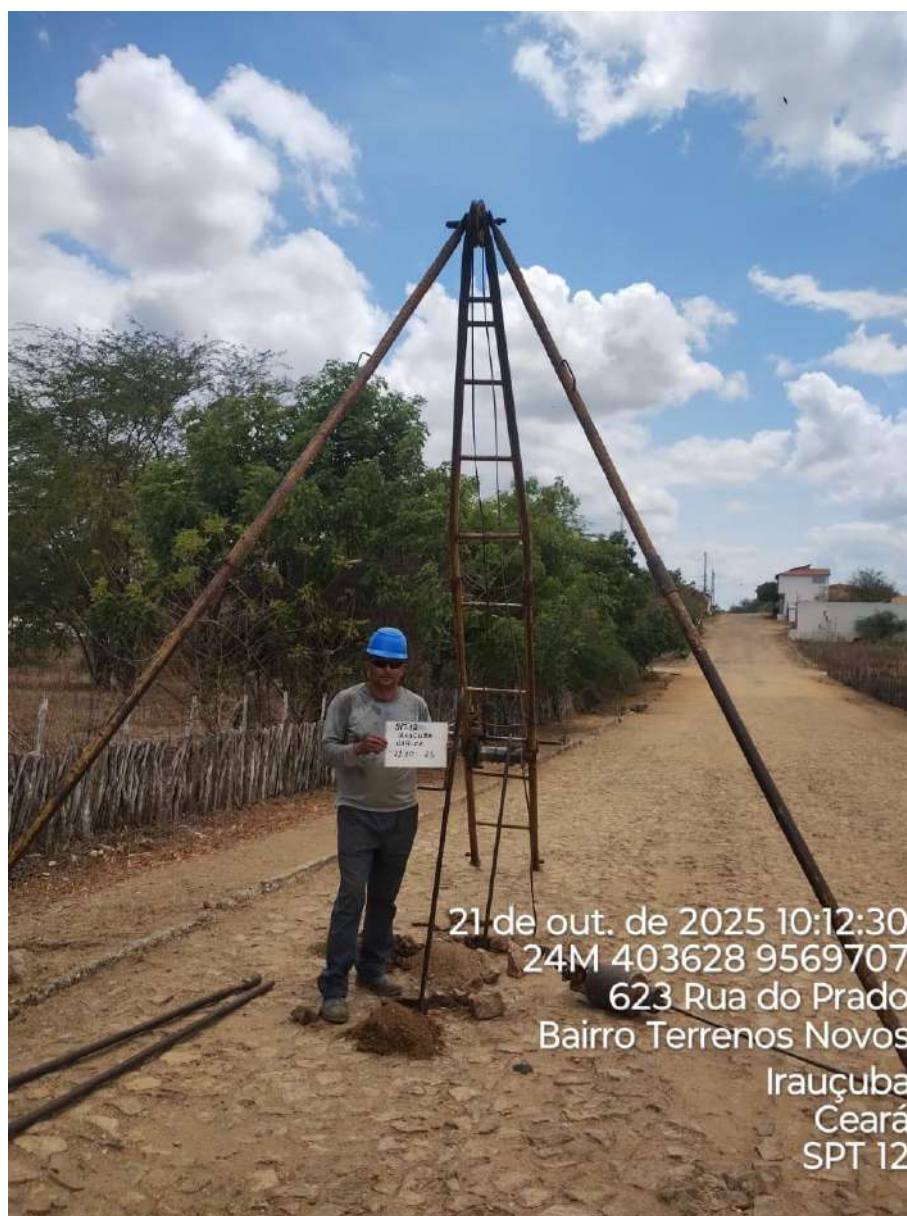
Instalação do furo 1.SPT-12
