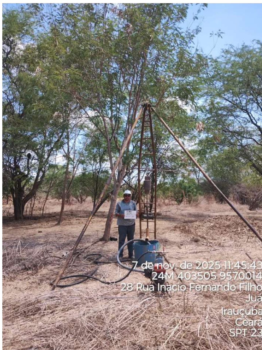
Instalação do furo 1.SPT-23
