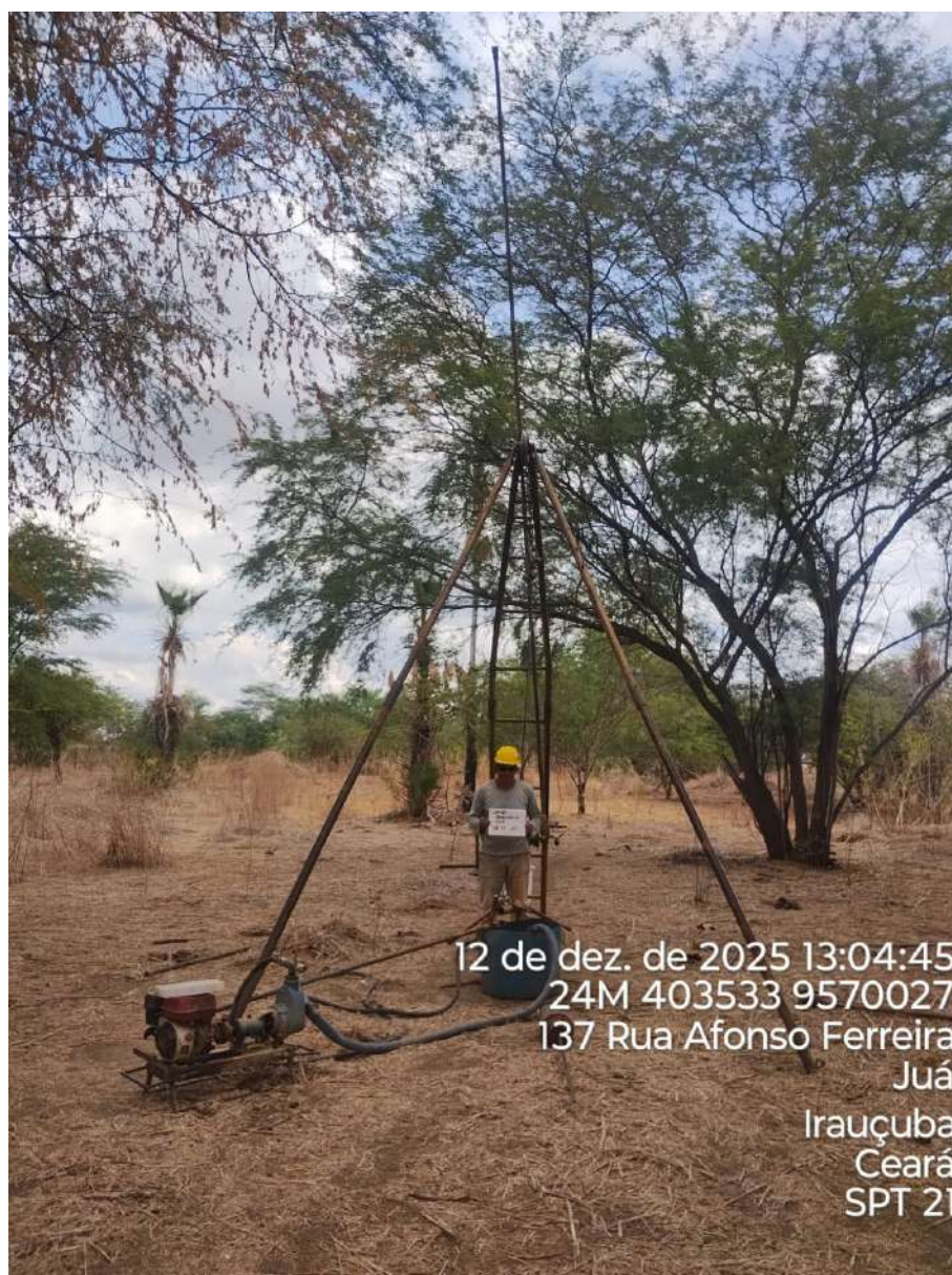
Instalação do furo 1.SPT-21
