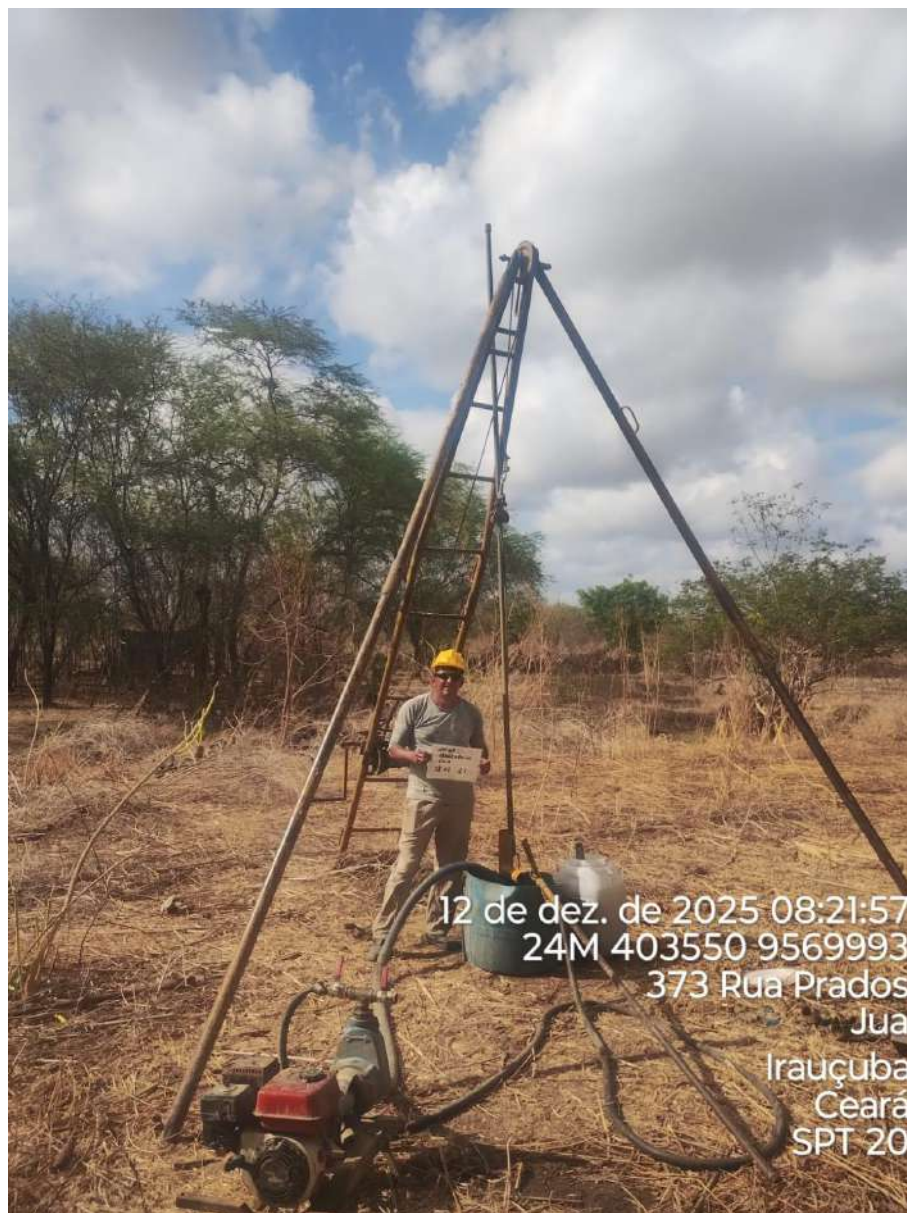
Instalação do furo 1.SPT-20
