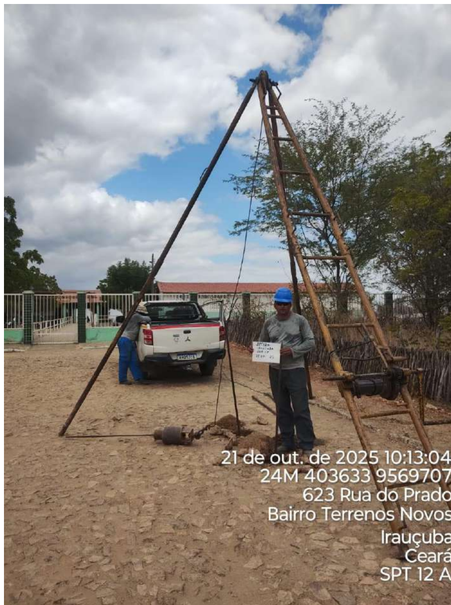
Instalação do furo 1.SPT-12 A
