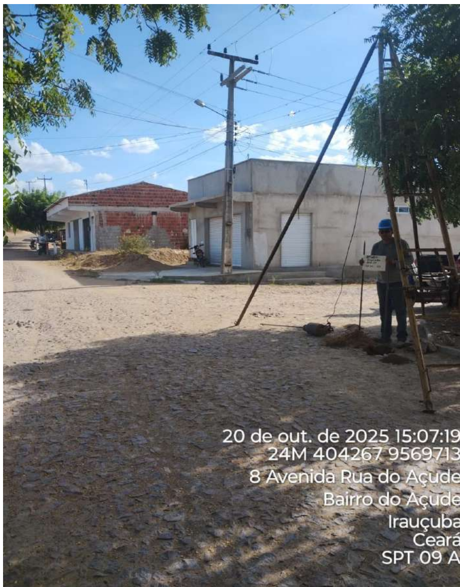
Instalação do furo 1.SPT-09 A
