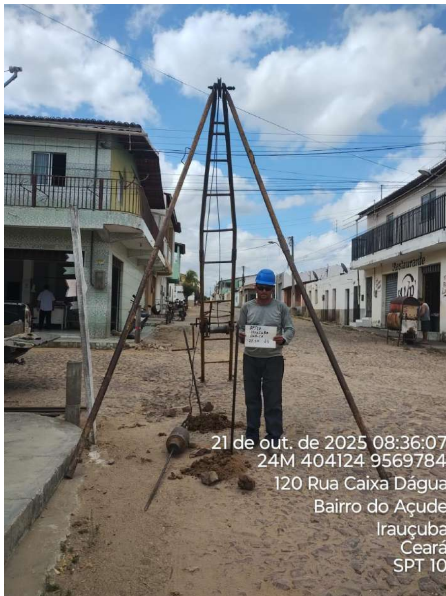
Instalação do furo 1.SPT-10
