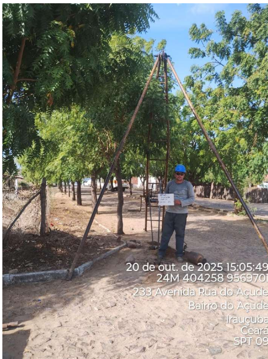
Instalação do furo 1.SPT-09
