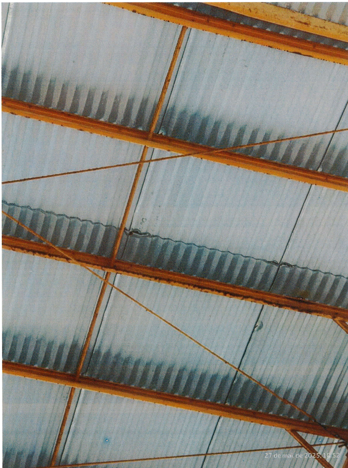
Foto 27: Vista geral das terças e cabos com vários pontos de oxidação.
