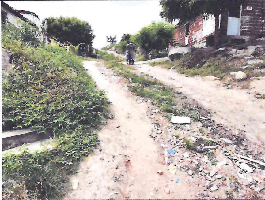
Início (Estaca E00) da TRAVESSA SÃO JOÃO UTM 568618.27/9435352.68
