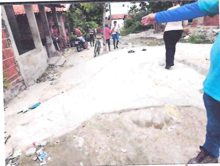
Início (Estaca E00) da RUA SEM DENOMINAÇÃO 02 UTM 568755.87 / 9435371.82
