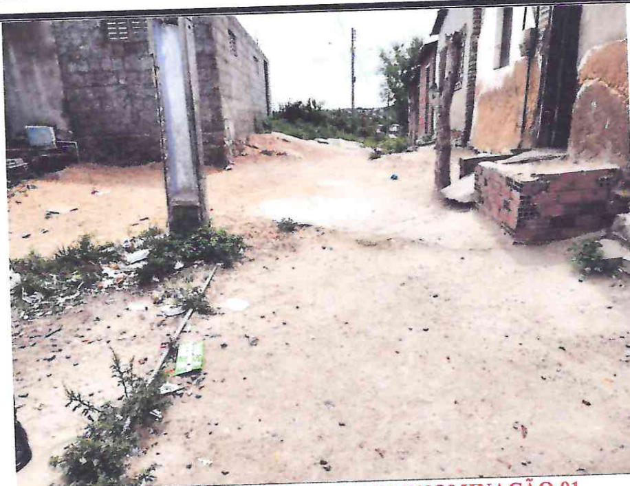
Início (Estaca E00) da RUA SEM DENOMINAÇÃO 01 UTM 568755.34 / 9435371.90
