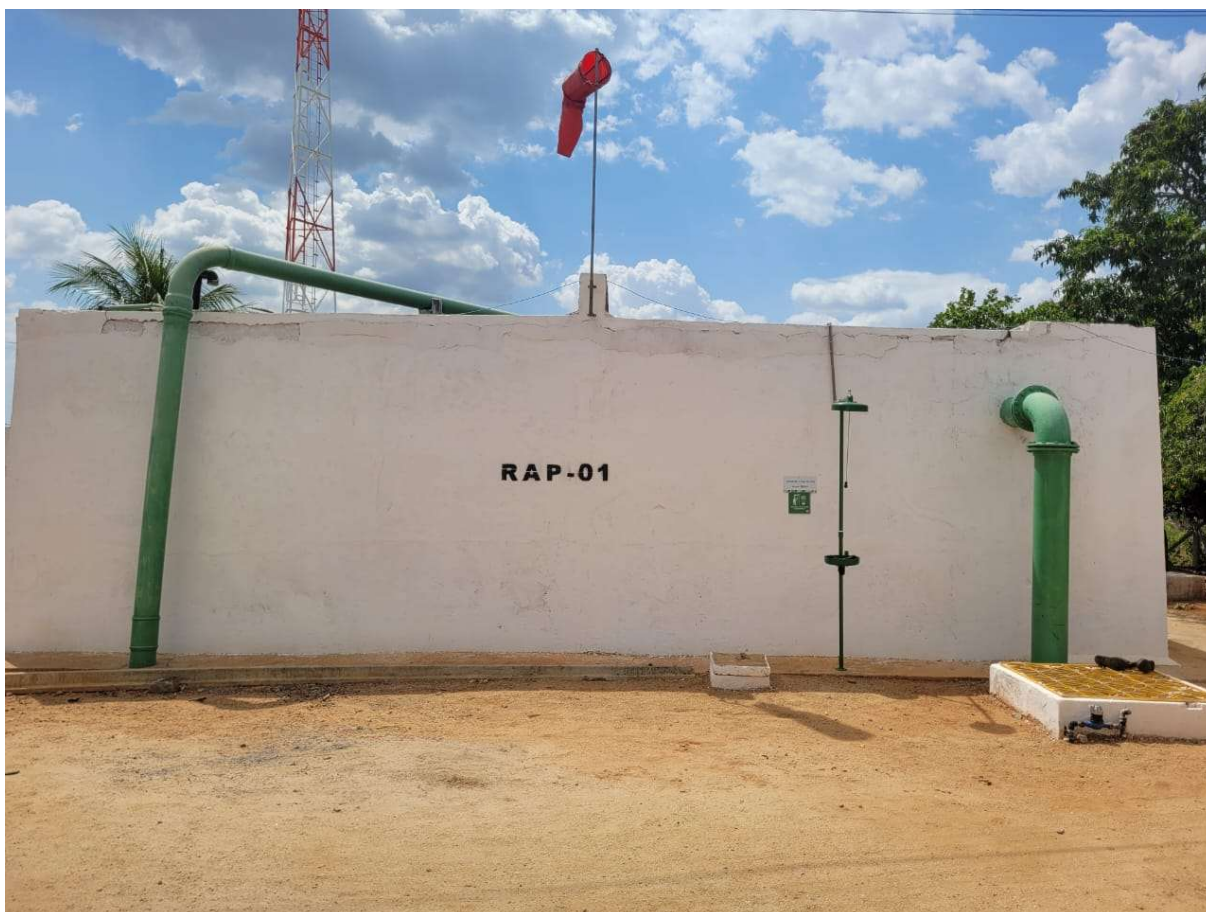
Figura 11 - Reservatório Apoiado 800m 3
