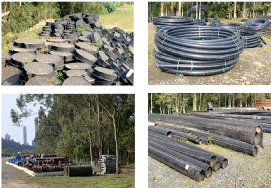
Figura 3 – Local onde estão armazenados os materiais.
