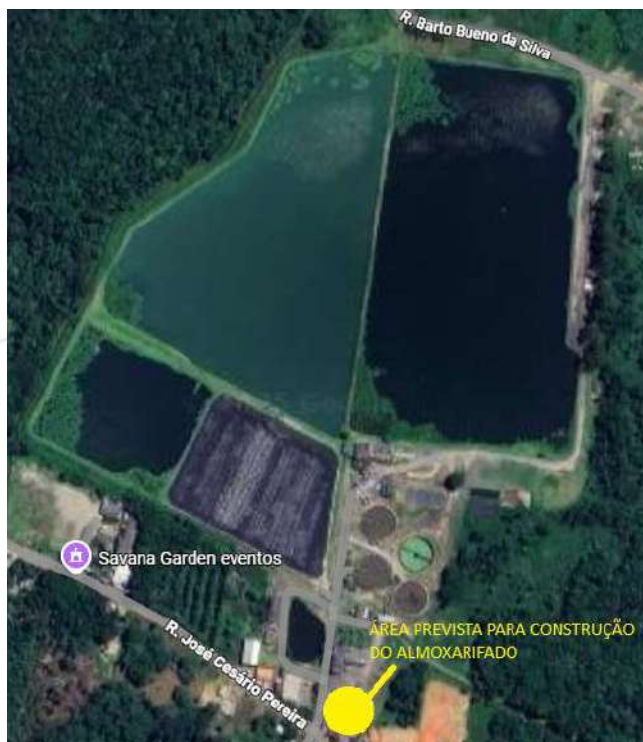
FIGURA 2 – INDICAÇÃO DA ÁREA PREVISTA PARA CONSTRUÇÃO DO ALMOXARIFADO.
