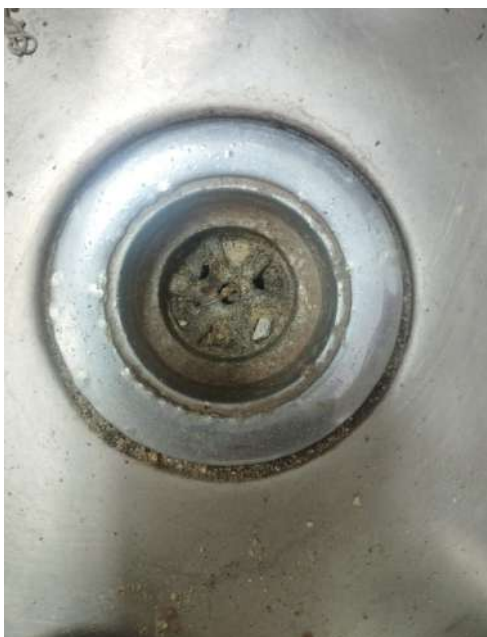
Válvulas inox a serem trocadas das pias dos Laboratórios.
