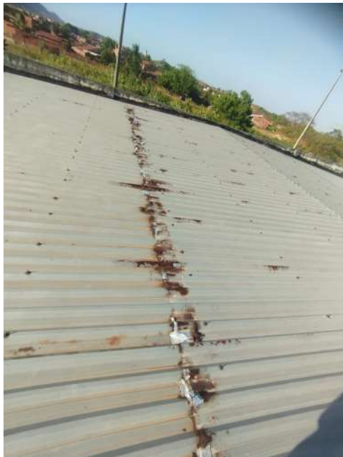
Teto para instalar manta asfáltica aluminizada.
