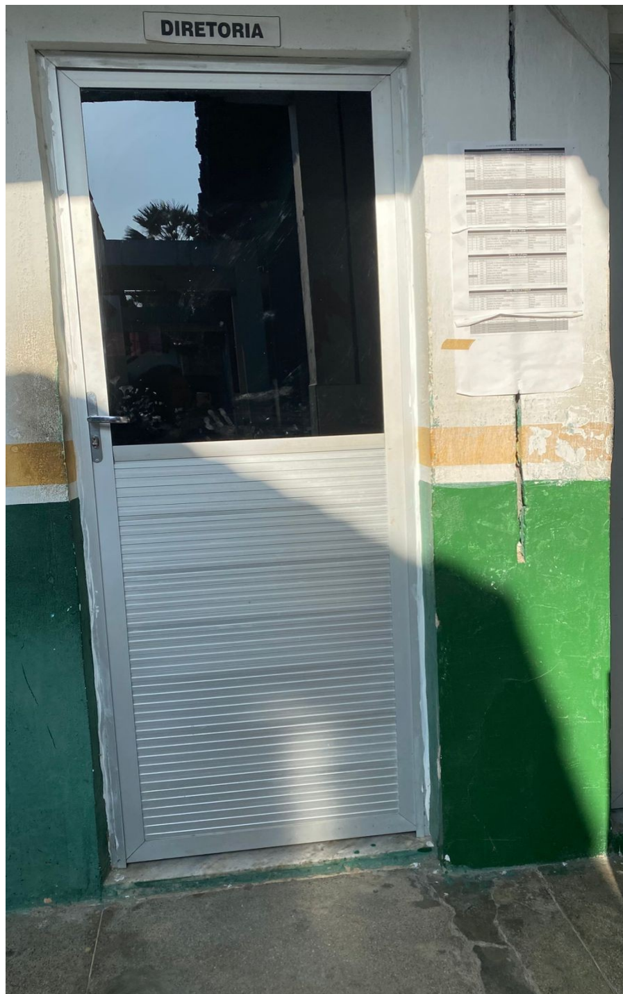
Foto da porta, conforme mencionado no item 507
