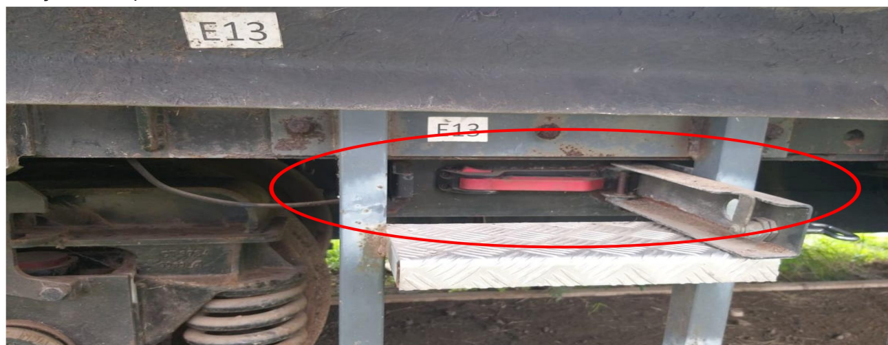
Figura 6 – Alavanca de abertura da porta do maquinista. Fonte: Edital do Leilão de Macaé/RJ
