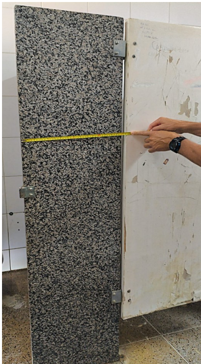
INCLUSÃO DAS PEDRAS QUE CAÍRAM (3 PEDRAS 40 X 180 CM) ESSA IMAGEM É ILUSTRATIVA, PARA SABEREM COMO É A PEDRA, POIS AS TRÊS PEDRAS QUE SERÃO INCLUÍDAS NÃO ESTÃO MAIS NO BANHEIRO POIS FORAM DANIFICADAS E RETIRADAS.
