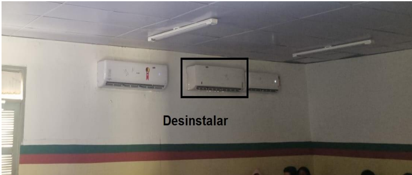
Foto 01: Uma maquina de 24000Btus a ser desinstalada na sala do 1ª ano A.
