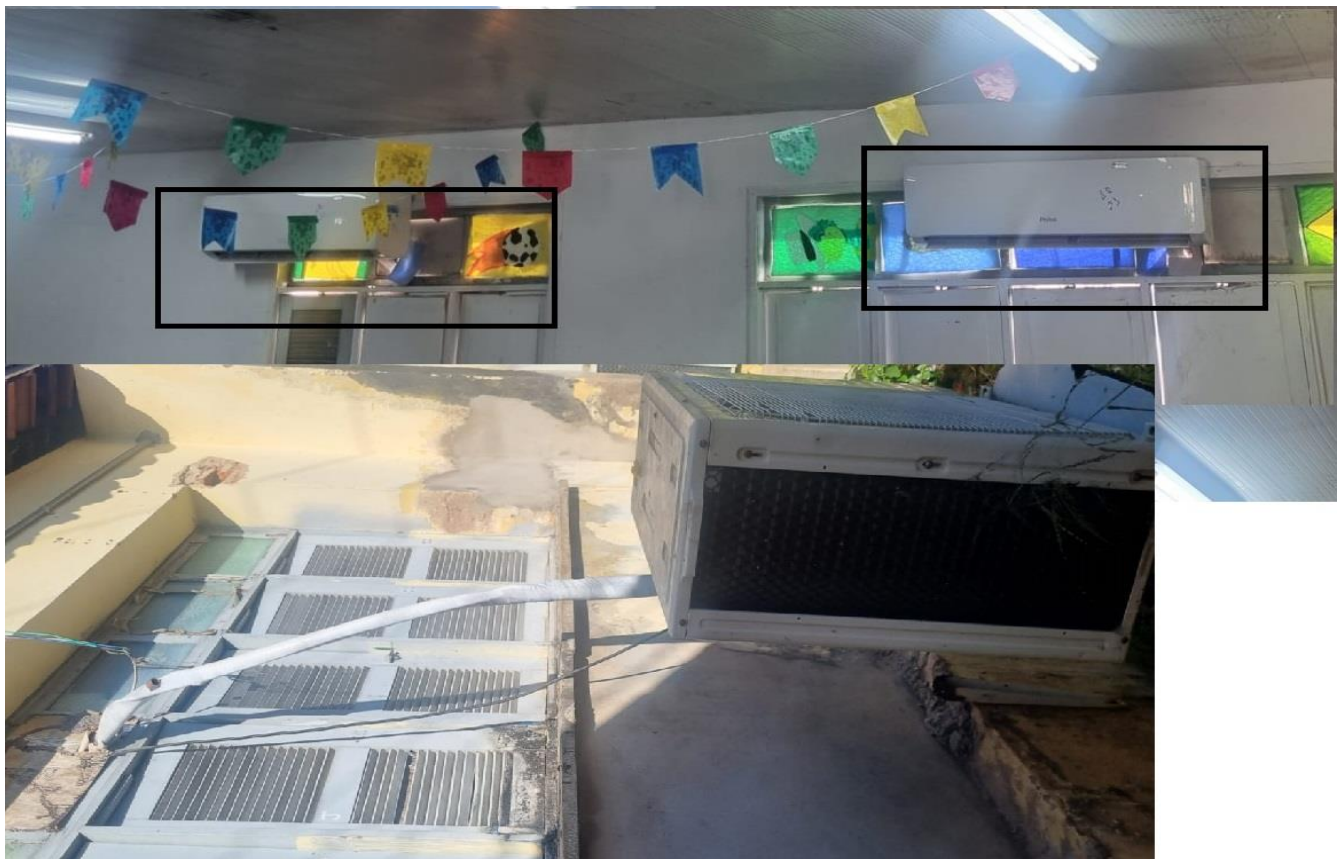
Foto 01: Uma maquina de 24000Btus a ser desinstalada na sala do 1ª ano A.
