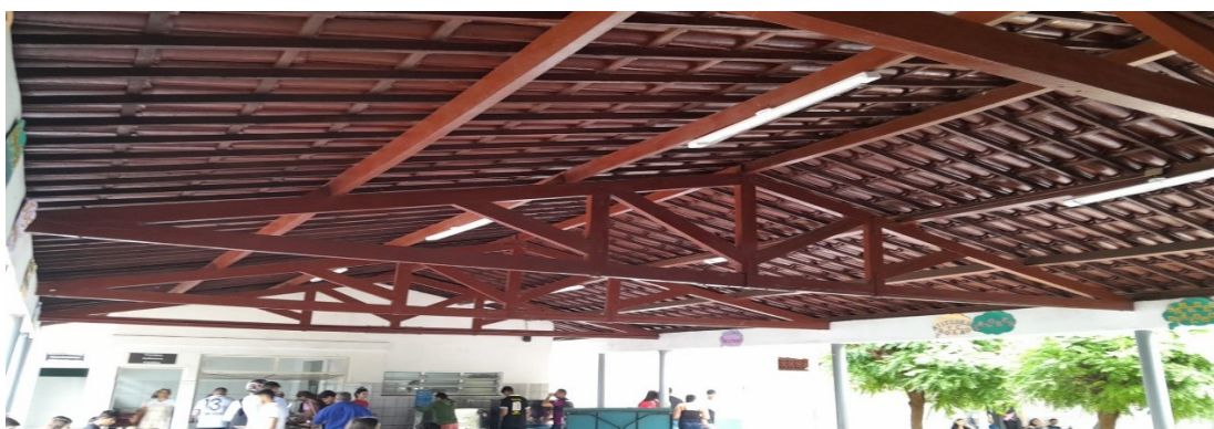
Figura 07. Ambiente Interno (Pátio)
