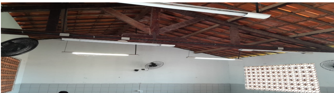
Figura 08. Ambiente Interno (Sala de Aula)
