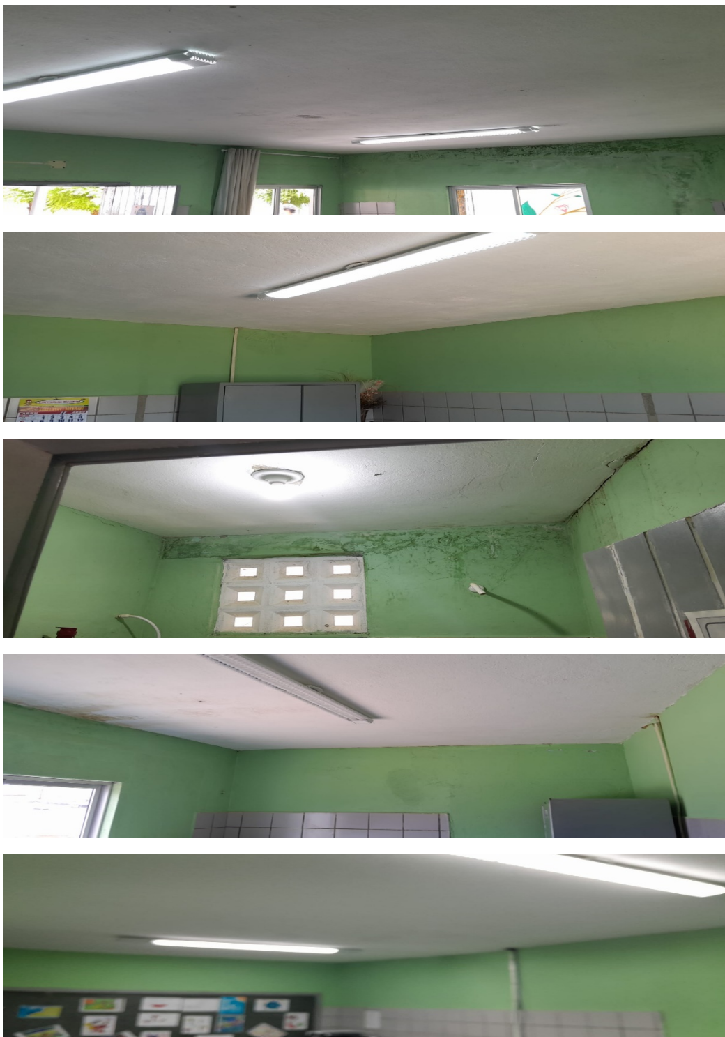
Figura 04. Ambiente Interno (Diretoria, Secretaria, Arquivo, Sala AEE e Banheiros)
