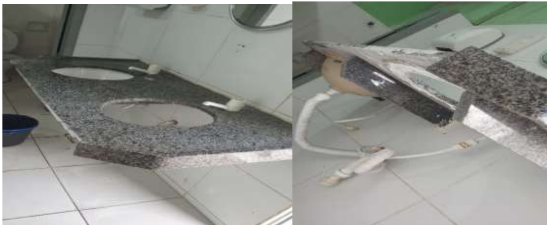
Figura 13. Instalação de Cuba (Banheiro Masculino)
