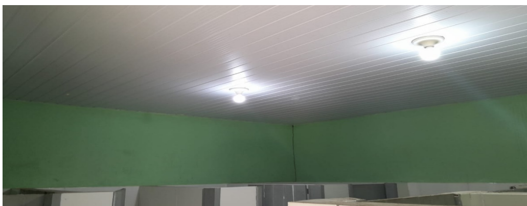
Figura 12. Ambiente Interno (Banheiro Femenino)
