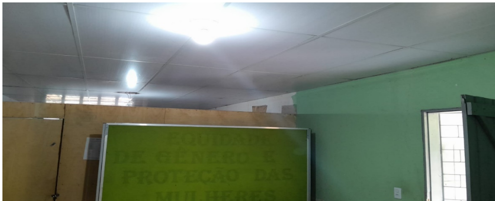
Figura 10. Ambiente Interno (Almoxarifado)
