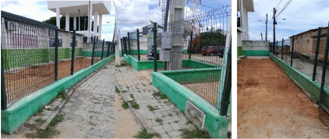
Figura 01. Pintura Gradil e Mureta
