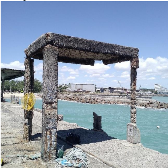
Figura 8 – Estrutura de Concreto Existente
