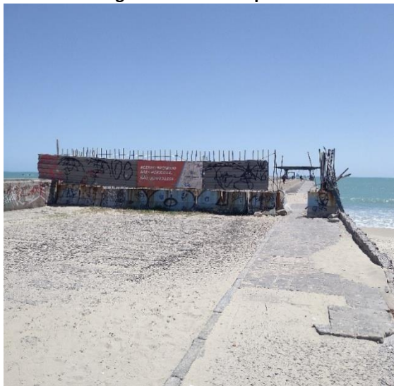
Figura 1 – Acesso à ponte
