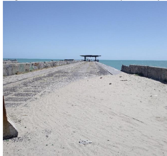
Figura 4 – Vista da Ponte - Parte Superior da Laje
