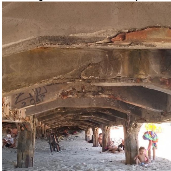
Figura 10 – Parte Inferior da Laje
