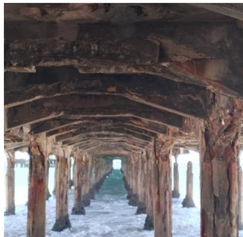
Figura 3 - Vista da Ponte - Parte Inferior da
