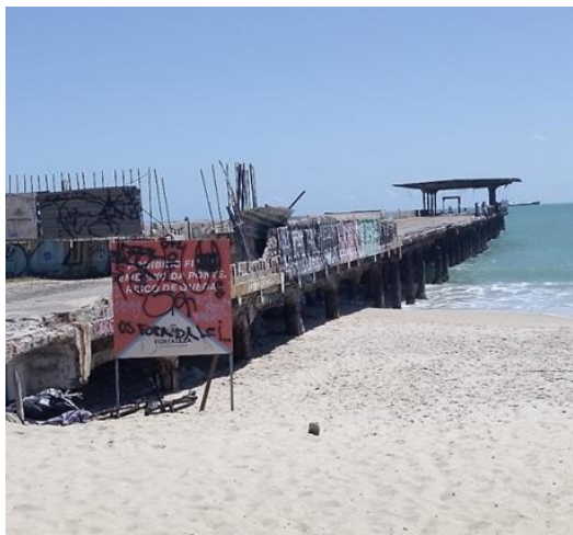
Figura 2 – Vista Lateral Leste da Ponte.
