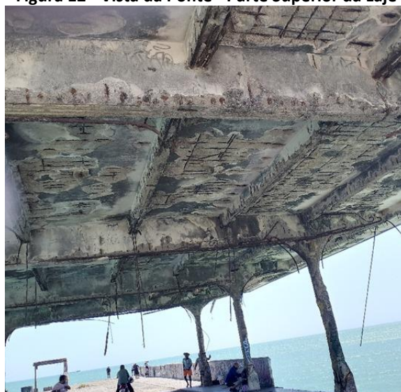
Figura 12 - Vista da Ponte - Parte Superior da Laje
