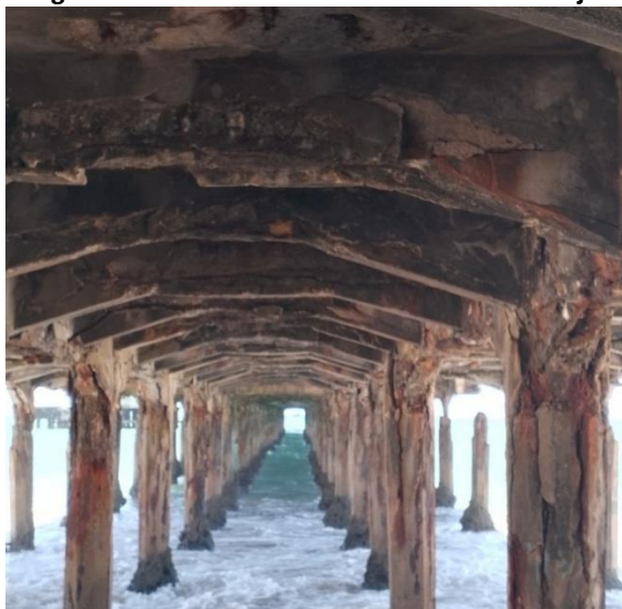
Figura 5 - Vista da Ponte - Parte Inferior da Laje
