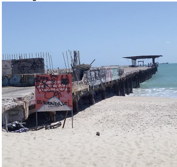
Figura 2 – Vista Lateral Leste da Ponte
