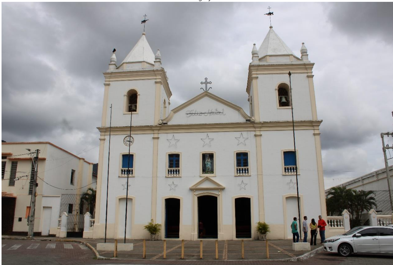
Foto 05 – Fachada Frontal da Igreja Nossa Senhora da Penha
