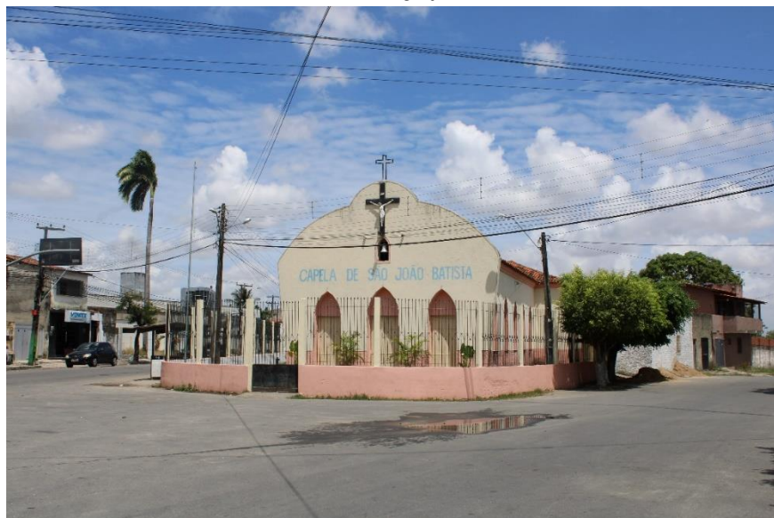
Foto 14 – Fachadas da Igreja São João Batista
