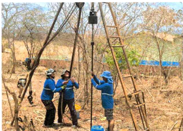
Foto 3 – Detalhe da operação de cravação do amostrador padrão para obtenção do "SPT" do terreno de fundação.
