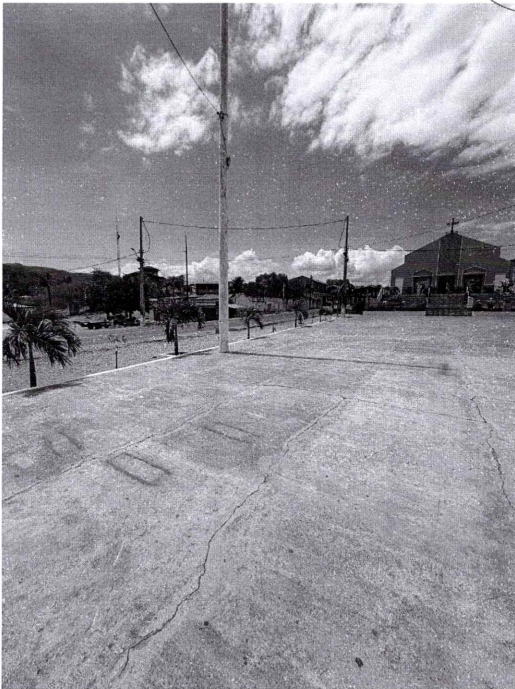
FOTO 9 - PATAMAR DA IGREJA NOVA
