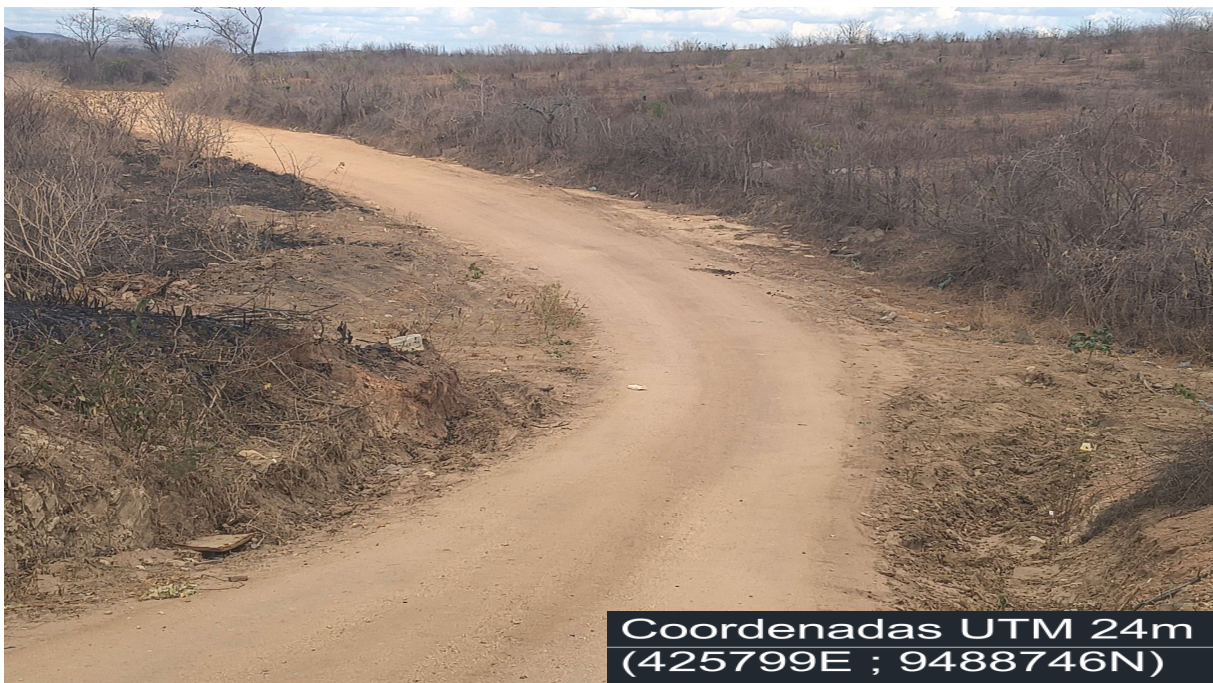
FOTO DO LOCAL DO FINAL DO BUEIRO (SENTIDO OESTE-LESTE)
