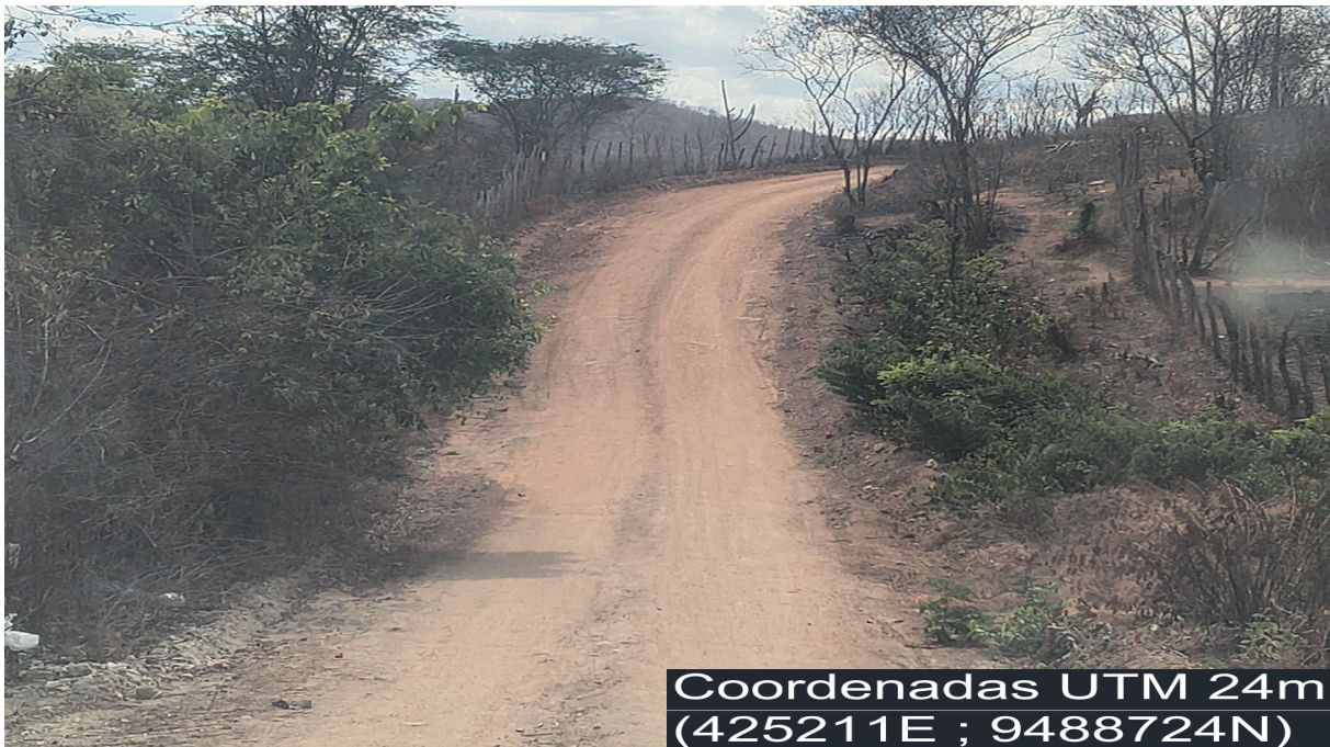
FOTO DO LOCAL DO FINAL PASSAGEM MOLHADA (SENTIDO LESTE-OESTE)
