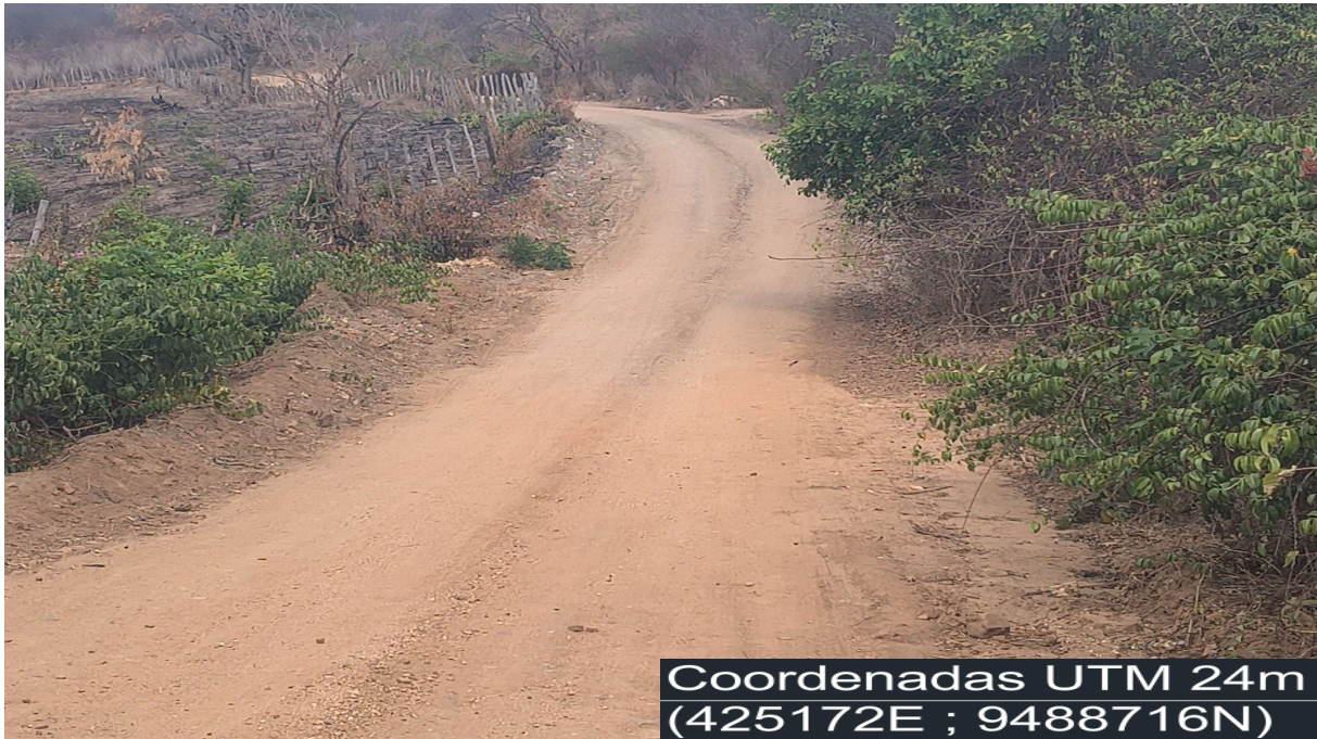
FOTO DO LOCAL DO INÍCIO PASSAGEM MOLHADA (SENTIDO OESTE-LESTE)
