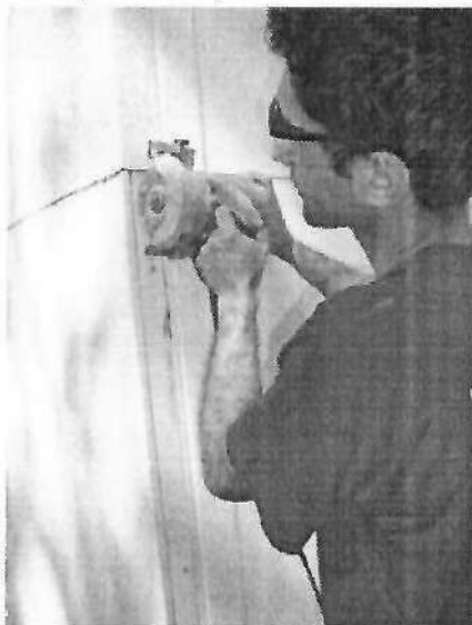
Foto 2) Cortar o perfil de canto com serra circular
