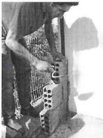
Foto 5 e 6) Assentar bloco cerâmico com argamassa.
