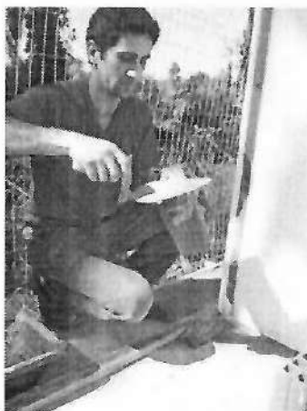
Foto 5 e 6) Assentar bloco cerâmico com argamassa.
