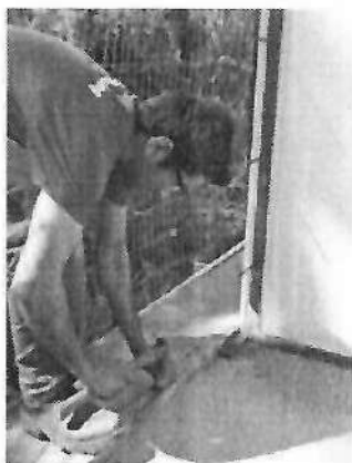
Foto 4) Fixar guia de piso, fazer furação com broca \varnothing 8\text{mm} para inserir barra de \varnothing 8\text{mm} .
