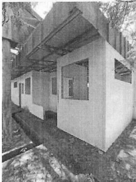
Figura 17 – Base da torre de água. Fonte: elaboração própria.
