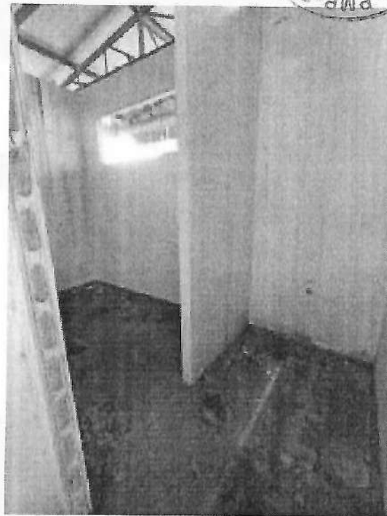
Figura 16 – Sala de aula. Fonte: elaboração própria.
