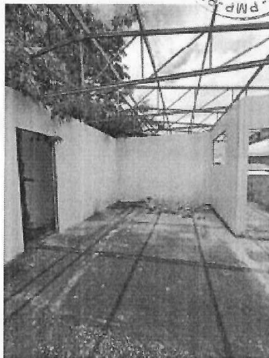
Figura 21 – Sala de aula. Fonte: elaboração própria.
