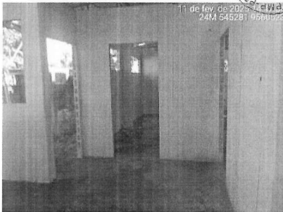
Figura 9 – Alvenaria executadas. Fonte: elaboração própria.
