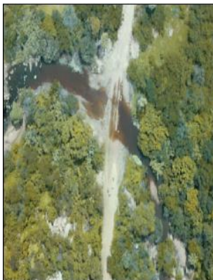
Vista superior do local da passagem molhada sobre o rio Pajeú
