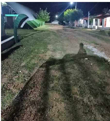
Rua que será pavimentada na comunidade do Rio Velho em Angicos/RN
