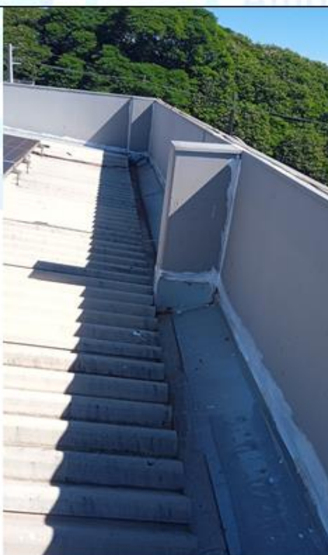
Foto 16 – Calha e Rufo Cobertura da Sede
