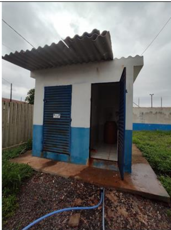
Foto 01 - Casa de Tratamento
