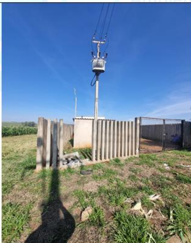
Foto 08 – Muro Palito Urb. Poço
