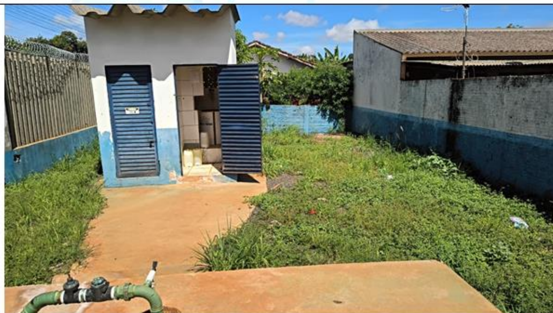
Foto 02 - Casa de Tratamento
