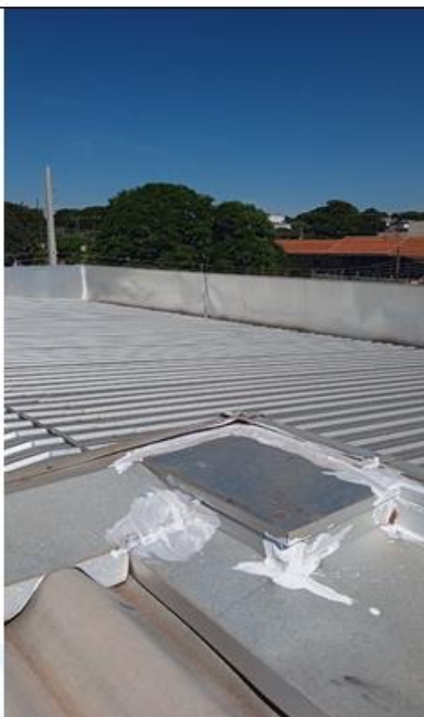
Foto 15 – Calha e Rufo Cobertura da Sede
