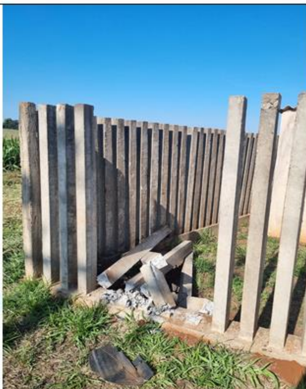
Foto 07 – Muro Palito Urb. Poço
