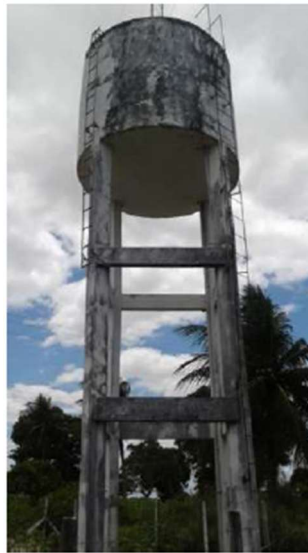
Figura: Reservatório elevado localizados na Comunidade Barbaço em Brejinho/RN.
