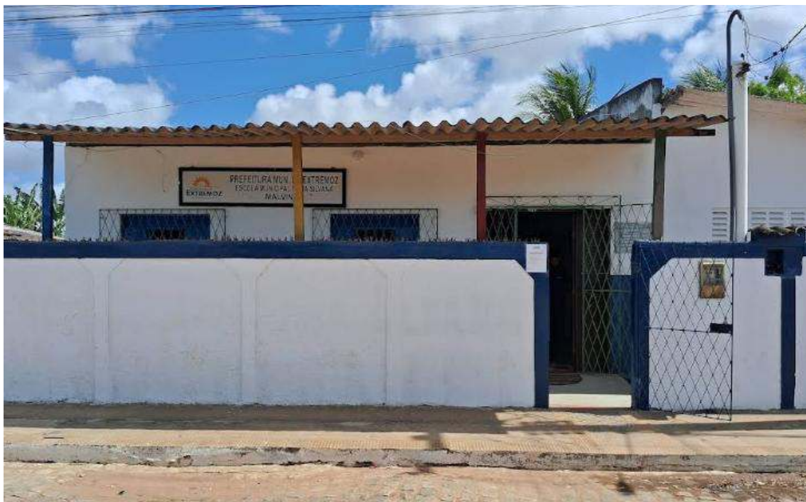
Vista frontal do imóvel avaliando
