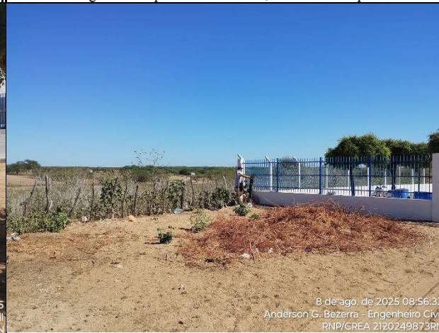
Foto 04: Parte do cercamento à demolir para construção da nova garagem.
