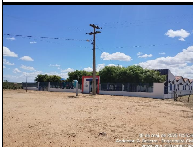
Foto 01: Fachada Frontal da Esc. Municipal Antônia Eurlí de Brito.
