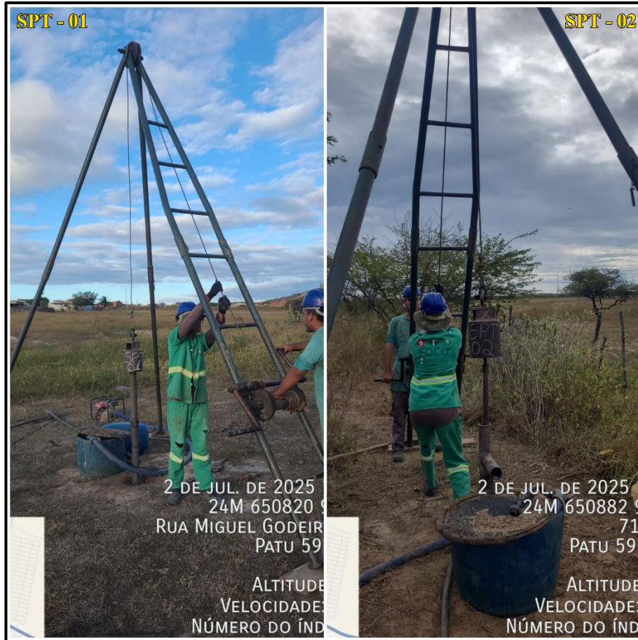
Figura 02: Execução das sondagens à percussão – SPTs (01 e 02). Fonte: Foco Geosoluções, 2025
