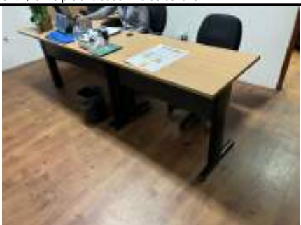
Foto 41: Mobiliário: O balcão de atendimento na recepção da Presidência possui altura inferior livre de 0,70m, altura total de 0,72m e profundidade livre de 0,14m.
