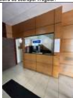
Foto 40: Mobiliário: Os balcões de atendimento na recepção possuem altura inferior livre de 1,02m/1,10m, altura total de 1,05m/1,13m e profundidade livre de 6cm/2cm.
