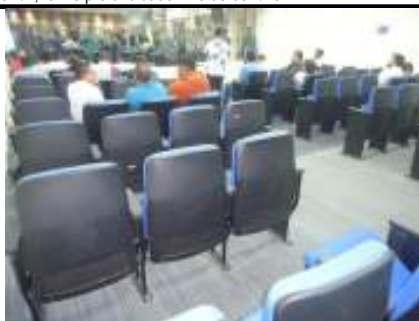
Foto 42: Mobiliário: Ausência de módulo de referência, devidamente sinalizado, ao lado dos assentos fixos. Não foram identificados assentos reservados para pessoas com mobilidade reduzida, pessoas obesas, espaço para acompanhante e espaço para cão-guia.
