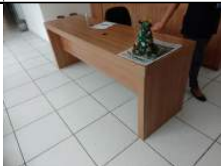
Foto 81: Mobiliário: A mesa de atendimento não permite o avanço de pessoas em cadeira de rodas sob o tampo, pois possui altura livre sob o tampo de 0,68m e profundidade livre de 0,17cm.
