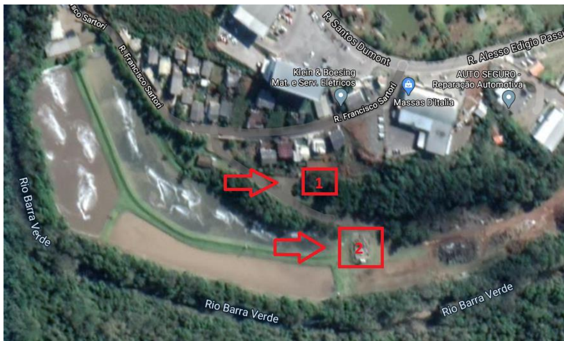
Imagem 1. ETE Herval d'Oeste. Referência ao local onde estão dispostas as caçambas tipo container.
