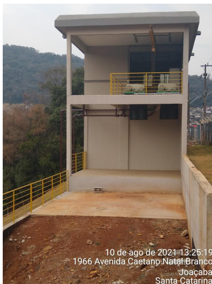
Imagem 9. Local de acomodação de caçambas.
