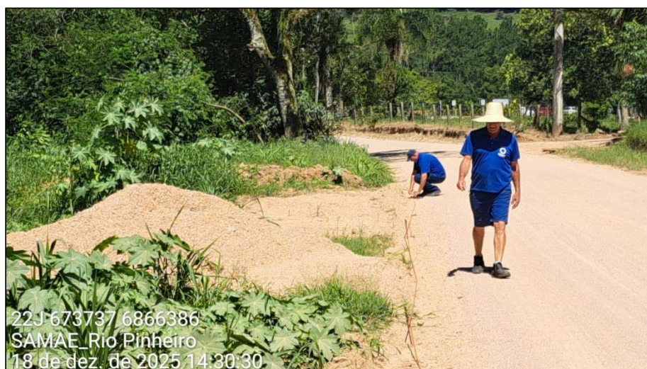
Fotografia 4. Instalação dos equipamentos na execução da linha RP1.
