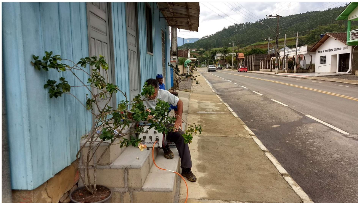
Fotografia 3 - Execução da linha da L 3 (A-2).
