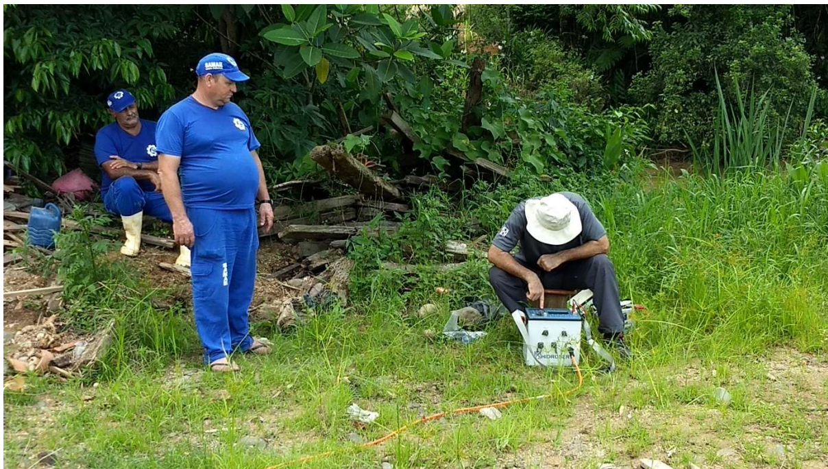
Fotografia 1 - Execução da linha de L 1 (S-6).
