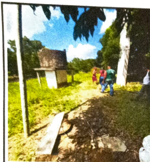
Foto 5: Sistema de Abastecimento (Poço artesiano, casa de bombas e reservatório superior).
