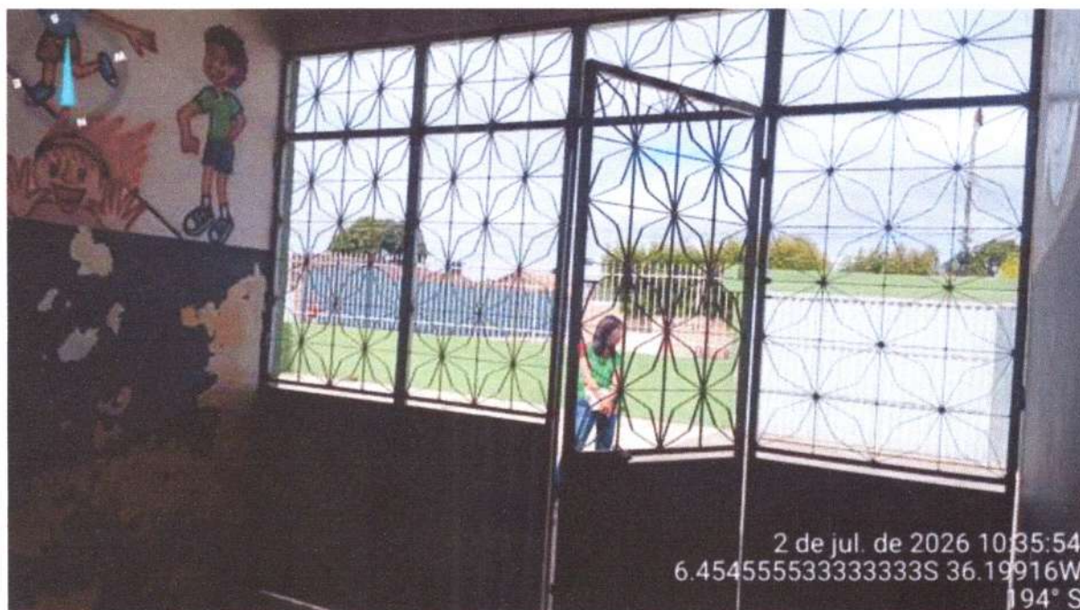
Figura 4: Portão será substituído
