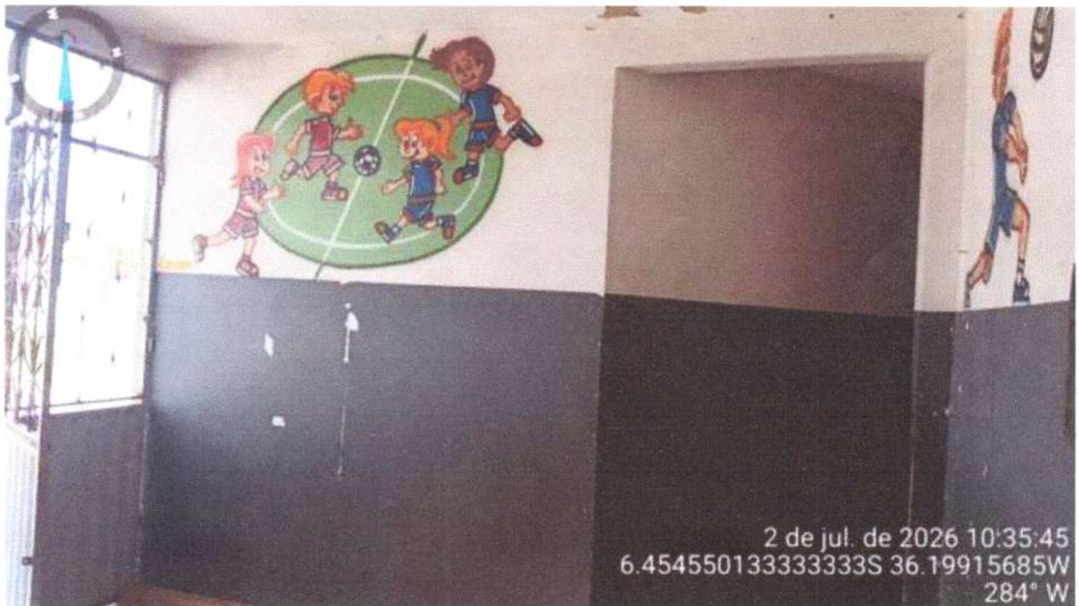
Figura 3: Passagem de acesso à quadra também receberá nova pintura
