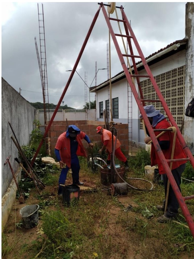
Figura 2. Execução de sondagem SPT
