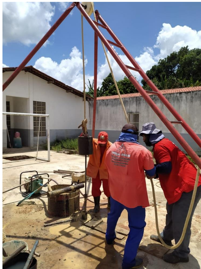
Figura 3. Execução de sondagem SPT
