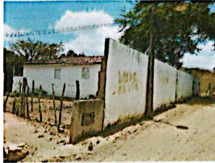
Foto 02- Via de acesso ao imóvel
